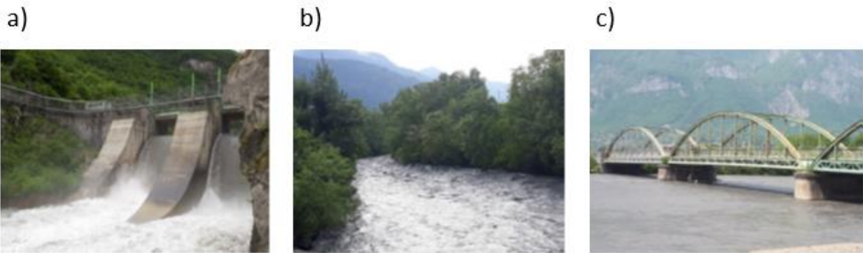
Figure II.3 : Photographies lors de la chasse du barrage d'Aigueblanche de 2018 (a) au niveau du barrage, (b) en amont de la Combe de Savoie et (c) en Combe de Savoie. Source : Loire (2019).
