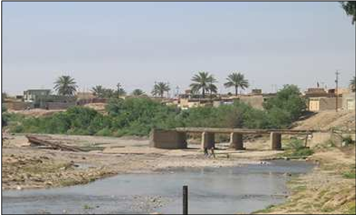
Photo 21 : Destruction d'un pont par une crue de la rivière de Kordarah (affluent de Khasajay) à Taza.
