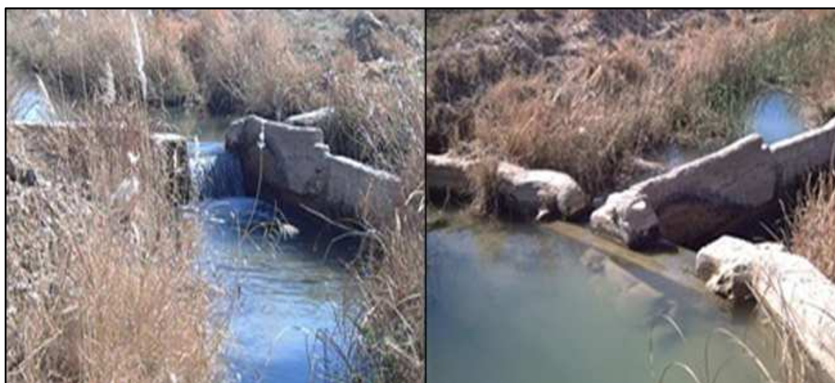
Photo 31 : Aménagements de répartition des eaux d'irrigation mal entretenus à Taza.
