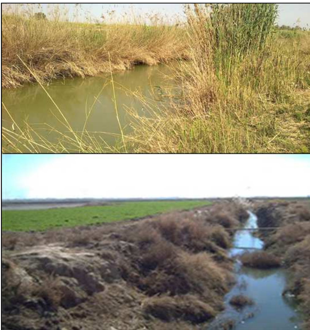
Photo 30 : Canaux d'irrigation en terre mal entretenus dans la province de Kirkuk.
