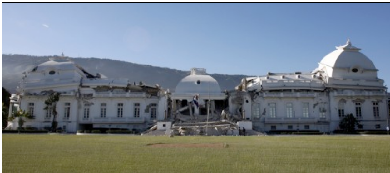
Photo 25. Le Palais présidentiel effondré lors du tremblement de terre de 2010
