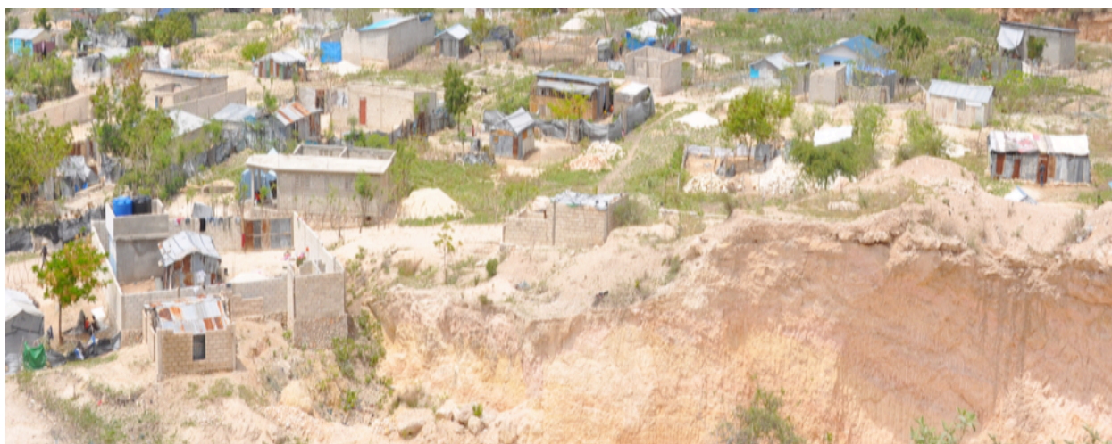
Photo 24. Constructions en expansion autour des parois d'une sablière à Canaan
