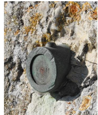
Figure 2. 9. Repère de référence à proximité du marégraphe de l'île d'Aix (Crédits : C. Chupin).
