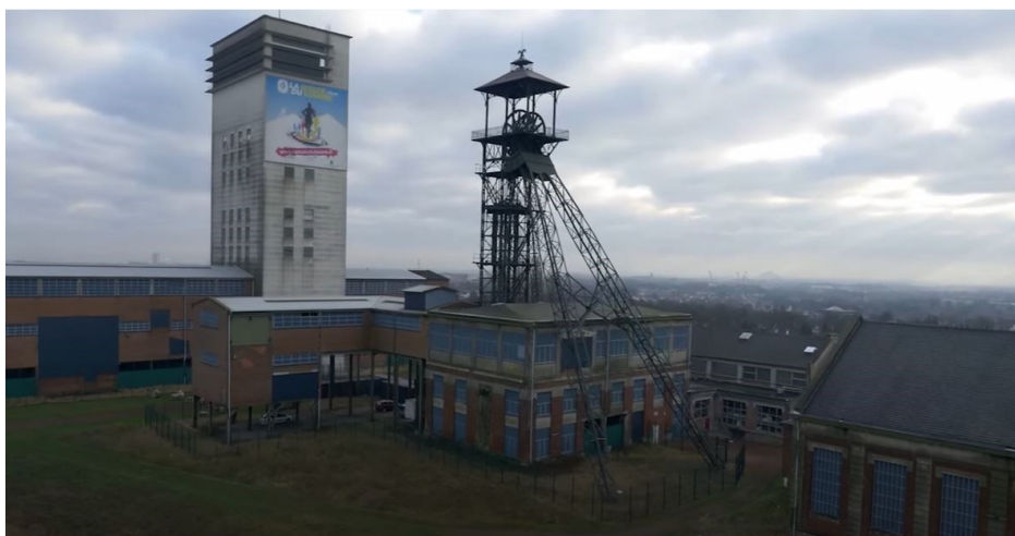
Figure 95 : Capture d'image de la vidéo Réhafutur (à 42 secondes) – Vue sur le chevalement (châssis à molette) (Source : https://www.youtube.com/watch?v=Ot84yWAu9TU consulté en juillet 2019)
