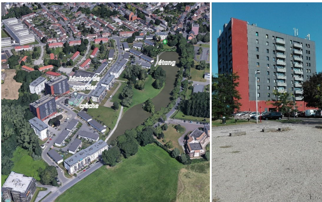
Figure 109 : Vue 3D de Google Earth capturée le 16 février 2021 avec annotations de l'auteur + Photo d'une des deux tours restantes (photos de l'auteure – aout 2019)
