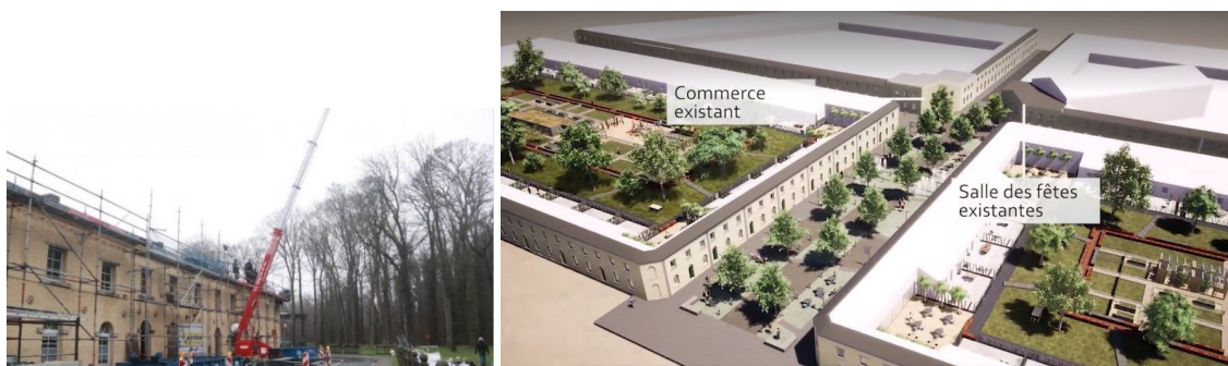
Figure 43 : à gauche, Photo des travaux sur la cité ouvrière en 2021 (Wilquin, 2021) - à droite, Vue aérienne fictive d'un projet présentant une vision d'avenir pour la cité ouvrière – R+Architecture (« Bois-du-Luc : une vision d'avenir pour le quartier », 2021)
