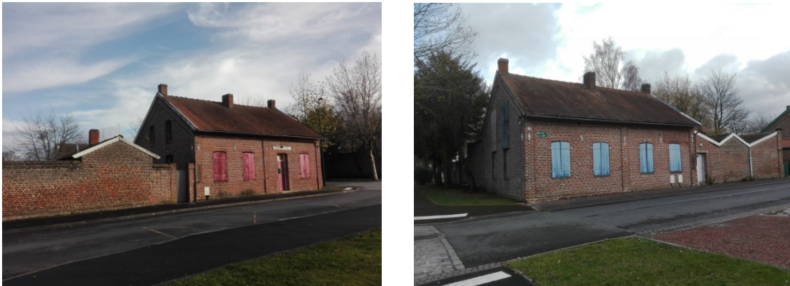
Figure 30 : Bâtiments miniers devant le site minier d'Arenberg Creative Mine à Wallers (Valenciennes) Sources: Photos de l'auteure (2018)
