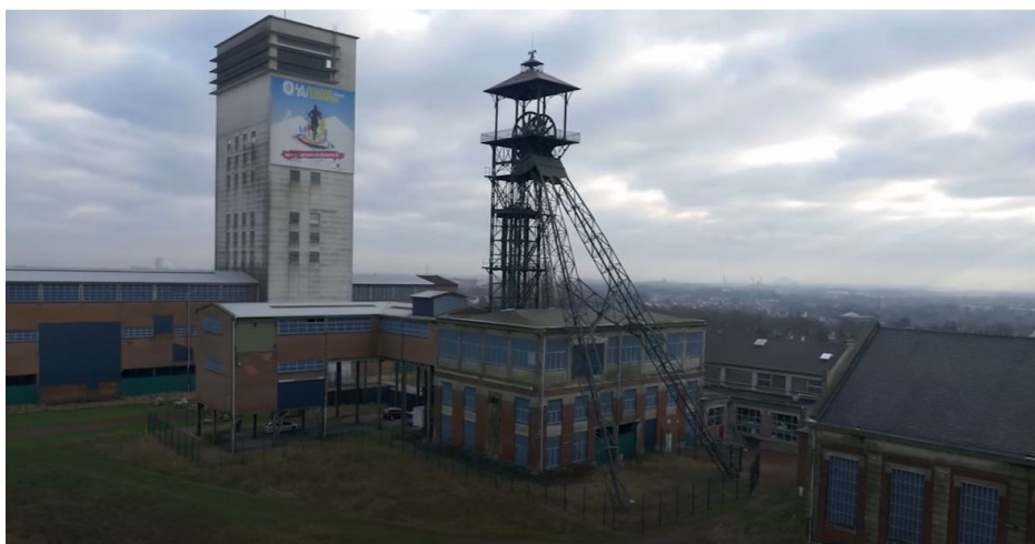
Figure 95 : Capture d'image de la vidéo Réhafutur (à 42 secondes) – Vue sur le chevalement (châssis à molette) (Source : https://www.youtube.com/watch?v=Ot84yWAu9TU consulté en juillet 2019)
