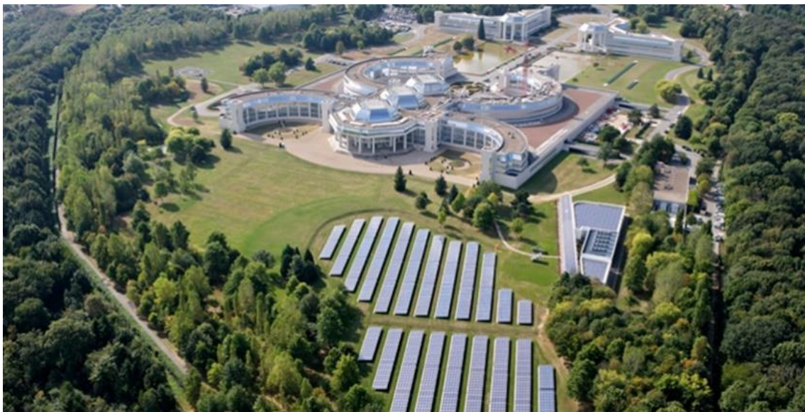
Figure 18 - Challenger, siège social de Bouygues Construction - crédit : Bouygues Construction
