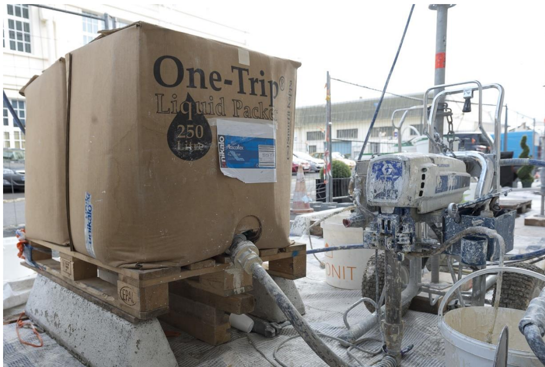
Figure 49 - Exemple de conditionnement de produits en bas d'immeuble - Crédits : Joëlle Mestas
