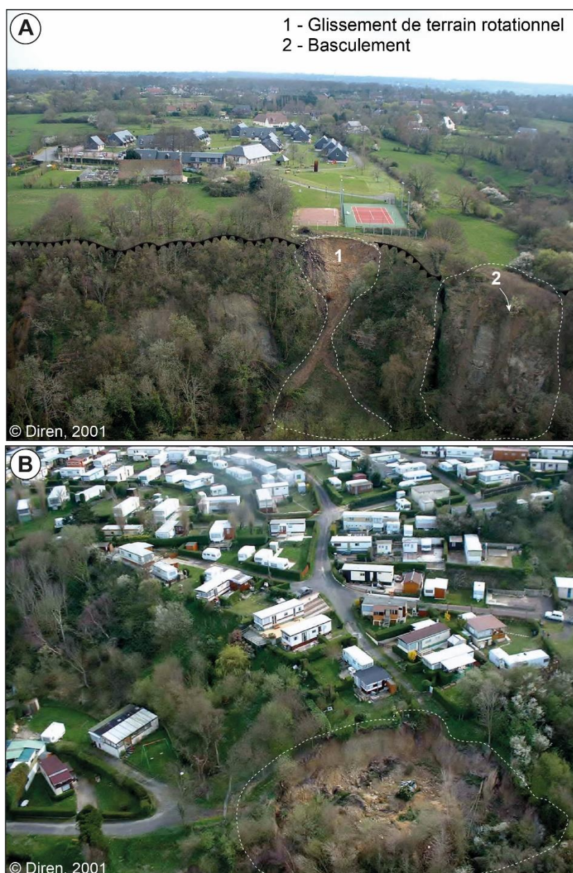
Figure 1.26 : Glissements de terrain et zone de basculement visibles sur la corniche de craie cénomaniennne ; A) Secteur du "centre de vacances CCAS", Auberville (photo : Diren, 2001) ; B) Secteur de camping à proximité du lieu-dit "la Corniche", Houlgate (photo : Diren, 2001)
