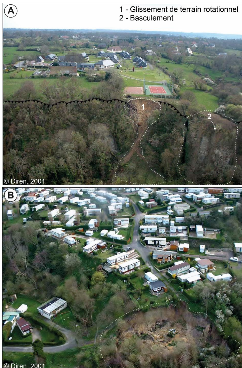
Figure 1.26 : Glissements de terrain et zone de basculement visibles sur la corniche de craie cénomaniennne ; A) Secteur du "centre de vacances CCAS", Auberville (photo : Diren, 2001) ; B) Secteur de camping à proximité du lieu-dit "la Corniche", Houlgate (photo : Diren, 2001)
