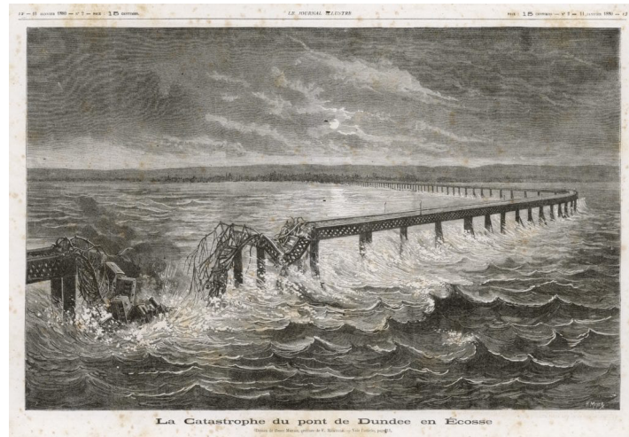
Figure 1.12: Catastrophe du pont Tay Bridge de Dundee en Écosse le 28/12/1879
