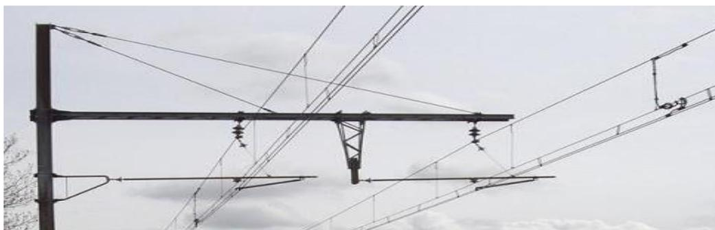
Figure 1-4 : Caténares exemple 1 500 V
