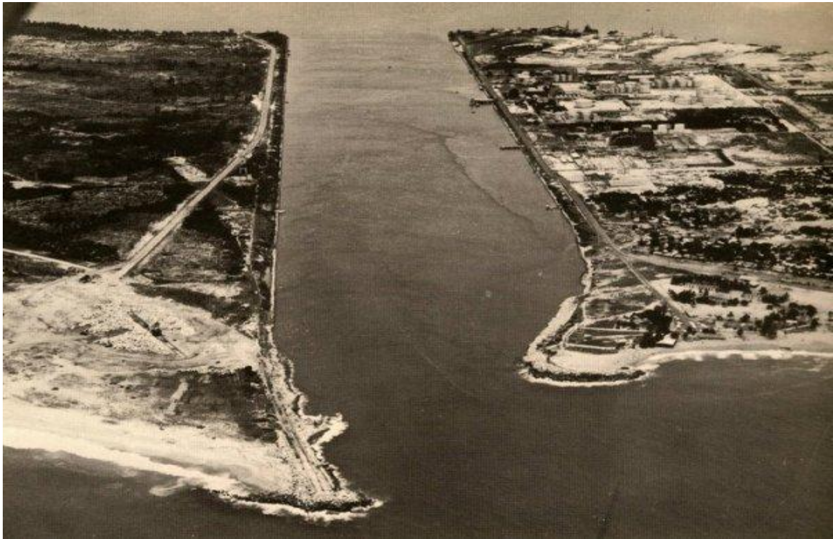
Figure 1 : la construction du port de Vridi canal
