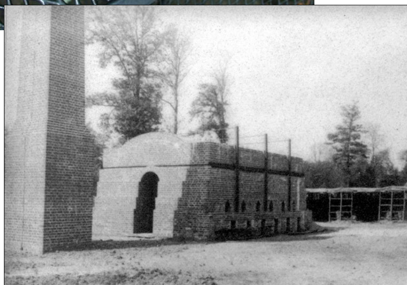
Fig. 155 Briques produites directement sur site, dans l'ancienne briquetterie de Sherrardspark Wood à Welwyn Garden City
