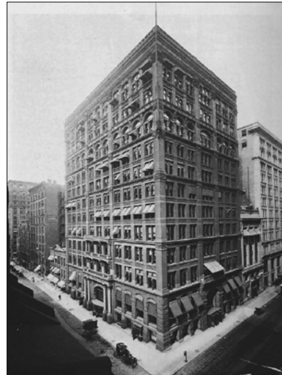
Fig. 41 Home Insurance Company (1885), premier gratte-ciel de Chicago, conçu par l'architecte William Le Baron Jenney en 1884 ; Chantier du Wainwright Building, réalisé en 1890-92 par Dankmar Adler et Louis Sullivan à St. Louis
