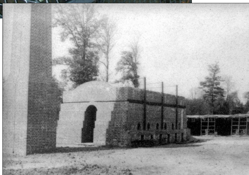
Fig. 155 Briques produites directement sur site, dans l'ancienne briquetterie de Sherrardspark Wood à Welwyn Garden City
