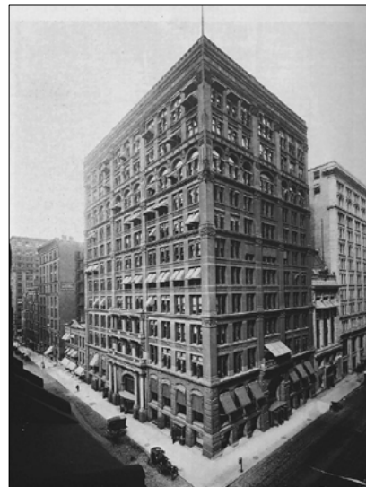
Fig. 41 Home Insurance Company (1885), premier gratte-ciel de Chicago, conçu par l'architecte William Le Baron Jenney en 1884 ; Chantier du Wainwright Building, réalisé en 1890-92 par Dankmar Adler et Louis Sullivan à St. Louis
