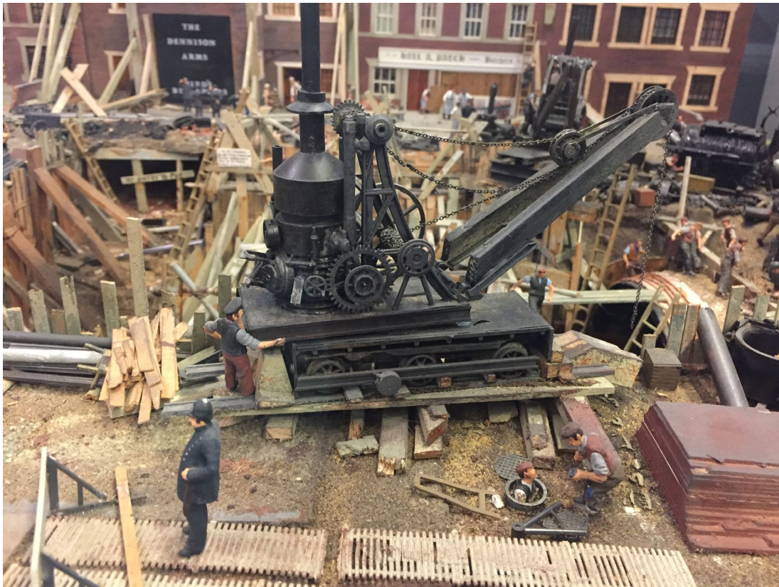
Fig. 95 Maquette d'une pelle à vapeur utilisée lors de la construction des premières lignes du métro de Londres à la fin du XIX e siècle
