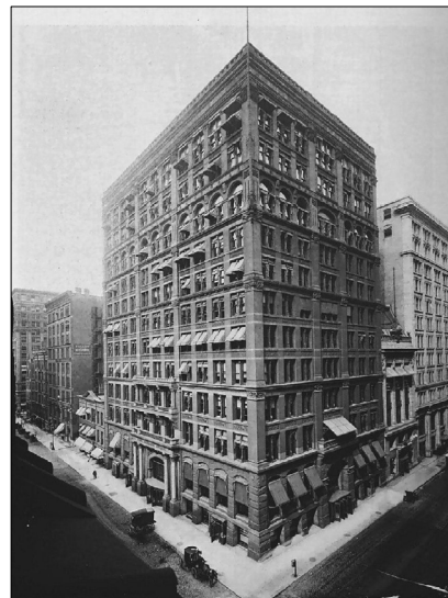
Fig. 39 Home Insurance Company (1885), premier gratte-ciel de Chicago, conçu par l'architecte William Le Baron Jenney en 1884 ; Chantier du Wainwright Building, réalisé en 1890-92 par Dankmar Adler et Louis Sullivan à St. Louis
