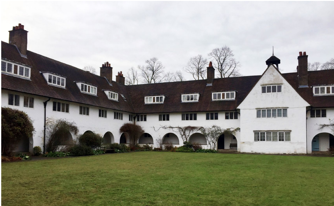
Fig. 54 Cour intérieure de Waterlow Court
