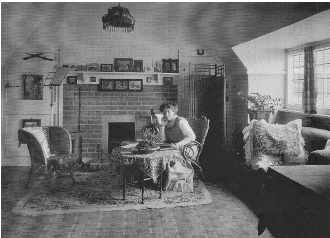
Fig. 55 Une habitante dans le salon de son appartement de Waterlow Court
