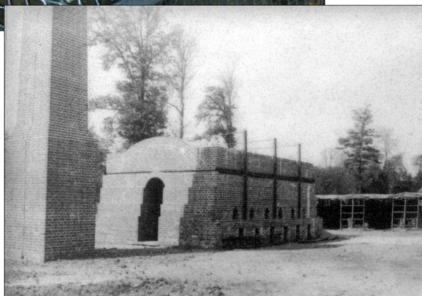
Fig. 153 Briques produites directement sur site, dans l'ancienne briquetterie de Sherrardspark Wood à Welwyn Garden City
