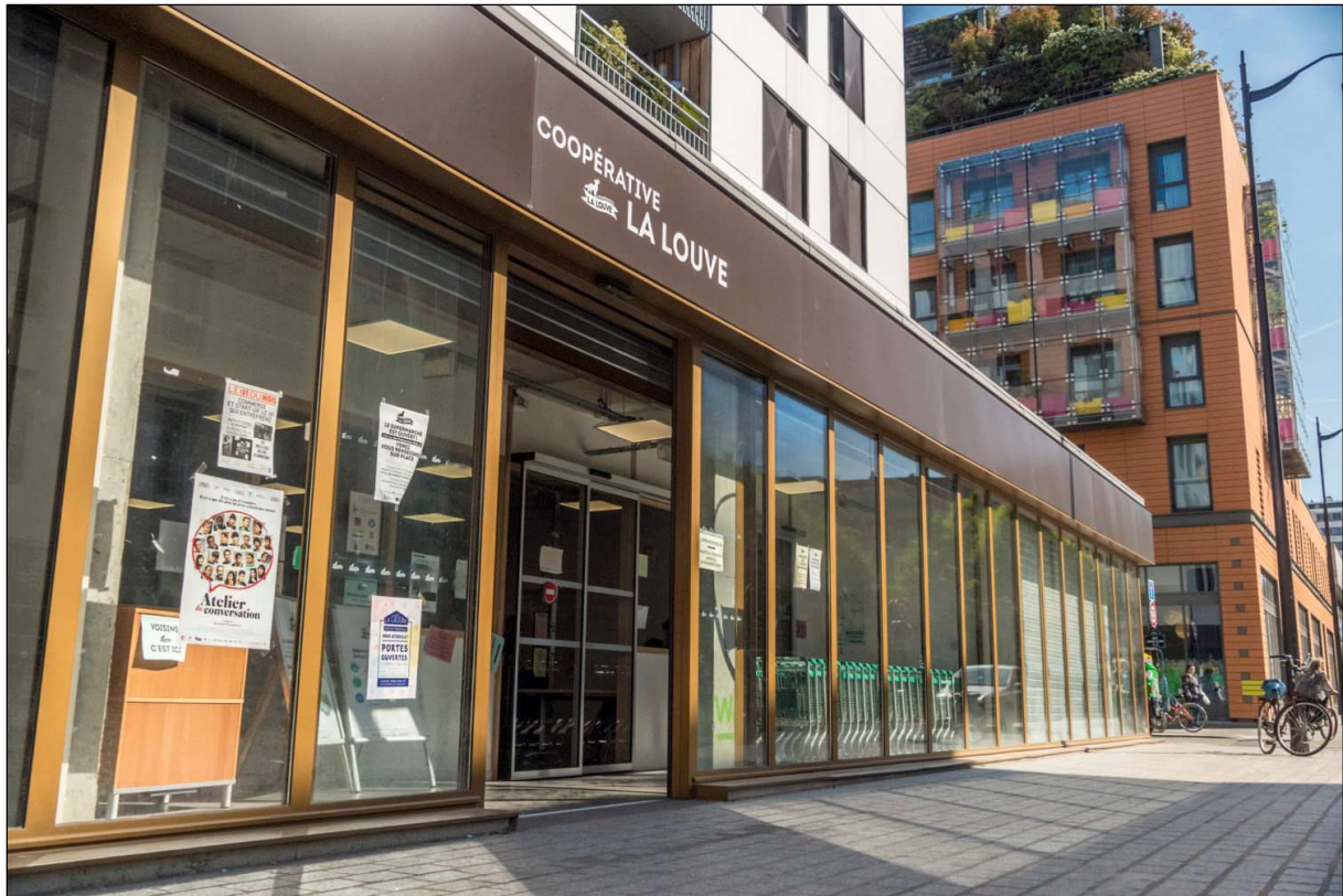
Illustration 10 : Entrée extérieure de la Louve. Crédit photo Benoît Mars
