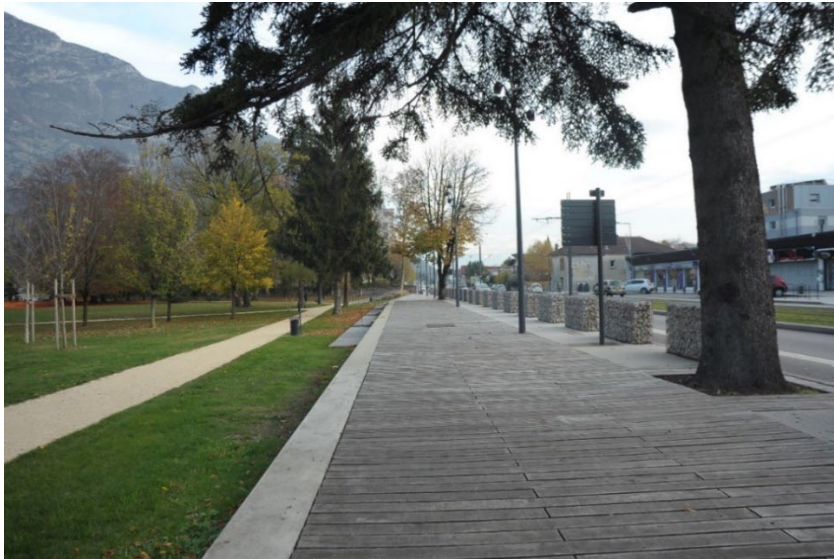
Aménagements d'espaces publics de qualité financés par l'enveloppe contrat d'axe le long de la ligne E. Source : Visite Grenoble juillet 2018.
