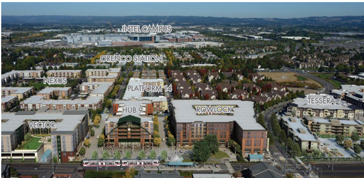
Vue aérienne montrant Platform District avec ses bâtiments imposants à usage mixte autour de la station d'Orenco. Source : Holland Partner Group Developers.
