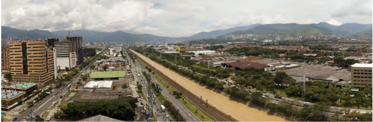
Photo du secteur du projet depuis le bâtiment Bancolombia situé près de la station Industriales. Source : Mairie de Medellín.
