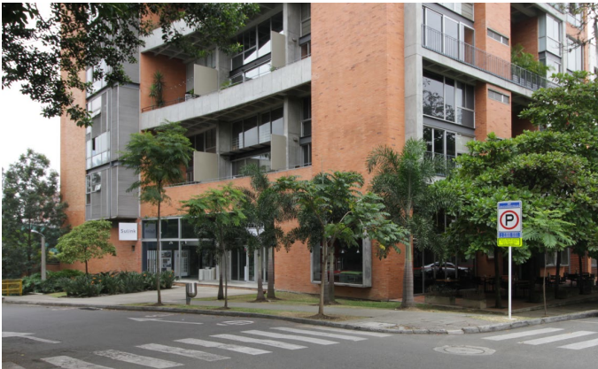
Style architectural dominant des immeubles du quartier El Poblado. Langage architectural influencé par l'architecture espagnole du siècle dernier, avec de grandes baies vitrées, et des matériaux en béton brut et brique. Source : Visite Medellín juillet 2018.
