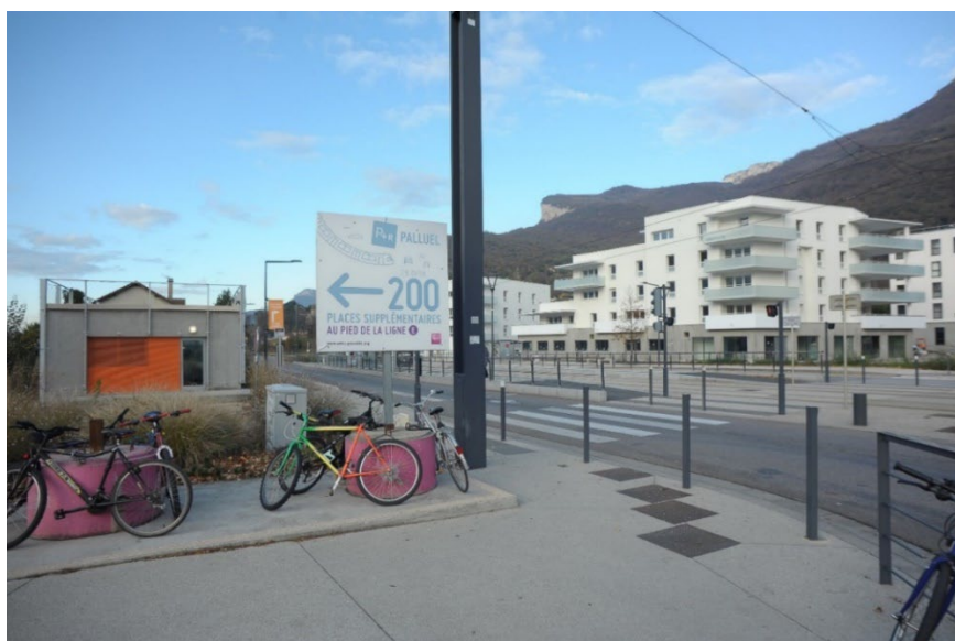
Construction de logements neufs au Fontanil-Cornillon autour de la station terminus de la ligne E. Source : Visite Grenoble juillet 2018.
