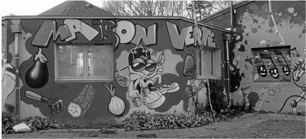
Figure 45 - Façade de la Maison Verte (© Ouest France, février 2018)
