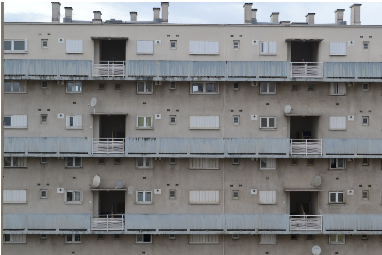
Alessia Nizovtseva, Façade d'habitation . photographie, (Architecture, Fabien Castaing, Jean-Christophe Chini, Jean Montier, 1956)
