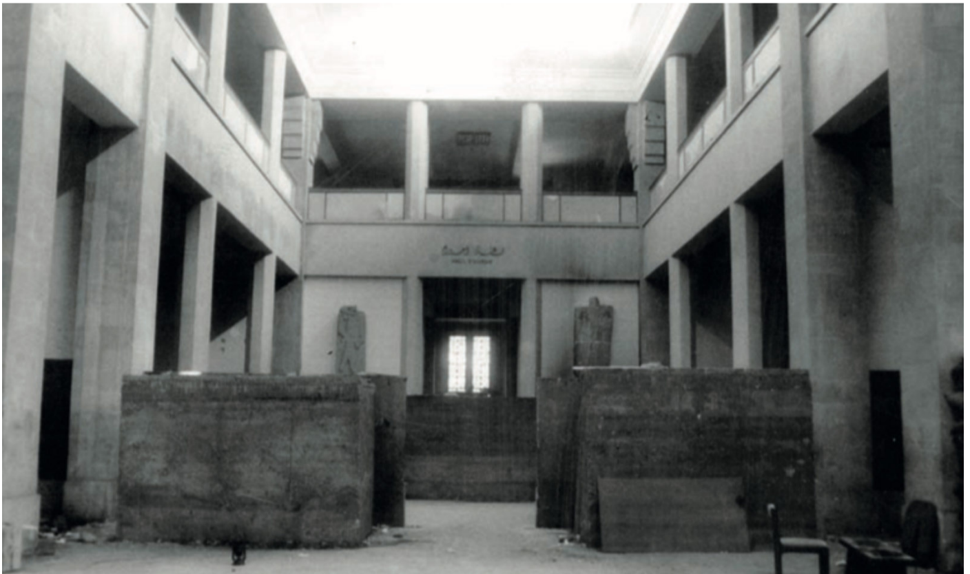
1. Vue des blocs de béton armé protégeant les oeuvres du musée national de Beyrouth ne pouvant être déplacées, 1991-1995, © Lamia Joreige, Under writing Beirut Mathaf , 2013, p. 10
