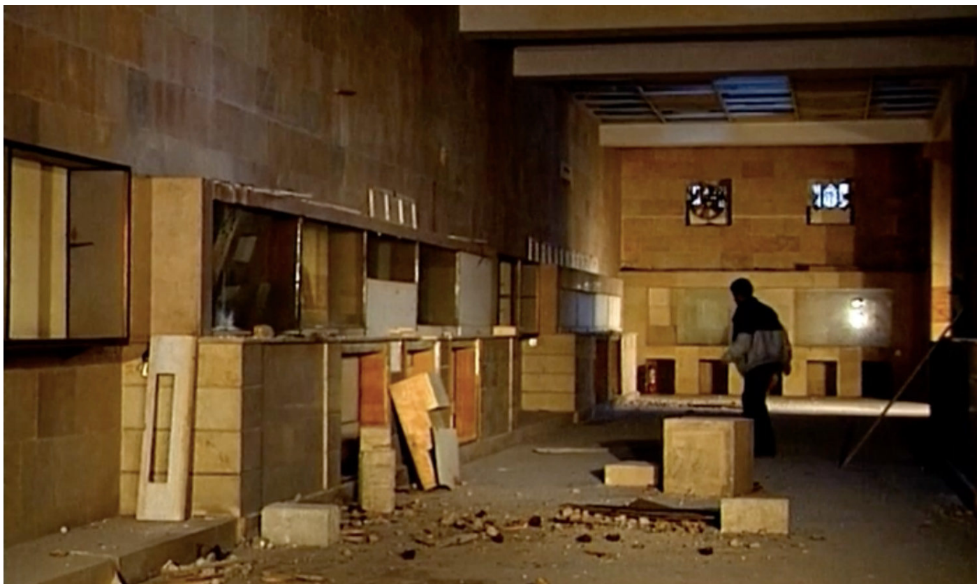
16. Vue d'une galerie du premier étage du musée national de Beyrouth, 1993 © Bahij Hojeij/DGA
