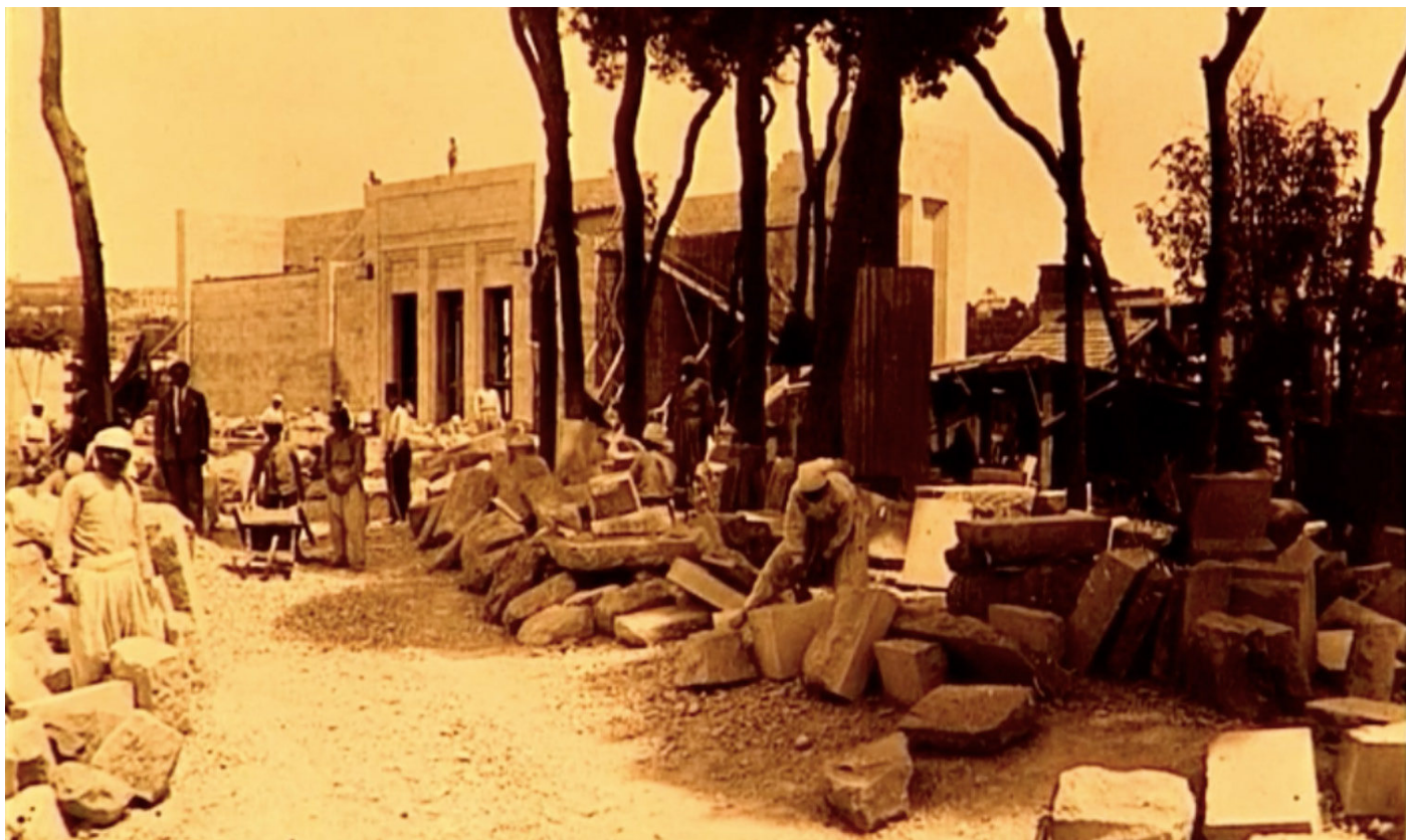
8. Construction de la façade du musée national de Beyrouth, avant 1938, © DGA
