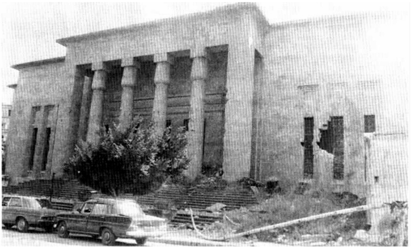
2. Vue de la façade principale du musée national de Beyrouth, 17 mars 1992, © L'Orient le Jour
