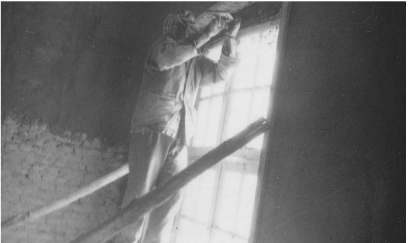
3. Ouvrier travaillant à la réhabilitation du bâtiment du musée national de Kaboul, 2000, © Ed Grazda
