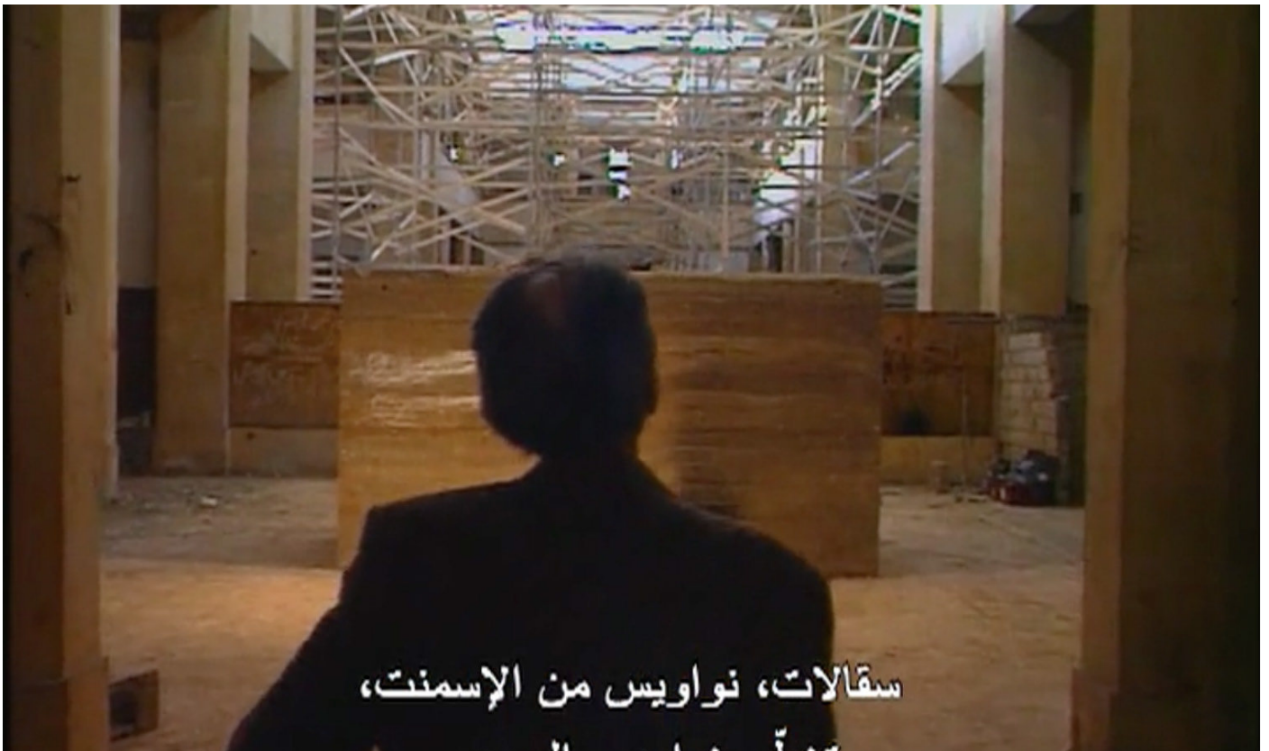
6. Vue des échafaudages à l'intérieur du musée national de Beyrouth pour stabiliser la structure du bâtiment, 1992, © Bahij Hojeij/DGA
