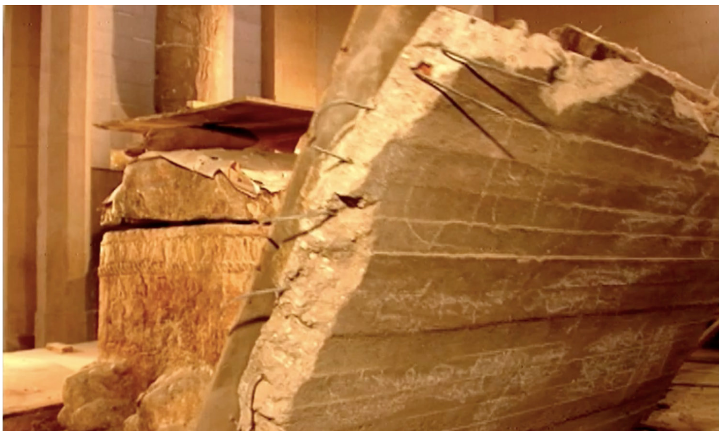
9. Ouverture des coffres de béton armé protégeant les oeuvres ne pouvant être déplacées, 1996, © Bahij Hojeij/DGA
