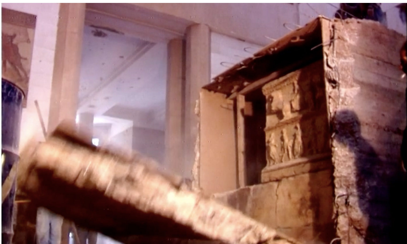
11. Ouverture des coffres de béton armé protégeant les oeuvres ne pouvant être déplacées, 1996, © Bahij Hojeij/DGA
