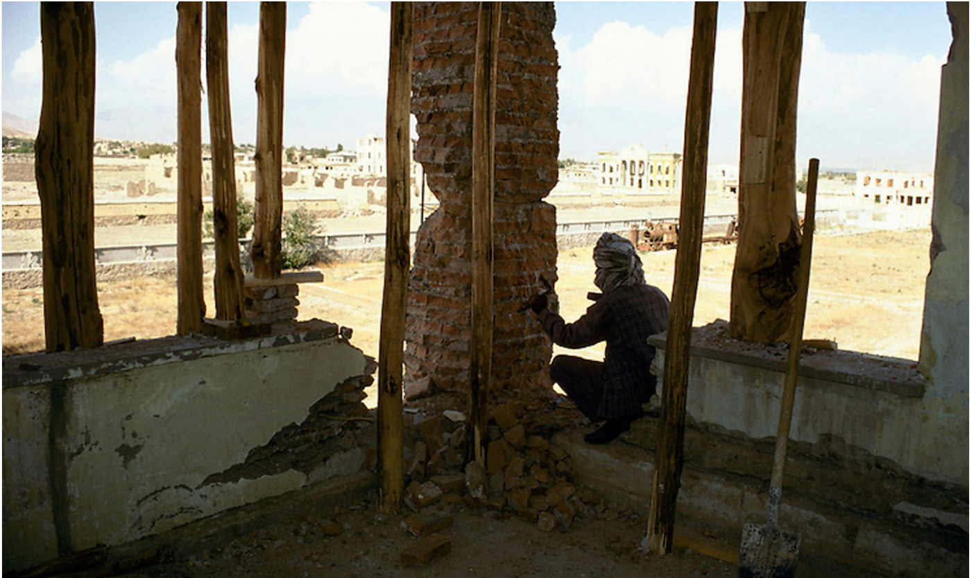
2. Ouvrier travaillant à la réhabilitation du bâtiment du musée national de Kaboul, 1999, © Swen Conrad/ Yume Vision
