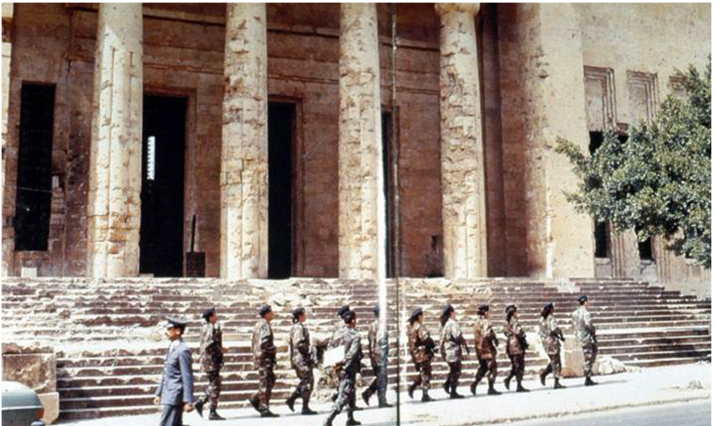
5. Vue de la façade endommagée du musée national de Beyrouth, 1975-1978, © DGA
