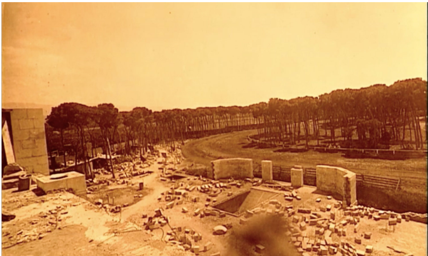
4. Vue de l'avancement des travaux du musée national de Beyrouth côté hippodrome, avant 1938, © DGA/Bahij Hojeij
