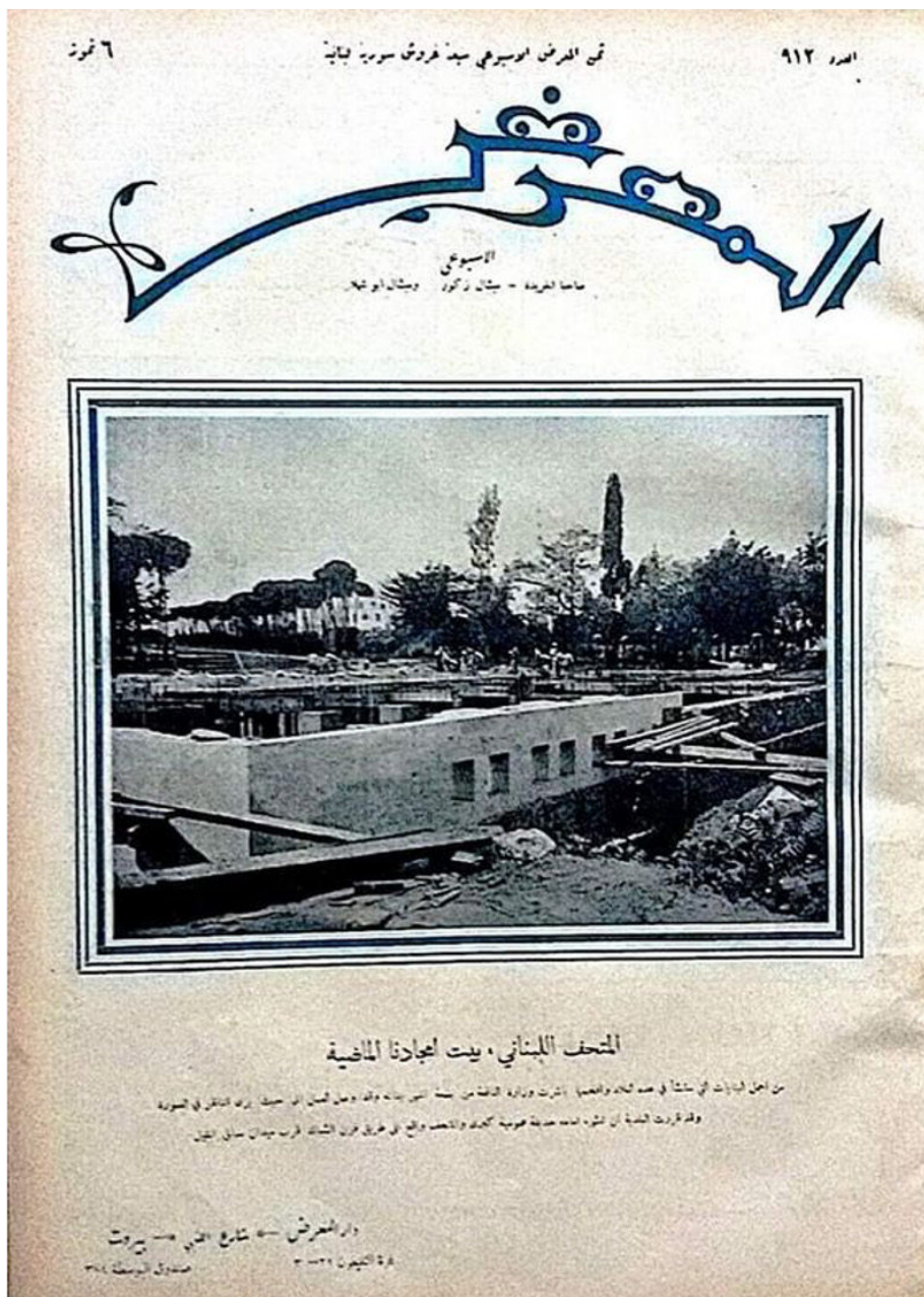
1. L'état d'avancement des travaux du musée de Beyrouth, 1930, © Al Maarad
