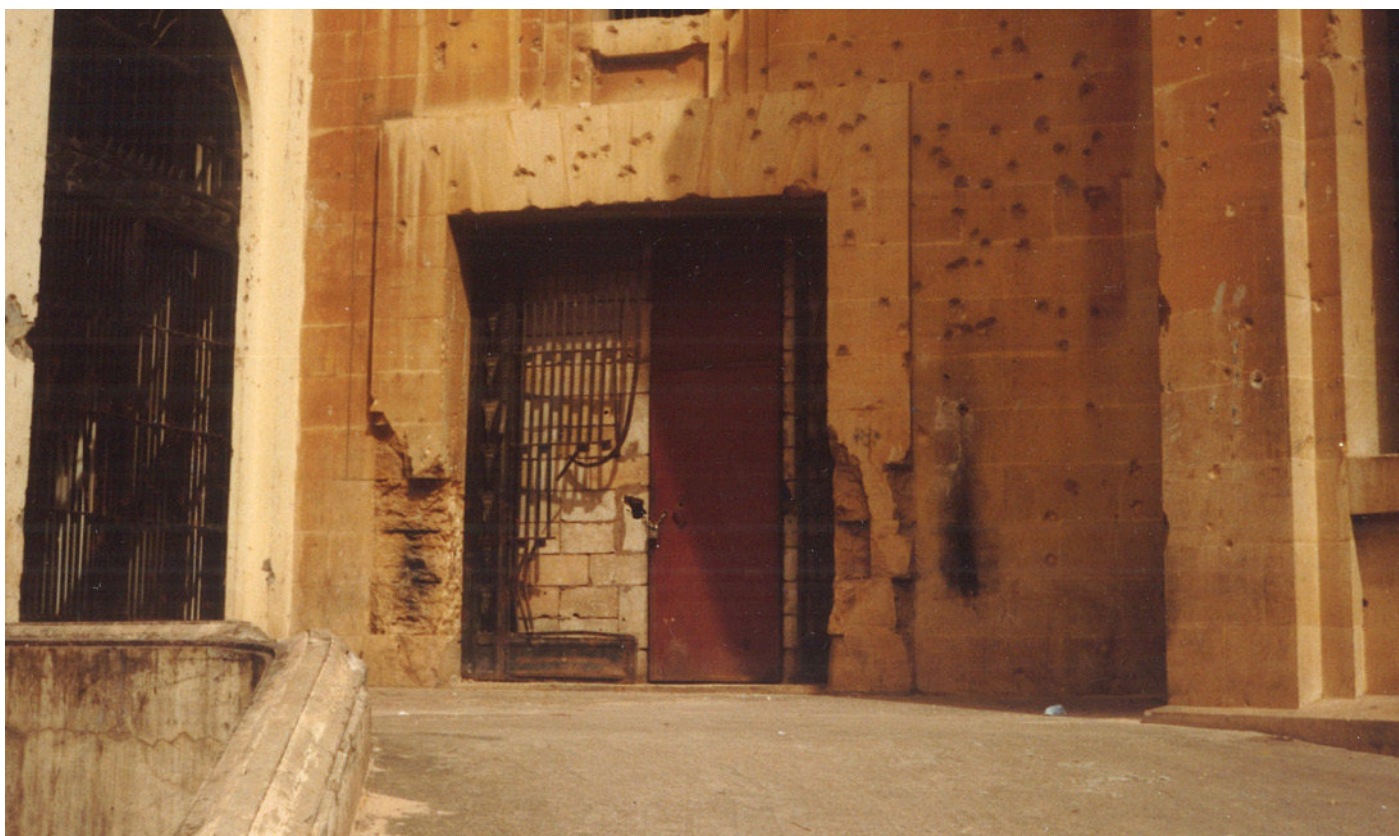
8. Vue de la porte latérale est du musée renforcée par une porte métallique et un mur en maçonnerie, 1975-1995, © DGA.
