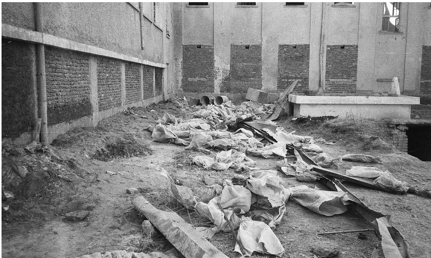
11. Travaux de renforcement des fenêtres du musée national de Kaboul par des murs en briques, 1994-1996, © Musée national d'Afghanistan
