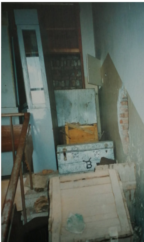
8. Vue de l'escalier menant au premier étage rempli de caisses d'objets probablement évacués du premier étage, 1995, © Pierre Cambon
