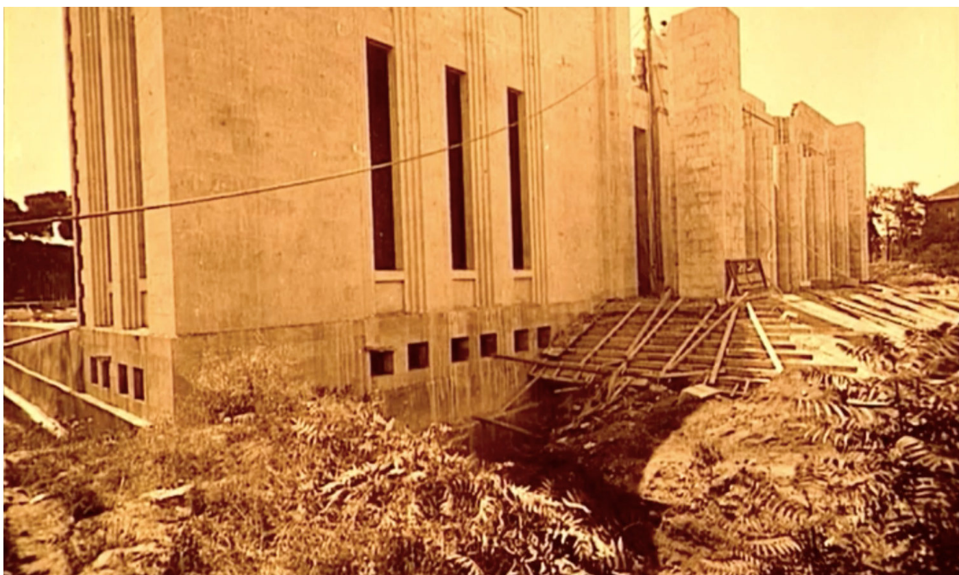
5. Construction de la façade du musée national de Beyrouth, avant 1938, © DGA/Bahij Hojeij
