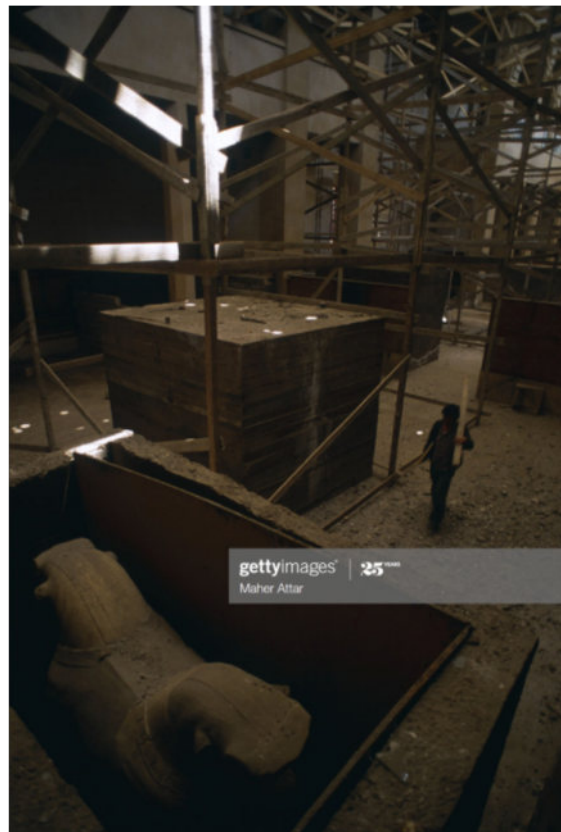
7. Vue des échafaudages à l'intérieur du musée national de Beyrouth pour stabiliser la structure du bâtiment, 1999, © Mahar Attar/Getty images
