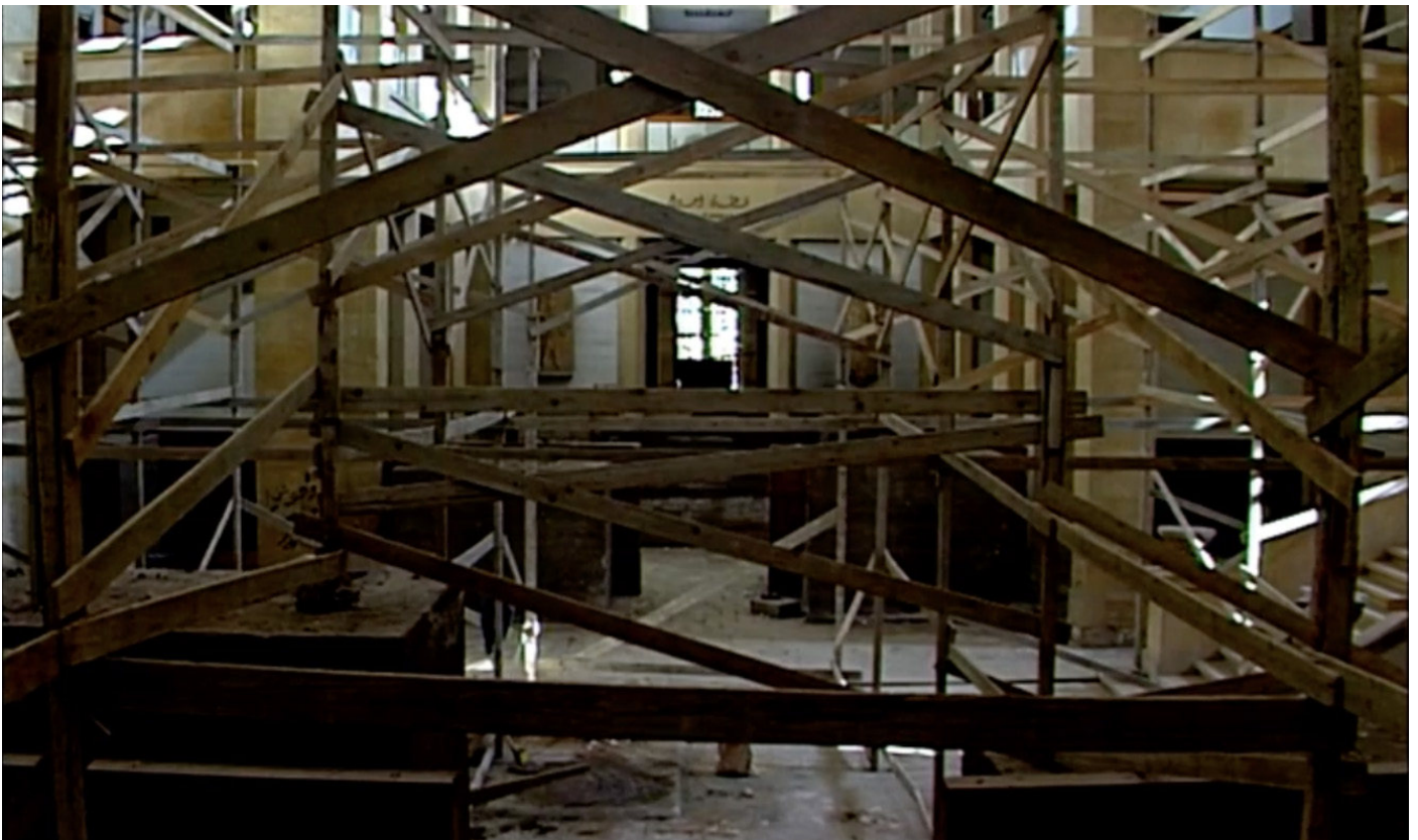
5. Vue des échafaudages à l'intérieur du musée national de Beyrouth pour stabiliser la structure du bâtiment, 1999, © Bahij Hojeij/DGA
