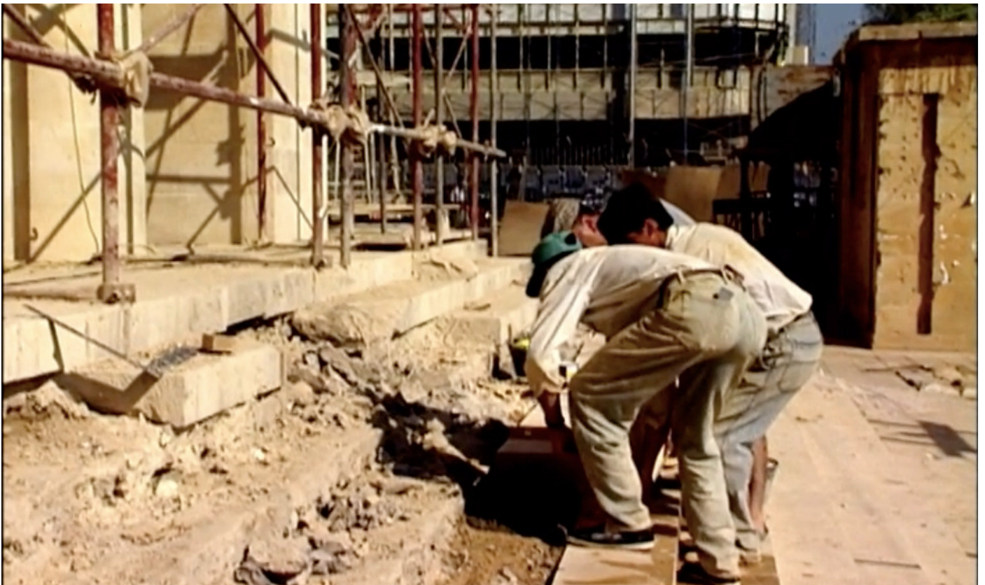
3. Travaux de reconstruction des marches du musée national de Beyrouth, 1996, © Bahij Hojeij/DGA
