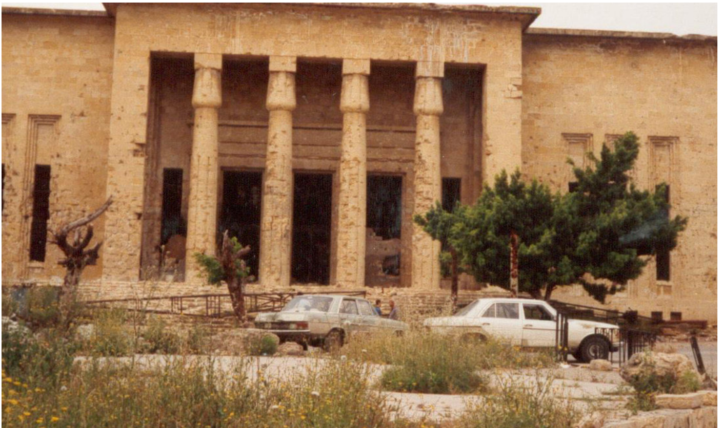
3. Vue de la façade principale du musée national de Beyrouth avec une barrière métallique pouvant indiquer la trace d'un ancien barrage, 1991-1995, © Suzy Hakimian
