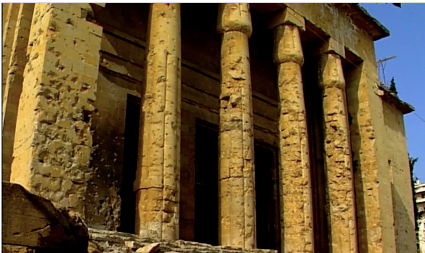
4. Les éclats de balles sur la façade du musée national de Beyrouth, 1993 © Bahij Hojeij/DGA
