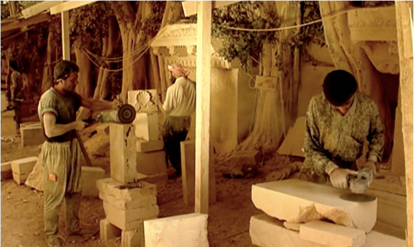
4. Travaux de reconstruction des marches du musée national de Beyrouth, 1996, © Bahij Hojeij/DGA
