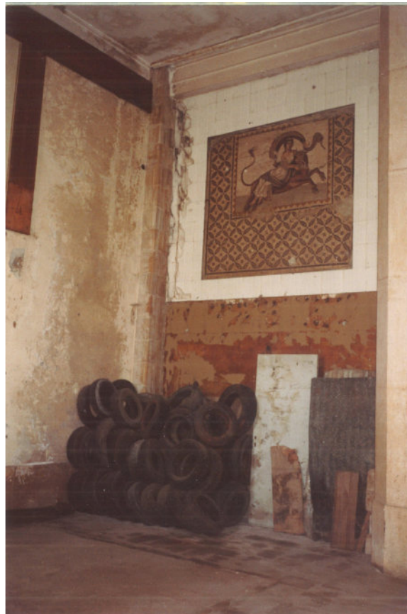
9. Vue d'une galerie du rez-de-chaussée du national de Beyrouth, 1991-1993, © DGA
