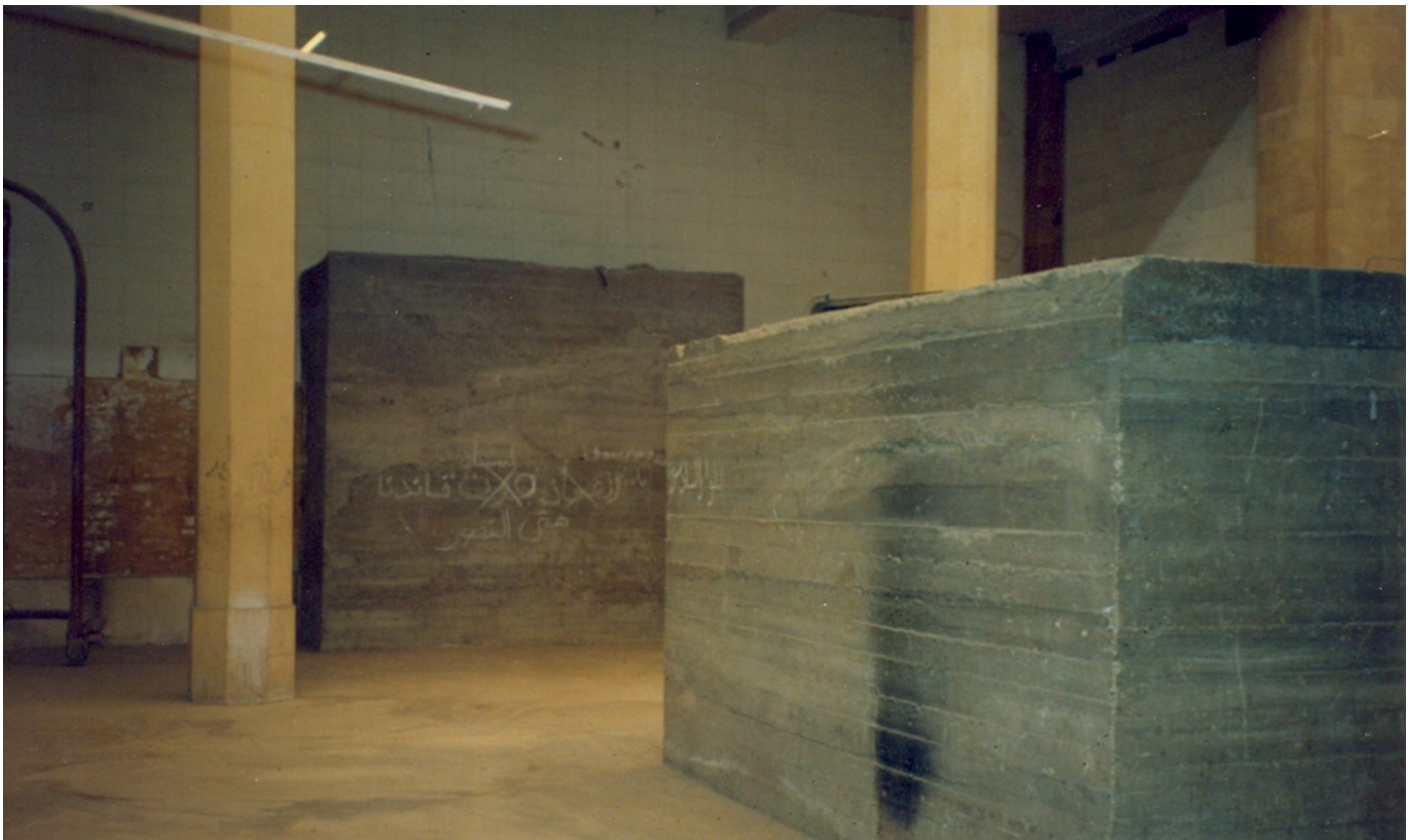
3. Vue des blocs de béton armé protégeant les oeuvres du musée national de Beyrouth ne pouvant être déplacées, 1991-1995, © Suzy Hakimian
