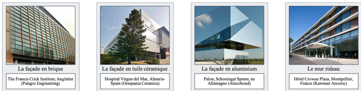
Figure 1.11 Exemples de projets de construction réalisés avec un système de parois ventilées
