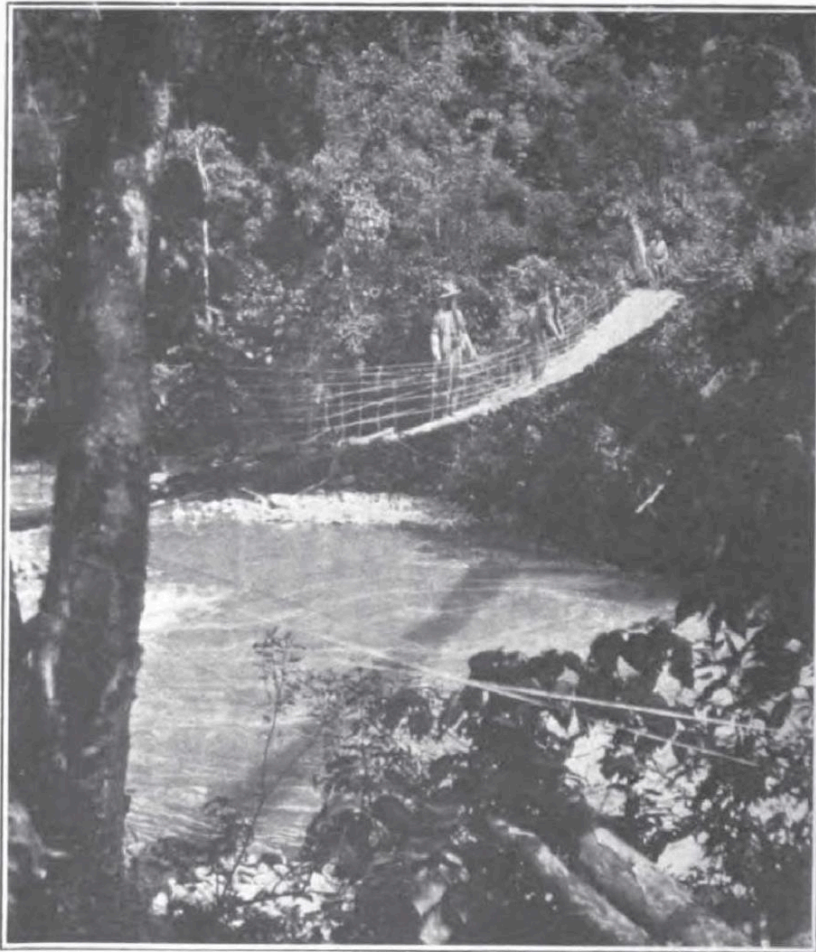
Figure 54. « Pont fait de câbles métalliques sur la rivière Bermejo, proche de Baeza, dans la partie orientale de l'Equateur. » Photo de George F. Fisher, publiée dans Pound et al. (1912).
