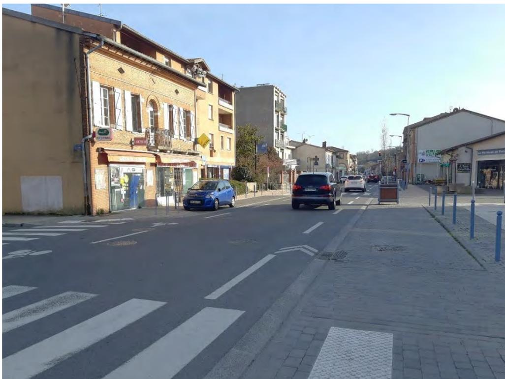
Figure 8.18 : Chaussée à voie centrale banalisée, avenue de Toulouse à Castanet-Tolosan – Photo personnelle, 13 février 2022
