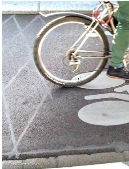
Figure 4.16 : Une boucle ZELT sur un aménagement cyclable – Source : Eco-Compteur
