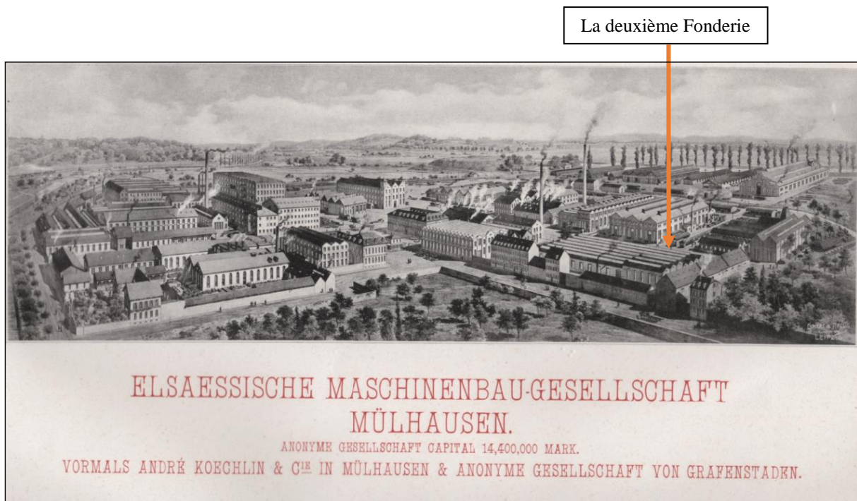
Figure 162 : Mulhouse, la SACM en 1900, la deuxième fonderie
