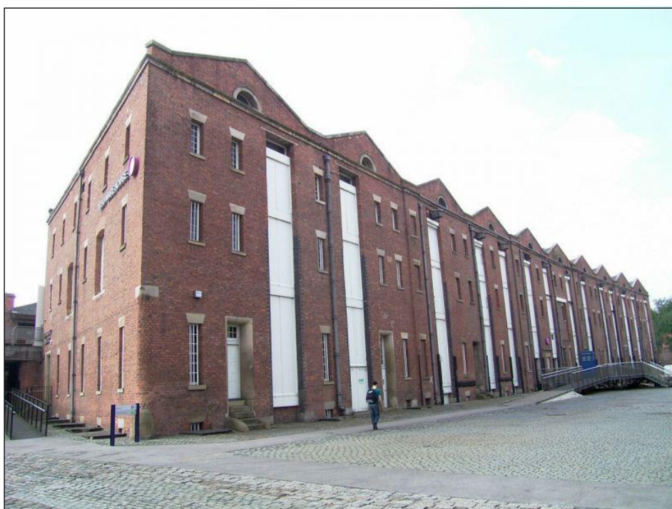
Figure 139 : Les entrepôts de Liverpool Road 574
