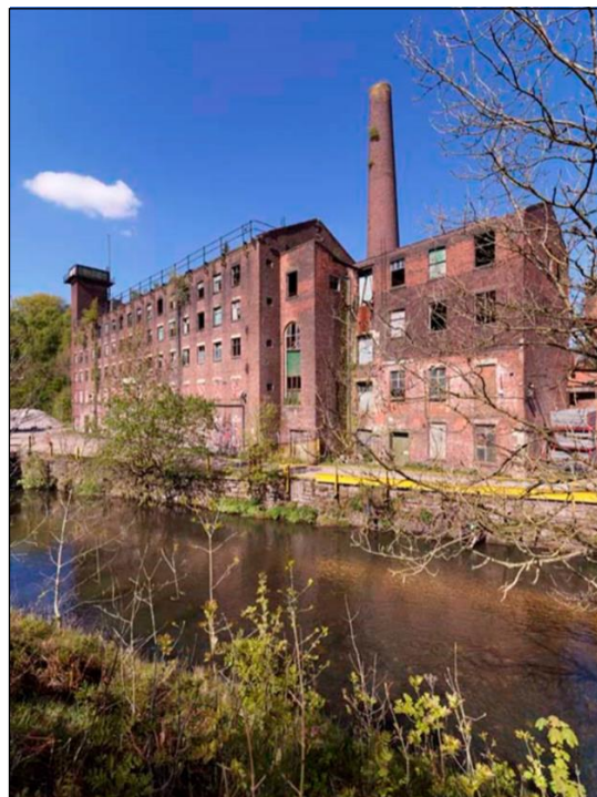
Figure 124 : Crimble Mill , vue avant, le long de la rivière Roch au premier plan (2018) 544
