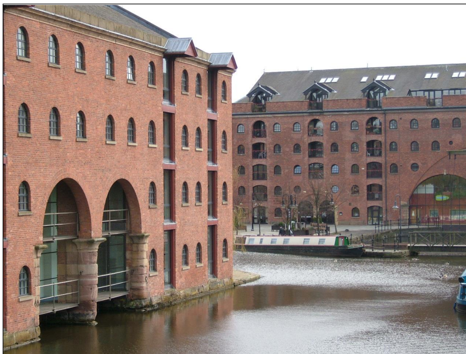
Figure 138 : Castelfield , Merchants' Warehouse (1825) au premier plan et Middle Warehouse (1828-1831) au second plan 573
