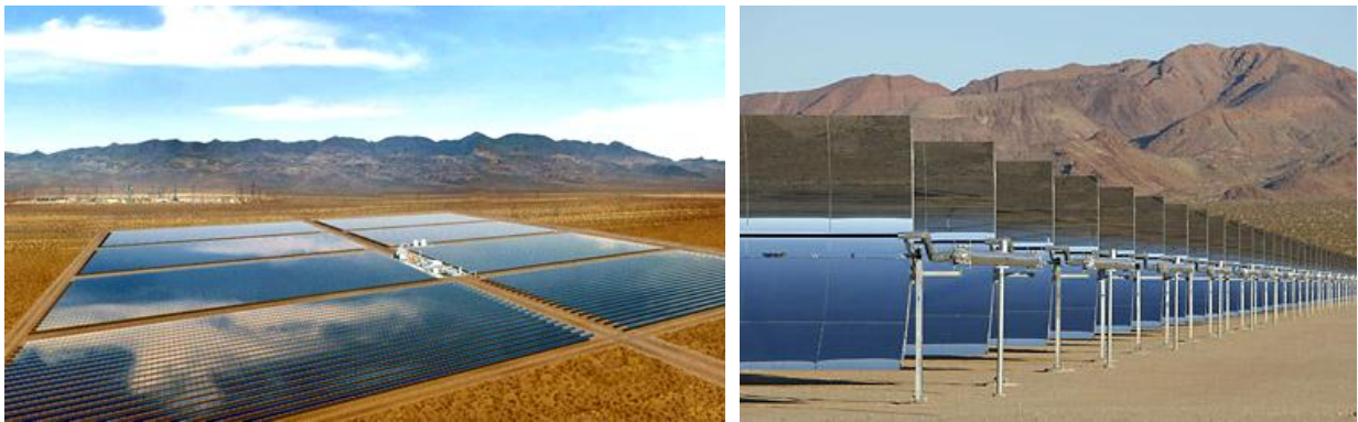
Figure 2 : Centrale utilisant la technologie cylindro-parabolique de Nevada Solar One (Nevada, Etats-Unis) [10]
