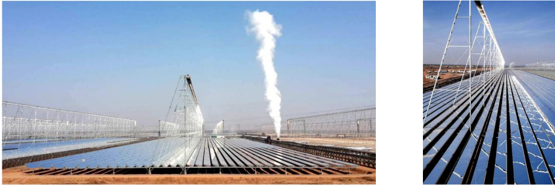
Figure 6 : Centrale utilisant la technologie linéaire Fresnel de Dhursar (Rajasthan, Inde) [17]
