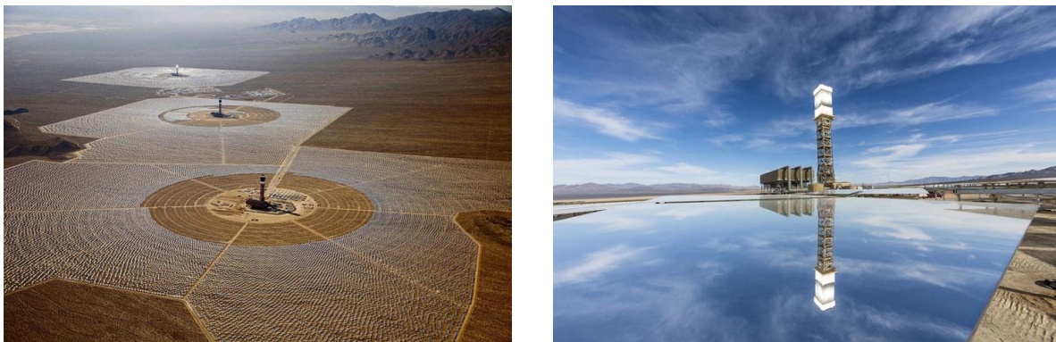
Figure 3 : Centrale solaire à tour d'Ivanpah (Californie, Etats-Unis) [12] [13]
