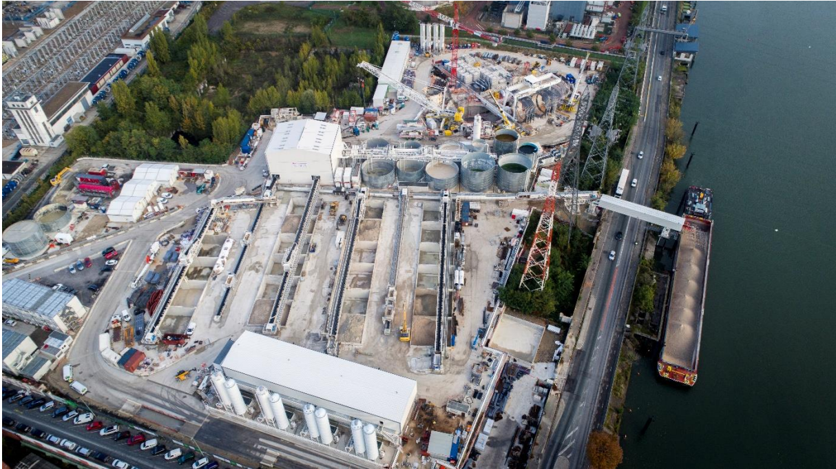
Figure b: Exemple de chantier de creusement de tunnel (Ligne 15 sud, chantier T2A entre les gares de Villejuif Louis-Aragon et Créteil l'Echat). En surface, la majeure partie du terrain est destinée au traitement, au stockage et à l'évacuation (par voie fluviale dans ce cas) des terres excavées. © Bouygues TP
