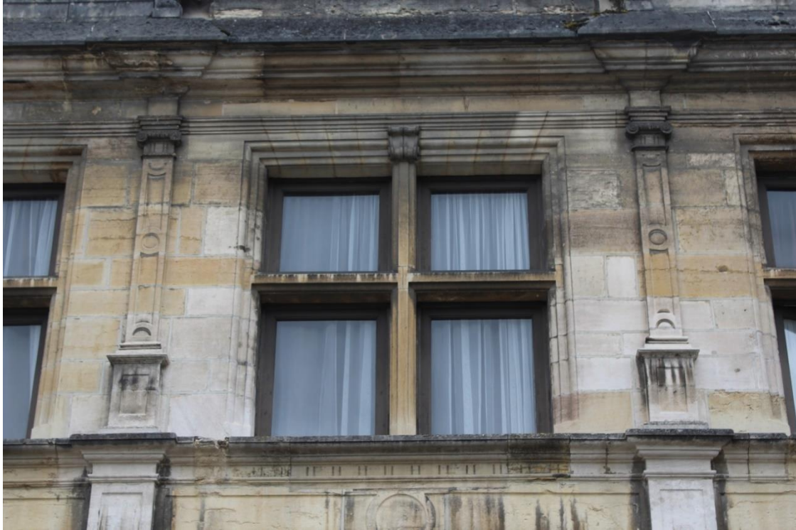
fig. 202 : Fenêtre à croisée centrale à l'étage de la façade principale de l'hôtel Bénigne de Serre à Dijon [21231-77]
