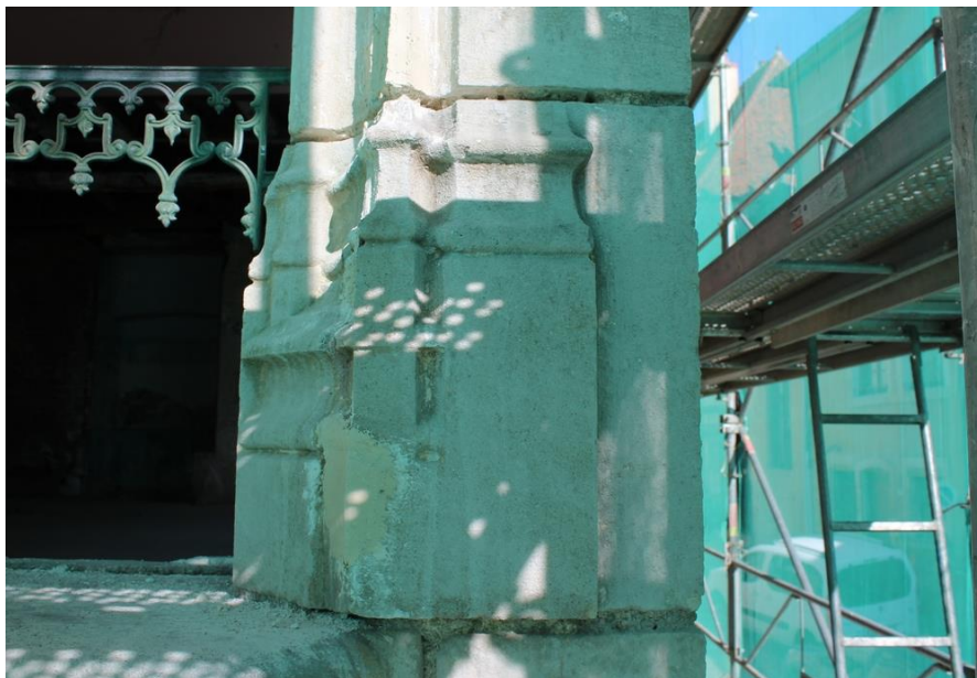
fig. 380 : Semur-en-Auxois [21603-64] : base réticulée moulurée de la haute fenêtre à l'étage en M4, cliché A. Lacaille
