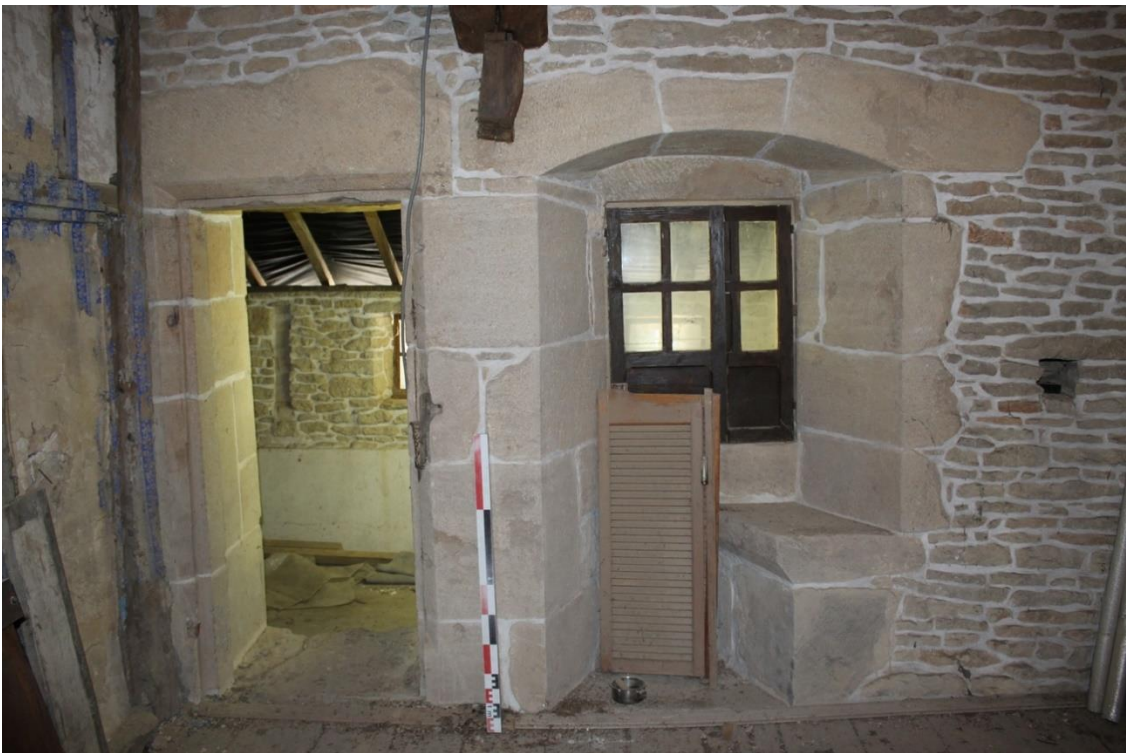
fig. 321 : Pouilly-en-Auxois [21501-6] : ouvertures percées dans le mur M3 à l'étage, vue vers l'ouest, cliché A. Lacaille
