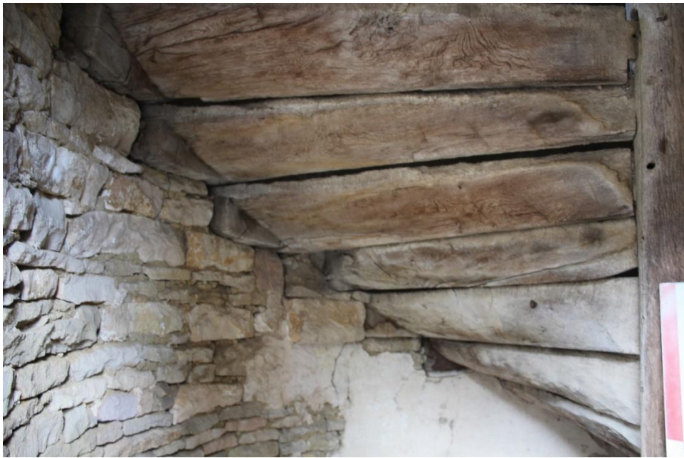
fig. 177 : Détail de la forme des degrés en bois de l'escalier (VIS70) à Fontaine-lès-Dijon
