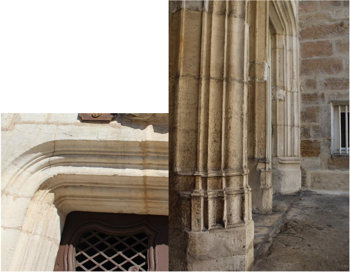
fig. 220 : Mouluration de baies de la Maison Pétral à Beaune : porte d'entrée depuis la place Monge et ouvertures en rez-de-chaussée de la façade arrière du corps de logis principal
