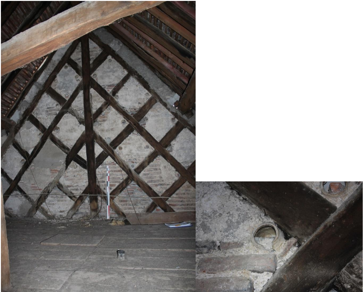
fig. 121 : Pignon sur cour de la maison [21023-8] d'Arnay-le-Duc avec des pots en terre-cuite emmurés
