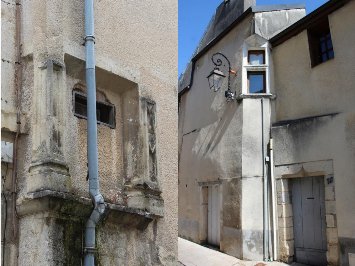
fig. 465 : Exemples de fenêtres d'angle à Fontaine-lès-Dijon [21278-13] et Montbard [21425-6]
