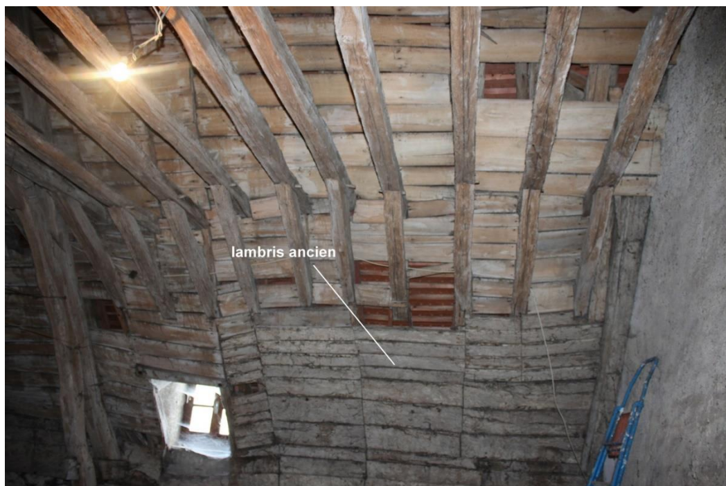
fig. 159 : Vestiges de lambris ancien sous la charpente de Pouilly-en-Auxois [21501-5]
