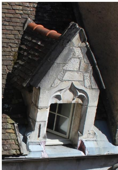
façade ouest du corps de logis secondaire
