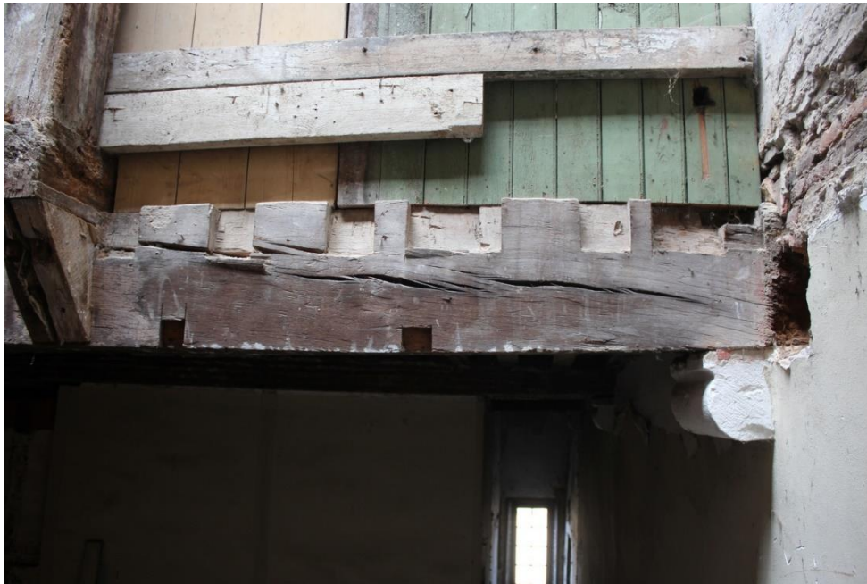
fig. 409 : Auxonne [21038-22] : profil du plafond de l'espace B du côté de l'escalier actuel (angle nord-est de la pièce), cliché A. Lacaille
