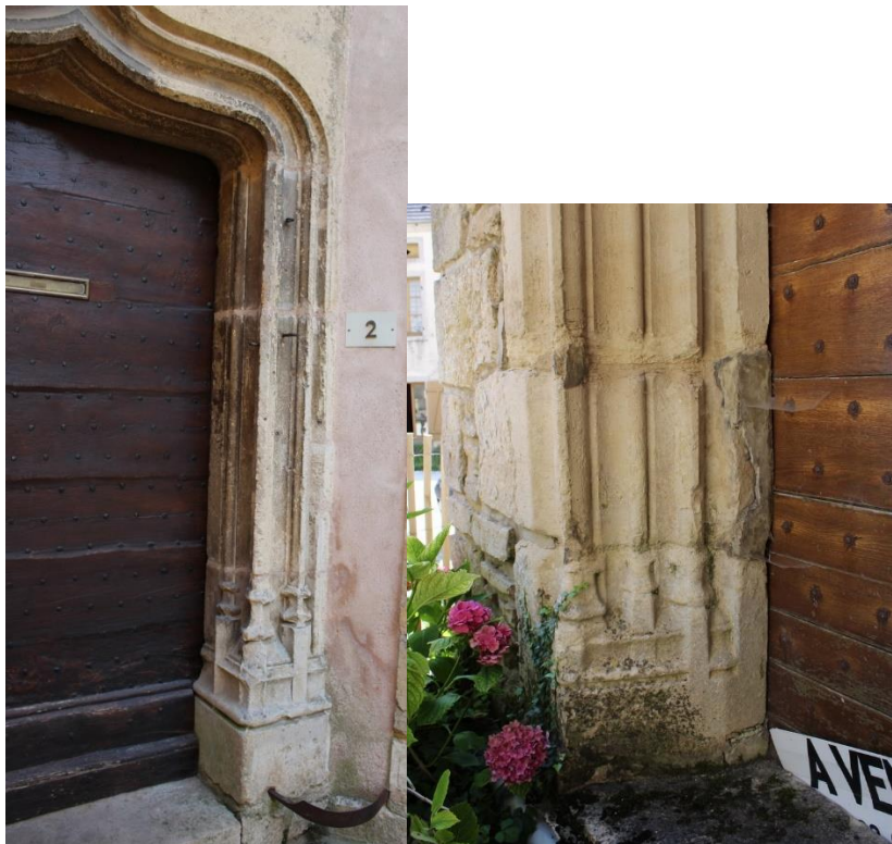
fig. 219 : Mouluration de la base de piédroit de porte d'accès à la tourelle d'escalier à Semur-en-Auxois [21603-59] et Mont-Saint-Jean [21441-10]
