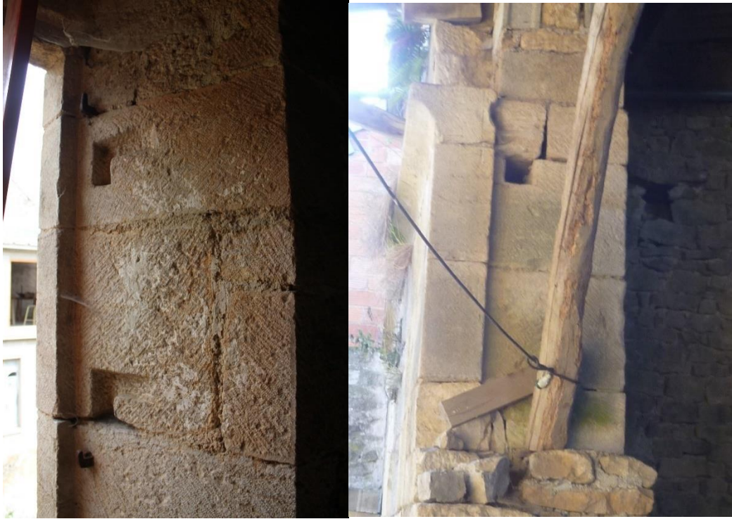
fig. 471 : Gonds et encoches pour la pose de barres en bois sur le piédroit sud de la fenêtre à croisée d'étage et trou d'épars sur le piédroit sud d'une porte d'étage de Vitteaux [21710-6]
