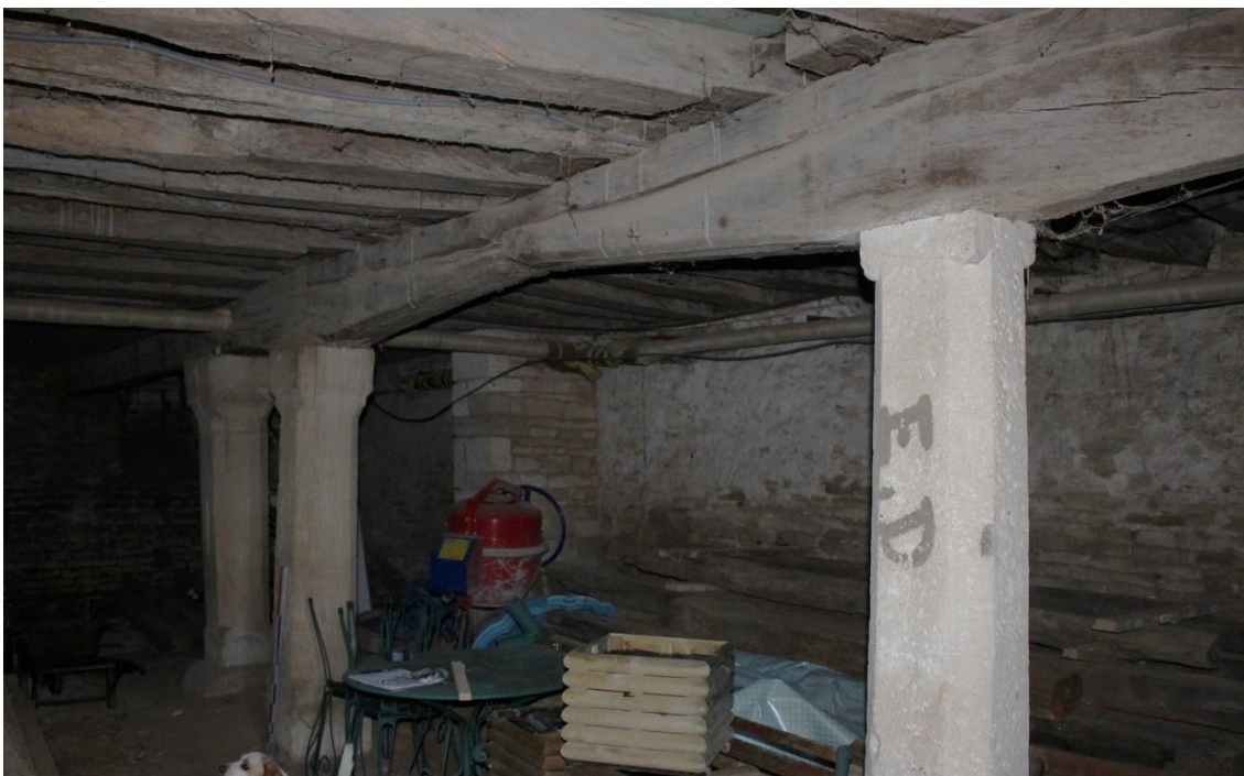
fig. 122 : Cave de Saulx-le-Duc [21587-1] avec sommier du plafond sur piliers, vue vers l'ouest
