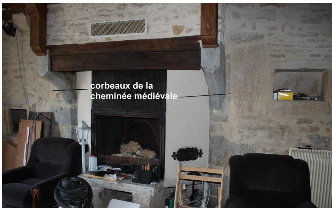
fig. 317 : Pouilly-en-Auxois [21501-6] : cheminée du mur M4 au rez-de-chaussée, cliché A. Lacaille
