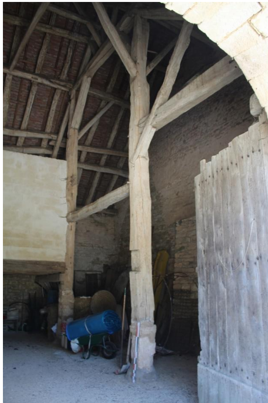
fig. 515 : Maison-halle accolée à une demeure seigneuriale à tourelle : vue générale depuis la cour et intérieur de la grange
