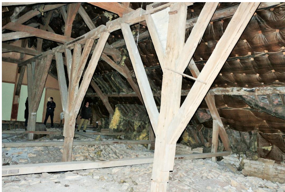
fig. 152 : Vestiges de la charpente ancienne du Cellier de Clairvaux [21231-107] à Dijon (cliché S. Aumard)
