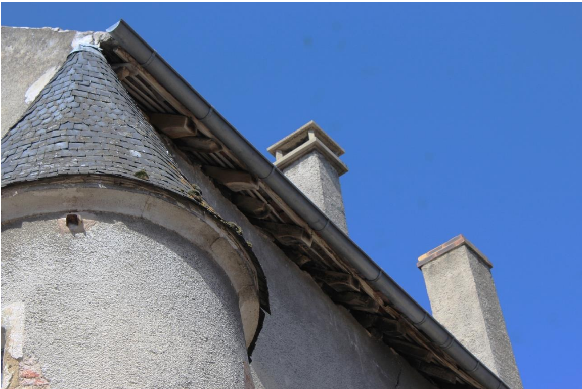
fig. 161 : Chevrons débordants formant avant-toit de la façade gouttereau de Molinot [21420-2]
