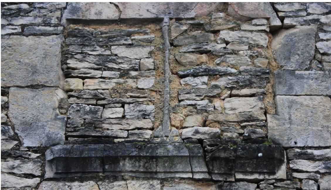
fig. 225 : Forme d'amorti du chanfrein assez originale pour une fenêtre à meneau à l'étage d'Agey [21002-2]
