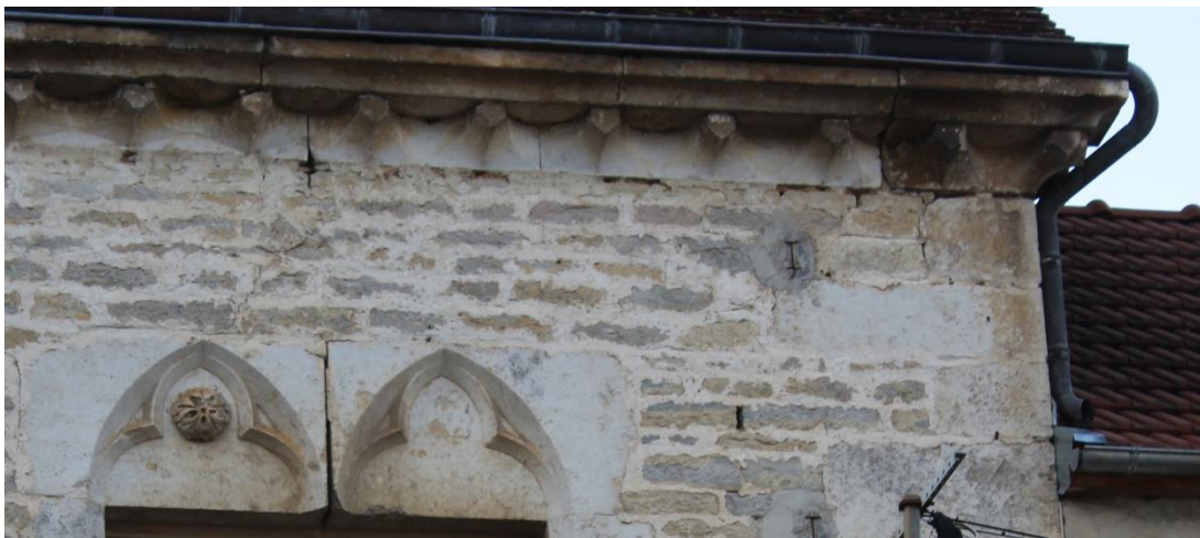
fig. 117 : Corniche à modillons sur la façade gouttereau sur rue de Châtillon-sur-Seine [21154-5]
