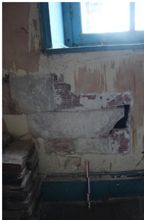
fig. 422 : Auxonne [21038-22] : sondage de l'enduit permettant d'attester la présence d'un coussiège pour la fenêtre à croisée à l'étage de M3, cliché A. Lacaille
