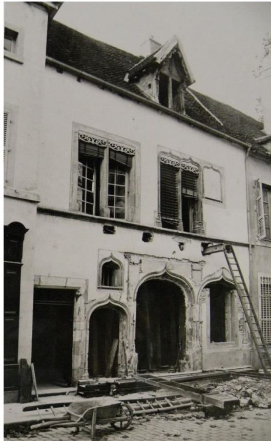
fig. 14 : Façade en cours de réfection de la maison 16 rue Maufoux à Beaune [21054-24], 1910 (AM Beaune 42W119).
