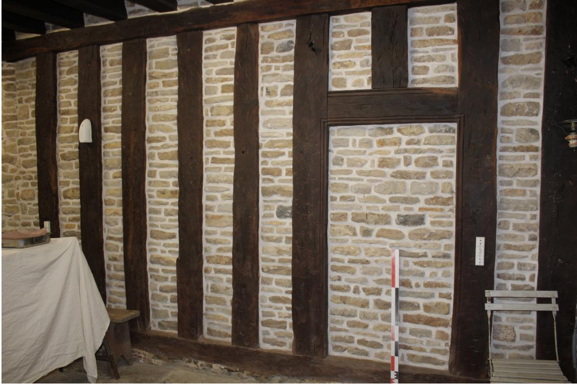
fig. 316 : Pouilly-en-Auxois [21501-6] : cloison nord d'axe est-ouest, au niveau du rez-de-chaussée, vue vers le sud, cliché A. Lacaille
