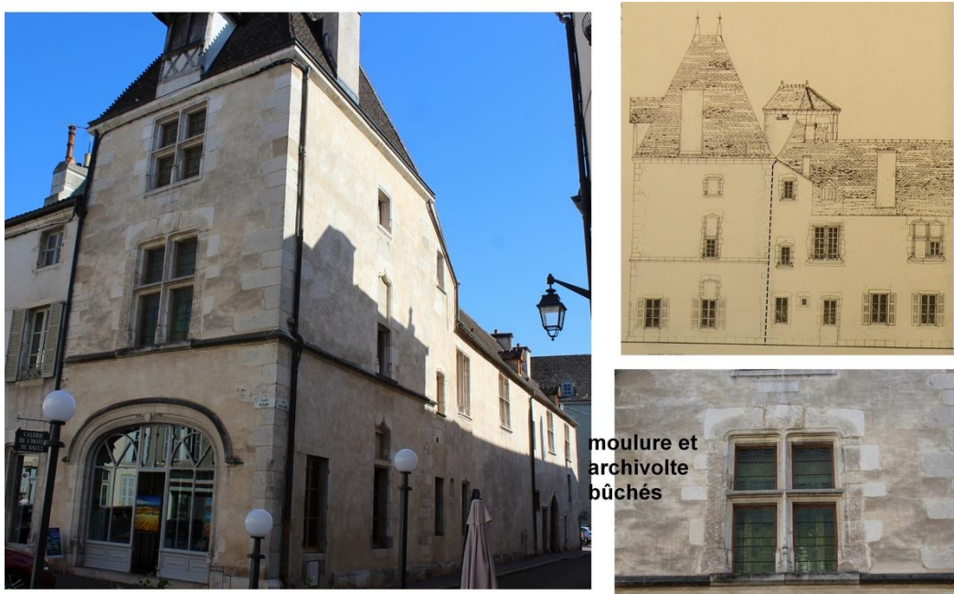
fig. 460 : Corps de logis principal de l'hôtel de Saulx à Beaune [21054-28] : vue générale, relevé de la façade ouest (F. Didier 1989) et détail d'une ouverture à l'étage
