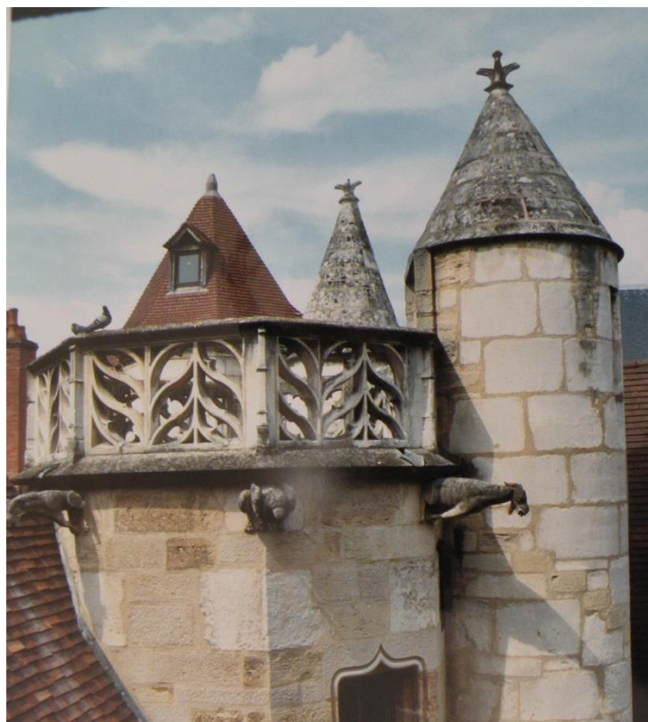
fig. 170 : Toitures en pierre des petites tourelles d'escalier latérales secondaires d'accès aux parties hautes de l'escalier et du bâtiment de la chapelle de l'hôtel Chambellan [21231-30] (CRMH Bourgogne-Franche-Comté)
