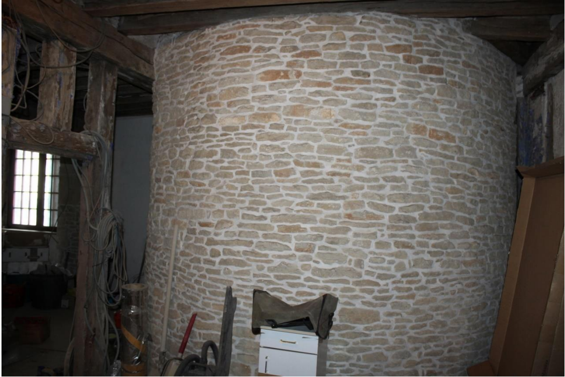
fig. 320 : Pouilly-en-Auxois [21501-6] : aspect de la cage d'escalier en vis au niveau de l'étage, cliché A. Lacaille
