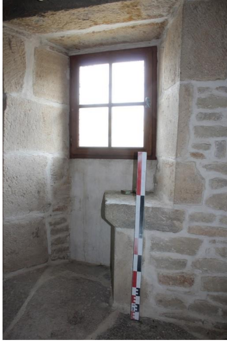
fig. 335 : Pouilly-en-Auxois [21501-6] : baie à coussiège qui ajoure l'escalier à vis en M1 au niveau de l'étage, cliché A. Lacaille
