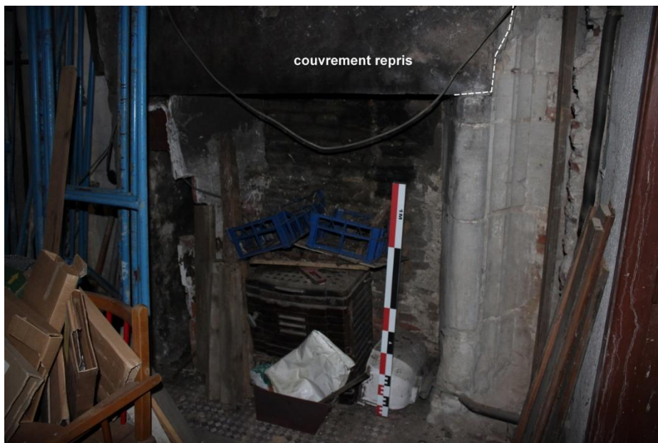
fig. 404 : Auxonne [21038-22] : vestiges d'une cheminée à colonnettes, contre le mur M2 au rez-de-chaussée de l'espace B, cliché A. Lacaille
