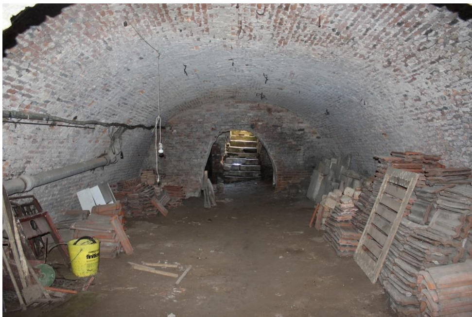
fig. 399 : Auxonne [21038-22] : la cave voûtée du côté oriental de l'espace B, vue depuis l'est, cliché A. Lacaille
