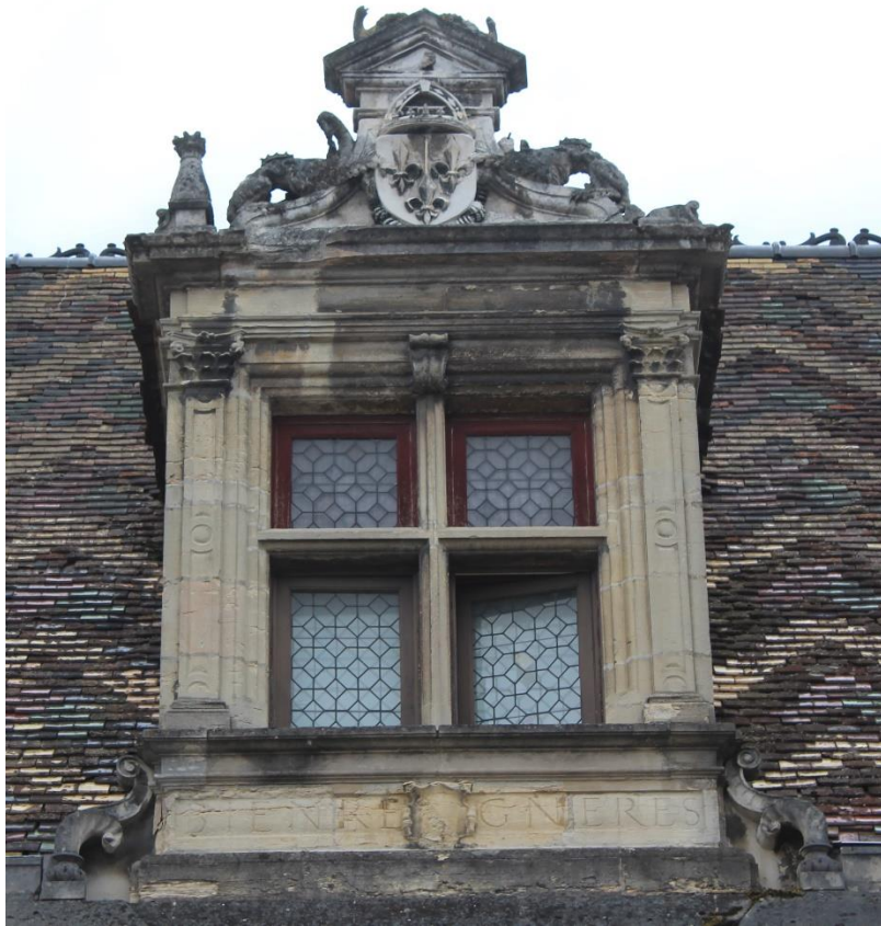
fig. 246 : Lucarne de la façade nord de l'hôtel Bénigne de Serre [21231-77]
