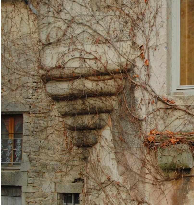
fig. 116 : Encorbellement à la base du pan coupé de la façade pignon sud de Flavigny-sur-Ozerain [21271-34]
