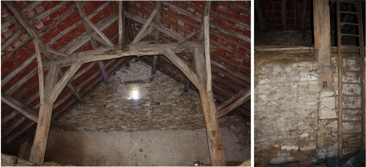
fig. 68 : Partie supérieure d'une ferme et élément de support de la charpente de la grange [21441-3] à Mont-Saint-Jean
