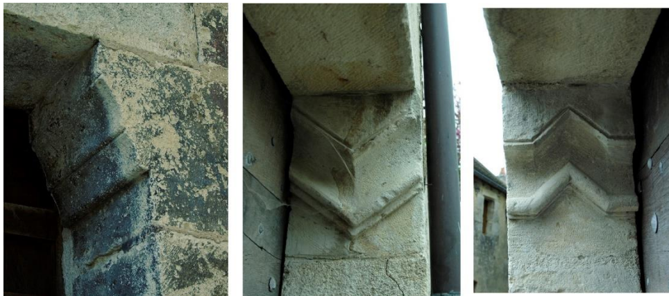
fig. 231 : Coussinets des portes d'accès à Flavigny-sur-Ozerain [21271-5] et [21271-111]
