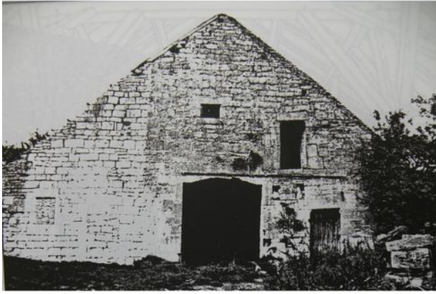
Chanceaux [21142-17] (LASSURE Christian, « Une grange à dîmes du XVI e siècle à Poncey-sur-l'IGNON (Côte-d'Or) », dans Architecture Vernaculaire T. XII (1988), p. 27-47.
