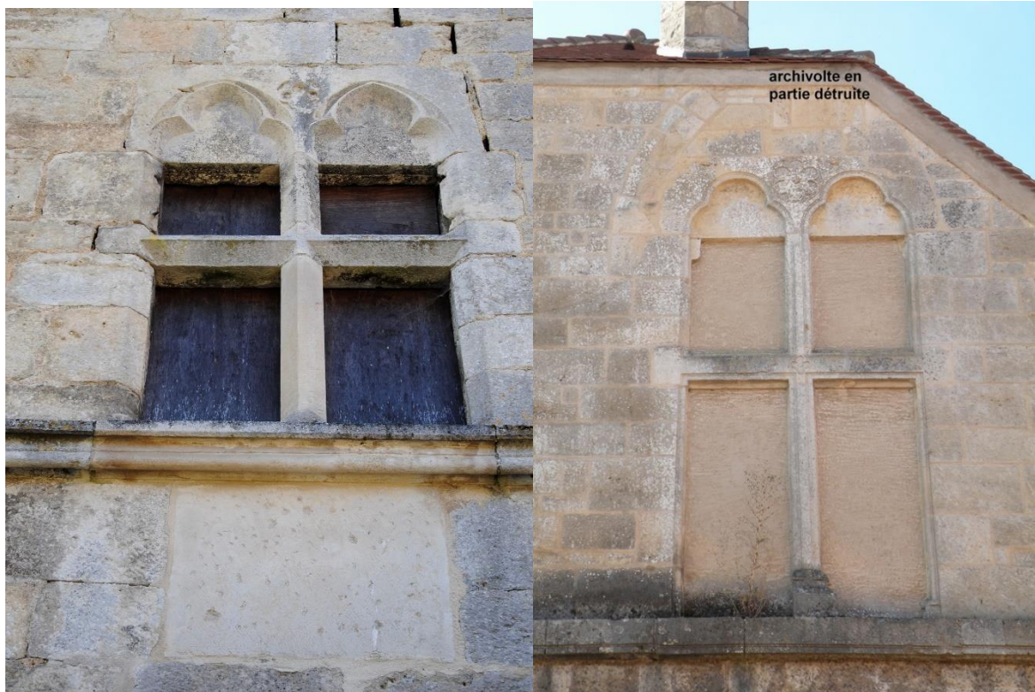
fig. 239 : Fenêtres à croisée à Flavigny-sur-Ozerain [21271-56] et Poiseul-la-Ville-et-Laperrière [21490-2]
