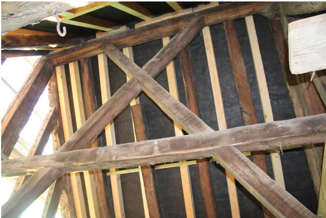
fig. 362 : Semur-en-Auxois [21603-64] : contreventement de la charpente en croix de Saint-André entre les deux fermes sud, cliché A. Lacaille
