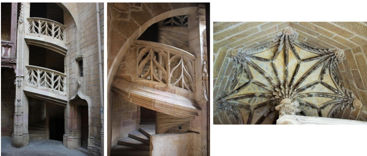
fig. 179 : Détails de l'escalier en vis (VIS73) de l'hôtel Chambellan à Dijon
