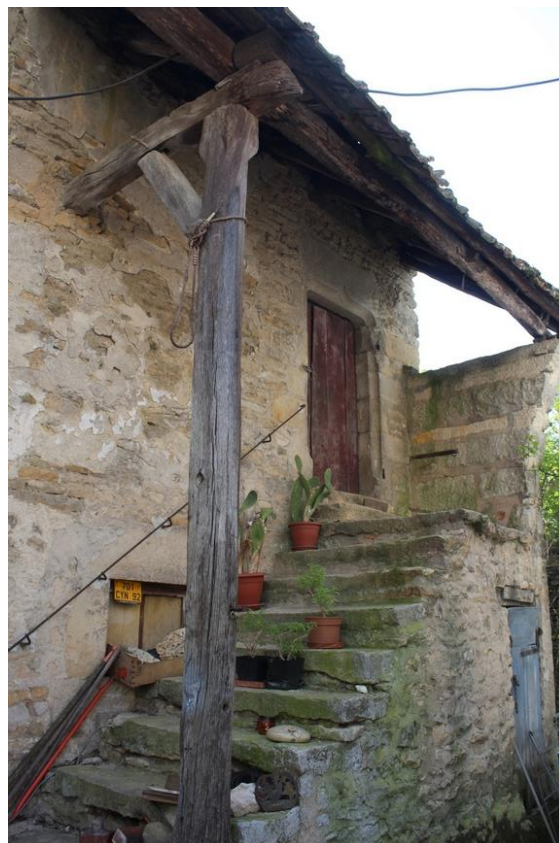
fig. 119 : Galerie d'escalier abritée d'un auvent à Gemeaux [21290-1]
