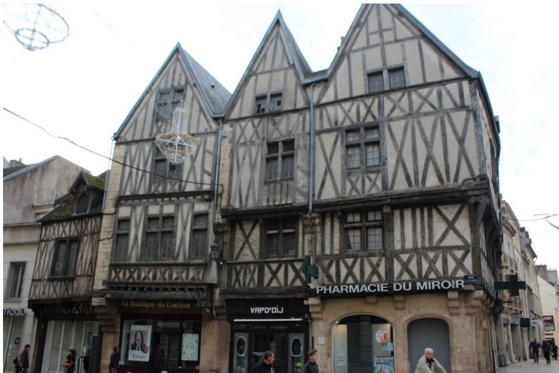
fig. 438 : Vue générale des façades dijonnaises [21231-55], [21231-105] et [21231-106]
