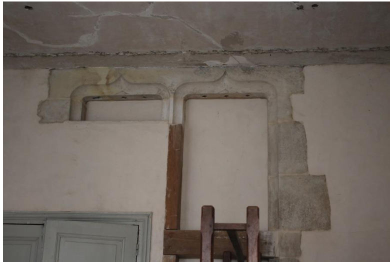
fig. 418 : Auxonne [21038-22] : vestiges de la croisée côté rue, au rez-de-chaussée du mur M1, cliché A. Lacaille
