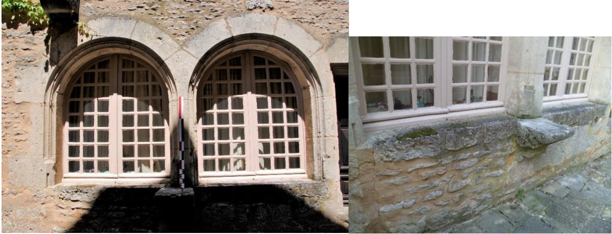
fig. 505 : Baies d'ouvroir de Flavigny-sur-Ozerain [21271-44] avec détail du support du banc d'étalage en pierre
