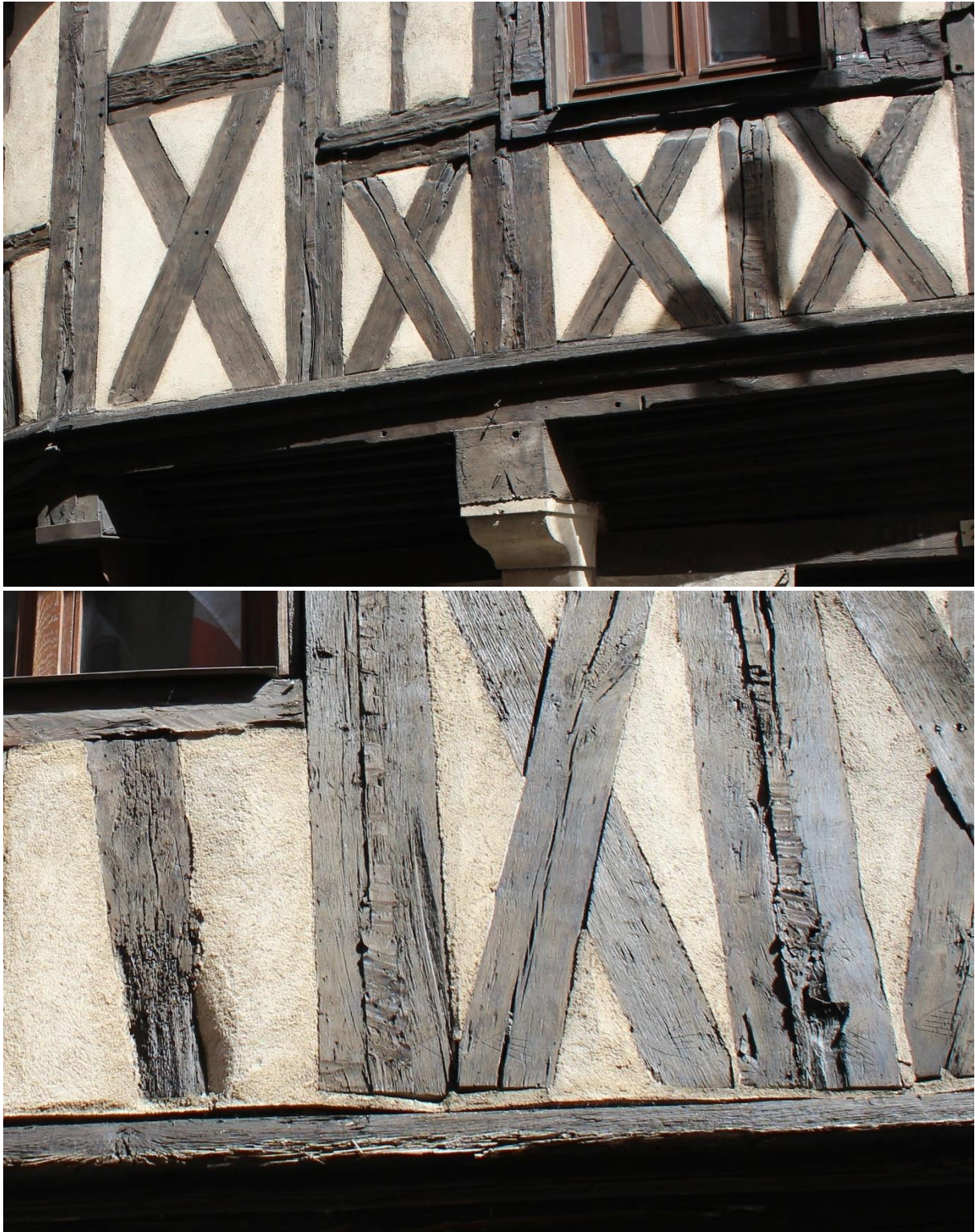
fig. 447 : Marquage de la partie basse des poutres du registre inférieur du pan de bois du niveau d'étage de la maison Semur-en-Auxois [21603-23]
