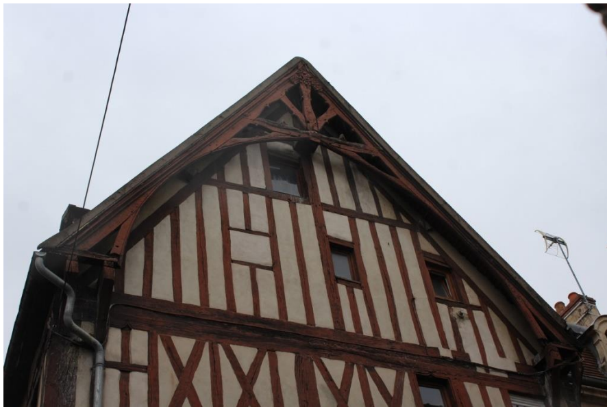
fig. 164 : Relevés des deux façades de la maison d'angle de Dijon [21231-3], d'après relevés J.-C. Lornet et cliché de la ferme débordante
