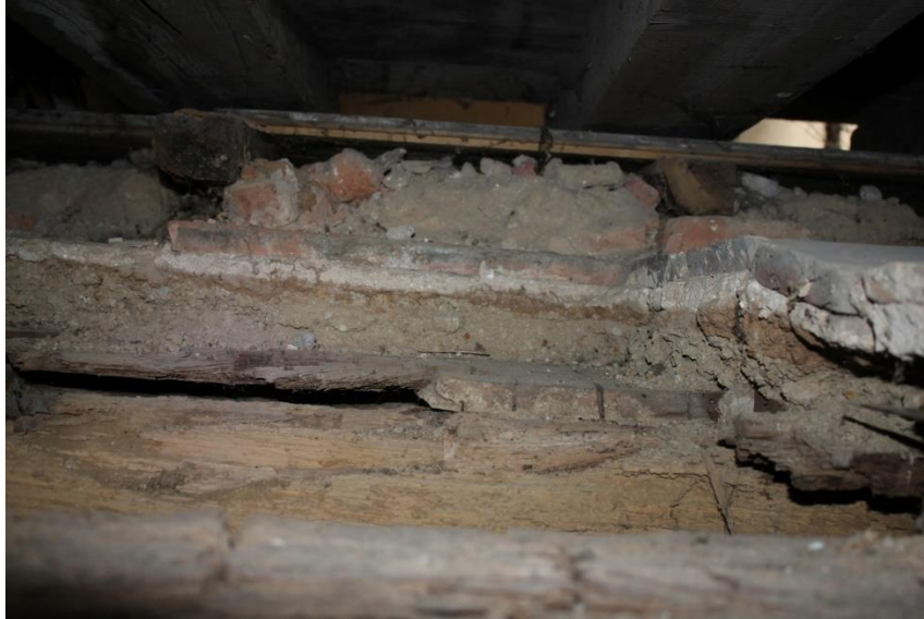
fig. 407 : Auxonne [21038-22] : trou dans le plafond contre le mur M2 au niveau du rez-de-chaussée de l'espace B, permettant d'apprécier la stratigraphie du sol de l'étage, cliché A. Lacaille
