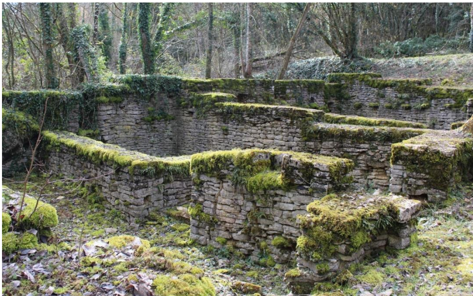
fig. 111 : Vestiges de demeure médiévale fouillées au site de Dracy (état en 2016)
