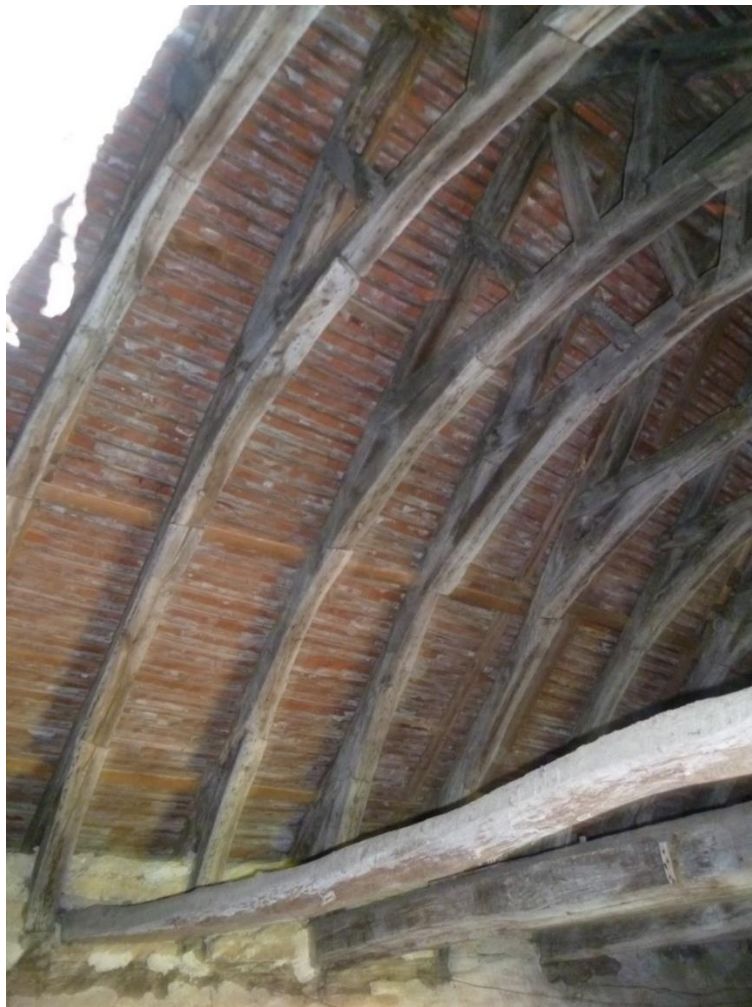
fig. 154 : Charpente de Flavigny-sur-Ozerain [21271-66] vue vers le nord
