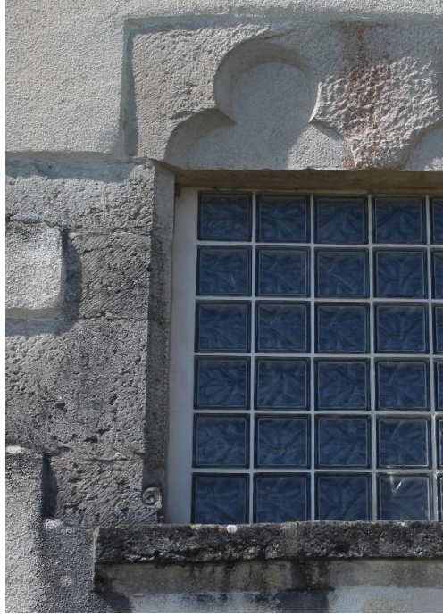
fig. 226 : Baie géminée à l'étage d'Uncey-le-Franc [21649-4]
