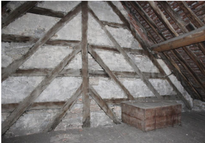
fig. 104 : Partie supérieure du pignon de la façade sur rue d'Arnay-le-Duc [21023-8], avec hourdis de brique
