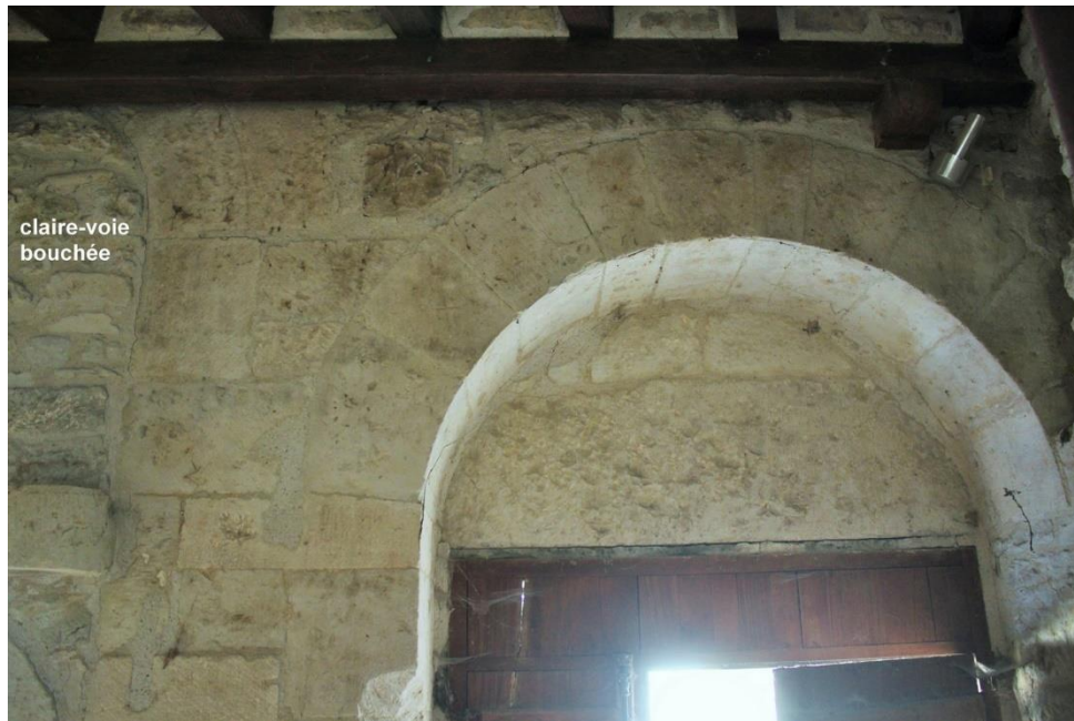
fig. 206 : Arrière-voussure de la porte principale de Flavigny-sur-Ozerain [21271-5]
