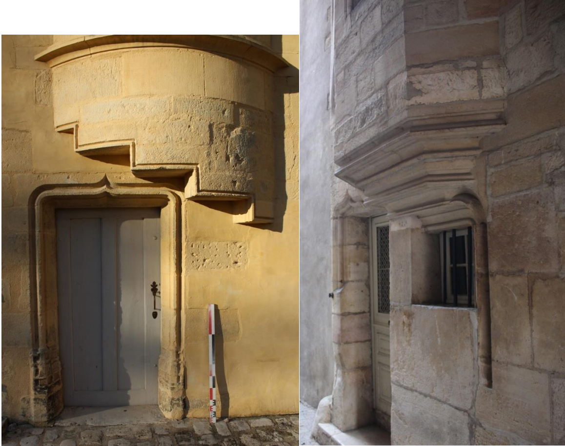
fig. 183 : Encorbellement en partie inférieure des escaliers VIS60 et VIS82
