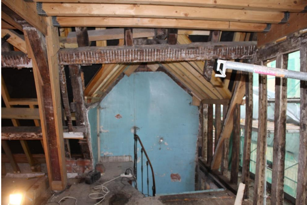
fig. 361 : Semur-en-Auxois [21603-64] : partie sommitale de l'escalier au niveau du comble, cliché A. Lacaille
