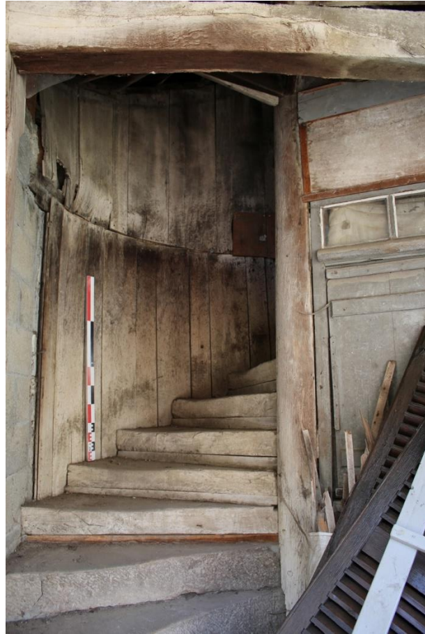
fig. 176 : Cage d'escalier de (VIS137) à Semur-en-Auxois en planches verticales clouées
