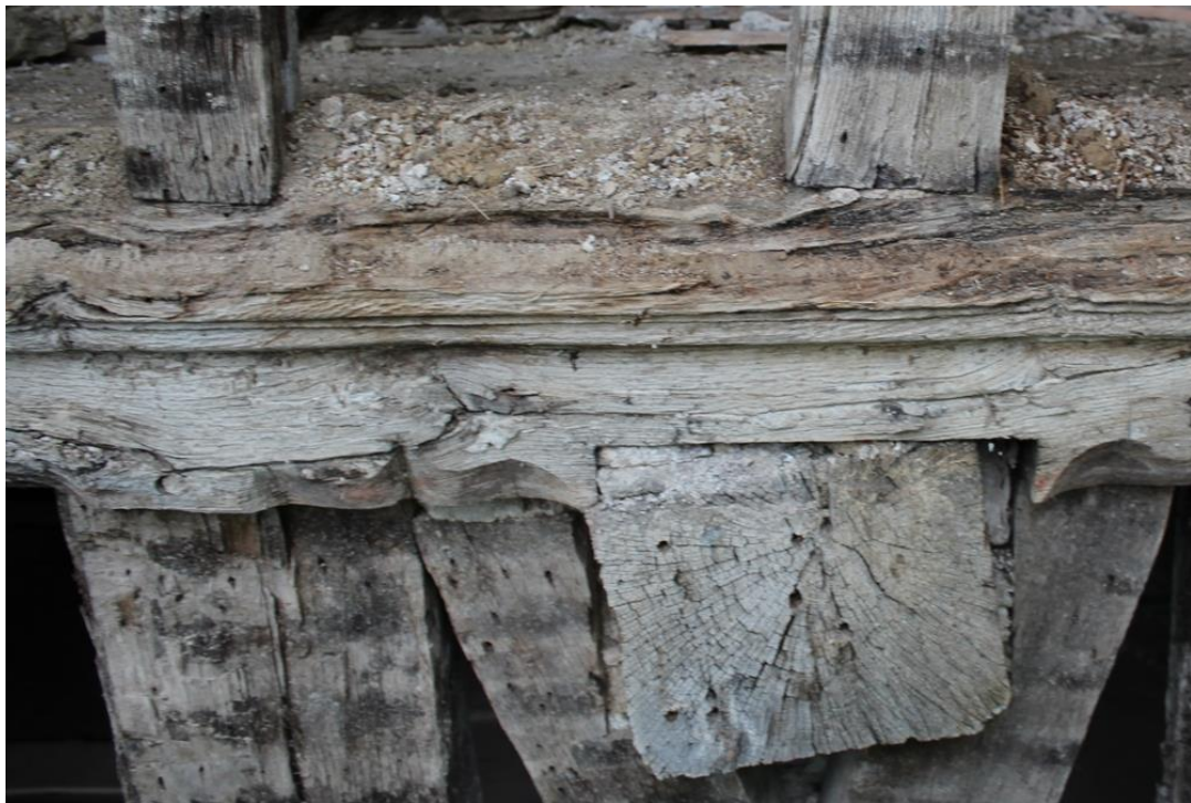
fig. 371 : Semur-en-Auxois [21603-64] : un about de sommier s'intercale entre une sablière décorée d'accolades et un contreventement en croix de Saint-André, cliché A. Lacaille
