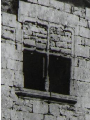
Chanceaux [21142-1] (UDAP 21, dossier commune de Chanceaux)
