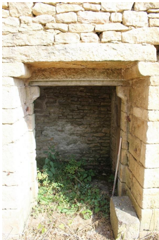
fig. 207 : Arrière-linteau sur coussinet d'une porte piétonne de la grange de Montréal [89267-1]
