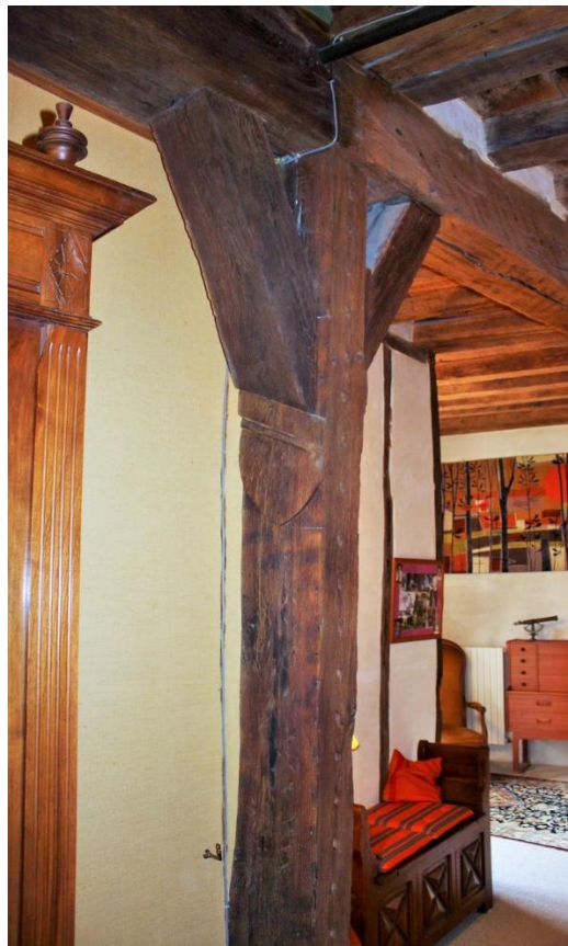
fig. 140 : Poteau supportant le plafond à l'étage de Fontaine-lès-Dijon [21278-10]
