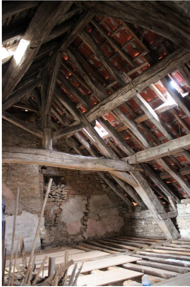
fig. 151 : Ferme de charpente de Châteauneuf [21152-16] vue vers le sud
