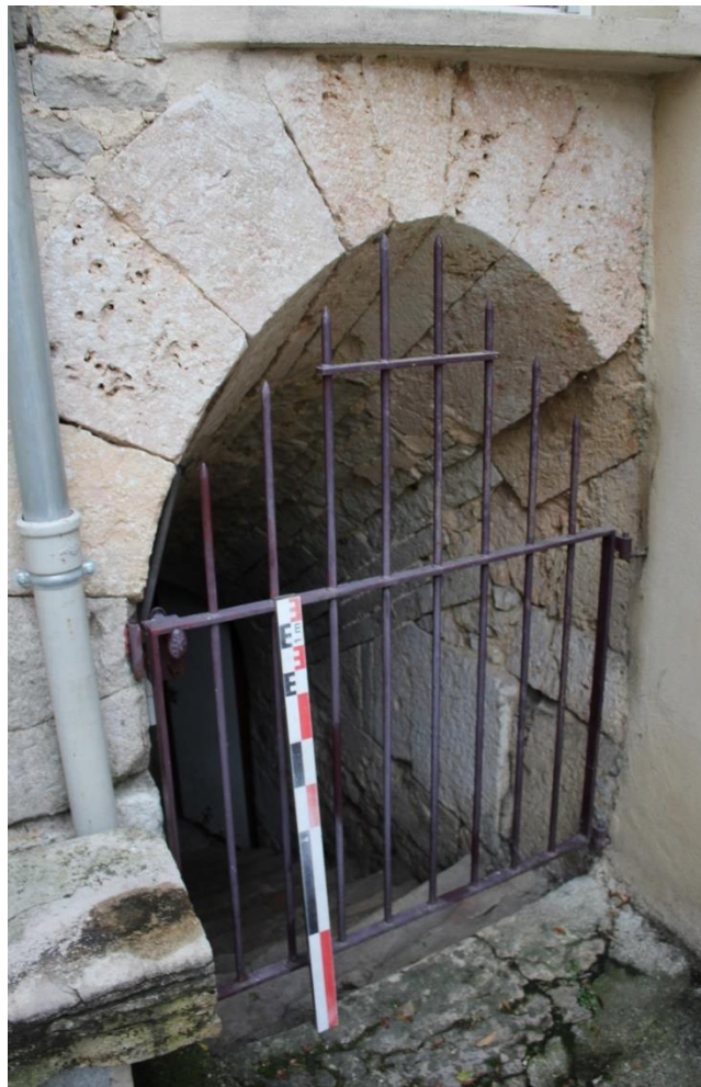
fig. 229 : Porte cintrée d'accès à la cave de Fleurey-sur-Ouche [21273-5]
