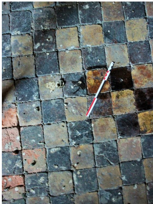
fig. 136 : Portion du sol du comble de Beaune [21054-33]
