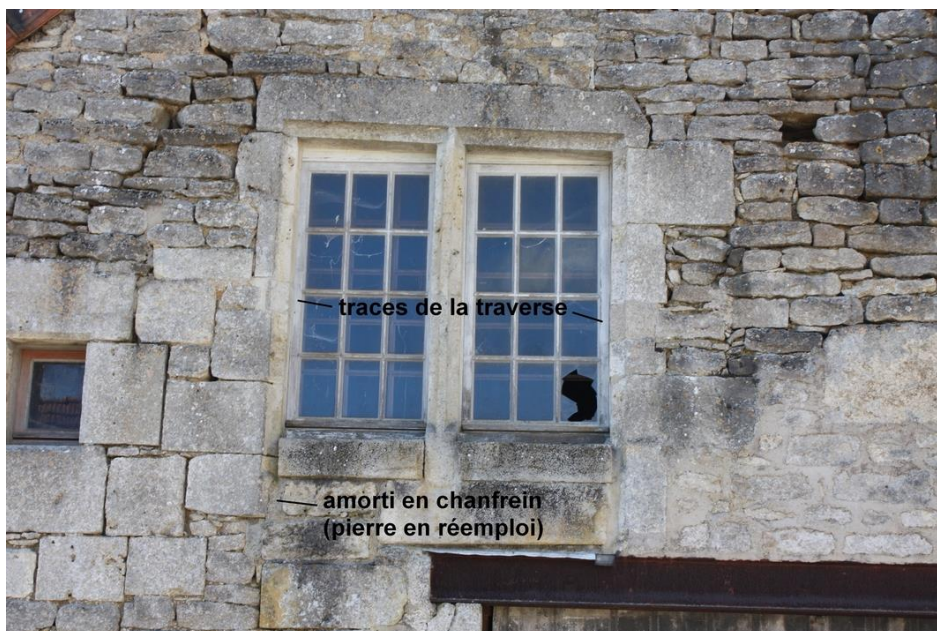
fig. 294 : Flavigny-sur-Ozerain [21271-8] : les vestiges de la fenêtre à croisée de la façade nord M1, cliché A. Lacaille
