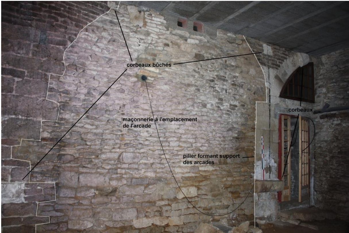
fig. 282 : Flavigny-sur-Ozerain [21271-8] : le mur M5 dans la cave de l'espace B, cliché A. Lacaille
