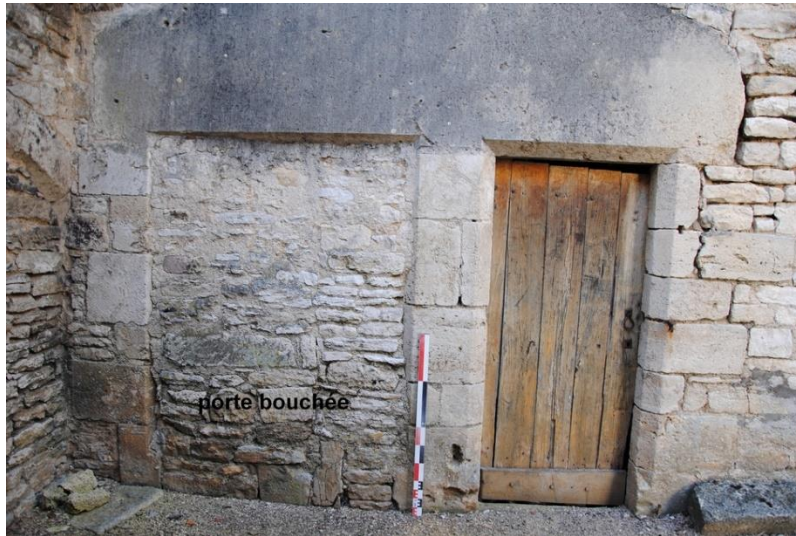
fig. 230 : Deux portes couvertes par un même linteau à Rougemont [21580-14]
