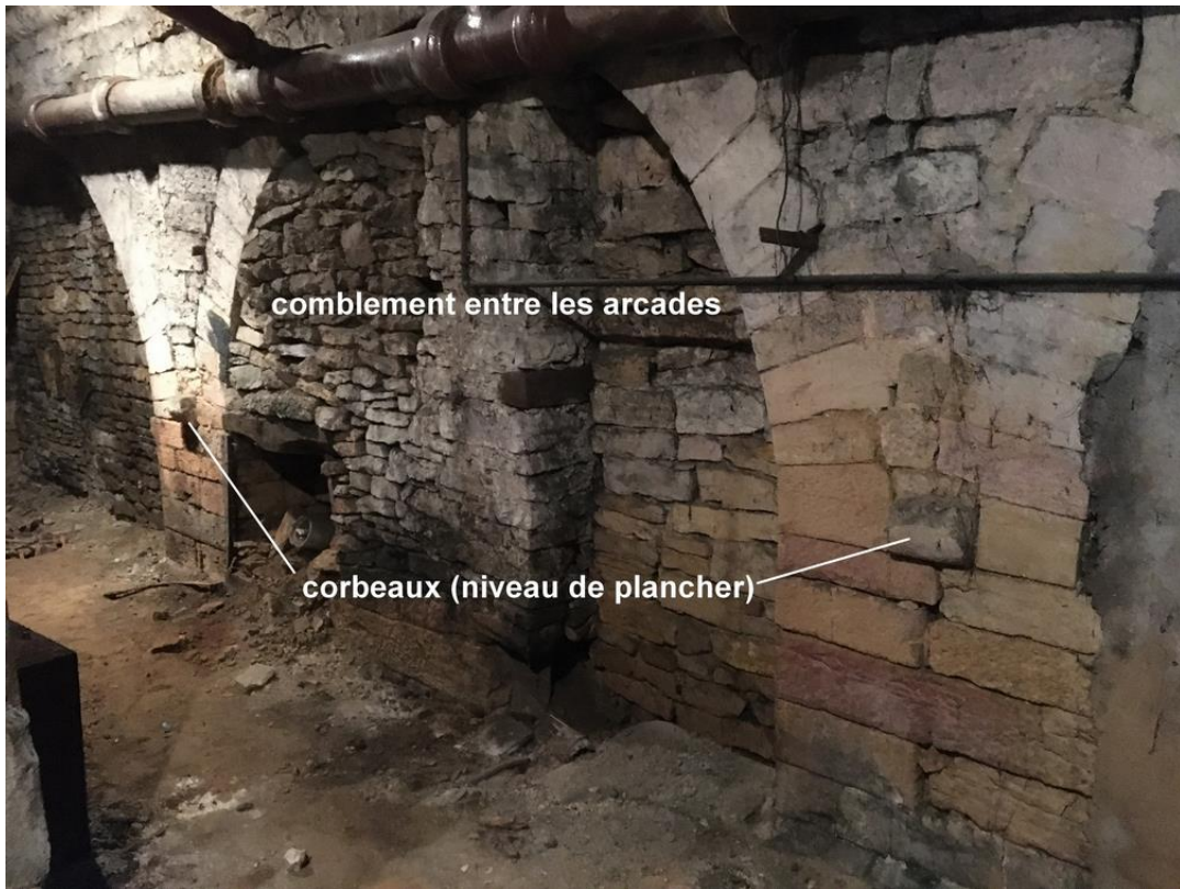
fig. 133 : Arcs diaphragmes installés dans le mur de refend nord de la cave à Dijon [21231-22], cliché C. Lassus
