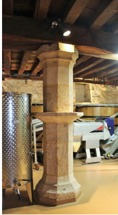
fig. 141 : Support intermédiaire du plafond du rez-de-chaussée de Beaune [21054-69]
