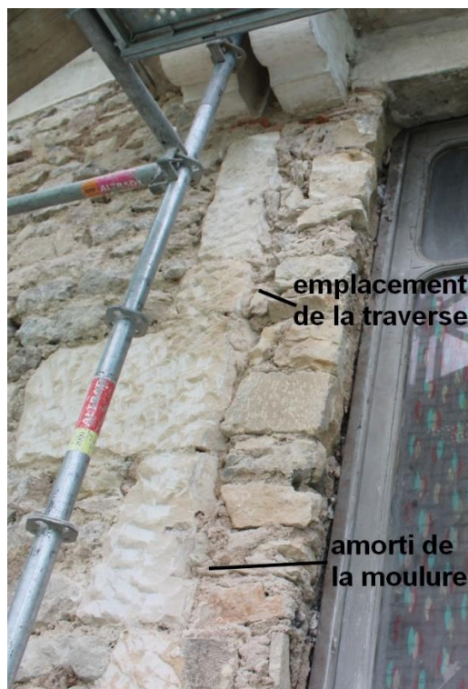
fig. 377 : Semur-en-Auxois [21603-64] : vestige d'un piédroit de croisée au rez-de-chaussée en M4, cliché A. Lacaille
