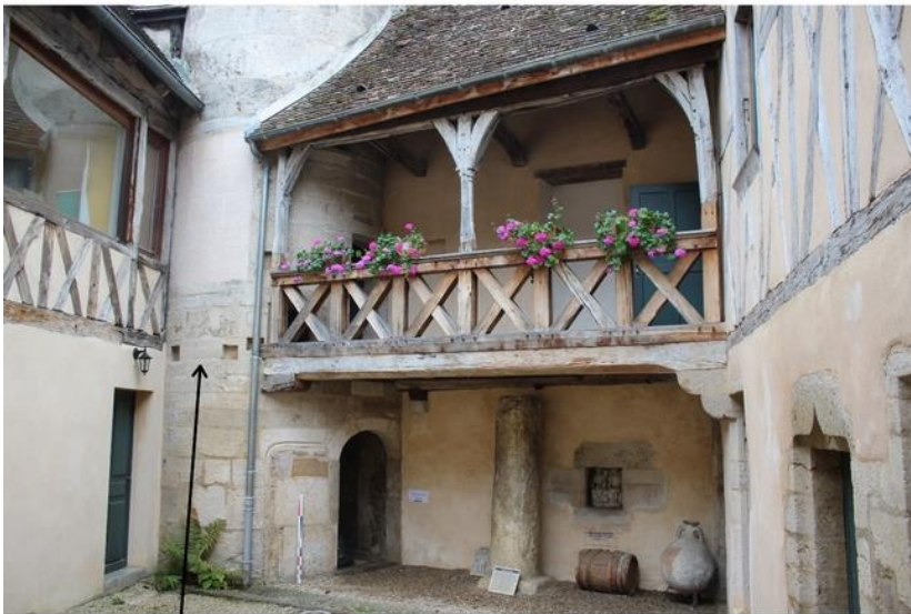
vestiges d'une seconde galerie (porte et ancrages de poutre)
