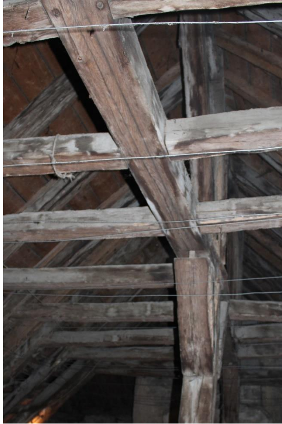
fig. 445 : Traces de lignage sur la face inférieure de la sous-faîtière de la charpente de Vitteaux [21710-5]
