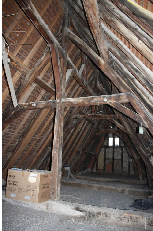
fig. 146 : Charpente de la maison Beaune [21054-33] vue vers le nord
