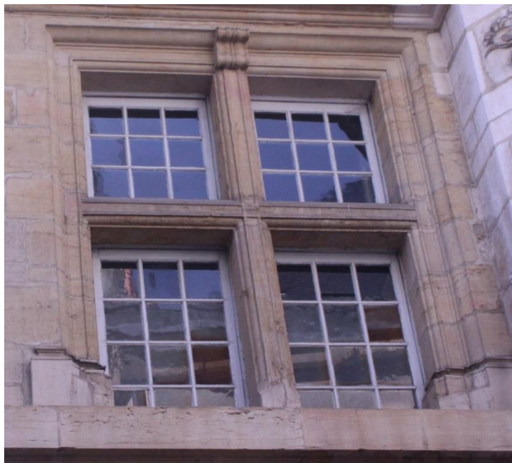
fig. 221 : Fenêtre à croisée à l'étage de l'hôtel Legouz-Gerland à Dijon [21231-79]
