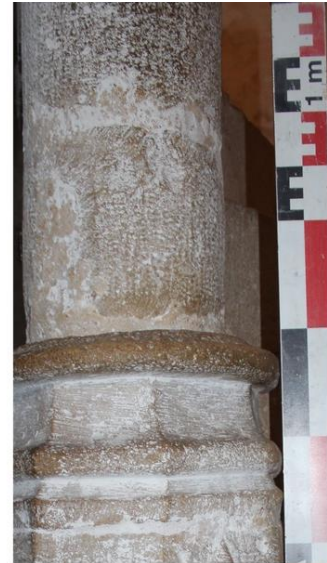
Gradine et ciselure périmétrique sur un noyau d'escalier en vis à Baigneux-les-Juifs [21043-1]
