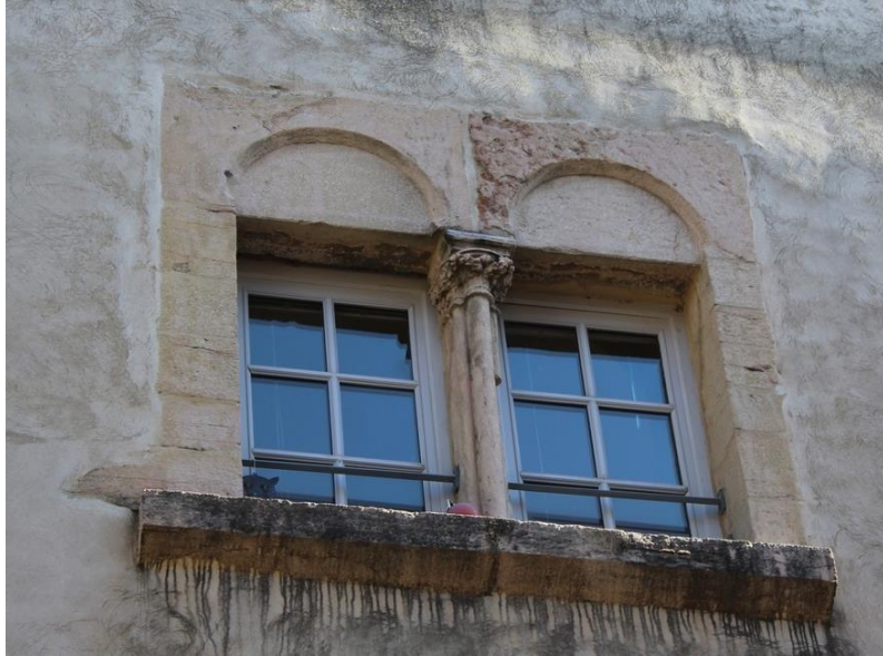
fig. 523 : Fenêtre à colonnette de Beaune [21054-66]
