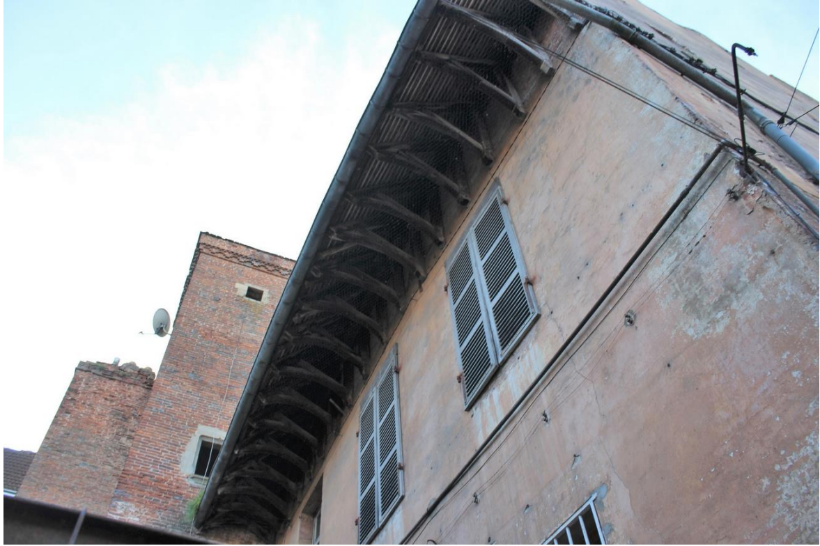
fig. 162 : Avant-toit de la façade gouttereau d'Auxonne [21038-13]
