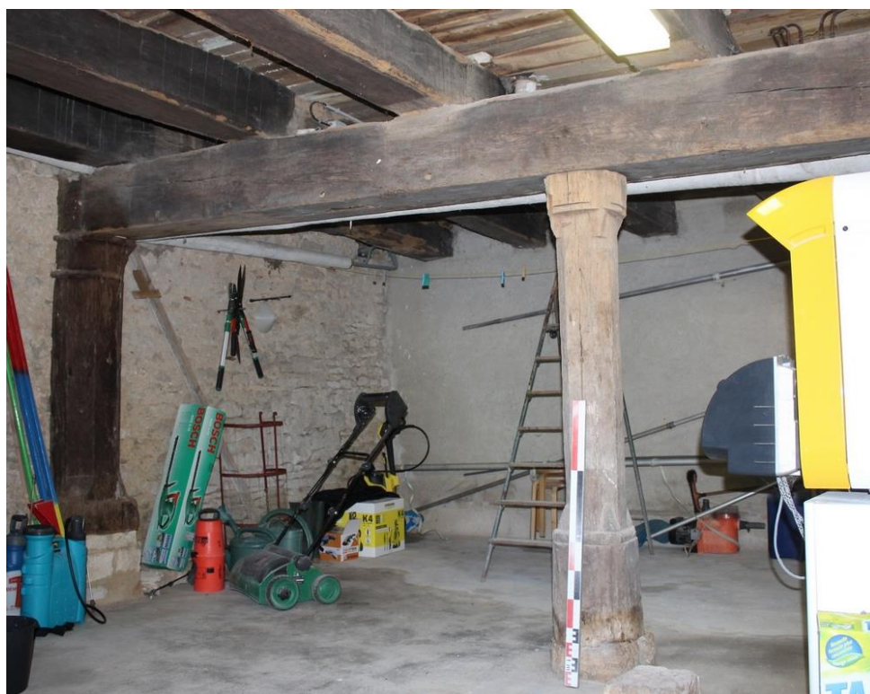
fig. 123 : Cave de Fontaines-en-Duesmois [21276-1] avec sommier du plafond sur poteaux, vue vers le sud
