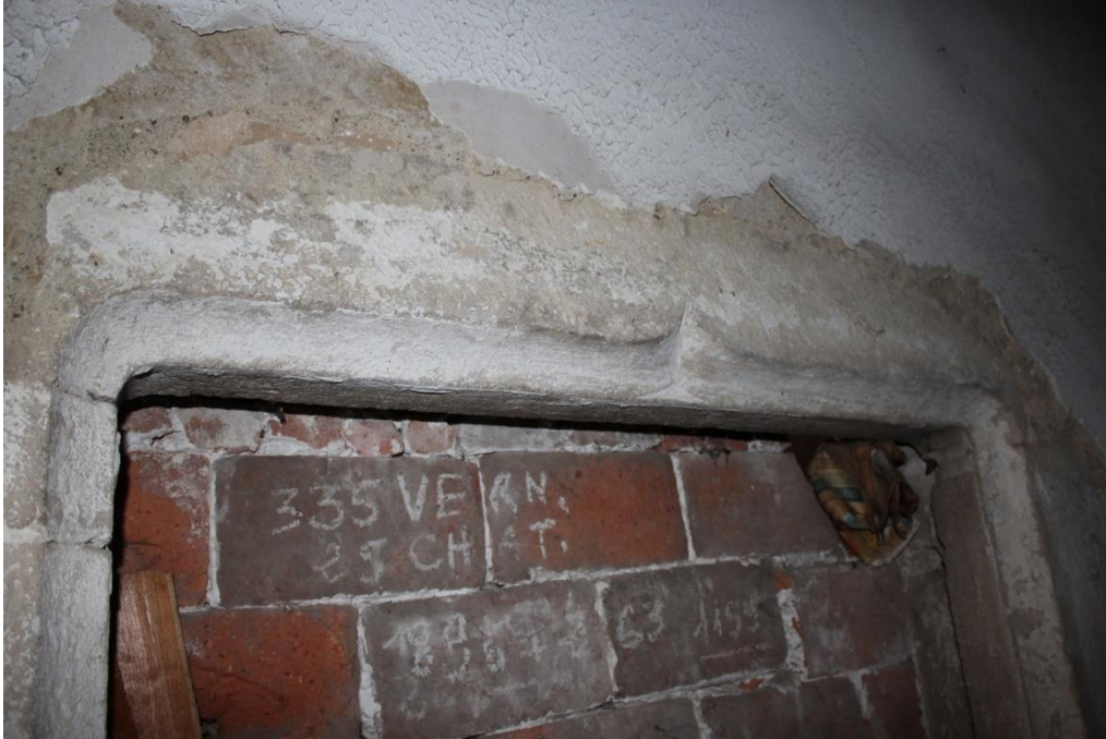
fig. 403 : Auxonne [21038-22] : linteau de la porte orientale qui dessert l'espace B depuis le couloir au niveau du rez-de-chaussée, cliché A. Lacaille
