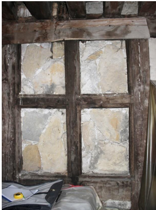
fig. 209 : Face interne d'une fenêtre à croisée en bois bouchée au second étage de Noyers [89279-13]
