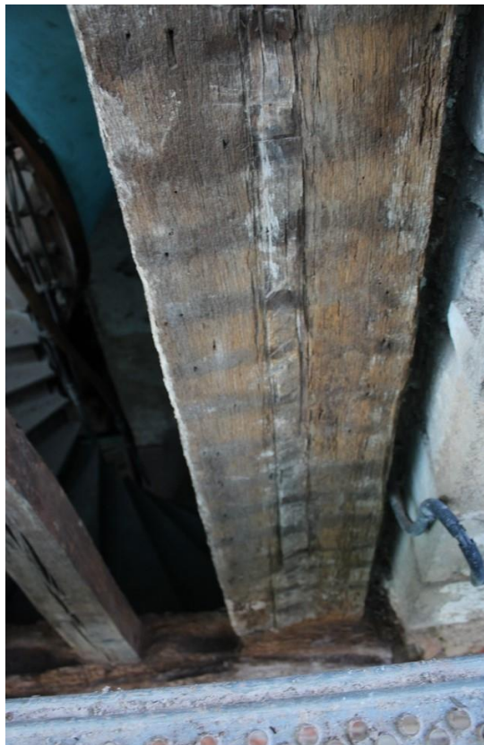
fig. 369 : Semur-en-Auxois [21603-64] : aspect de la moulure verticale bûchée formant pinacle du poteau le plus à l'est du pan de bois, cliché A. Lacaille
