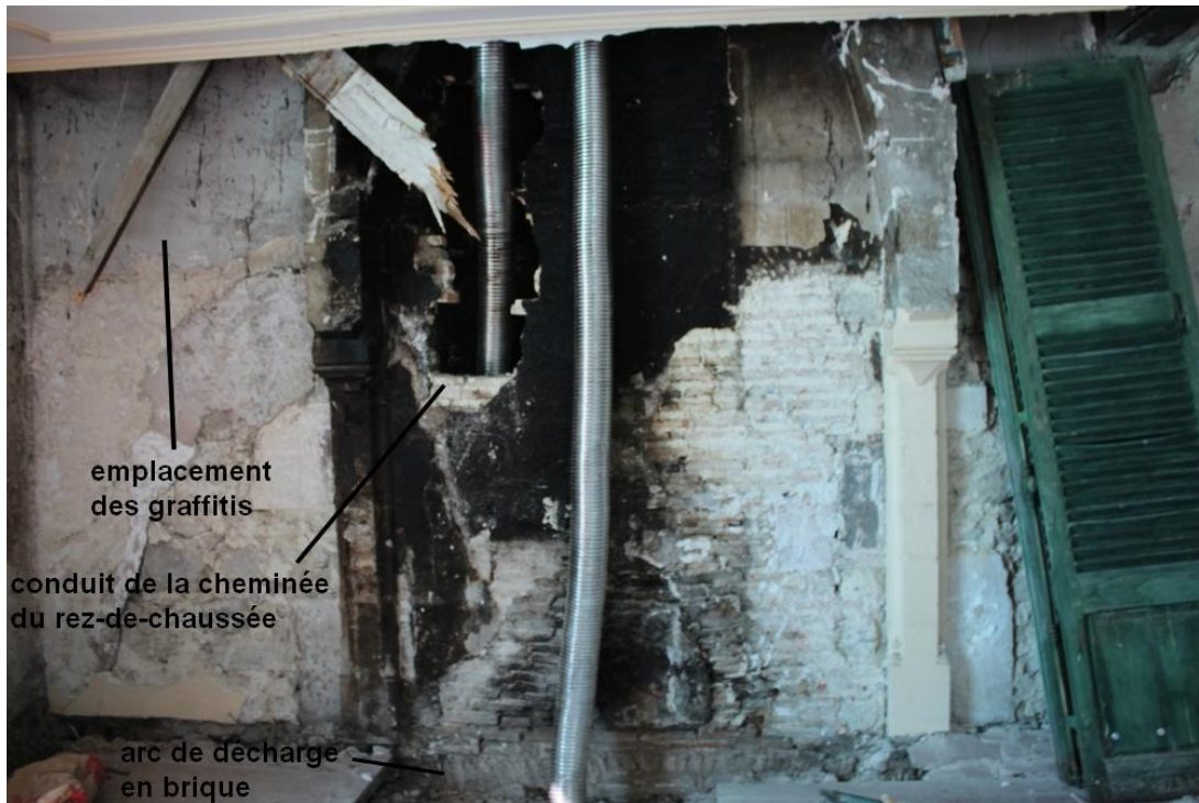
fig. 359 : Semur-en-Auxois [21603-64] : les vestiges de la cheminée du mur nord M3 à l'étage, cliché A. Lacaille
