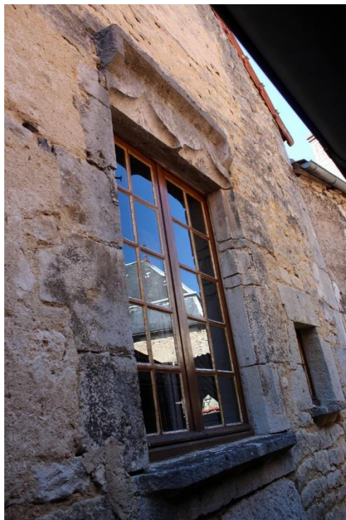
fig. 205 : Fenêtre à croisée avec appui supérieur en façade de Flavigny-sur-Ozerain [21271-97]
