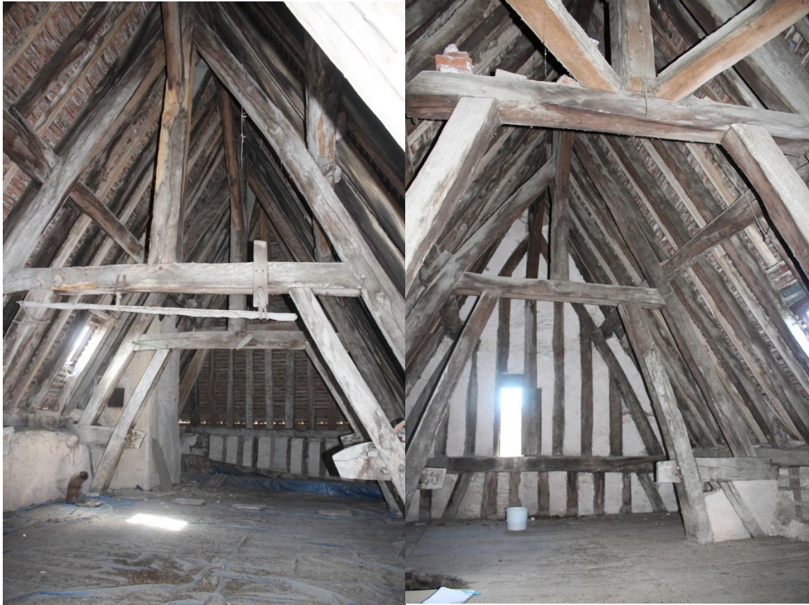
fig. 149 : Charpentes des maisons nucériennes [89279-13] et [89279-40]
