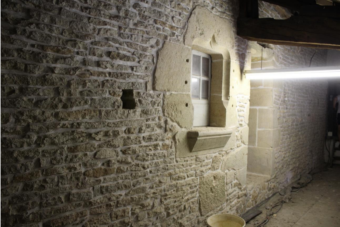
fig. 322 : Pouilly-en-Auxois [21501-6] : ouvertures percées dans le mur M3 à l'étage, vue vers l'est, cliché A. Lacaille
