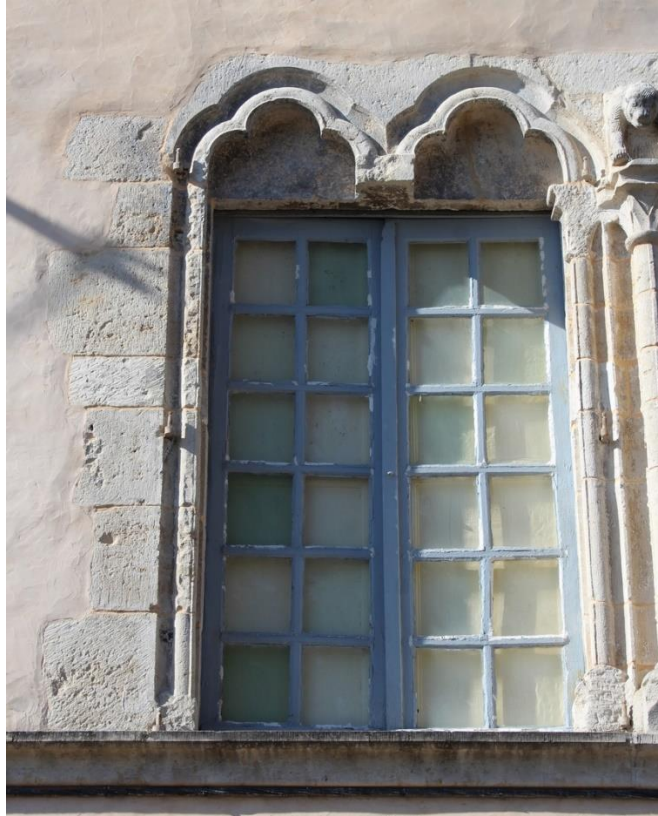
fig. 218 : Fenêtre à croisée moulurée d'un tore à listel à l'étage de Montbard [21425-4]
