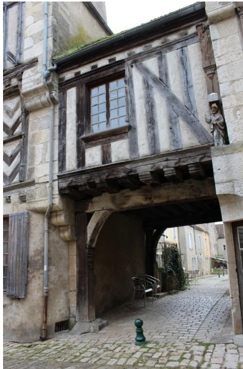
fig. 91 : Détail des solives portant la saillie de la maison et la galerie de Noyers [89279-45]
