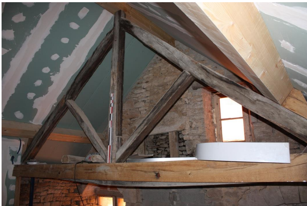
fig. 288 : Flavigny-sur-Ozerain [21271-8] : la ferme de charpente à l'étage de l'espace A, vue vers le nord, état pendant travaux, cliché A. Lacaille
