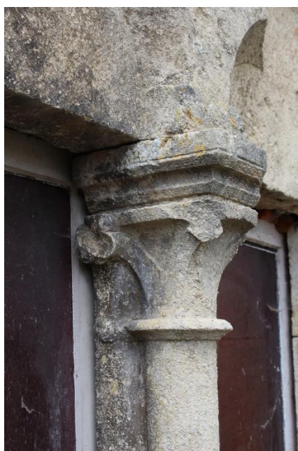
fig. 292 : Flavigny-sur-Ozerain [21271-8] : le chapiteau de la fenêtre à colonnette de la façade nord M1, cliché A. Lacaille
