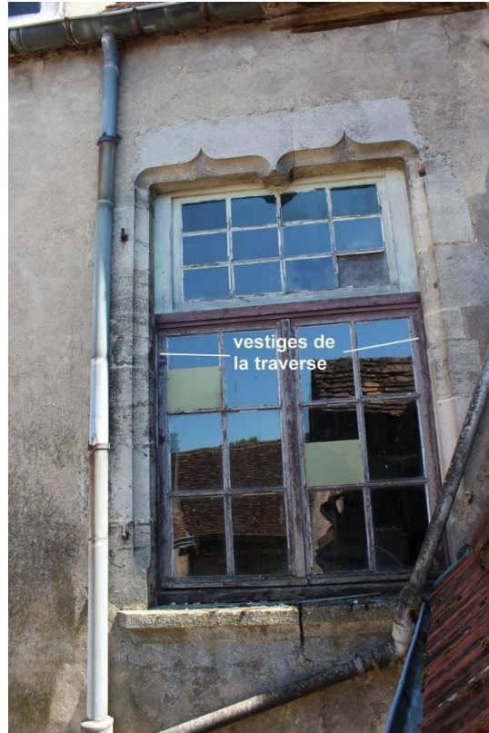
fig. 421 : Auxonne [21038-22] : fenêtre à croisée à l'étage de M3, en façade sur cour. Les pierres de la traverse bûchées sont conservées sur place, cliché A. Lacaille
