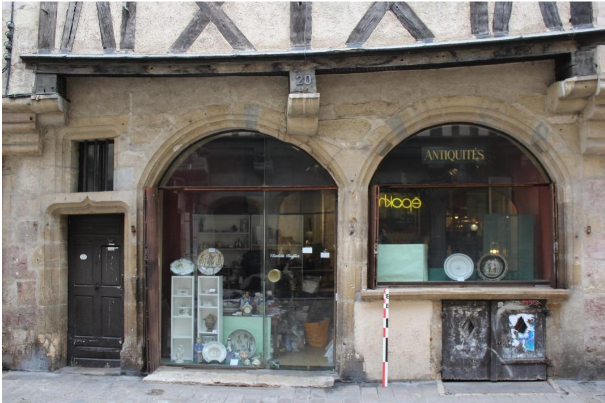
fig. 509 : Rez-de-chaussée de la façade de Dijon [21231-85]
