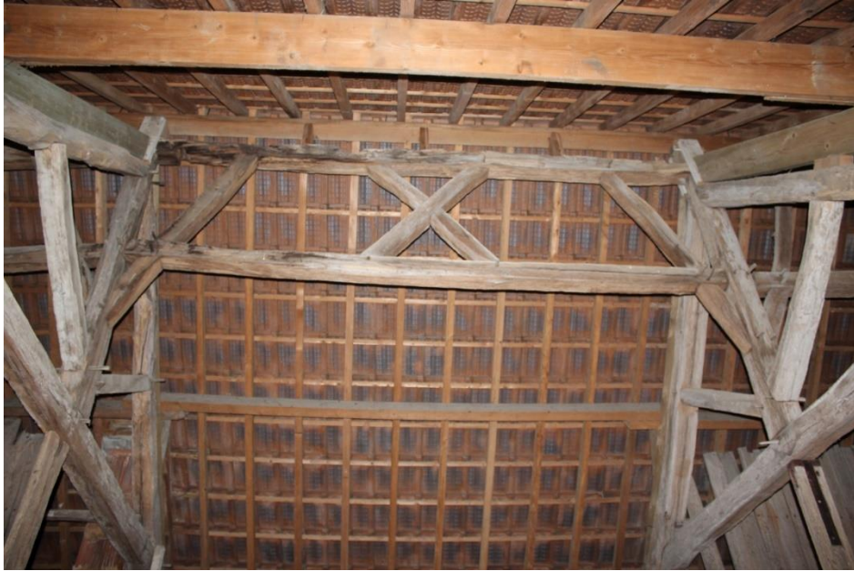
fig. 153 : Contreventement de la charpente de Montréal [89267-22]
