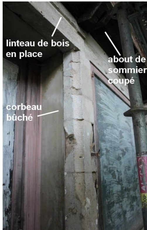
fig. 366 : Semur-en-Auxois [21603-64] : ancien piédroit de baie conservé au rez-de-chaussée de M1, cliché A. Lacaille
