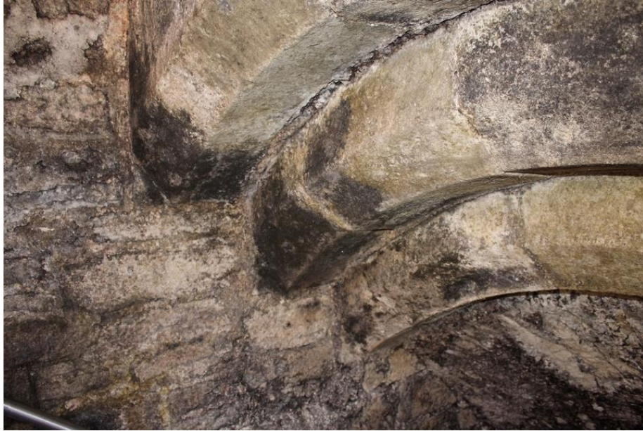
fig. 228 : Arcs en redent couvrant la porte d'accès à la cave de Beaune [21054-69]
