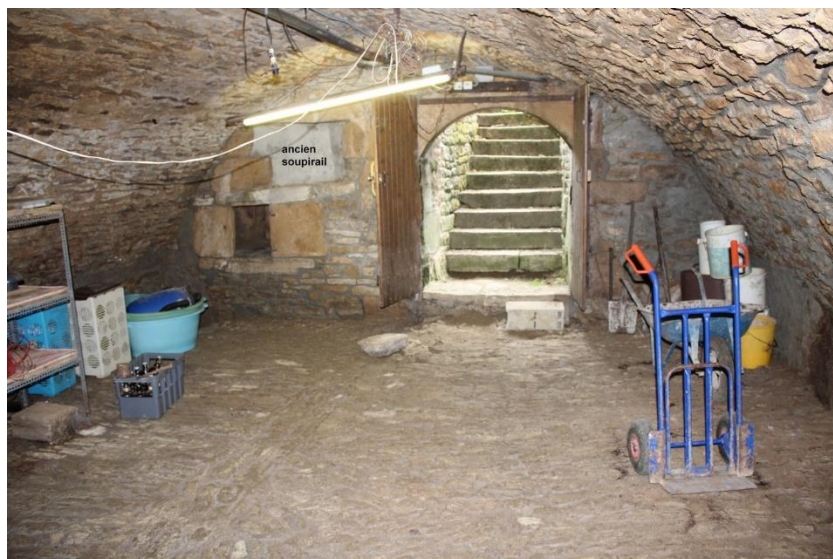
fig. 314 : Pouilly-en-Auxois [21501-6] : aspect de la cave voûtée, vue vers l'est, cliché A. Lacaille
