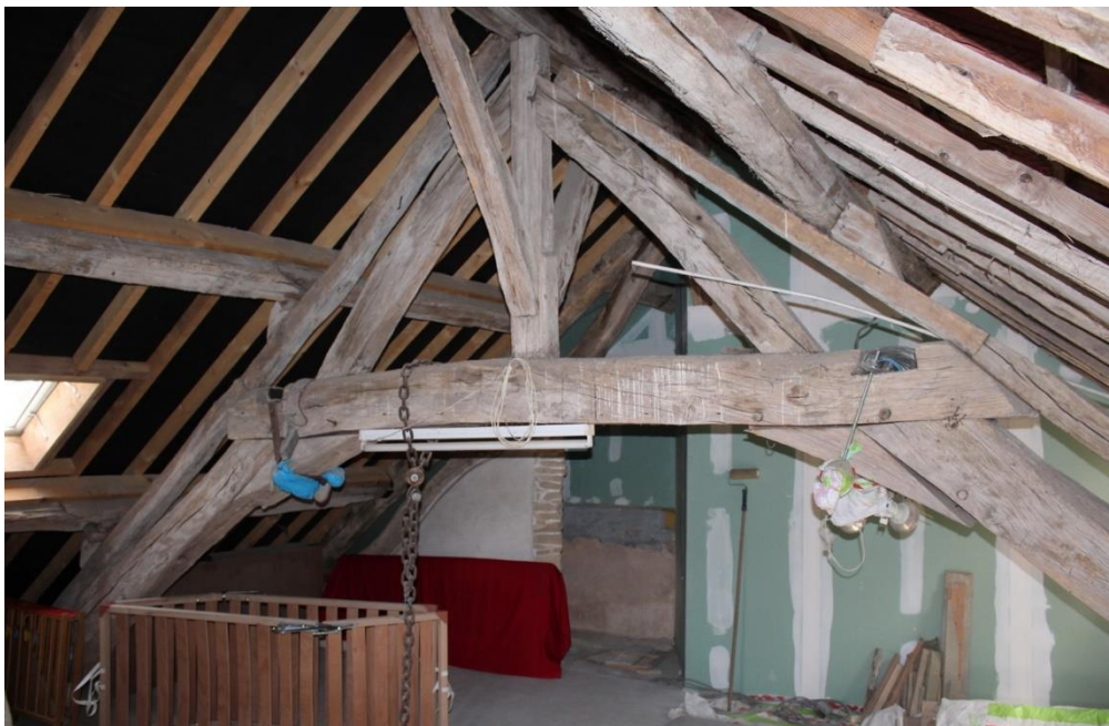
fig. 327 : Pouilly-en-Auxois [21501-6] : ferme de charpente nord, vue vers le sud, cliché A. Lacaille
