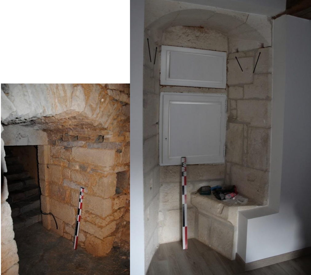
fig. 443 : Trous d'ancrage des cintres pour la pose d'arrière voussure de baies à Flavigny [21271-111] et Saulx-le-Duc [21587-2]
