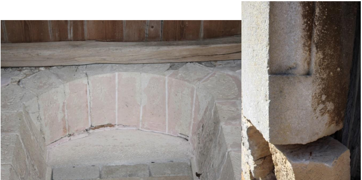
fig. 446 : Marques simples inscrites sur des blocs d'encadrement de baies à Salives [21579-4] et Chanceaux [21142-18], probablement comme repères de montage
