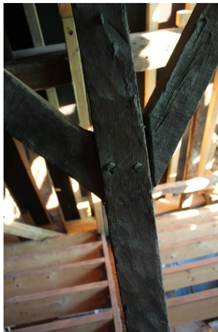
fig. 364 : Semur-en-Auxois [21603-64] : traitement du bois à l'herminette (poinçon) et à la scie (décharge), cliché A. Lacaille
