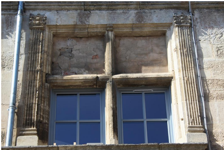
fig. 527 : Baies à pilastres : Noyers [89279-34] et Is-sur-Tille [21317-4]
