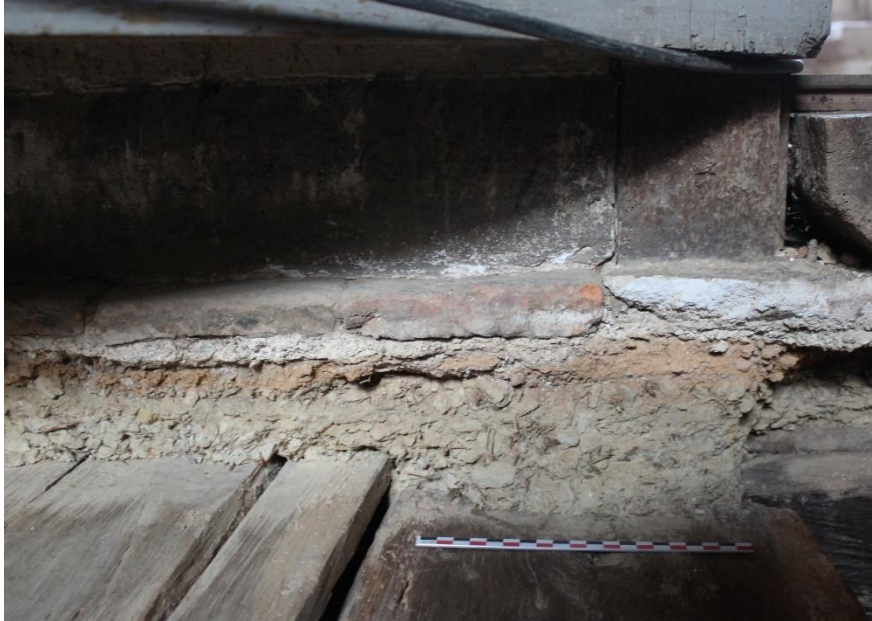
fig. 135 : Coupe du sol ancien à l'étage de Châteauneuf [21152-16] depuis les planches recouvrant les solives jusqu'aux carreaux de sol
