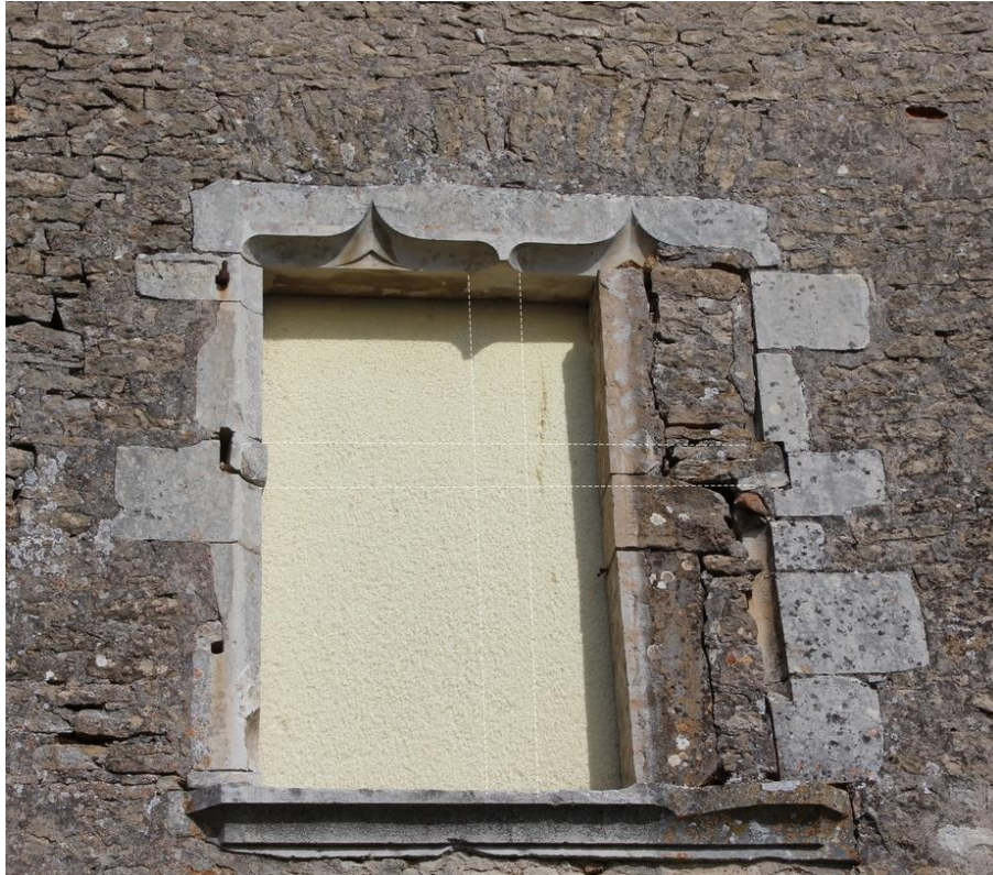
fig. 203 : Fenêtre à croisée surmontée d'un arc de décharge à l'étage de la façade ouest de Châteauneuf [21152-6]
