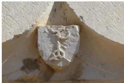
Linteau de fenêtre de Meursault [21412-1]
