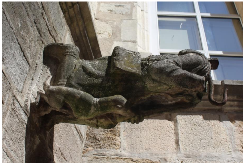
fig. 62 : Personnage formant corbeau porte-poulie de puits inséré dans la tourelle d'escalier de Beaune [21054-51]
