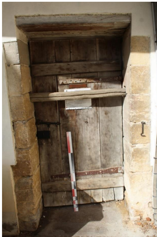
fig. 472 : Epars médiéval encore fonctionnel pour la porte d'accès à la cour de Fontaine-lès-Dijon [21278-13]
