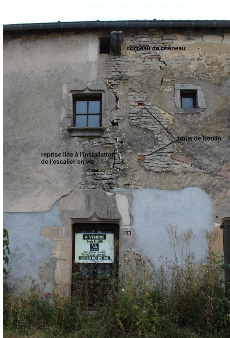
fig. 333 : Pouilly-en-Auxois [21501-6] : portion de la façade M1 où se situe l'escalier intérieur, cliché A. Lacaille
