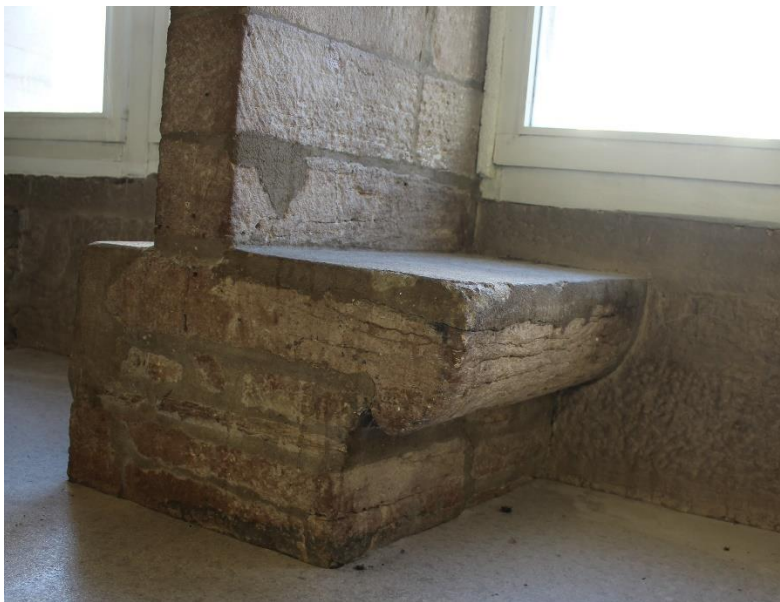
fig. 249 : Coussiège d'une baie de la claire-voie d'étage de Beaune [21054-29]
