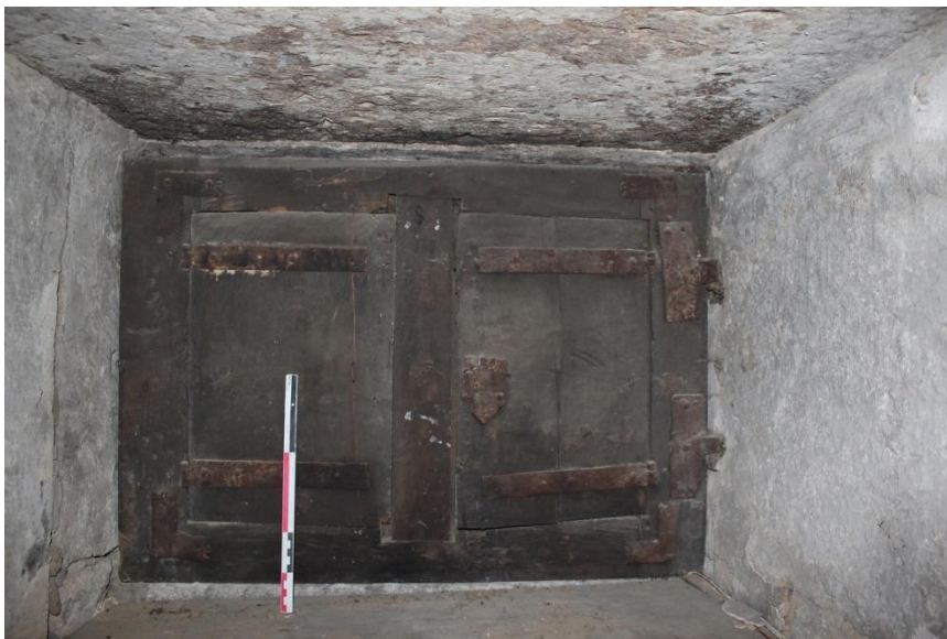
fig. 211 : Huisserie conservée dans la partie supérieure d'une fenêtre à traverse à Mont-Saint-Jean [21441-17]
