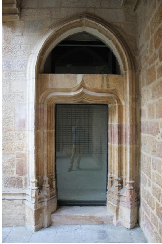
fig. 234 : Porte au rez-de-chaussée du corps de logis sur rue de l'hôtel Chambellan [21231-30]
