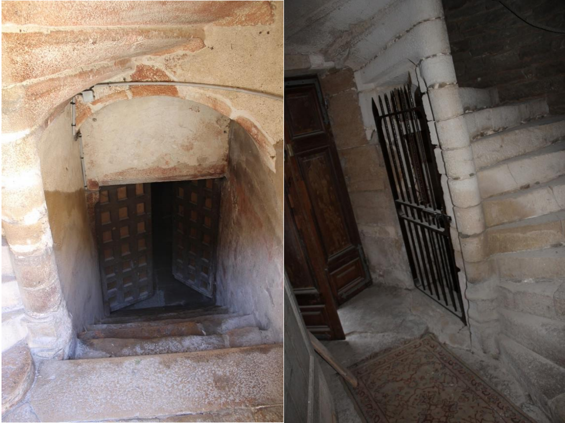
fig. 174 : Escaliers droits d'accès aux caves depuis les tourelles d'escalier en vis (VIS11) et (VIS65)
