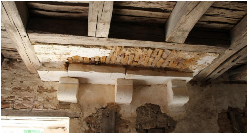
fig. 258 : Soutien de la sole de cheminée à l'étage de Salives [21579-4]
