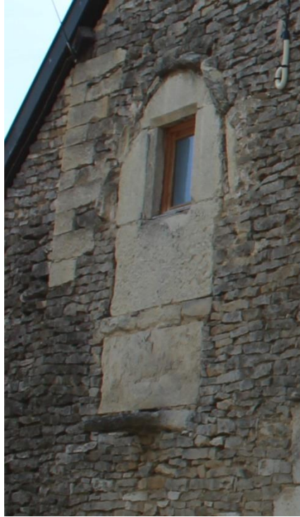
fig. 268 : Face extérieure de l'évier à l'étage de Pichanges [21483-1]
