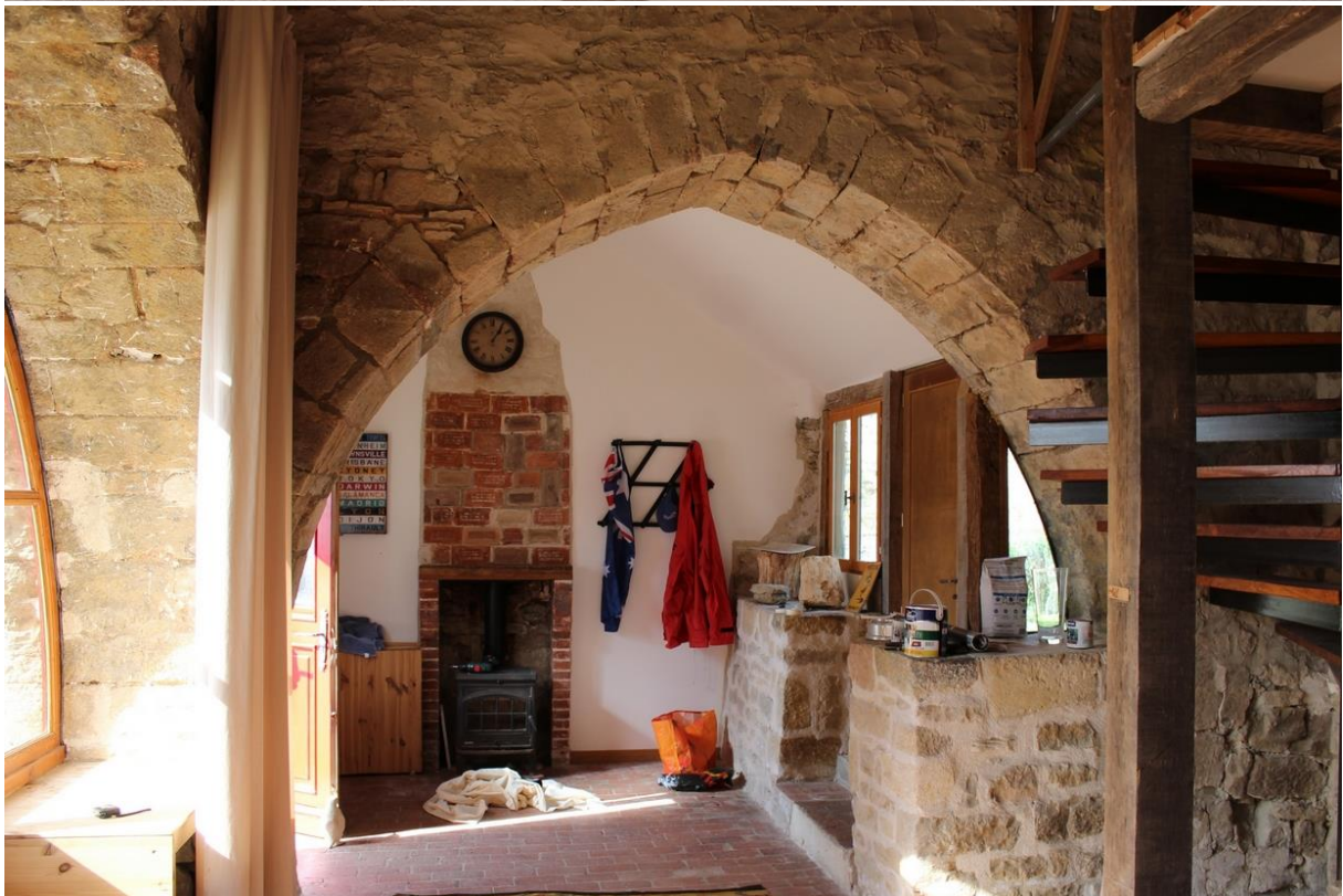
fig. 499 : Aspect général de l'édifice de Saint-Thibault [21576-5] et arcade nord vue vers le nord à l'intérieur
