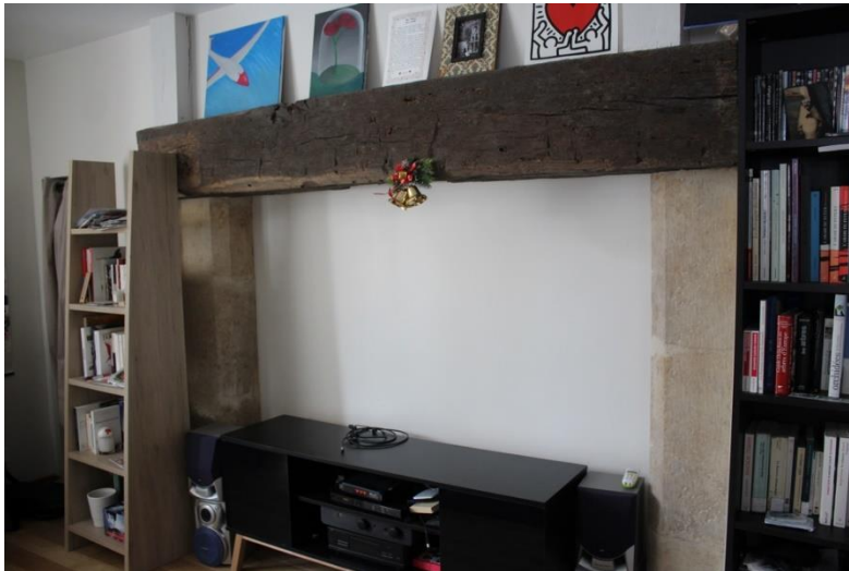
fig. 355 : Semur-en-Auxois [21603-64] : choix d'aménagement de la cheminée découverte en M3, cliché A. Lacaille
