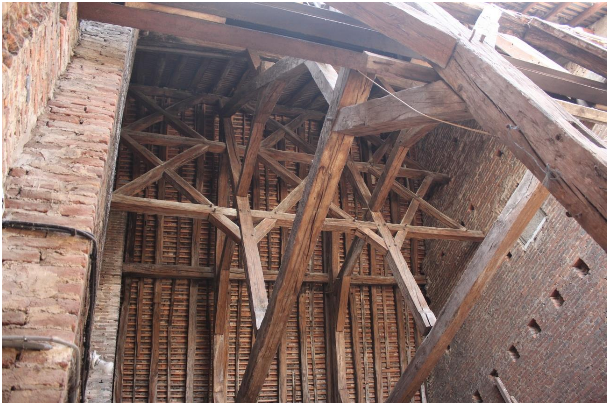
fig. 412 : Auxonne [21038-22] : aspect général de la charpente depuis l'angle sud-est, cliché A. Lacaille
