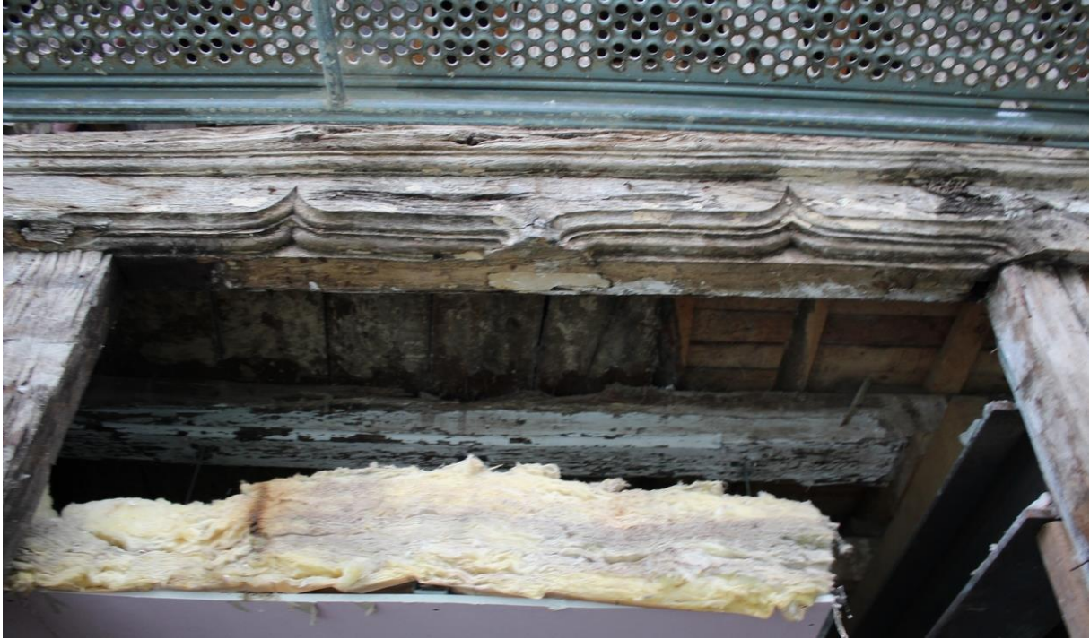
fig. 368 : Semur-en-Auxois [21603-64] : la sablière de chambrée de l'étage du pan de bois sert de linteau mouluré pour les croisées, cliché A. Lacaille
