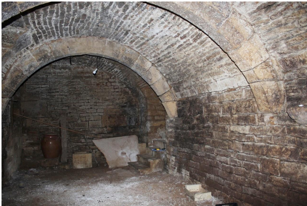
fig. 125 : Voûte de la cave de Chanceaux [21142-8], vue vers le nord
