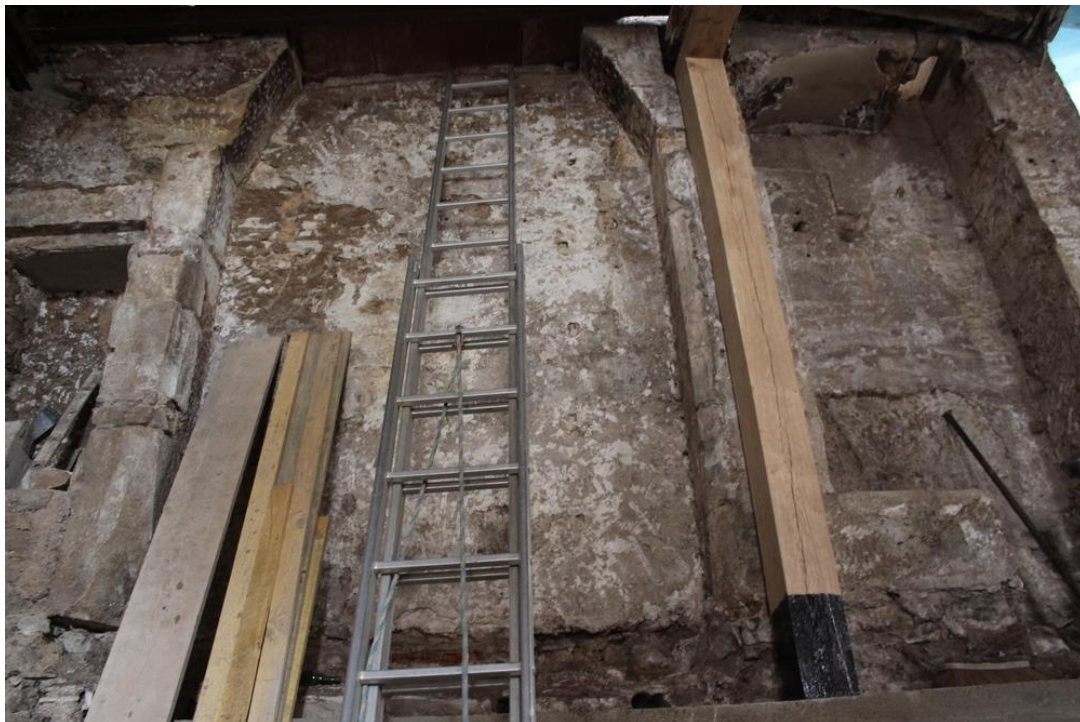
fig. 354 : Semur-en-Auxois [21603-64] : partie du mur M2 au rez-de-chaussée avec les vestiges d'une cheminée, cliché A. Lacaille
