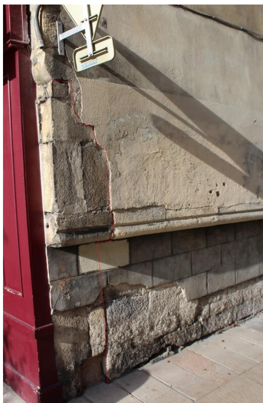
fig. 115 : Partie inférieure de l'angle entre les deux façades sur rue de Dijon [21231-138]. Le pointillé rouge indique la limite de l'angle avant la consolidation moderne
