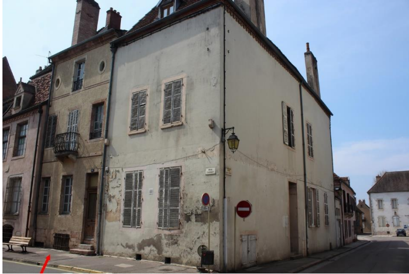
fig. 390 : Auxonne [21038-22] : situation de la demeure étudiée, à proximité de l'angle entre les rues Carnot et du capitaine Landolphe, cliché A. Lacaille
