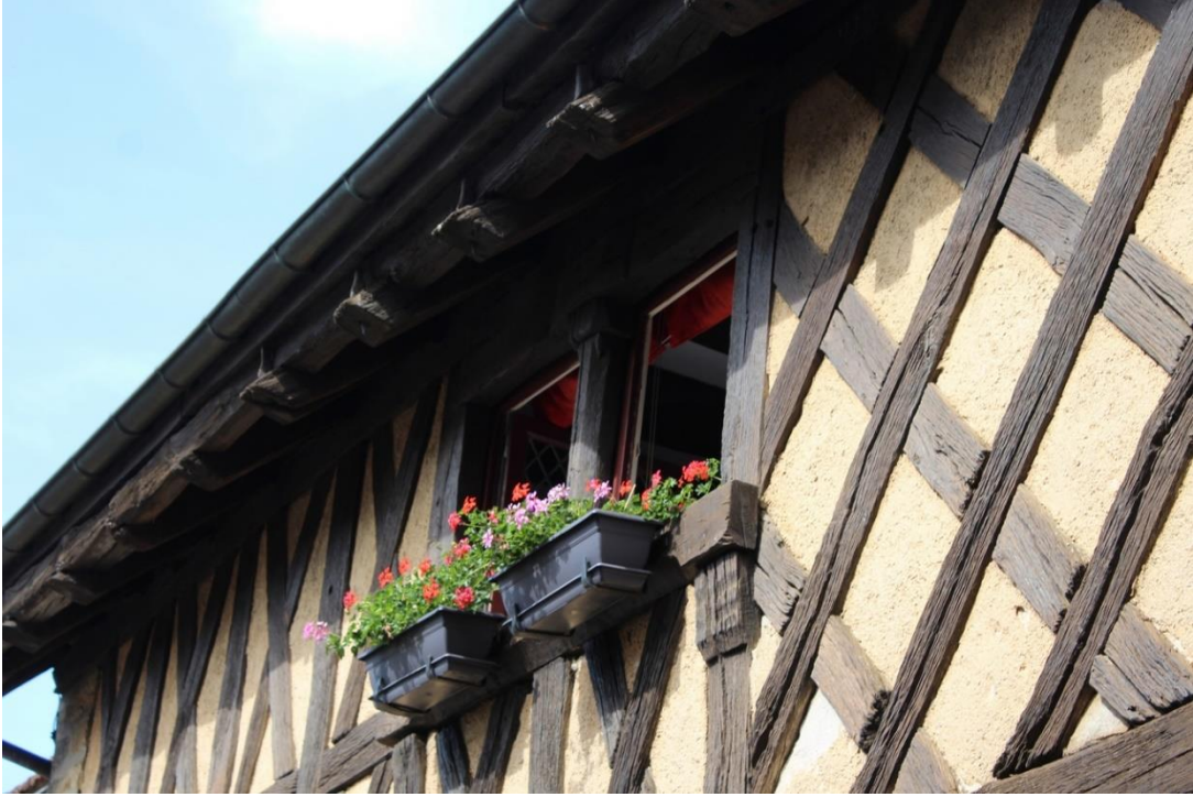
fig. 160 : Avant-toit de la façade gouttereau de Châteauneuf [21152-15]
