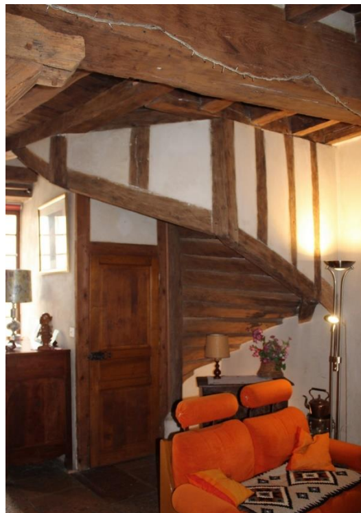
fig. 175 : Aspect de l'escalier en vis (VIS123) de Fontaine-lès-Dijon depuis l'intérieur
