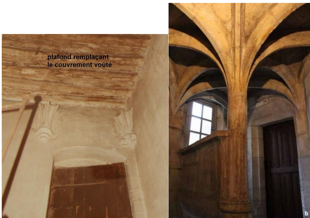
fig. 182 : Couvremet voûté des escaliers en vis (VIS79) (cliché K. Lagorsse, ALIX Stéphane (dir.), Dijon, Côte-d'Or : 61 rue des Godrans, rapport d'opération de diagnostic archéologique, Inrap Grand Est sud, 2017, 170 p.) et (VIS119) (cliché B. Sonnet 1987, CRMH Bourgogne-Franche-Comté)
