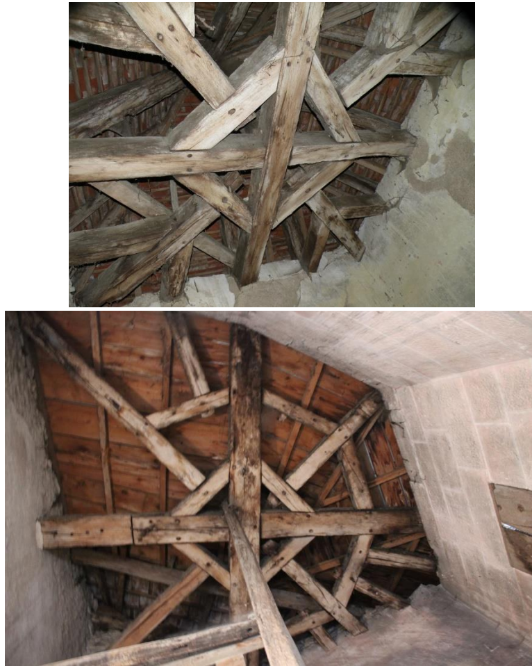
fig. 185 : Charpentes des tourelles (VIS34) et (VIS44)
