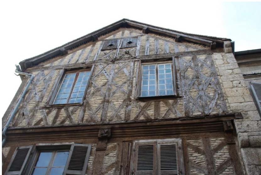
fig. 101 : Partie haute de la façade pignon de Châtillon-sur-Seine [21154-6]
