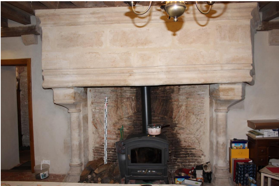
fig. 323 : Pouilly-en-Auxois [21501-6] : cheminée à colonnette contre le mur M4 à l'étage, cliché A. Lacaille
