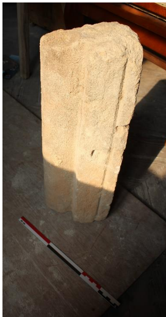
fig. 424 : Auxonne [21038-22] : élément d'une colonnette de baie conservé dans la maison, cliché A. Lacaille
