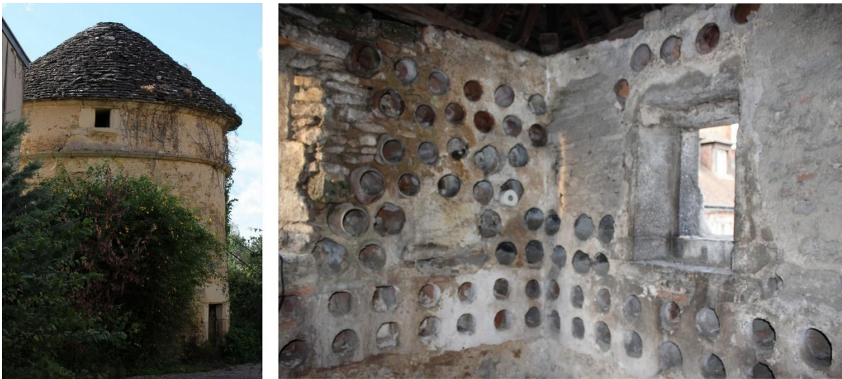
fig. 73 : De rares abris à oiseaux du XVI e siècle encore visibles : pigeonnier dépendant d'une maison à tourelle à Pouilly-en-Auxois [21501-5] et probable volière au sommet de la tourelle d'escalier Renaissance de Beaune [21054-1]
