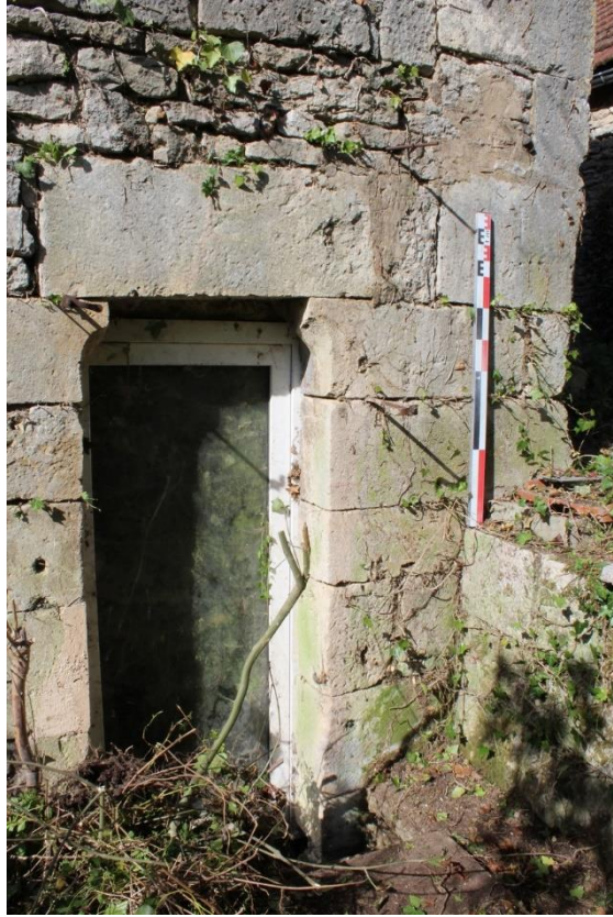
fig. 296 : Flavigny-sur-Ozerain [21271-8] : porte du rez-de-chaussée à l'est de la façade sud M3, cliché A. Lacaille
