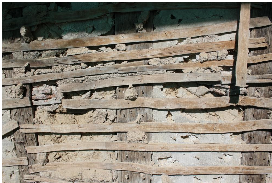
fig. 374 : Semur-en-Auxois [21603-64] : vestiges du torchis et de l'enduit extérieur entre les poteaux du pan de bois sous les lattes modernes, cliché A. Lacaille
