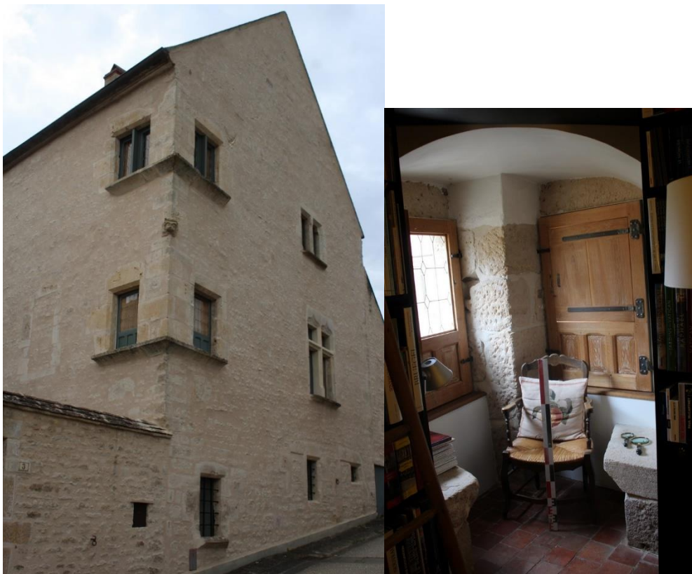
fig. 464 : Fenêtres d'angle de la maison Arbalette à Montréal [89267-10] : vue générale extérieure et vue des fenêtres du rez-de-chaussée surélevée du côté intérieur
