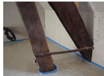
attache de maintien reliant l'arbalétrier à la jambe de force d'une ferme de charpente à Beaune [21054-54]
