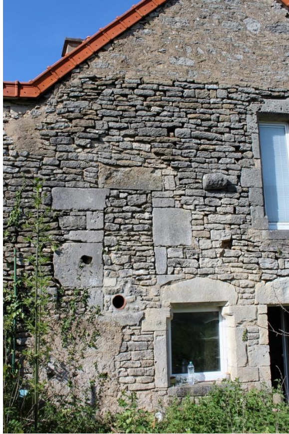
fig. 298 : Flavigny-sur-Ozerain [21271-8] : partie ouest de la façade sud M3, cliché A. Lacaille
