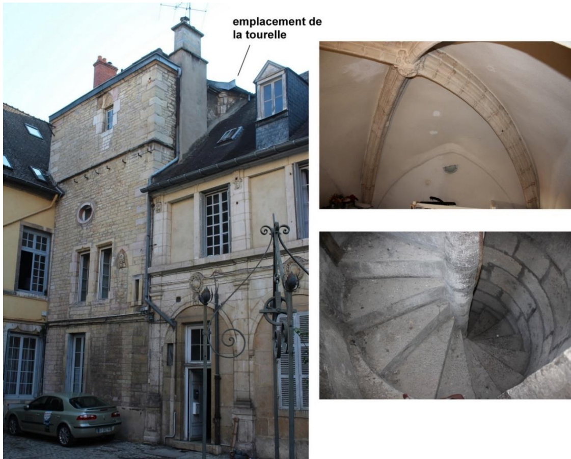
fig. 459 : Maison-tour de l'hôtel Frémyot [21231-47] à Dijon : façade principale, escalier en vis et voûte de l'étage
