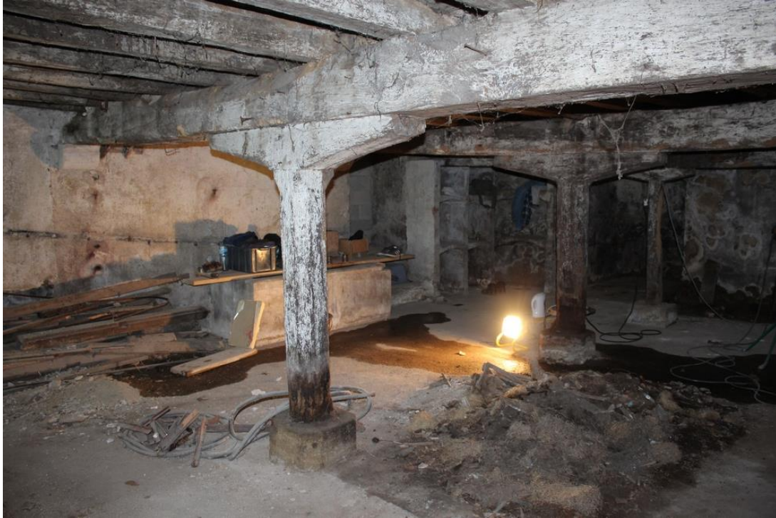
fig. 349 : Semur-en-Auxois [21603-64] : aspect de la cave avant la démolition des plafonds, vu vers l'est, cliché A. Lacaille
