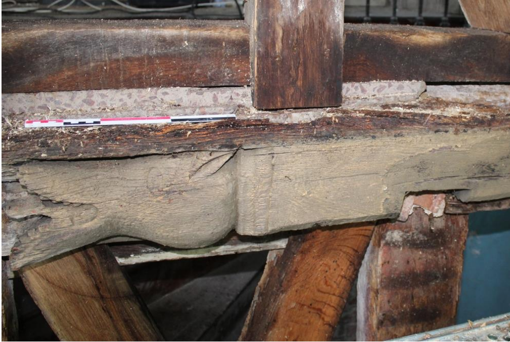
fig. 370 : Semur-en-Auxois [21603-64] : sculpture d'engoulant sur l'extrémité ouest de la sablière de chambrée, cliché A. Lacaille
