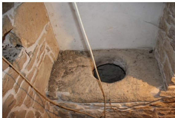
fig. 337 : Pouilly-en-Auxois [21501-6] : les latrines, au sud de la galerie, cliché A. Lacaille
