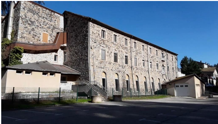
Illustration 43 : le moulinage Lafont, actuellement salle polyvalente et locaux associatifs
