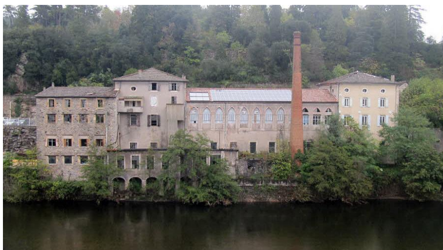
Le site Rocheberg avant travaux
