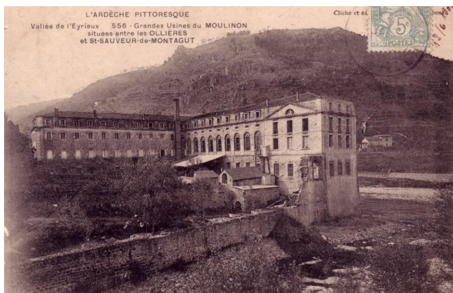
L'usine au début du 20 e siècle (carte postale qui a circulé en 1908) : la troisième aile (côté Auzène) n'est pas encore en place, la cheminée de la filature est bien visible à l'angle de la cour.
