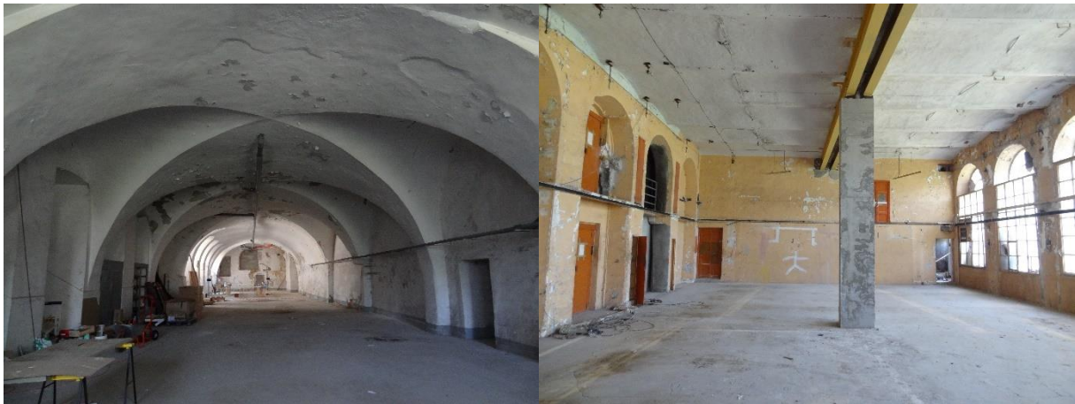
Illustration 17 : les salles du moulinage et de la filature avant travaux
