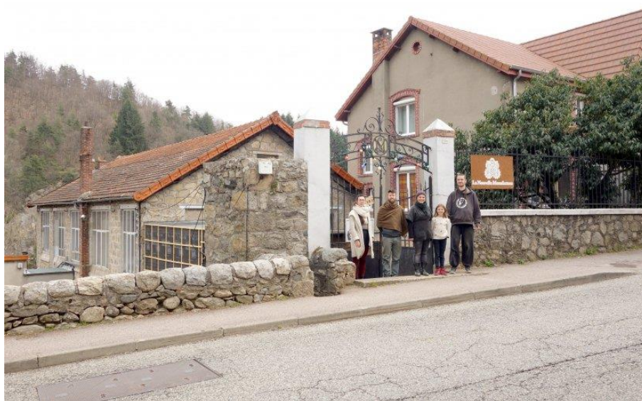
Illustration 47 : La Nouvelle Manufacture avec le café culturel en travaux en 2019
