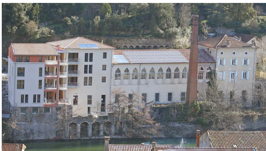
Le site Rocheberg après travaux, en 2015
