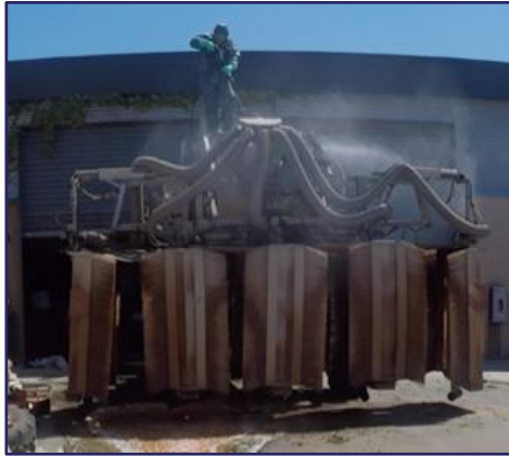
Figure 76 – Nettoyage de l'intérieur de la cuve
