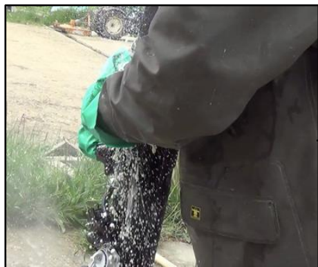
Figure 80 – Retrait des buses et des filtres sur les descentes
