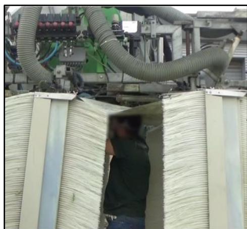
Figure 43 – Réparation des bâches
