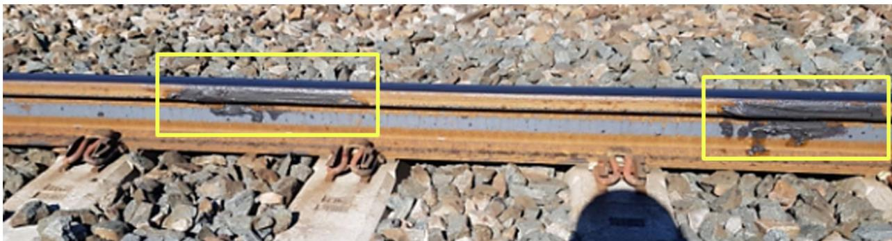
FIGURE I.43 – Rail graissé excessivement ayant engendré un enrayage avec arrêt d'un train hors quai (document interne SNCF). Les zones encadrées permettent d'identifier des zones graissées excessivement.
