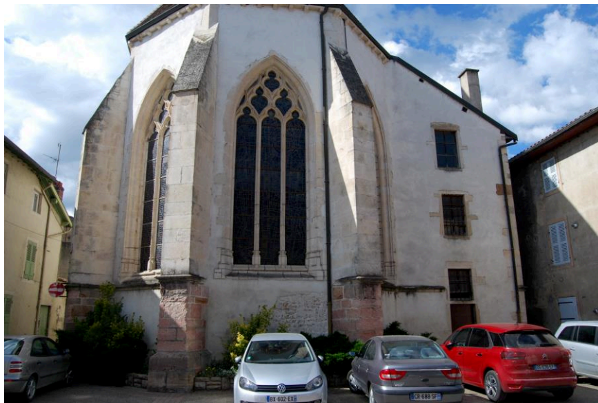
Figure 87 : Notre-Dame de Pont-de-Vaux : chevet et bâtiment de la sacristie.
