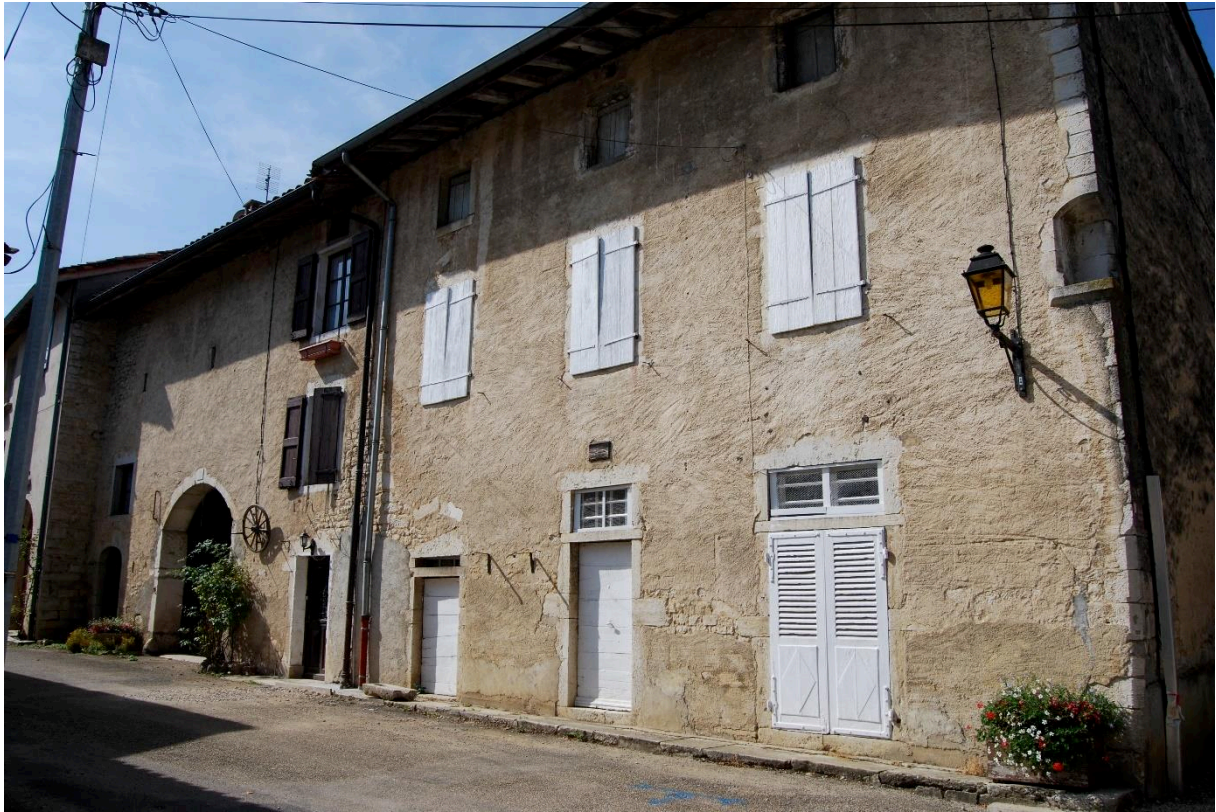
Figure 59 : maison dite du chapitre
