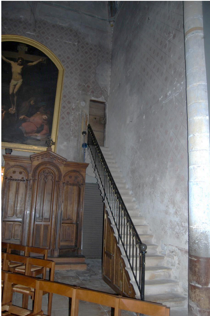
Figure 126 : Belleville : escalier du bras sud du transept qui menait au dortoir
