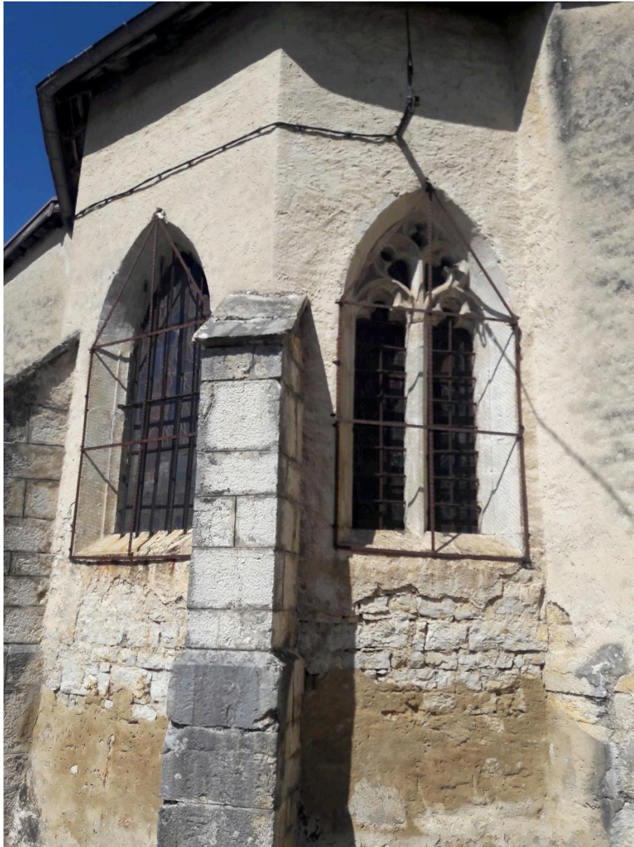
Figure 81 : Église de Cerdon. Vue extérieure de l'abside, baies et remplages nord, 2018.
