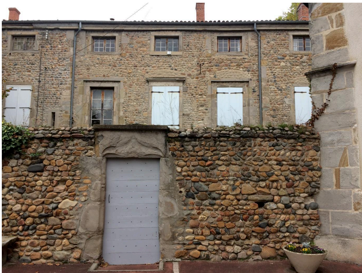
Figure 117 : entrée du château : mur d'enceinte en galet, contrefort nord-ouest de l'église et château en arrière-plan (2016).
