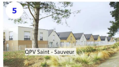
5 QPV Saint - Sauveur Quartier Saint-Sauveur, construction de 26 logements individuels dans le cadre du PNRU
