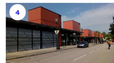
4 Quartier Perseigne- production de logements et locaux commerciaux dans le cadre du PNRU
