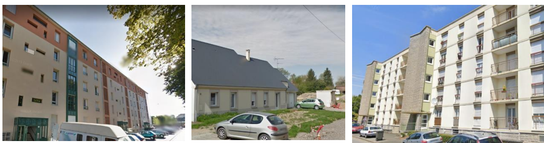
Immeubles des années 1960 réhabilités en logements étudiants
