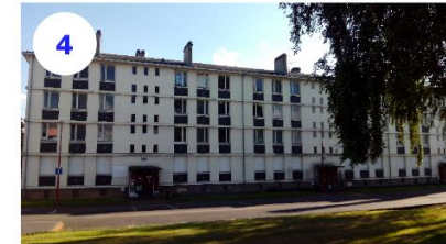
4 Quartier des Fleurs- Immeuble des années 1970
