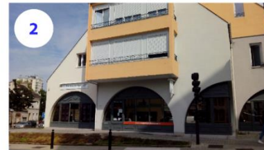
2 Quartier Montsort- Logements et locaux du bailleur et d'associations en rez-de-chaussée
