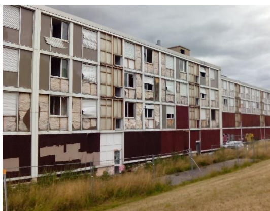
Immeubles en attente de démolition, en bordure d'une opération PNRU à Firminy Vert, Firminy, Loire
