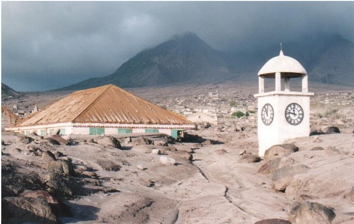
Figure II.6 : Photo prise en 1997 du centre ville de Plymouth (ex-capitale de Montserrat) après 2 ans d'éruption. La ville a été entièrement recouverte par les différents écoulements pyroclastiques engendrés par Soufrière Hills qu'on devine en fond dans les nuages (Kokelaar, 2002).
