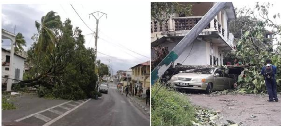
Photographie 14: dégâts matériels causés par le passage du cyclone Kenneth
