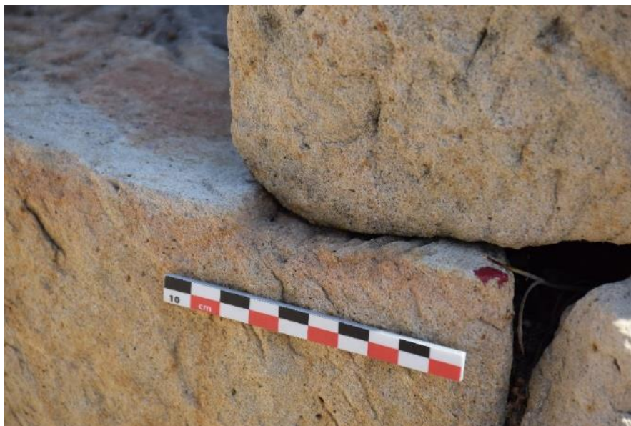
Fig. 56. Photographie du décrochement du bloc 8 et angle du bloc 14 en place.
