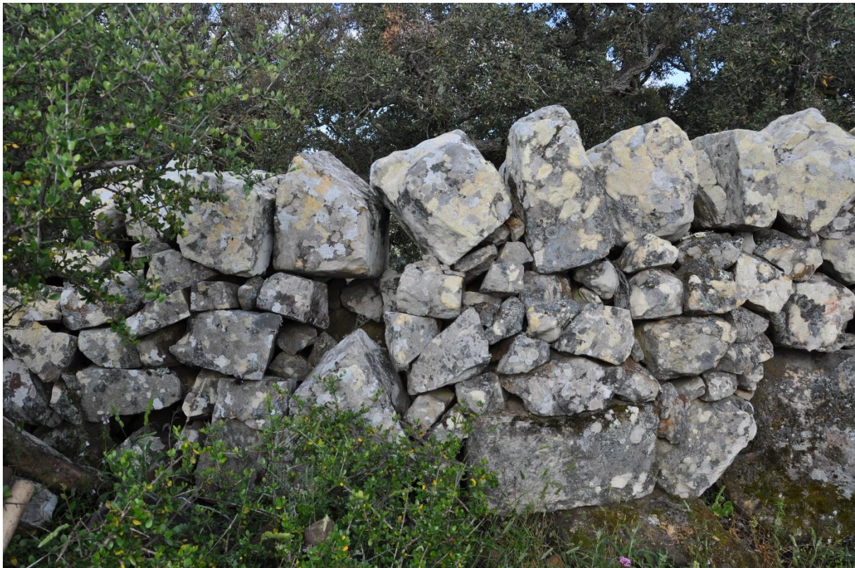
Fig. 5. Photographie d'une portion du muret moderne qui remployait des blocs d'architecture.
