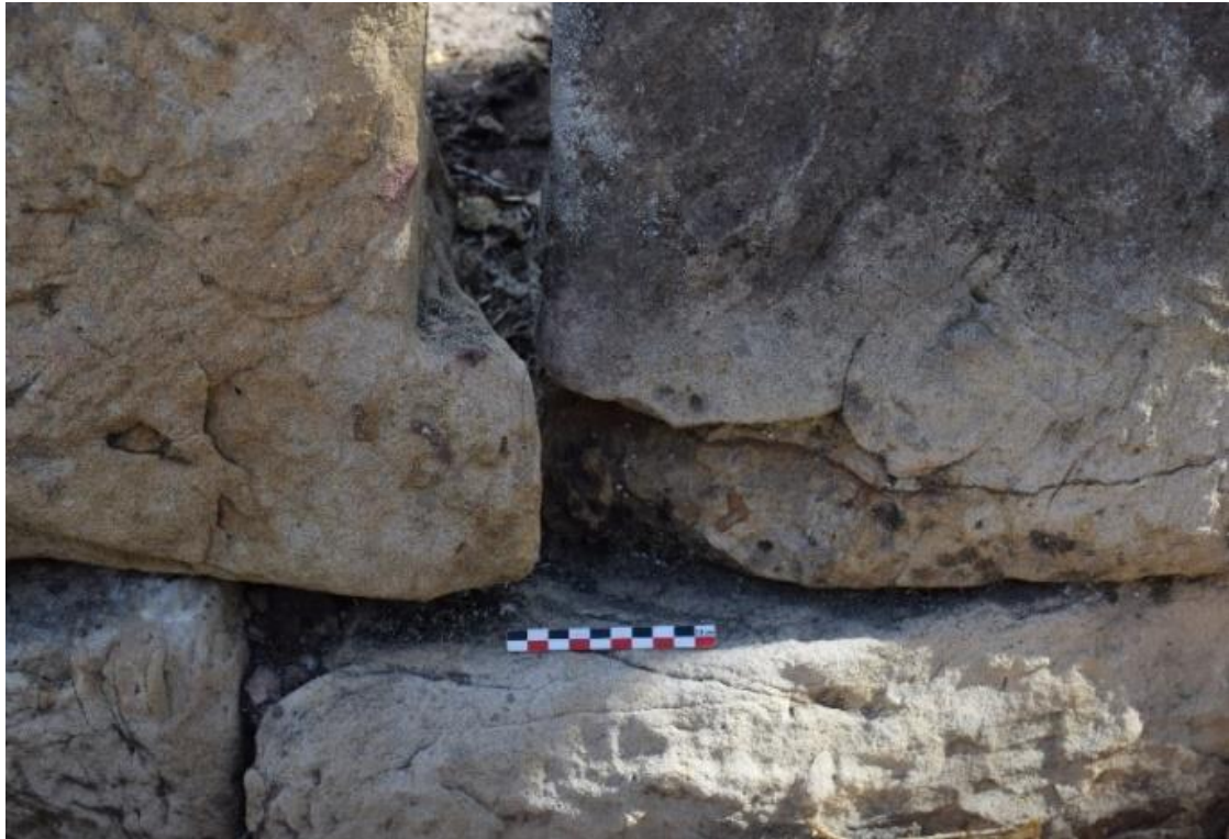
Fig. 44. Photographie du décrochement.
