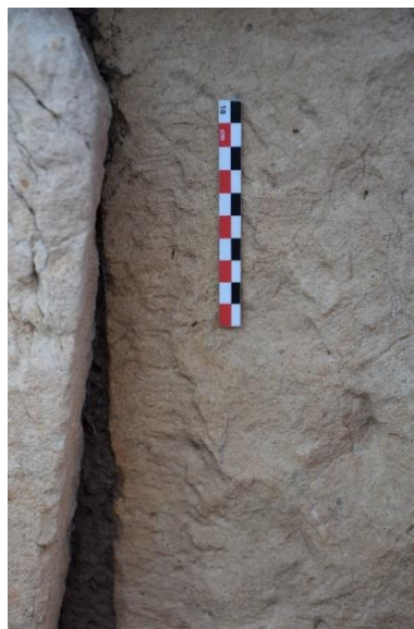
Fig. 48. Photographie de la feuilure observée sur la face de joint d'un des blocs de la première assise.
