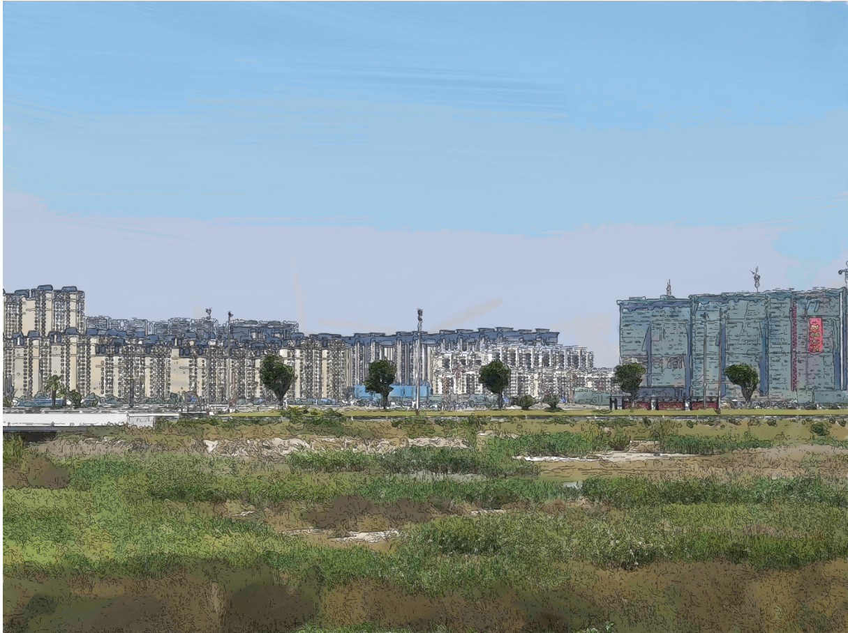
Figure 66 : Construction d'un quartier résidentiel dans la nouvelle ville-éponge (© Séphora Loaiza Zuluaga, 2021)
