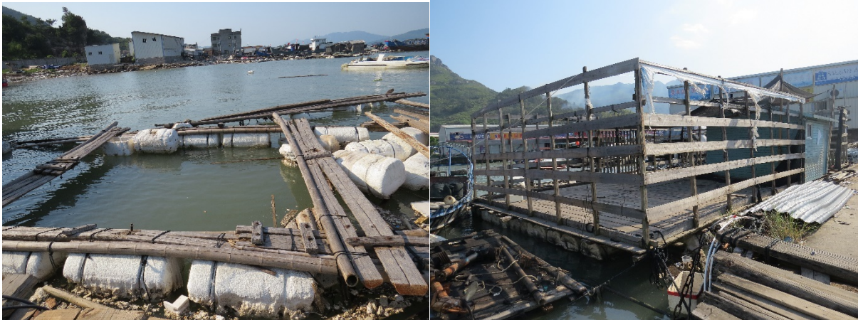
Figure 50 : Etapes de construction d'une maison flottante (© Séphora Loaiza Zuluaga, 2018)
