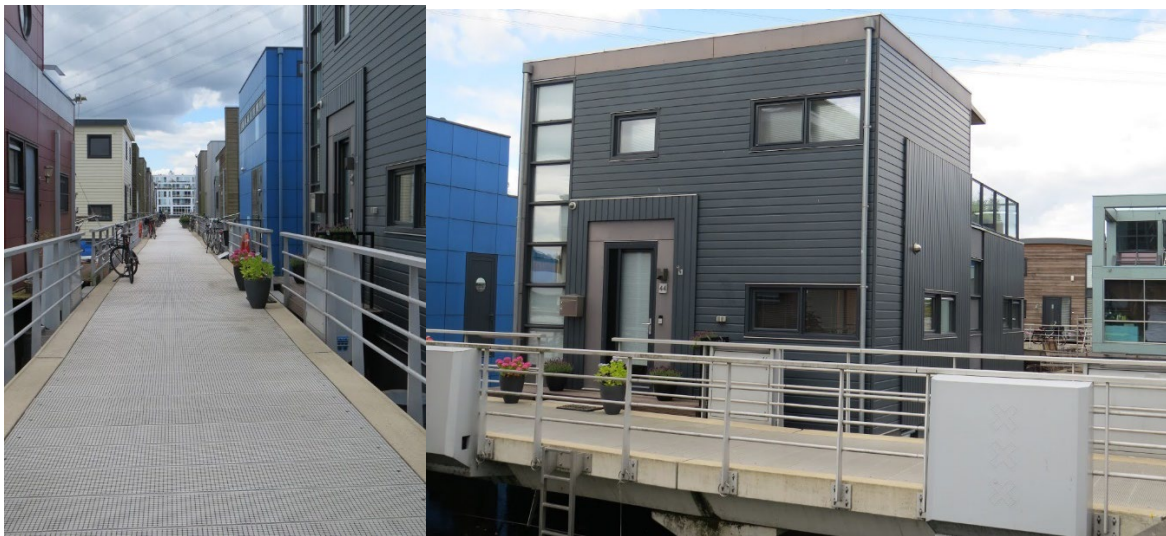
Figure 17 : Passerelles métalliques dans le quartier flottant IJburg (© Séphora Loaiza Zuluaga, 2019)
