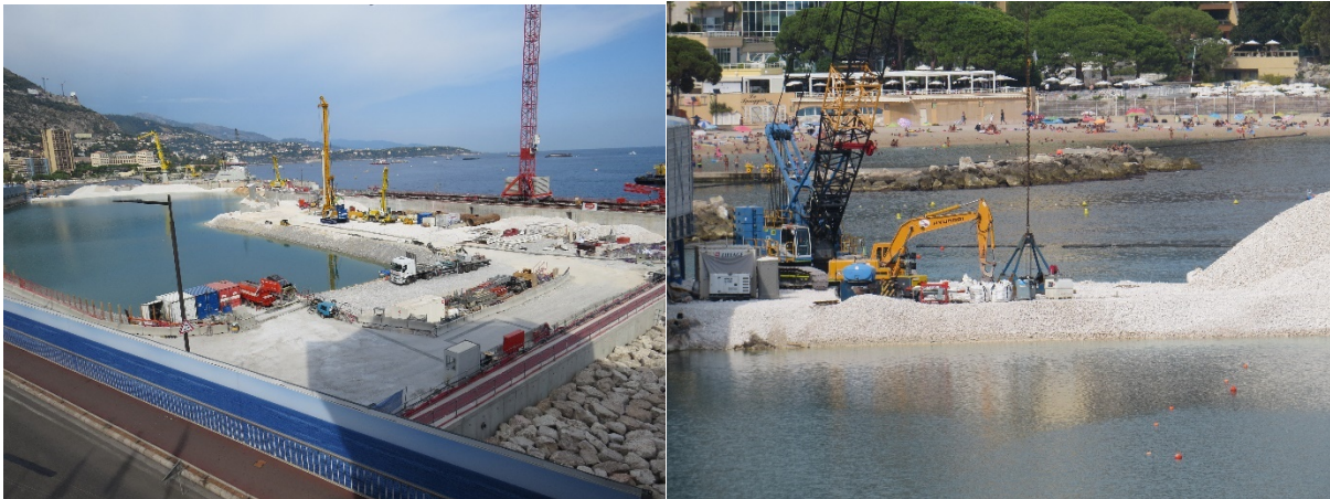
Figure 4 : Pose d'un sol terrestre dans un nouveau quartier à Monaco (© Séphora Loaiza Zuluaga, 2019)
