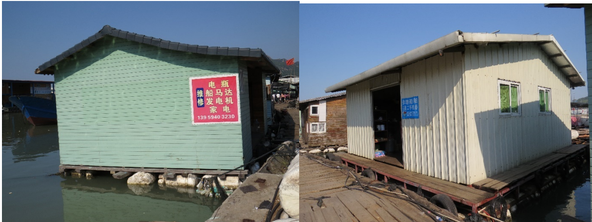
Figure 21 : Utilisation de tôles métalliques et de bois pour la construction des maisons (© Séphora Loaiza Zuluaga, 2018)
