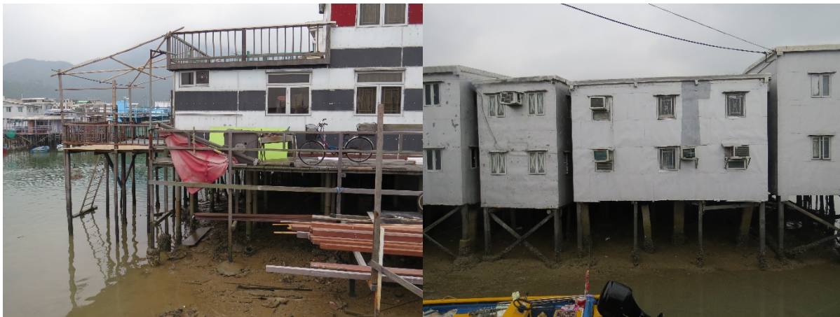
Figure 23 : Utilisation principale de bois et de tôles métalliques (© Séphora Loaiza Zuluaga, 2018)
