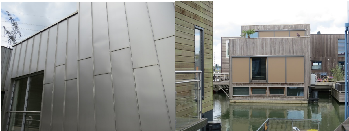
Figure 13 : Utilisation de métal et de bois pour le revêtement de façades (© Séphora Loaiza Zuluaga, 2019)
