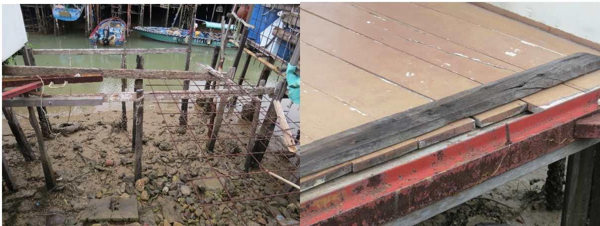
Figure 24 : Planches de bois et de ferraille sur des pieux en bois (© Séphora Loaiza Zuluaga, 2018)
