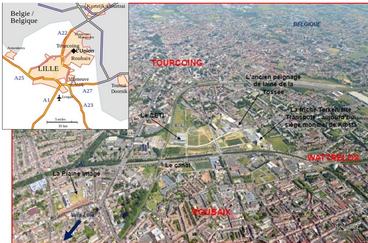
Figure n 47 : Le site de l'Union en cours d'aménagement (2014).
