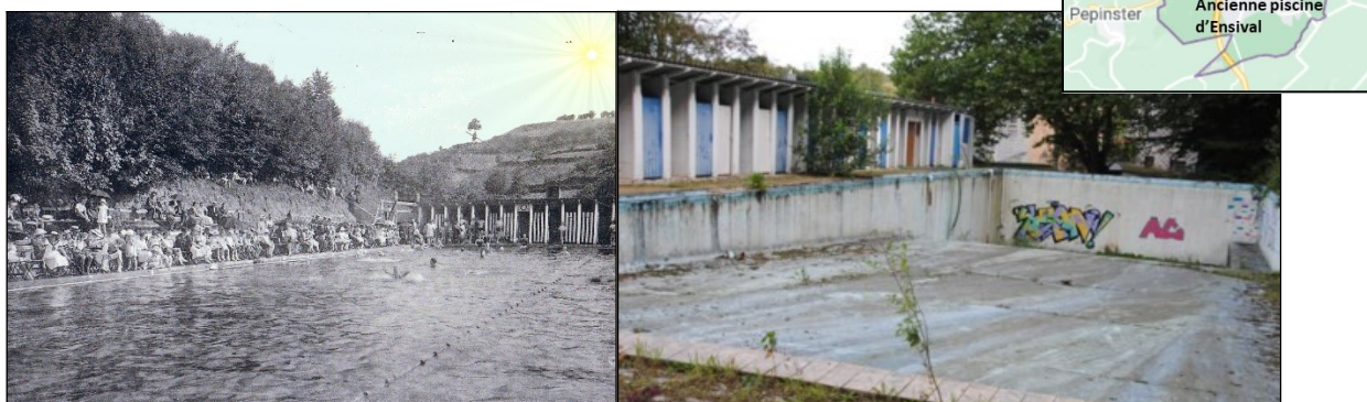
Photographie n°73 : L'ancien bassin de natation d'Ensival
