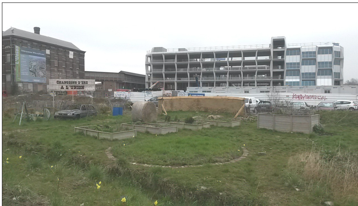
Figure n°95 : Le chantier du parking silo et la ruche d'entreprises de La Tossée se trouvent place à la place et au milieu des friches (octobre 2014).
