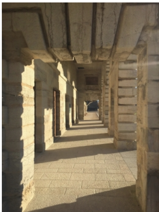
Corridor du bâtiment ouest destiné à l'évaporation du sel.
