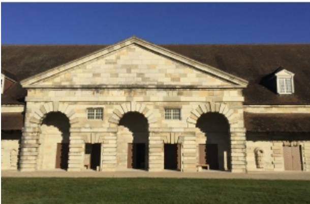
Bâtiment pour la cuisson du sel avec des bossages dans les arches et autour des ouvertures. Inspiration palladienne de Ledoux.
