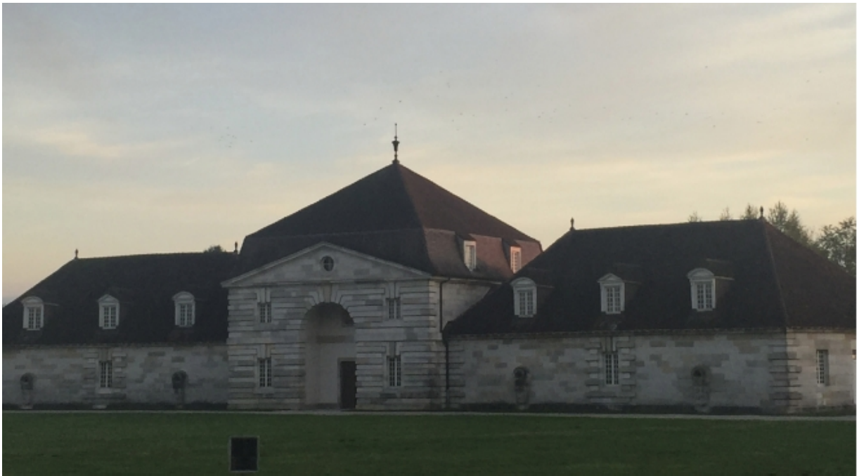
Hangar ouest (chaufferie) de la saline royale d'Arc-et-Senans.
