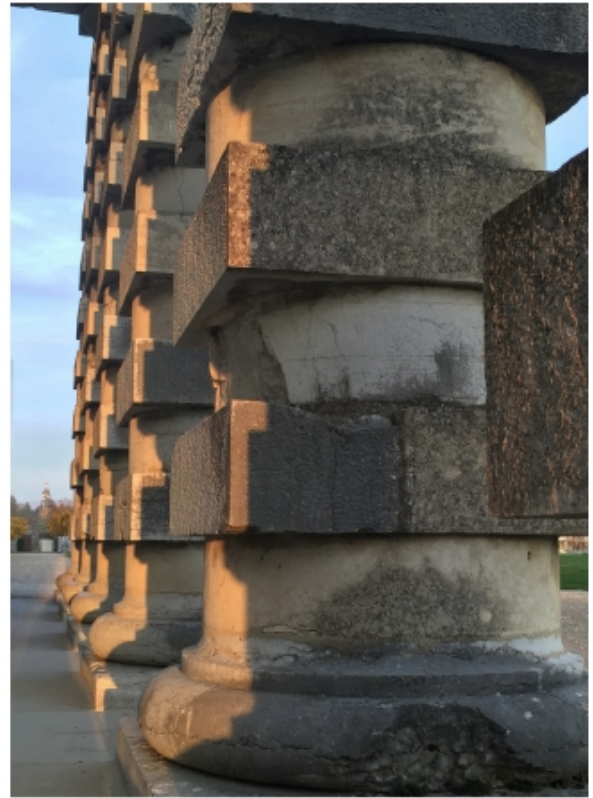
Colonnes à sections carrés et circulaires de la maison du directeur des salines.
