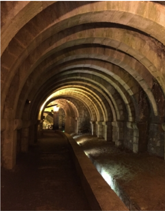
Canalisation souterraine de la saline de Salins les Bains.
