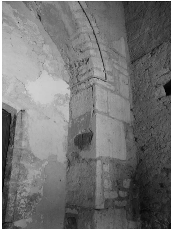
Fig. 17 : Détails du piédroit sud du portail.
