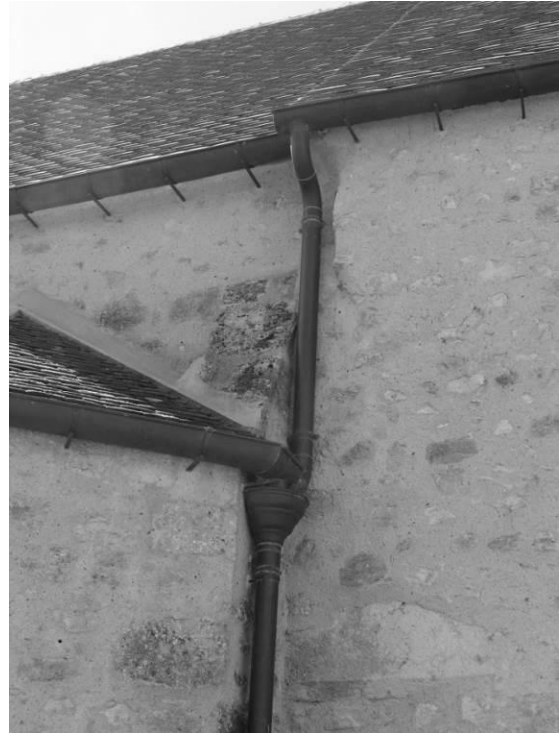
Fig. 11 : La jonction entre le mur gouttereau nord de la nef et le chevet.
