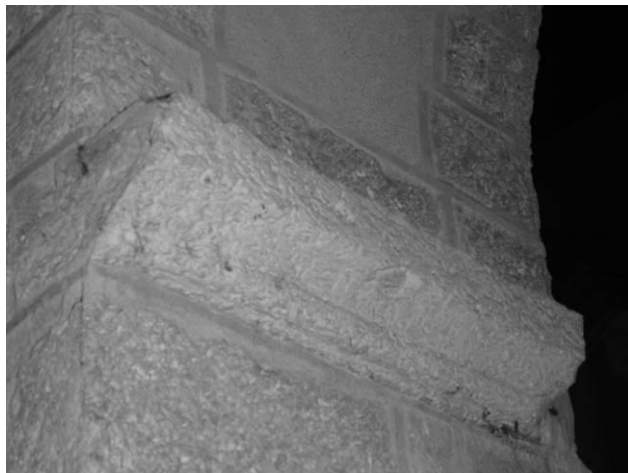
Fig. 75 : Mur gouttereau nord, troisième pilier depuis l'est, imposte ouest.
