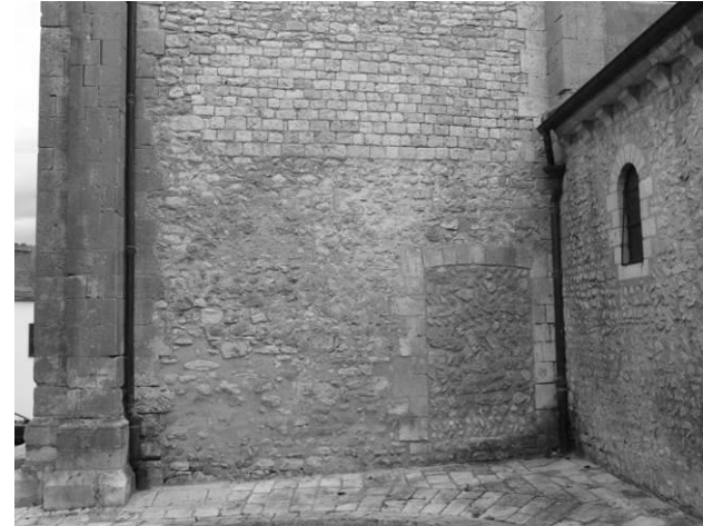
Fig. 78 : Le mur ouest du bras nord du transept.
