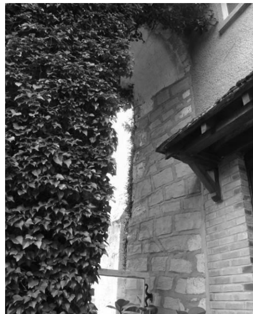
Fig. 21 : Arcade subsistant dans la paroi sud de l'abside.
