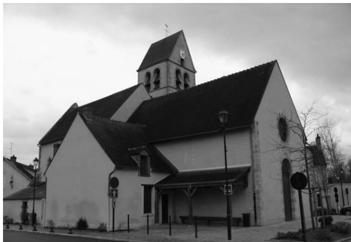
Fig. 6 : L'église vue depuis le nord-ouest.
