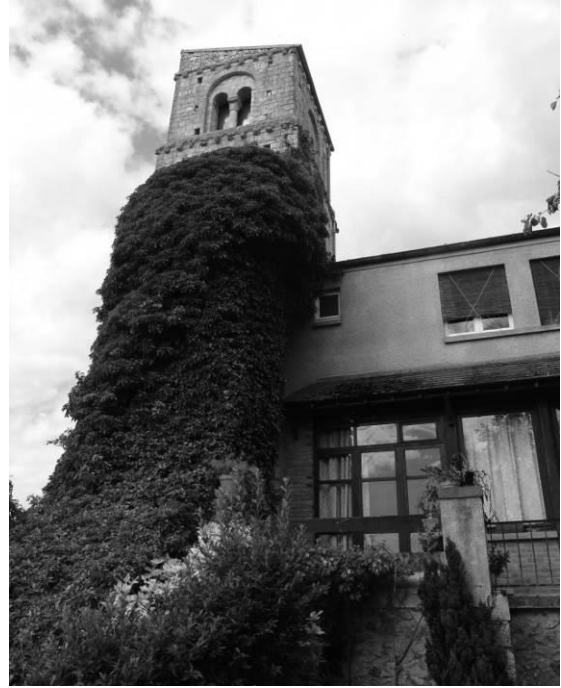
Fig. 15 : La tour, vue depuis l'est.
