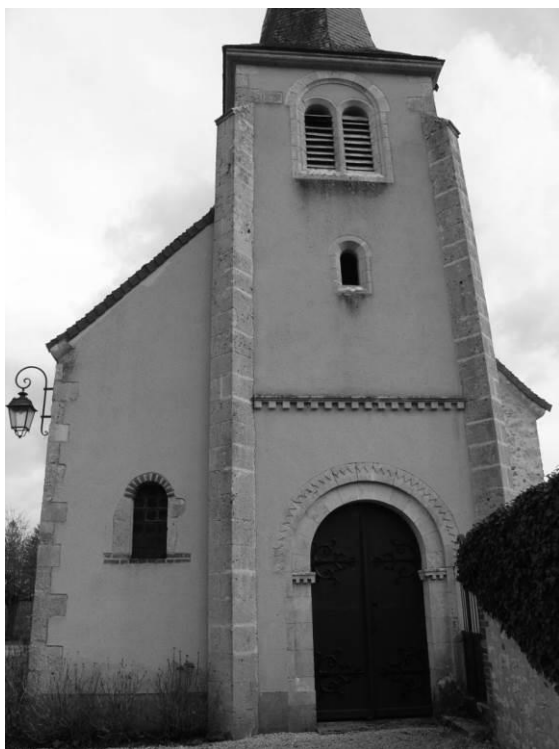
Fig. 11 : La façade ouest.
