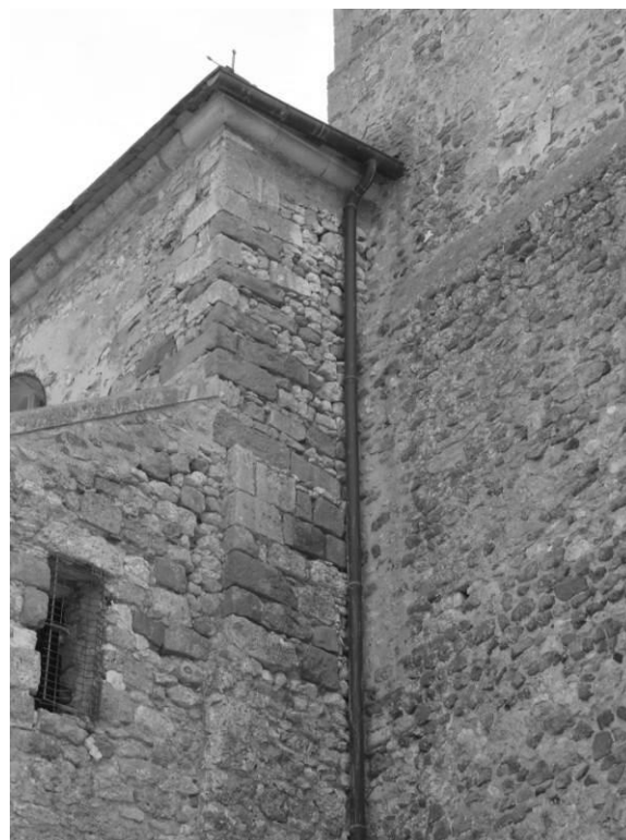
Fig. 16 : Jonction entre le mur nord du clocher et la nef.
