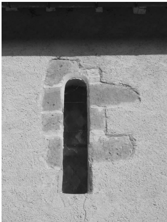
Fig. 10 : La baie orientale du mur sud de la nef.
