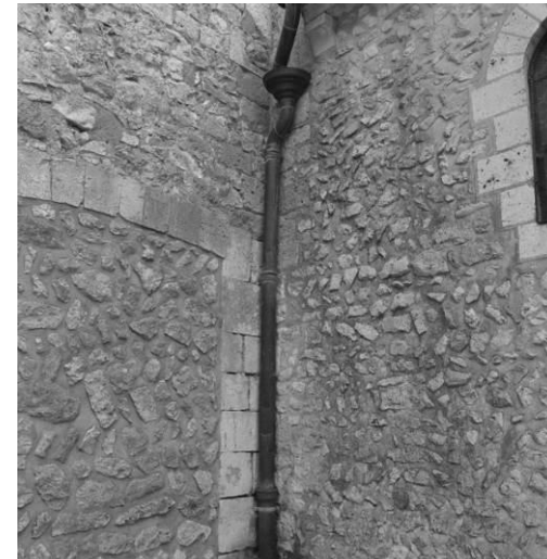
Fig. 26 : Angle oriental entre le bas-côté nord et le transept.
