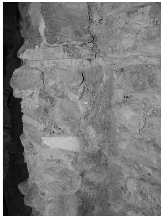
Fig. 46 : Le contrefort sud.
