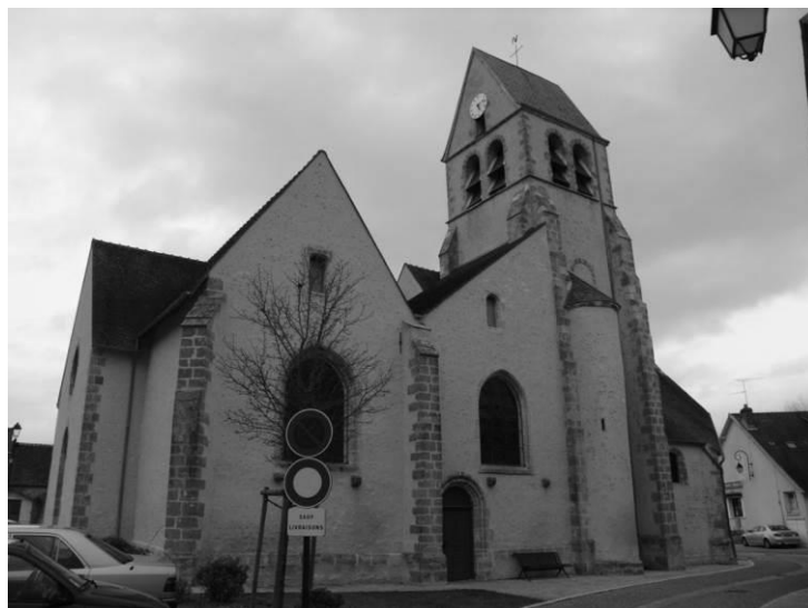
Fig. 8 : L'église vue depuis le sud-ouest.
