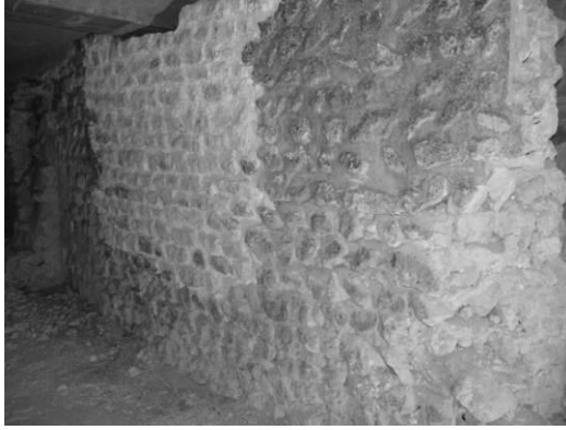
Fig. 70 : Couloir sud, partie orientale du mur sud.
