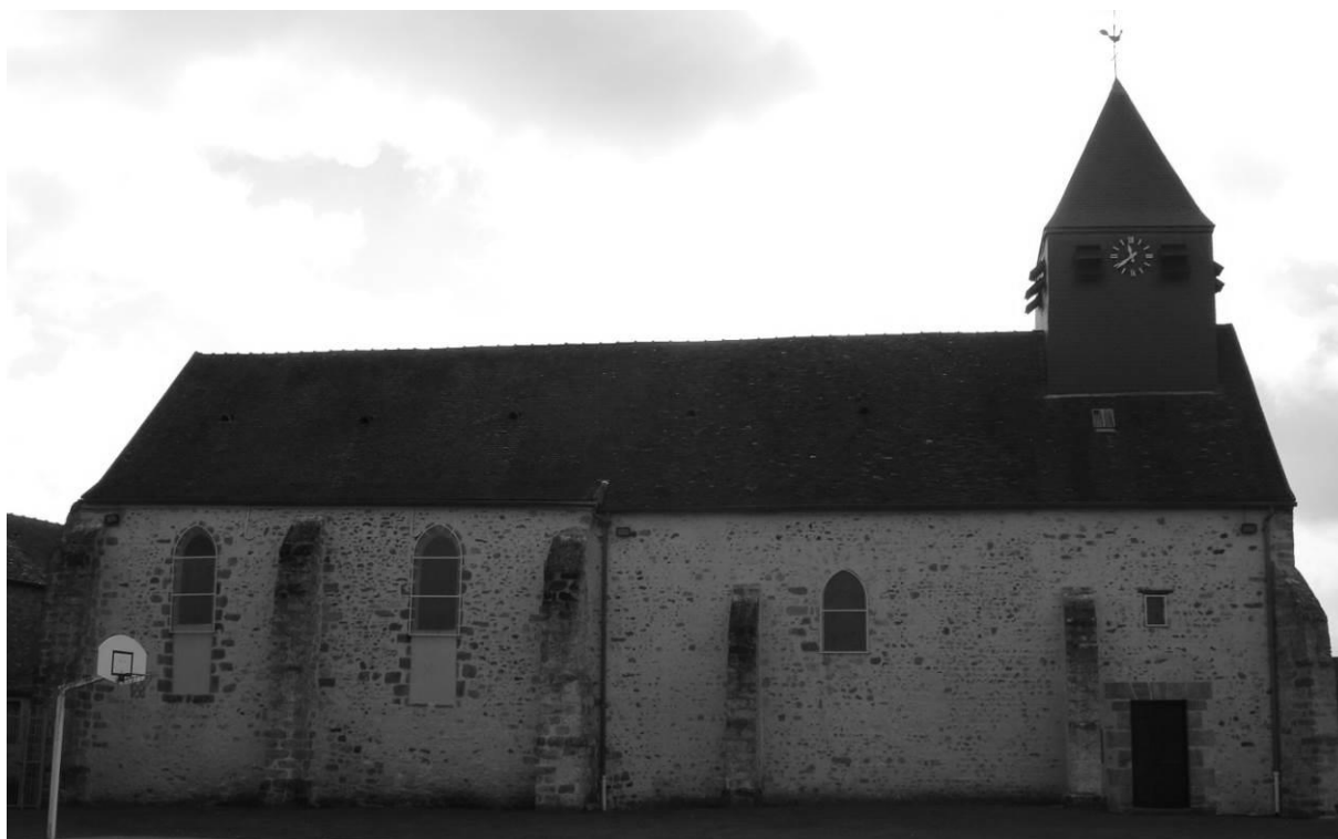
Fig. 11 : Le mur nord de l'église.
