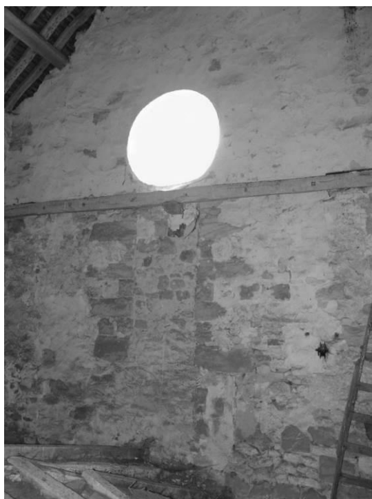
Fig. 39 : Le mur sud de l'ancien clocher (actuel bras sud du transept).
