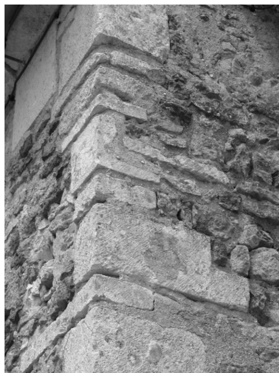
Fig. 11-12 : Le chaînage d'angle entre la nef et le chevet, au sud.
