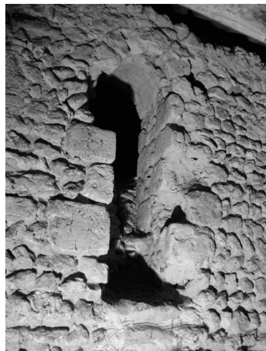
Fig. 55 : Mur gouttereau nord : la baie orientale.
