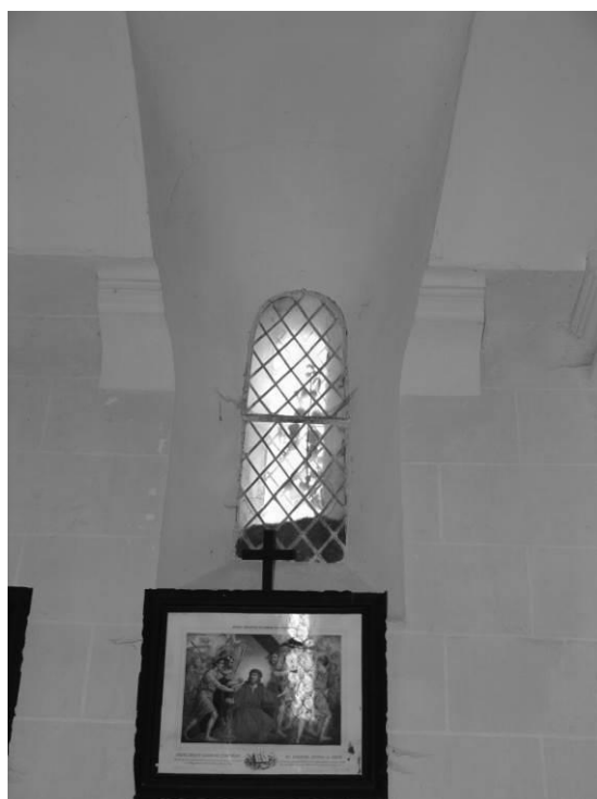
Fig. 12 : L'ébrasement intérieur d'une baie du mur sud de la nef.
