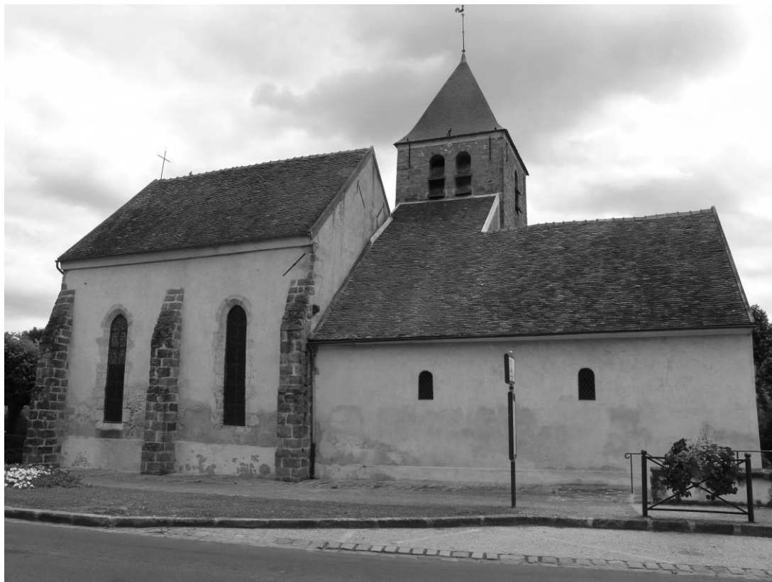
Fig. 8 : Vue de l'église depuis le nord.
