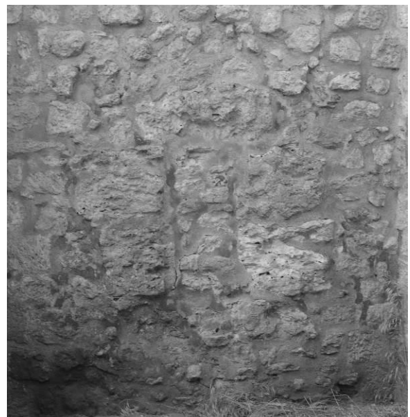
Fig. 28 : Détail de la fig. 24 : Une baie bouchée.
