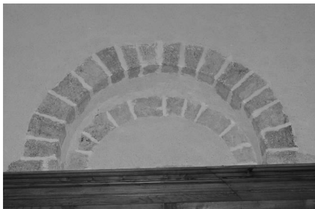
Fig. 31 : La partie supérieure du revers du portail sud.
