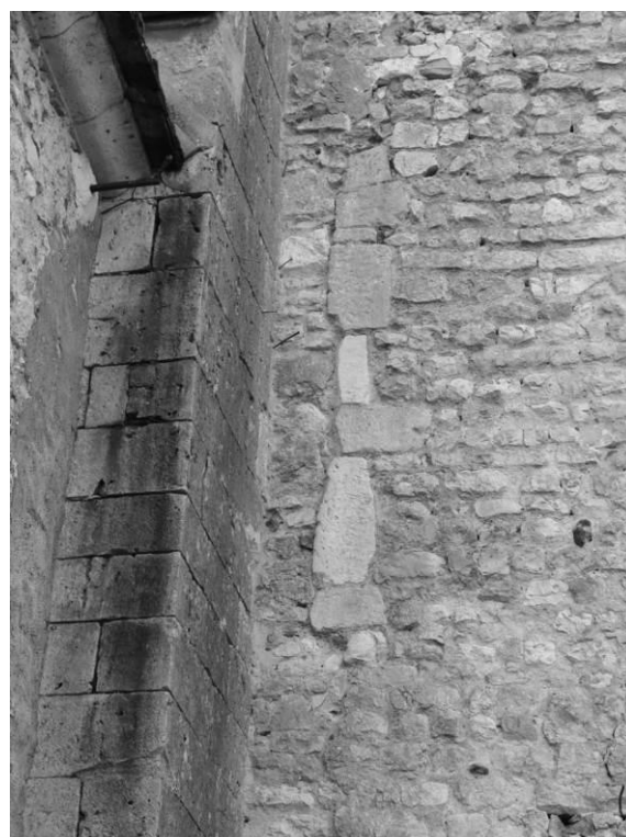
Fig. 41 : Vestiges d'une fenêtre dans le mur gouttereau nord de la nef.
