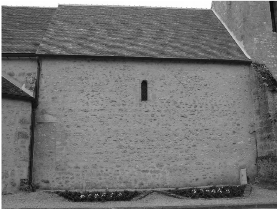
Fig. 8 : Le mur gouttereau nord de la nef.
