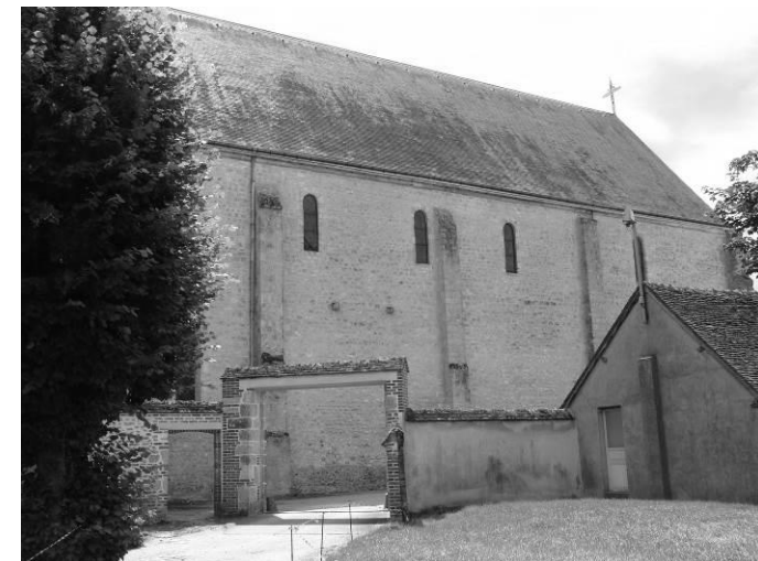
Fig. 17 : Le mur gouttereau nord de la nef.
