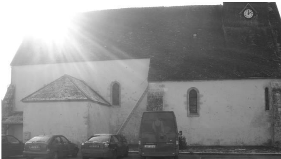
Fig. 9 : Le mur nord de l'église.
