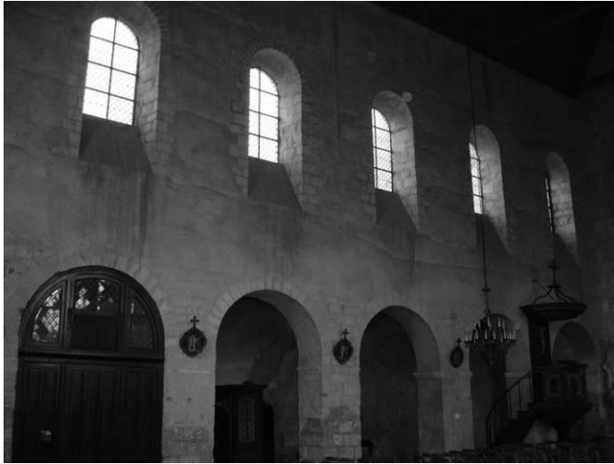
Fig. 63 : Le mur gouttereau nord de la nef.
