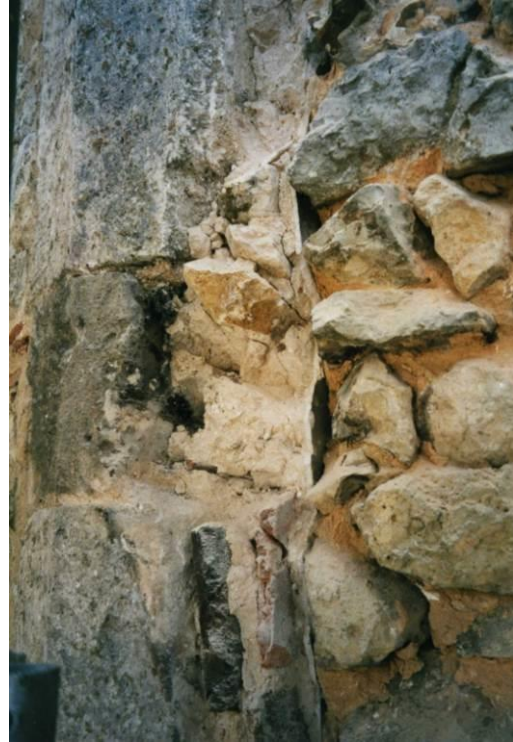
Fig. 19 : Traces de reprises entre l'angle oriental et le mur en moellons.
