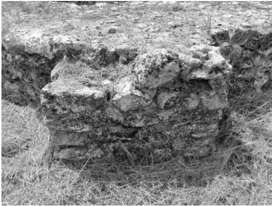
Fig. 49 : L'un des deux contreforts de l'abside.
