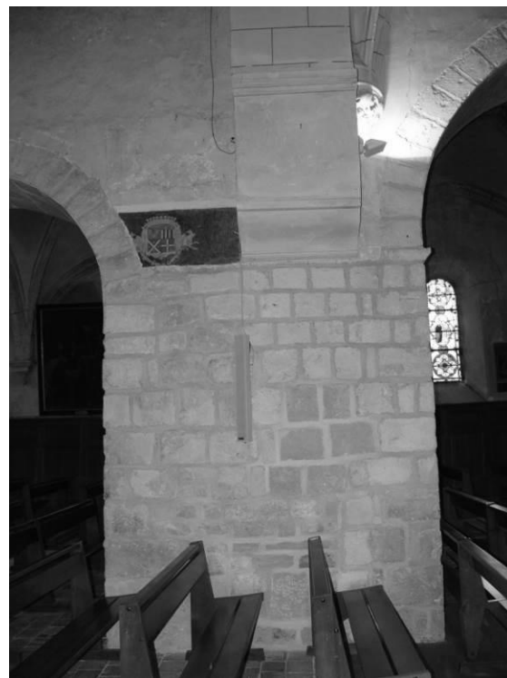
Fig. 24 : Le deuxième pilier du mur gouttereau nord de la nef, face sud.
