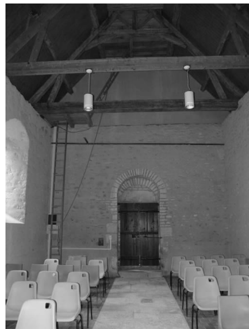
Fig. 72 : L'intérieur de l'édifice, vu vers l'ouest, en 2008.
