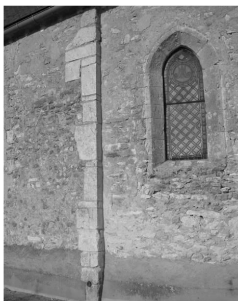
Fig. 9-10 : Vue générale et détail du chaînage d'angle sud, à la naissance de l'abside.
