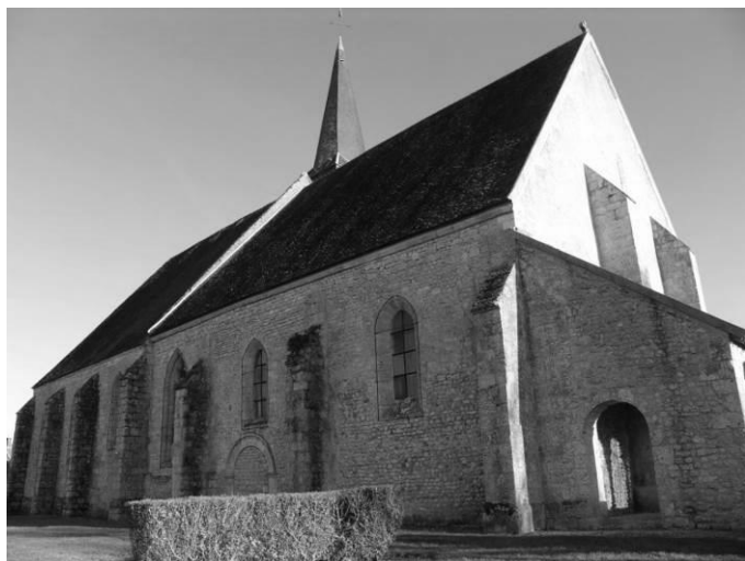
Fig. 10 : La façade nord.
