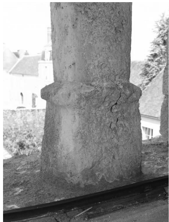
Fig. 37 : Base de la colonnette de la baie géminée ouest.
