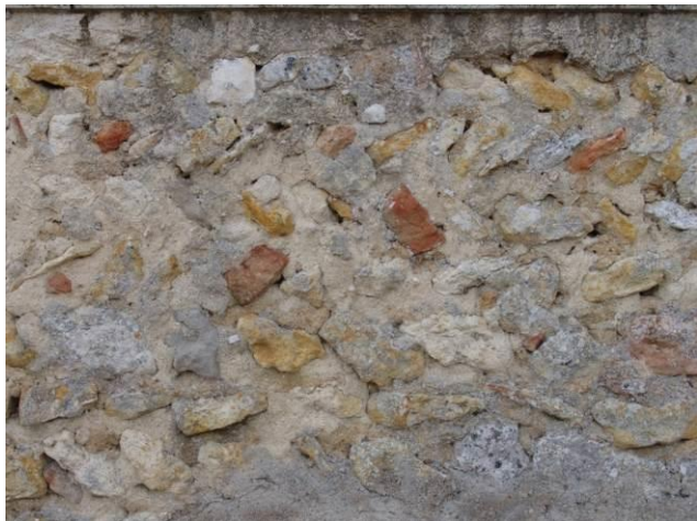
Fig. 22 : Détail du parement en opus spicatum du mur gouttereau nord de la nef.
