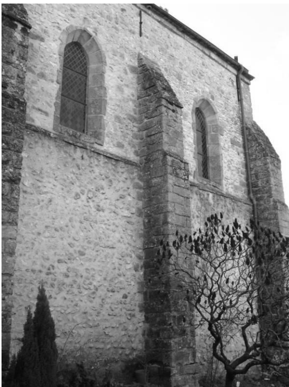
Fig. 14 : Le mur gouttereau nord de la nef.
