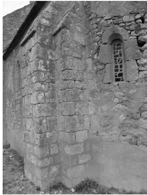
Fig. 29 : La jonction entre la travée droite et l'absidiole au sud.
