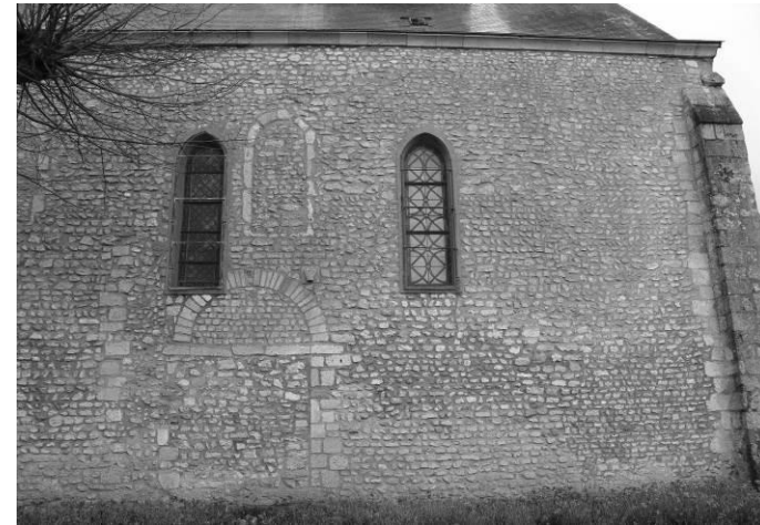
Fig. 9 : Le mur nord de la nef.
