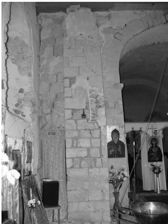
Fig. 53 : Le pignon oriental de la nef, côté nord.
