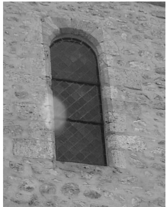
Fig. 21 : Fenêtre occidentale du mur gouttereau nord de la nef.
