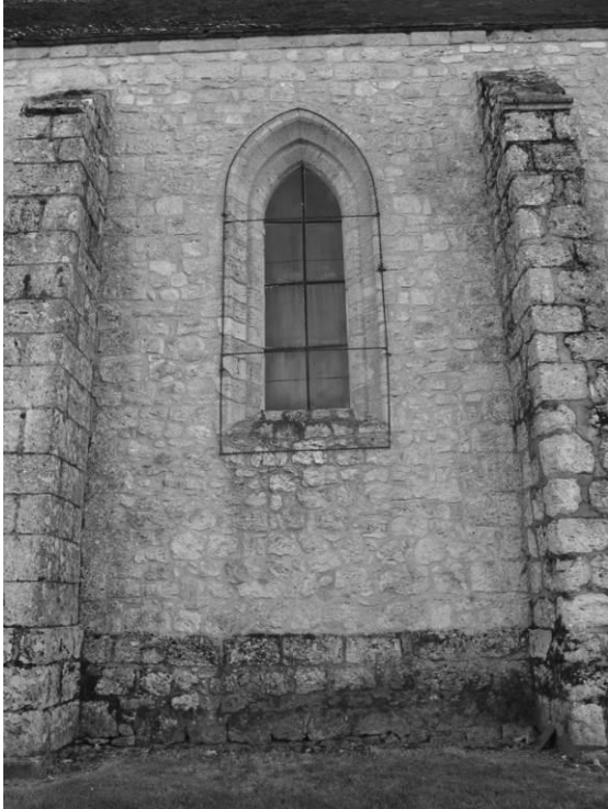
Fig. 24 : Le mur nord de l'église : cinquième travée depuis l'ouest.
