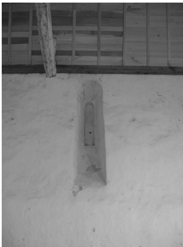
Fig. 33 : Baie bouchée dans le mur nord.
