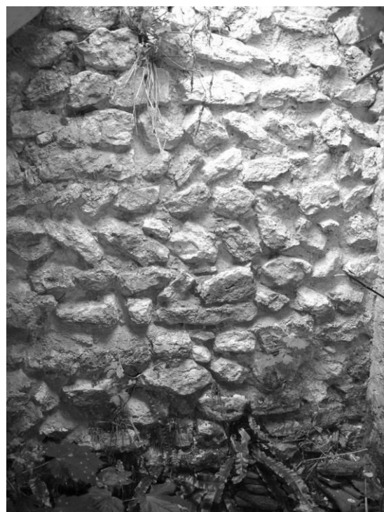
Fig. 29 : Détail du parement en opus spicatum du mur sud.
