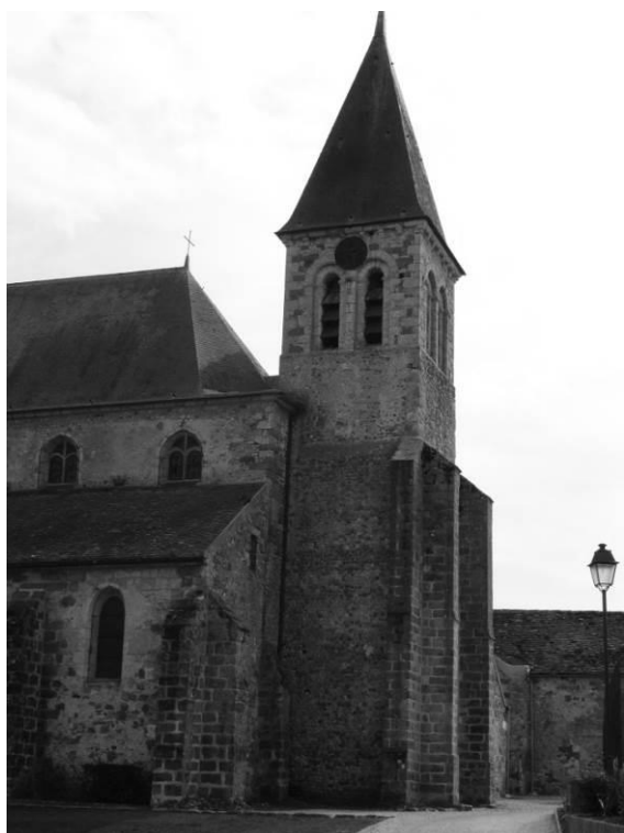
Fig. 13 : La face nord du clocher.
