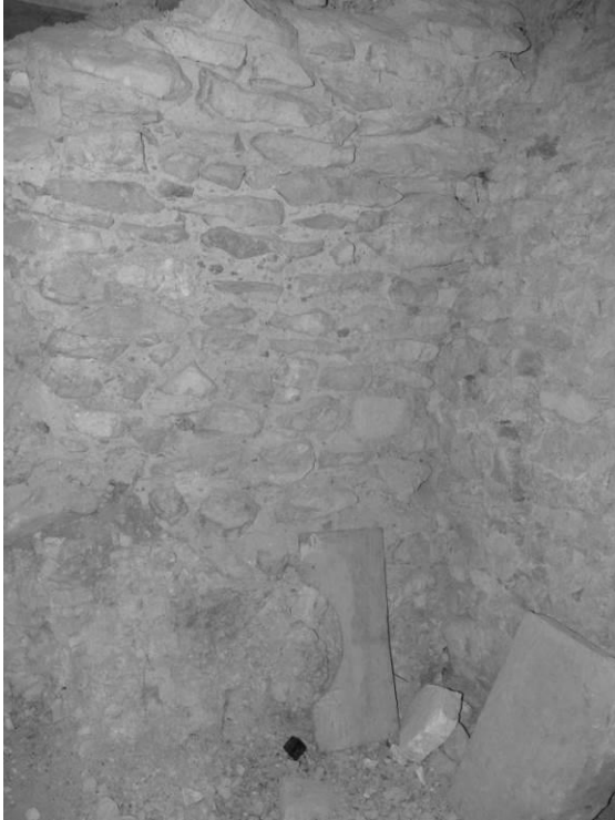
Fig. 94 : Le mur nord de la salle sud, extrémité occidentale.
