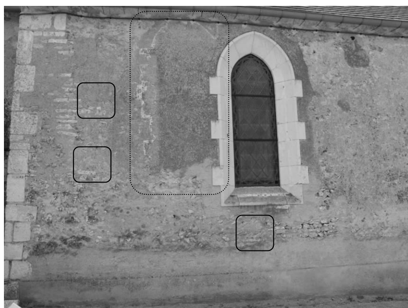
Fig. 20 : La partie orientale du mur gouttereau nord de la nef. Trois trous de boulins sont encadrés ainsi qu'une baie bouchée en pointillés.
