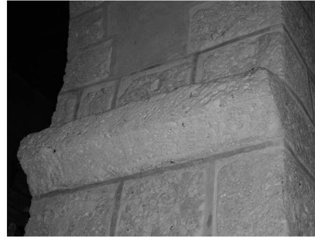
Fig. 74 : Mur gouttereau nord, troisième pilier depuis l'est, imposte est.
