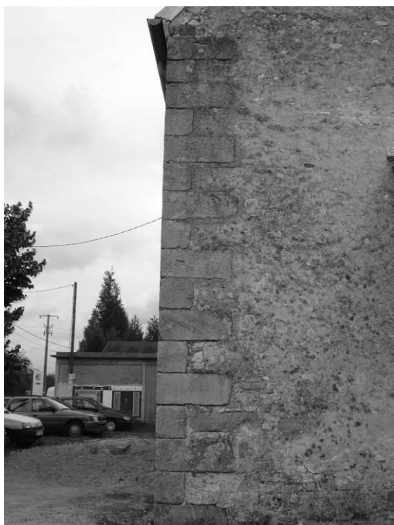
Fig. 20 : L'angle nord-ouest de l'édifice, face ouest.
