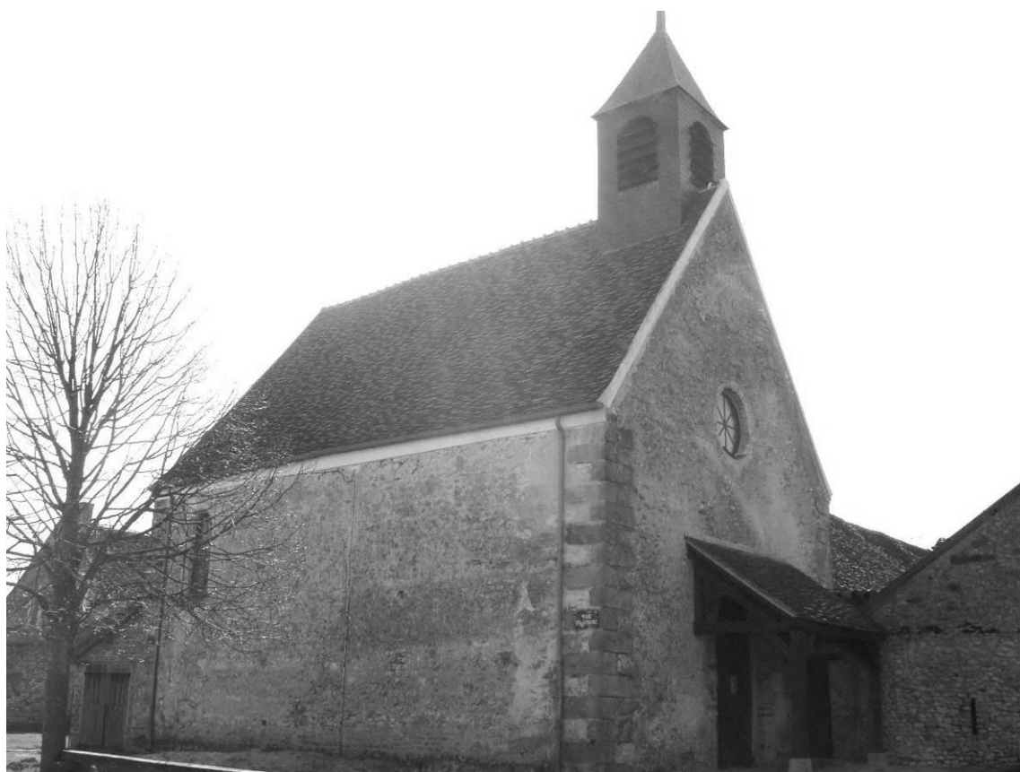
Fig. 13 : L'église vue depuis le nord-ouest.
