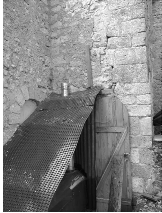
Fig. 33 : L'angle entre le mur nord de la travée droite du chœur, à gauche, et le mur pignon oriental de la nef, à droite.
