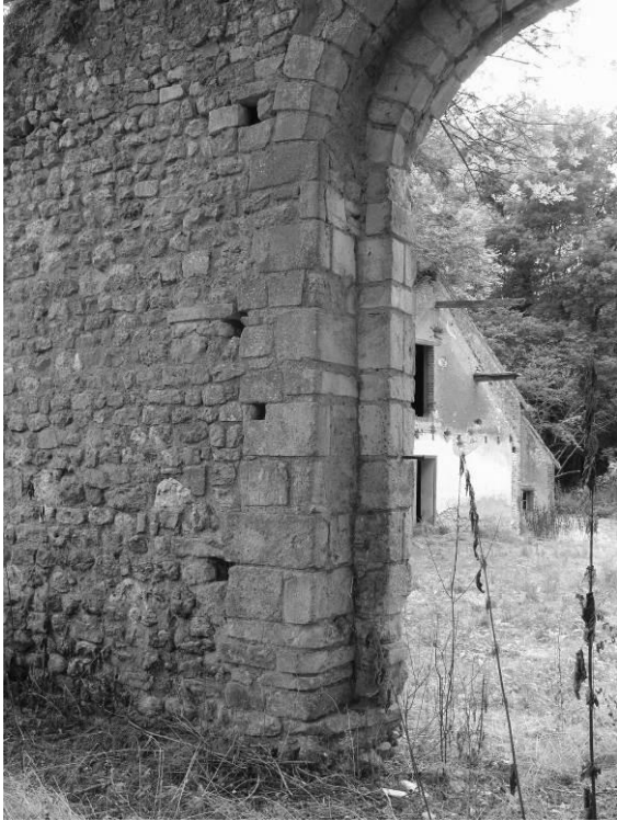
Fig. 10 : Le piédroit sud du portail, à l'intérieur de l'église.
