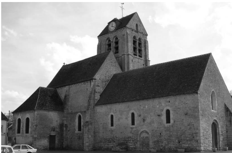
Fig. 16 : L'église vue depuis le nord-ouest.
