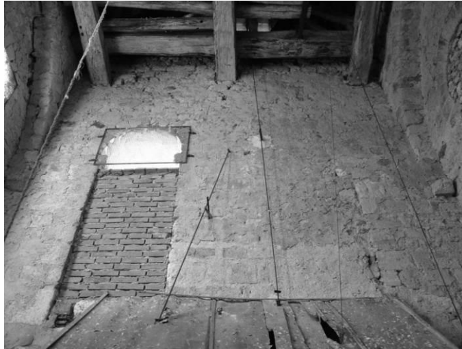
Fig. 47 : Les fenêtres du mur ouest du clocher.
