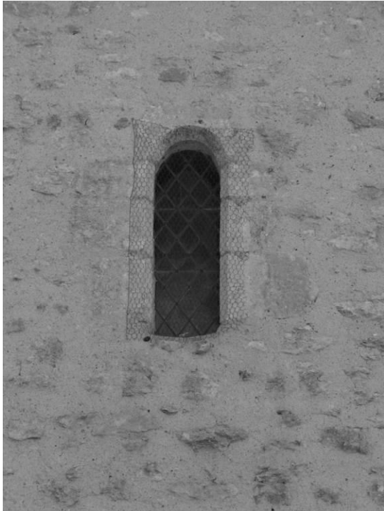
Fig. 10 : La fenêtre du mur gouttereau nord de la nef.
