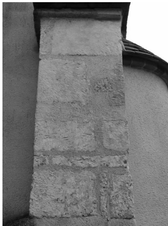
Fig. 9 : Détail du contrefort sud-ouest de la nef.
