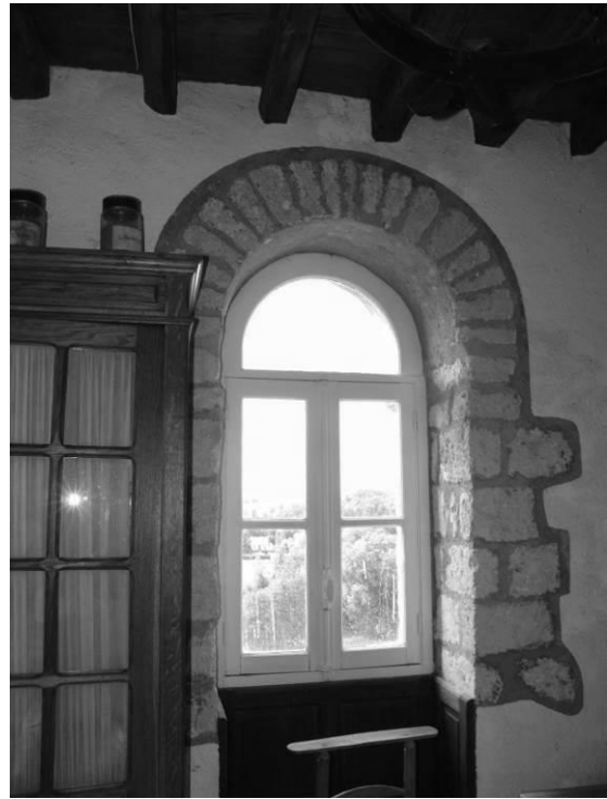
Fig. 27 : Premier étage du clocher, au-dessus de l'abside : baie sud.
