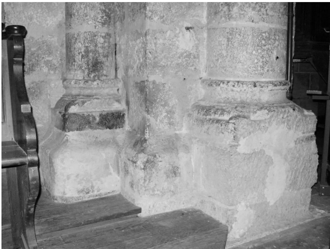
Fig. 18 : Les bases du support sud-est du clocher.
