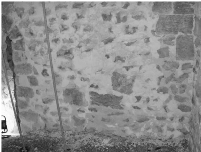
Fig. 62 : Premier étage du clocher : mur ouest.
