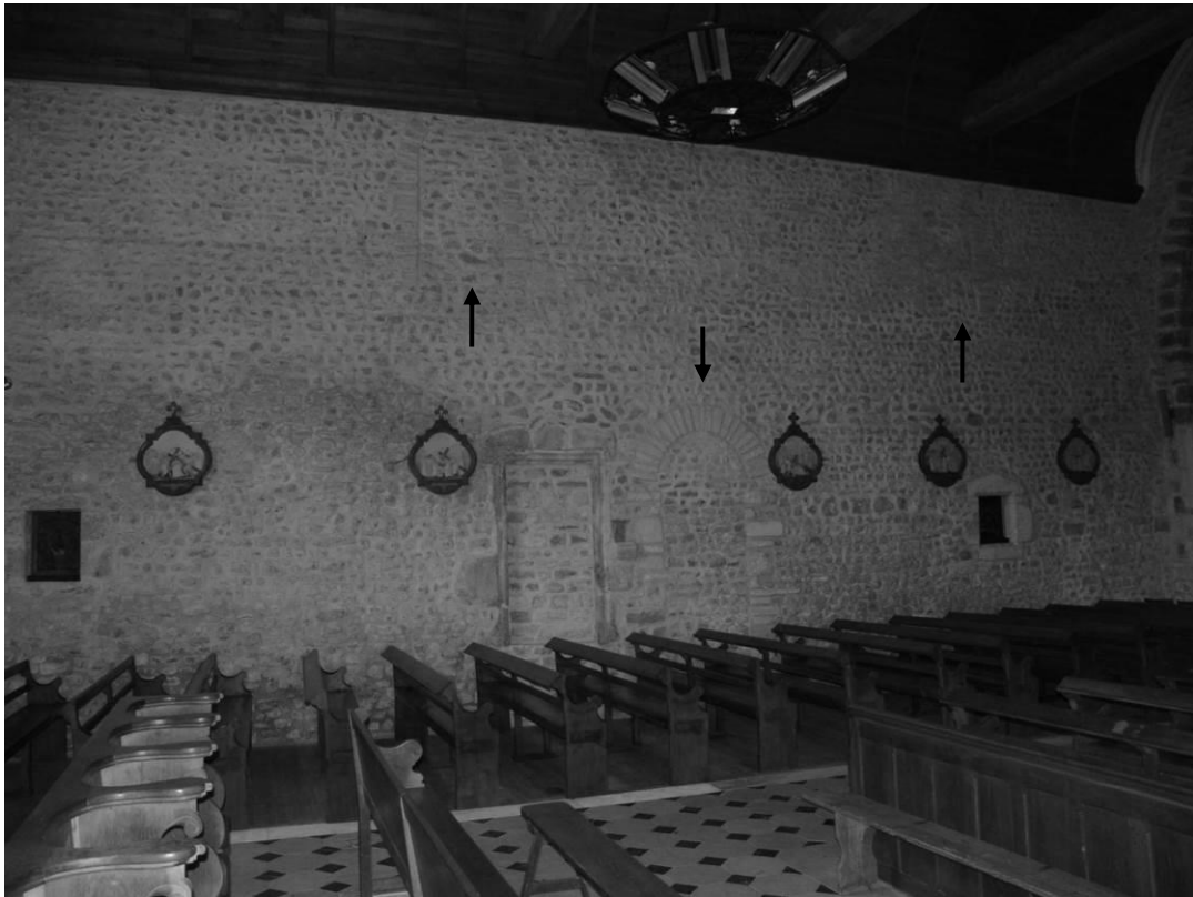
Fig. 14 : Le mur gouttereau nord de la nef. Les flèches indiquent la position des fenêtres et du portail.
