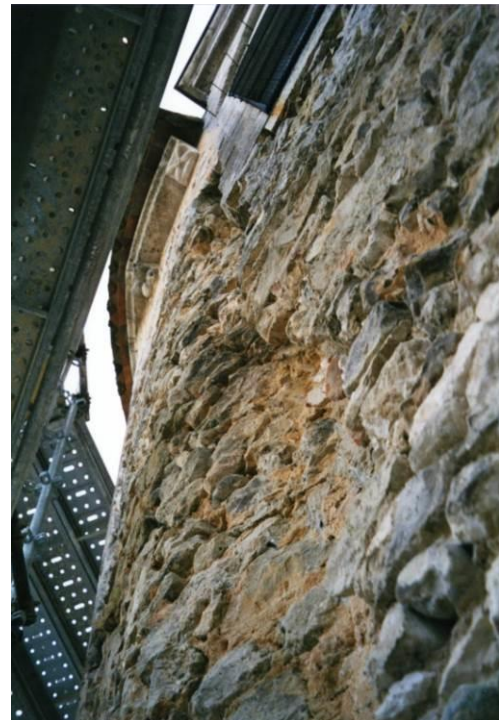
Fig. 21 : Traces de reprises dans le mur nord de l'abside.
