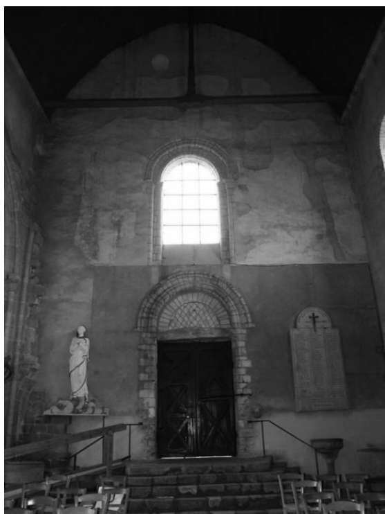
Fig. 61 : Le revers du mur pignon ouest de la nef centrale.
