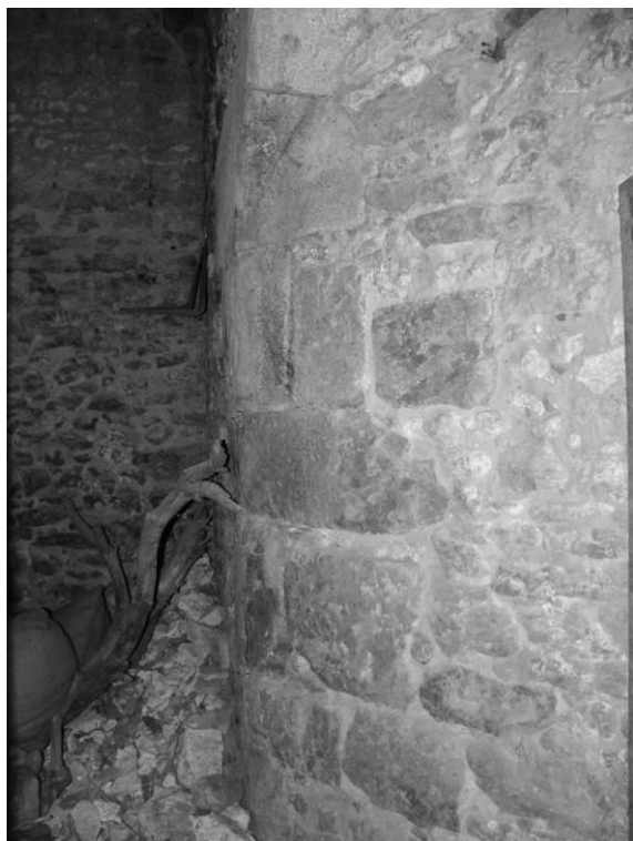
Fig. 43 : Le mur est du clocher, à droite, en entrant par la porte.
