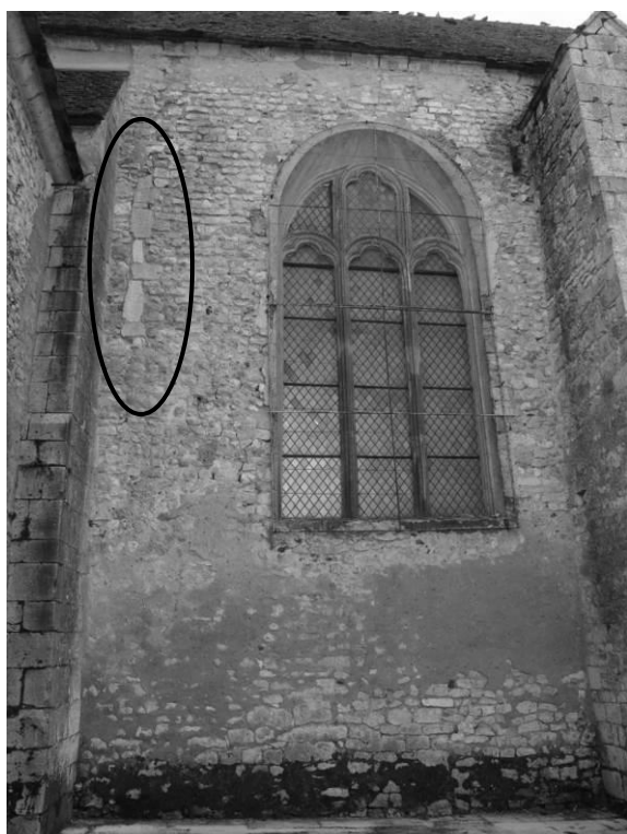
Fig. 40 : Travée orientale du mur gouttereau nord de la nef.
