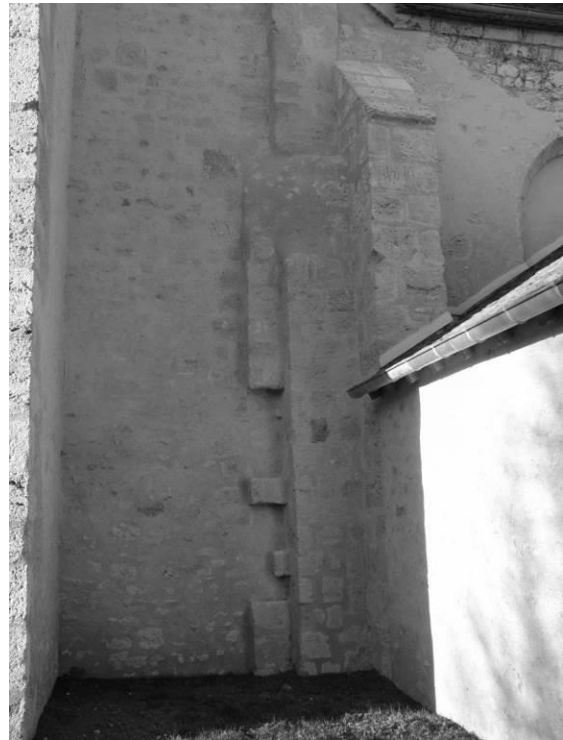
Fig. 27 : Le mur sud de l'église : la jonction entre le clocher et la deuxième travée depuis l'est.
