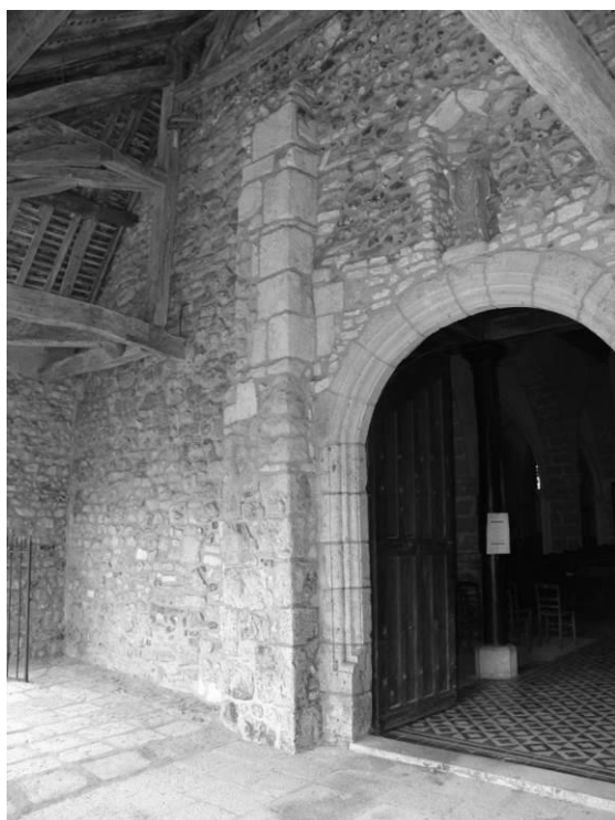
Fig. 7 : Vue sous le porche, vers le nord.
