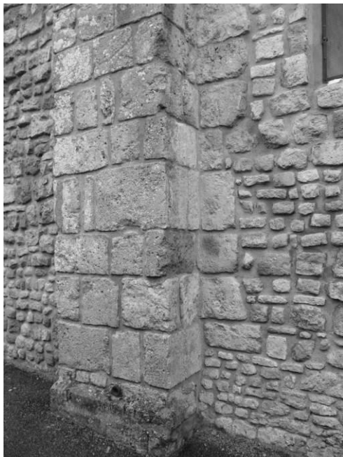
Fig. 16 : Contrefort entre la travée droite de l'abside et le clocher.
