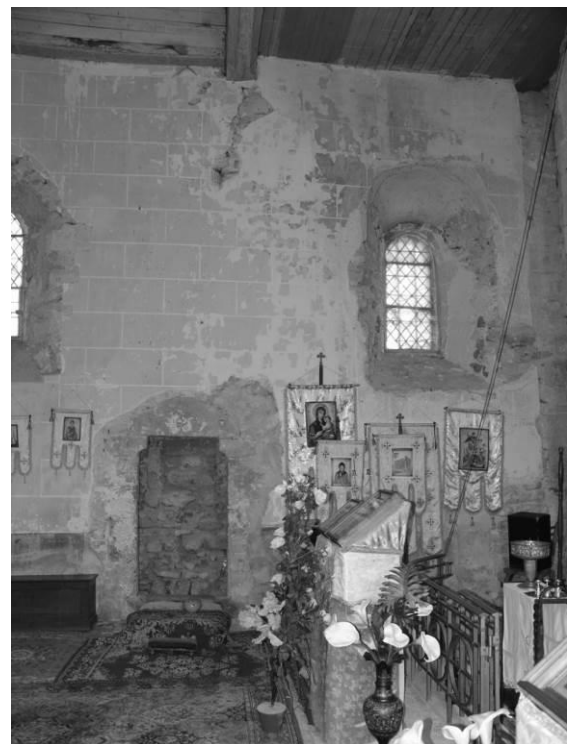
Fig. 46 : La partie orientale du mur gouttereau nord de la nef.
