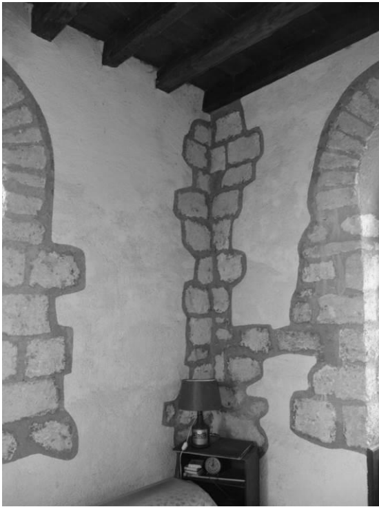
Fig. 26 : Premier étage du clocher, au-dessus de l'abside : angle sud-est.
