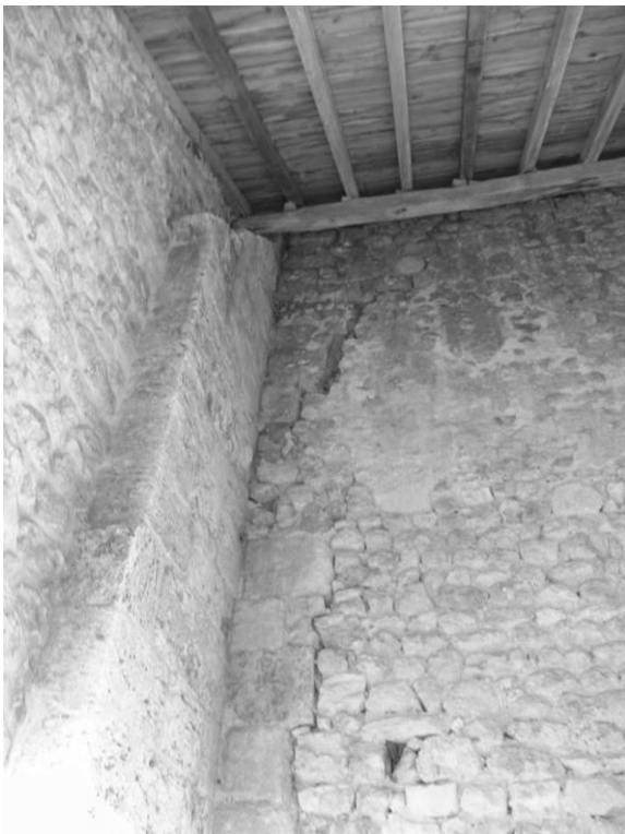
Fig. 18 : Liaison entre la façade ouest et son contrefort nord-ouest.
