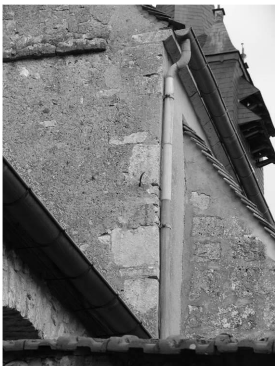
Fig. 12 : L'angle sud-ouest de la nef.
