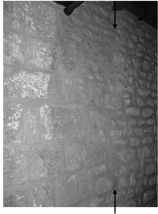
Fig. 40 : Le mur ouest de la nef, dans la partie nord. Les flèches indiquent une reprise dans le mur.
