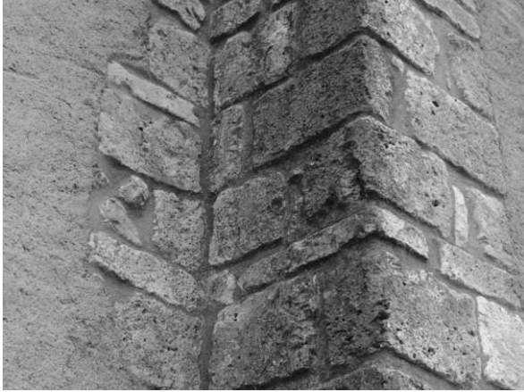
Fig. 13 : Détail de l'appareil des contreforts sud de la nef.
