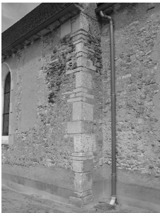
Fig. 11-12 : Le chaînage d'angle entre la nef et le chevet, au sud.
