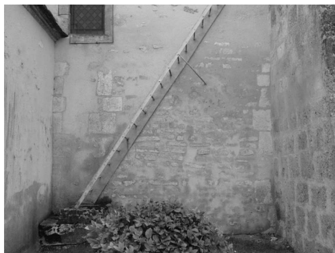
Fig. 12 : La travée occidentale du chevet, côté nord.
