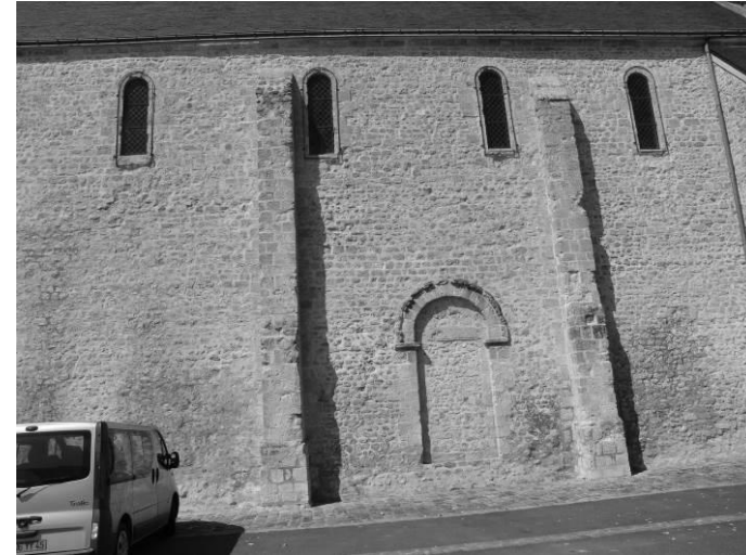
Fig. 16 : La partie orientale du mur gouttereau sud.
