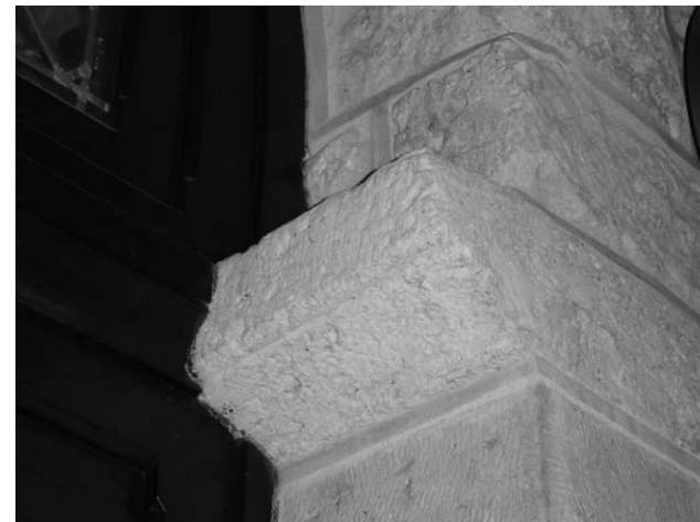
Fig. 76 : Mur gouttereau nord, sixième pilier depuis l'est, imposte ouest.
