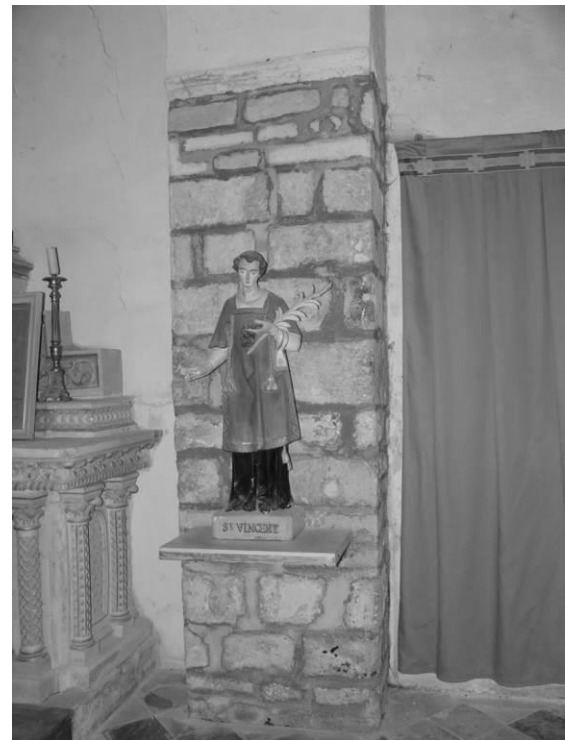
Fig. 35 : Le pilier nord-est du chœur (relevé fig. 8).
