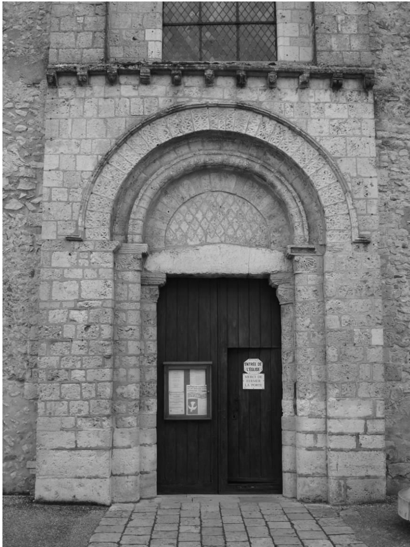
Fig. 44 : Portail ouest, face extérieure.
