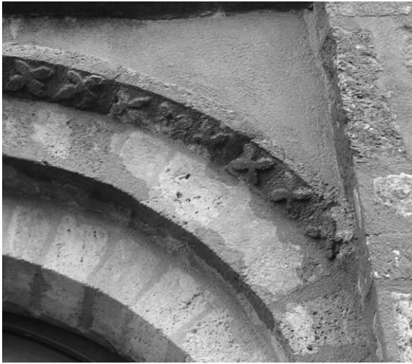
Fig. 10 : Détail des vousses du portail.
