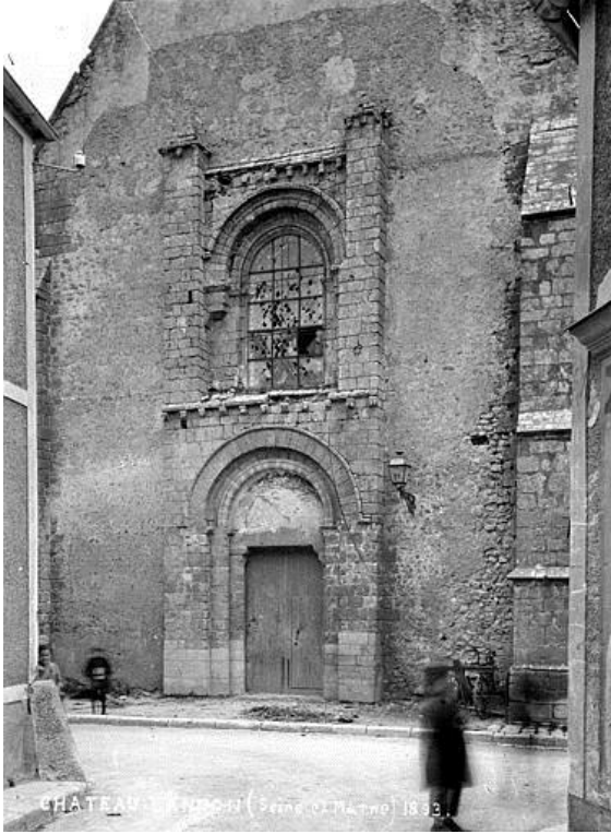
Fig. 16 : Façade occidentale de l'église au cours du XIX e siècle.
