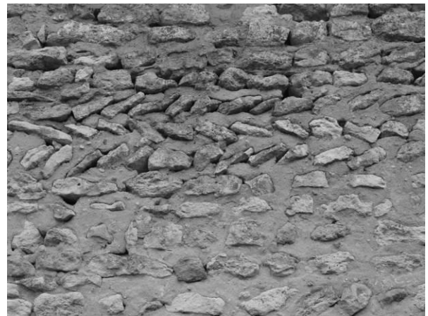
Fig. 36 : Détail du parement en opus spicatum du mur nord de la nef.
