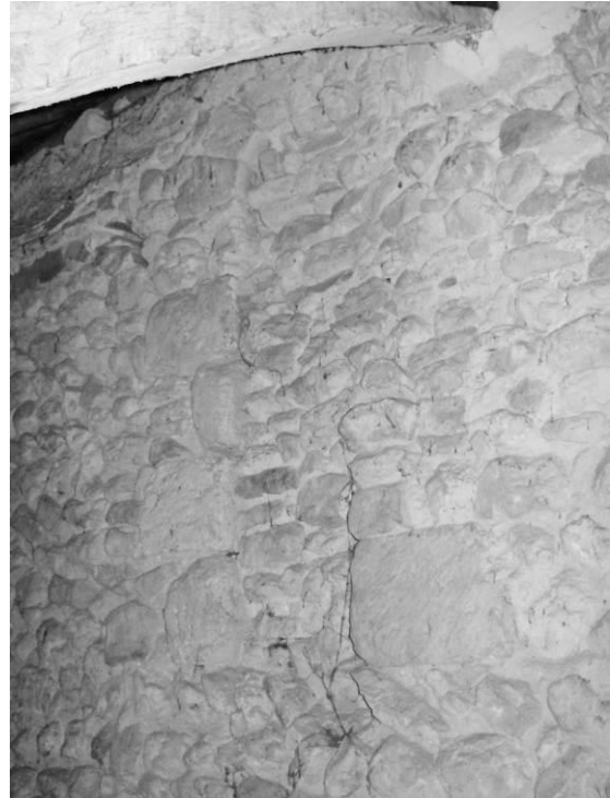
Fig. 53 : Mur gouttereau nord : première baie ouest.
