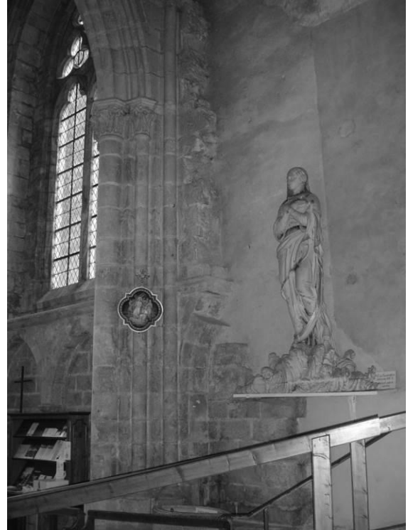
Fig. 67 : Angle sud-ouest du vaisseau central de la nef.
