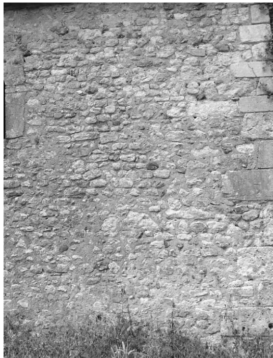
Fig. 16 : Le mur sud de l'abside.
