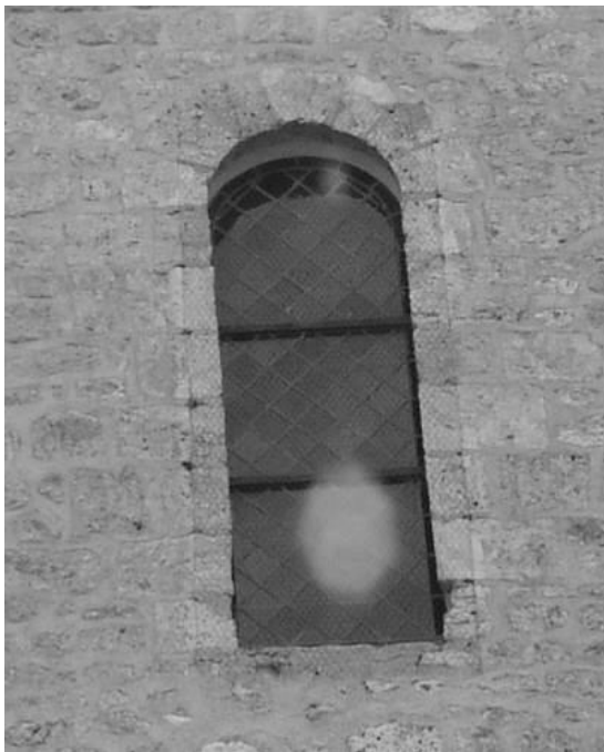
Fig. 20 : Fenêtre du mur gouttereau nord de la nef.
