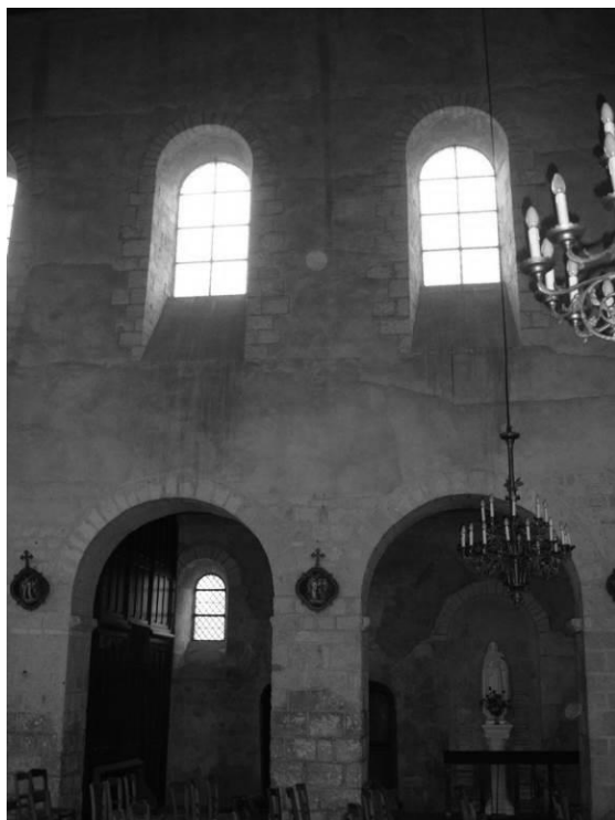
Fig. 68 : Détail des deux arcades centrales du mur gouttereau nord.
