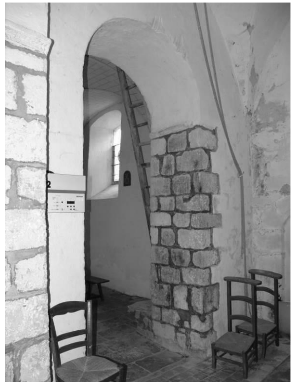
Fig. 31 : L'arc situé entre le collatéral nord et le clocher.
