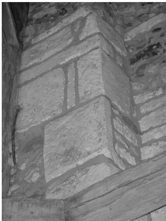
Fig. 10 : Détail de la partie supérieure du contrefort sud.
