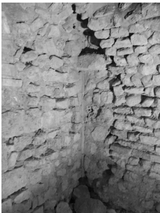
Fig. 86 : L'angle sud-est de la salle occidentale.
