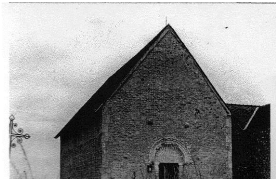
Fig. 27 : Vue de l'église depuis le nord-ouest, en août 1969. Cortrat : dossier travaux (Orléans – Service départemental de l'architecture et du patrimoine – Dossier de la commune de Cortrat) [photographie n° P4F4].
