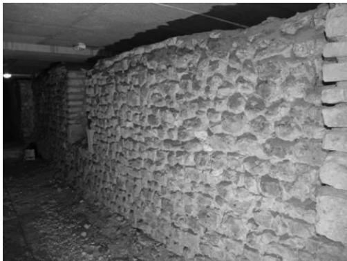
Fig. 71 : Couloir sud, partie occidentale du mur sud.
