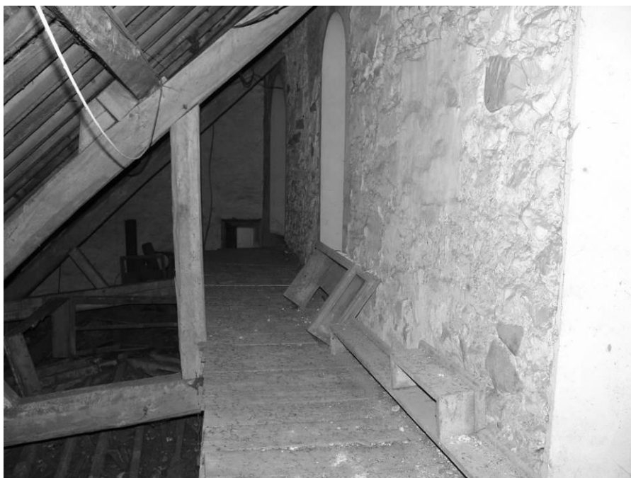
Fig. 38 : Le mur gouttereau sud de la nef, dans les combles.
