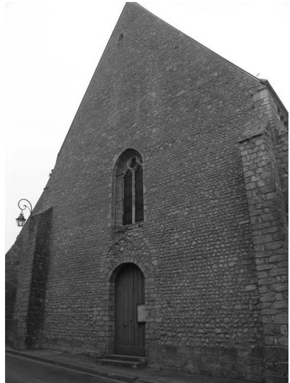
Fig. 14 : La façade ouest.
