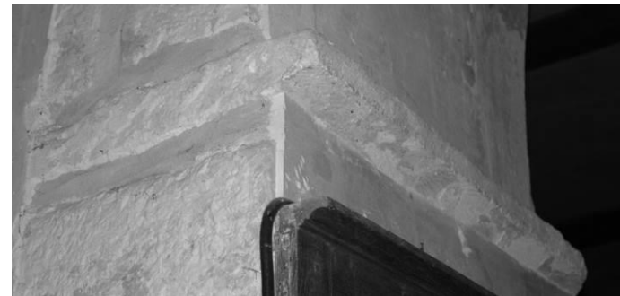
Fig. 34 : Imposte du pilier engagé à l'ouest du mur gouttereau sud.
