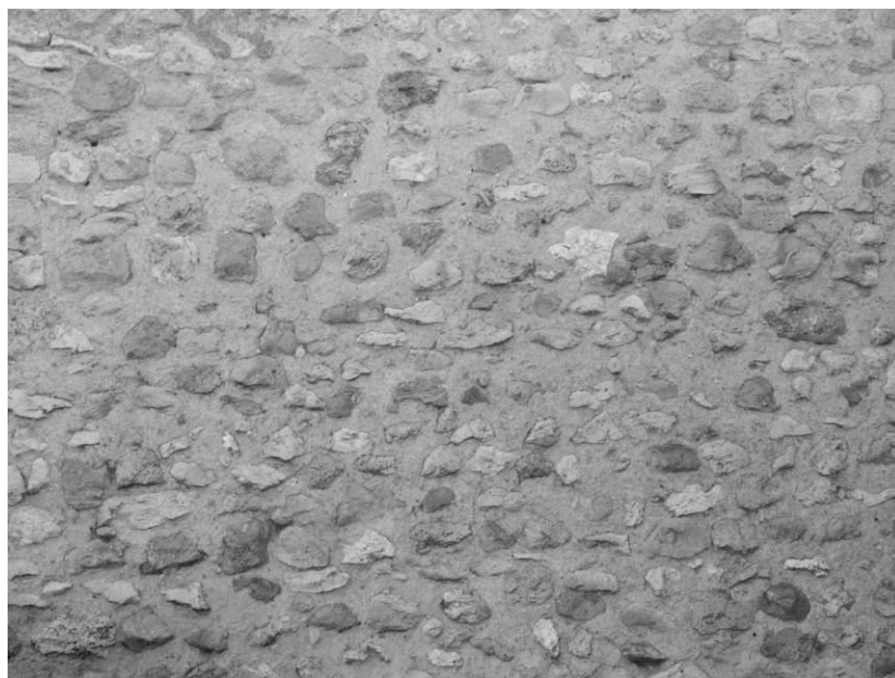
Fig. 13 : Détail du mur gouttereau nord de la nef.
