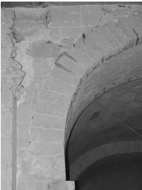
Fig. 62 : La retombée nord de l'arc triomphal du chœur.
