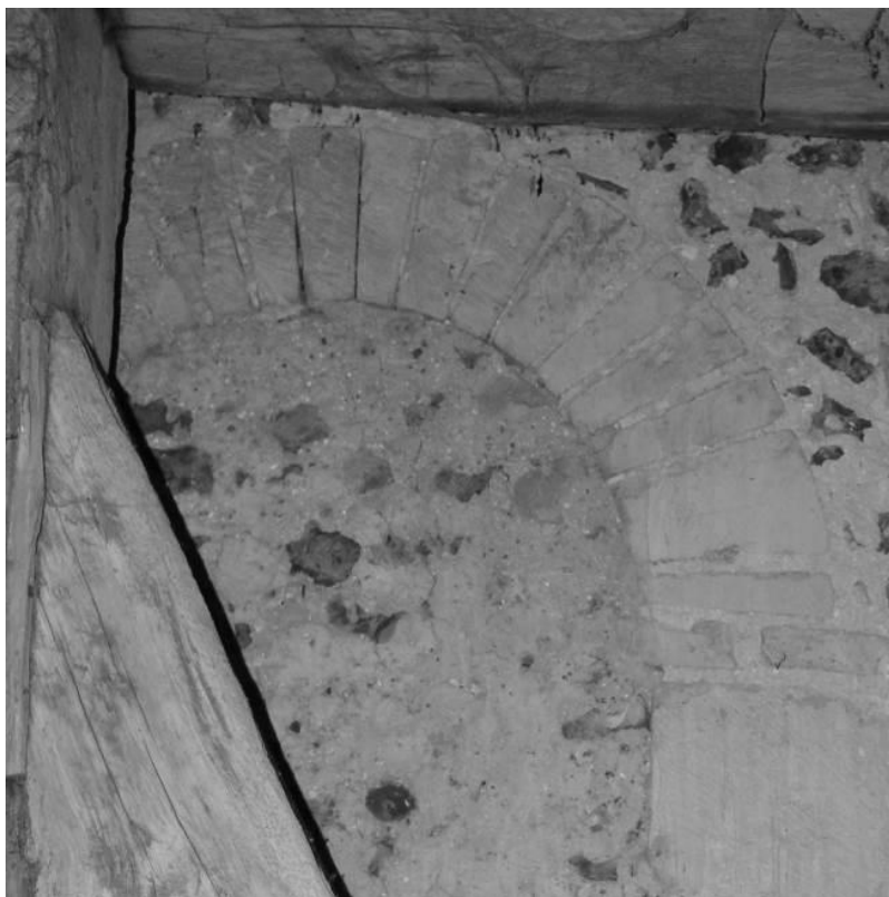
Fig. 34 : Les claveaux d'une baie triple du premier niveau.
