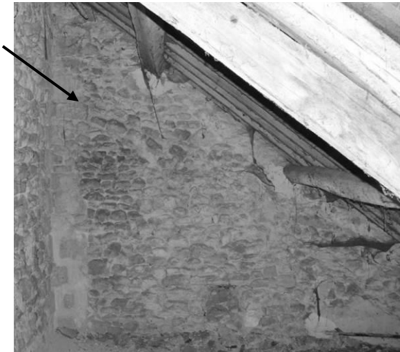
Fig. 58 : Mur pignon occidental du collatéral nord, dans les combles, avec une ancienne trace d'accroche de toiture (flèche).
