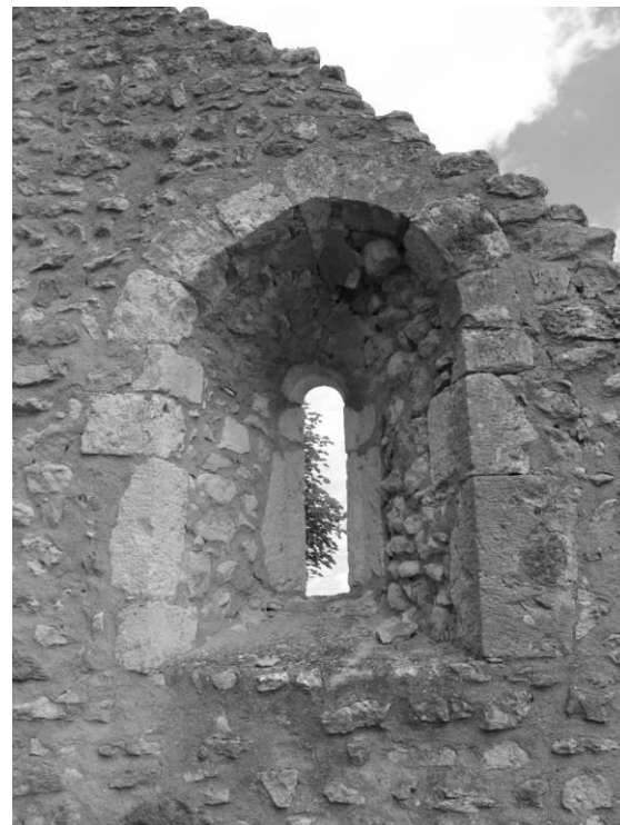
Fig. 56 : La baie du mur sud du chevet, face intérieure.
