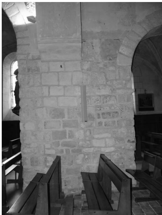
Fig. 23 : Le deuxième pilier du mur gouttereau sud de la nef.
