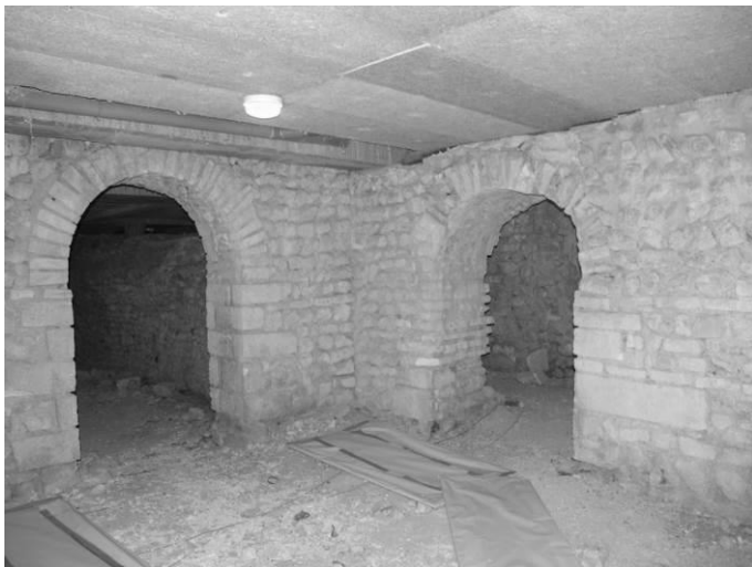
Fig. 52 : Les murs nord et ouest de la salle orientale.
