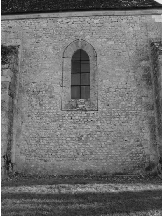
Fig. 20 : Le mur nord de l'église : travée occidentale.
