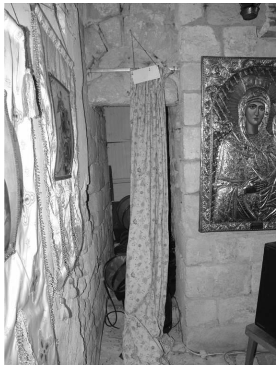
Fig. 54 : La porte aménagée dans le mur pignon oriental de la nef, au sud.
