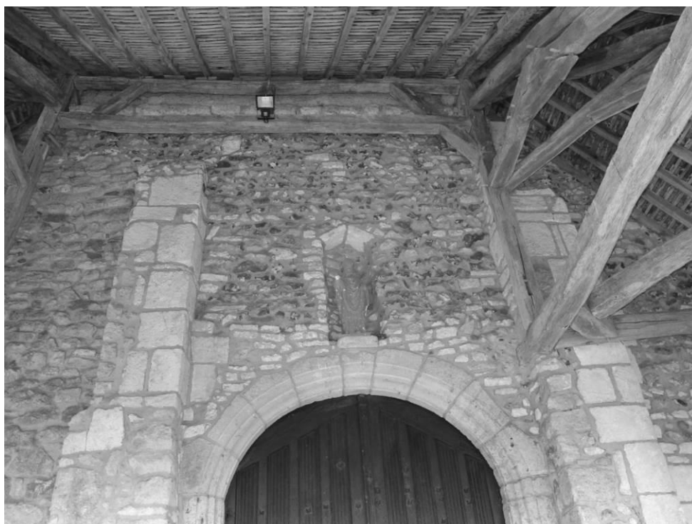
Fig. 9 : Le sommet du portail ouest.
