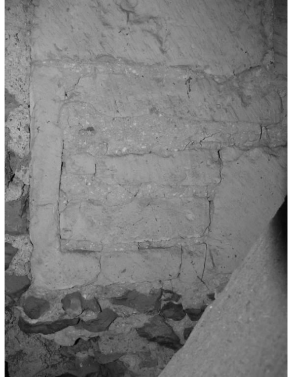
Fig. 31 : Détail du piédroit d'une des baies triple, face nord, premier niveau.
