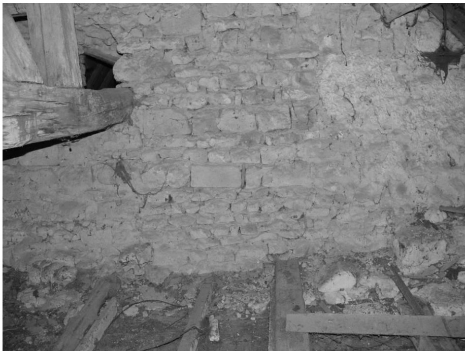
Fig. 59 : Le mur pignon oriental de la nef, dans les combles.
