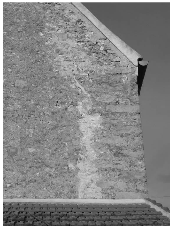
Fig. 18 : Angle sud-est de l'édifice.
