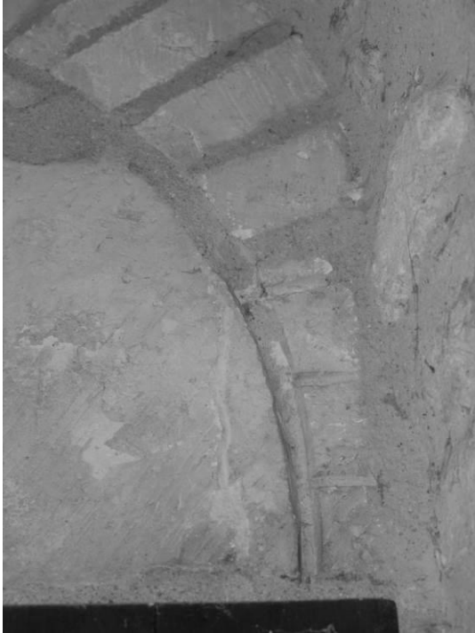
Fig. 80 : Le revers du linteau du portail, avec les premiers claveaux de l'arc gravés.
