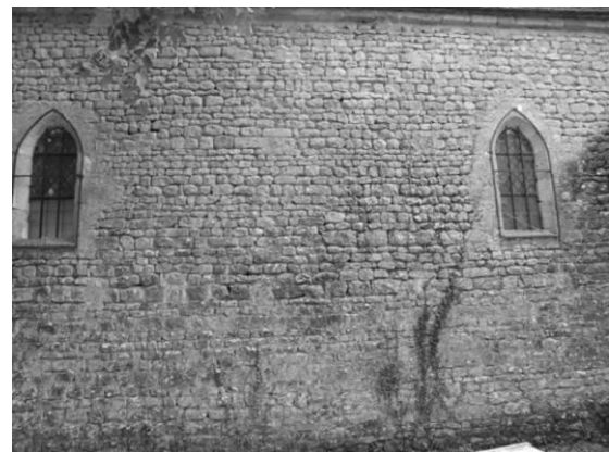
Fig. 38 : Le mur gouttereau nord de la nef.
