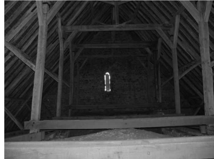
Fig. 49 : Les combles au-dessus de la nef.
