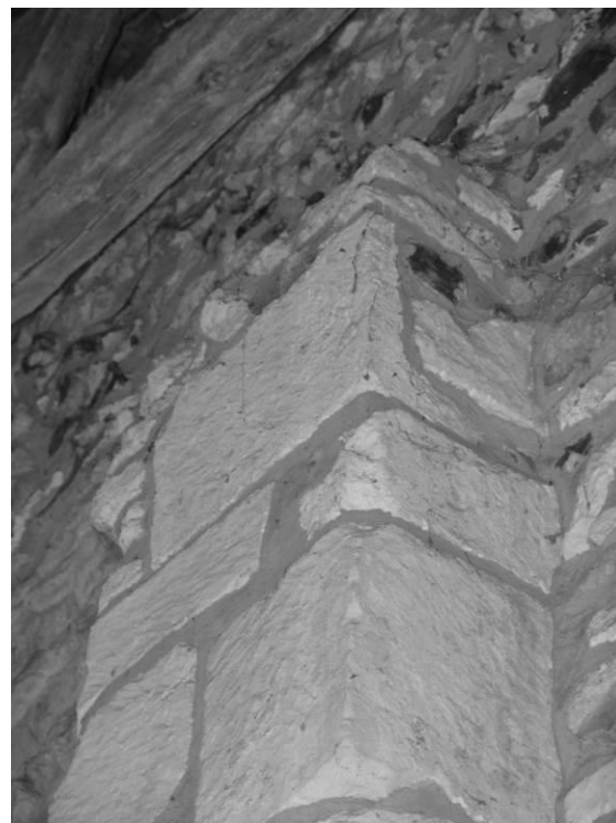
Fig. 11 : Détail de la partie supérieure du contrefort nord.
