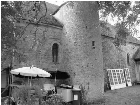
Fig. 35 : Le mur gouttereau nord de la nef.
