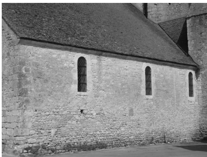
Fig. 18 : Le mur sud de la nef.
