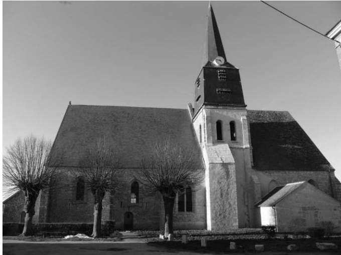
Fig. 8 : La façade sud de l'église.
