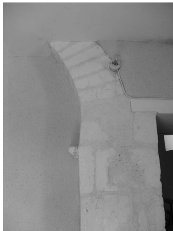
Fig. 18 : La retombée nord de l'arc triomphal.
