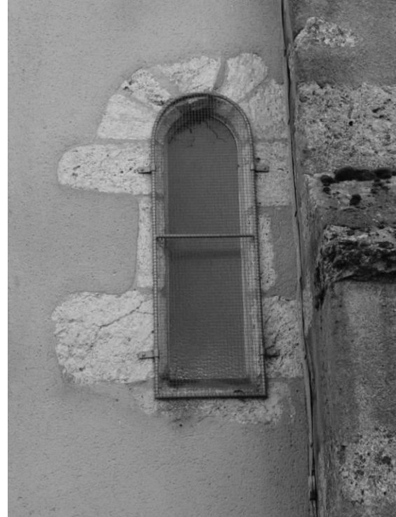
Fig. 10 : Détail d'une des baies du mur nord du chevet.
