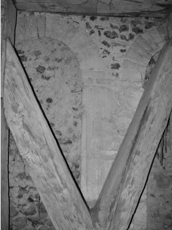
Fig. 30 : Détail du premier niveau des baies triples, face sud.
