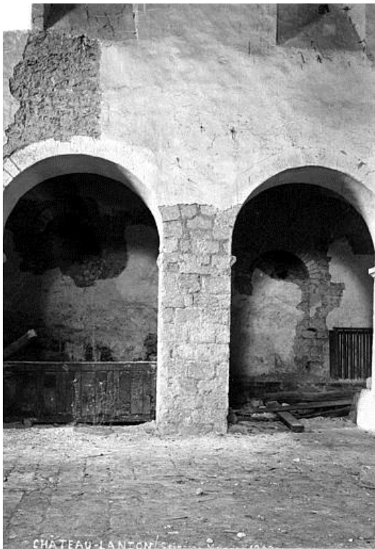
Fig. 21 : Le mur gouttereau nord de la nef au cours des travaux du XIX e siècle. Robert P., Bas-côté , photographie, s. d., Médiathèque de l'architecture et du patrimoine.
