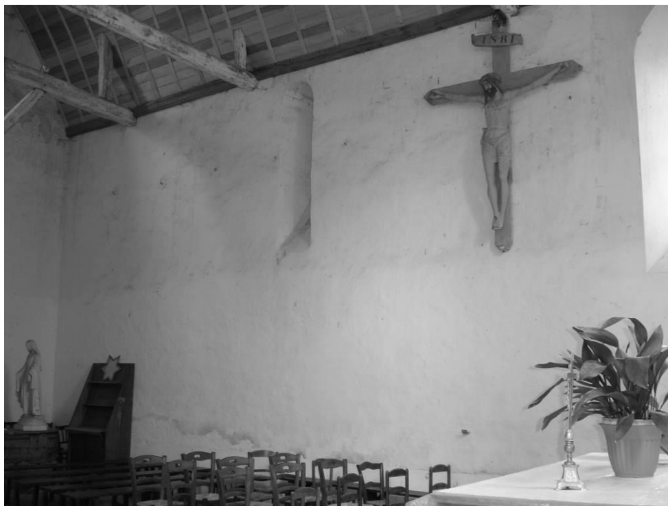
Fig. 32 : Le mur gouttereau nord, à l'intérieur, avec la baie bouchée repérée à l'extérieur (fig. 24).
