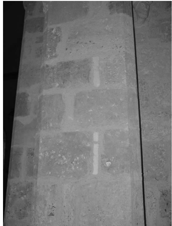
Fig. 15 : Détail de l'appareil de l'un des piliers du chevet.
