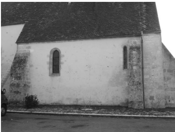
Fig. 10 : Le mur gouttereau nord de la nef.
