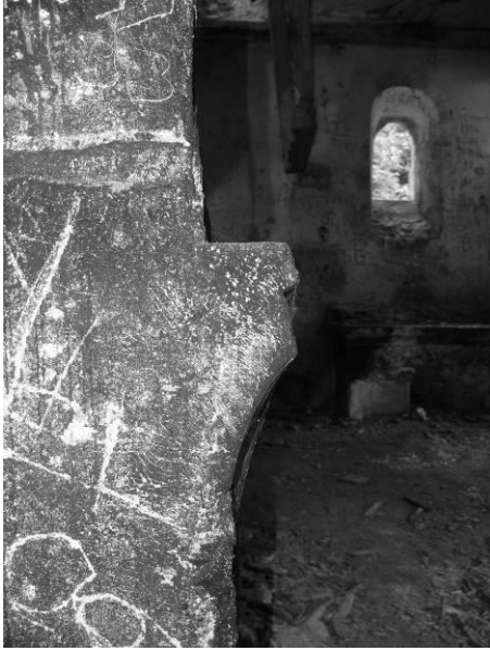
Fig. 26 : Profil de l'imposte nord de l'arc triomphal.
