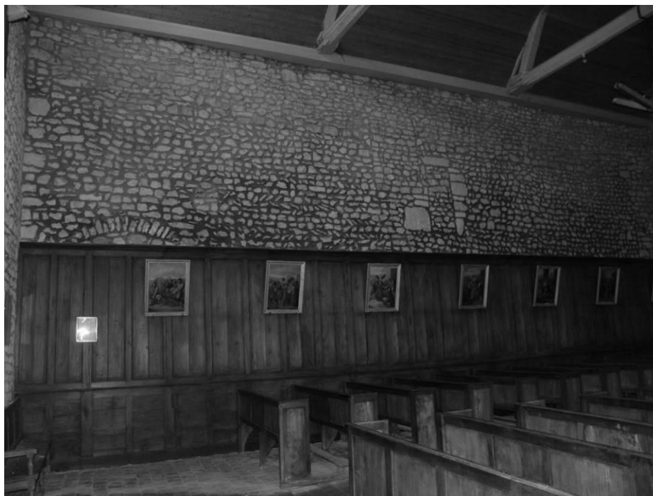
Fig. 9 : Le mur nord de la nef.
