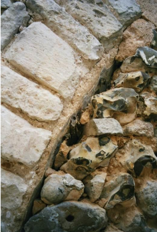
Fig. 18 : Vestiges de l'arc en plein cintre avec enduit.
