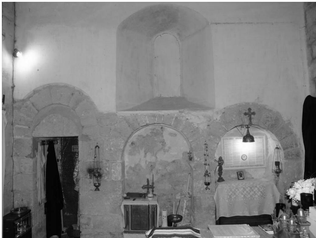
Fig. 64 : Le mur nord de la travée droite du chœur.
