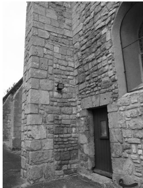
Fig. 17 : Le contrefort sud-ouest du clocher, côté est.
