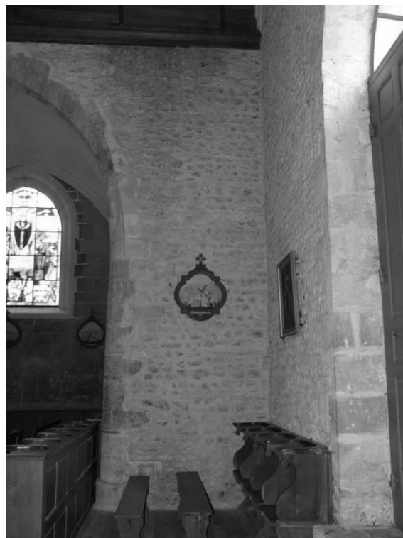
Fig. 21 : L'angle sud-ouest de la nef.
