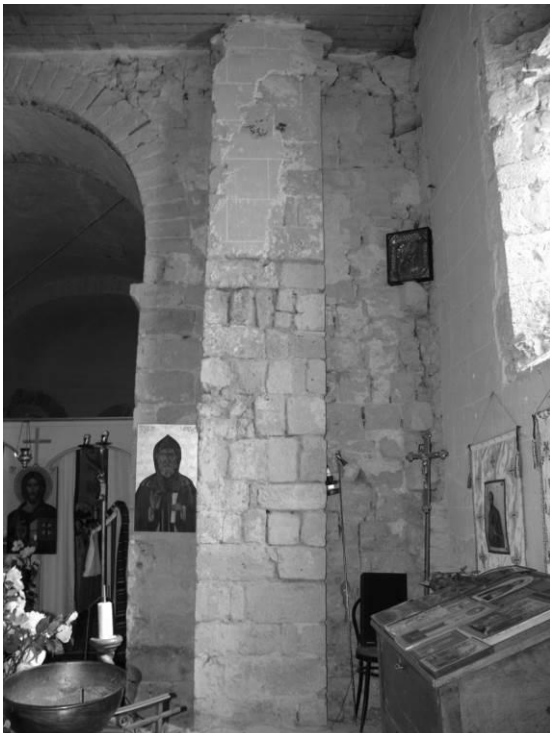
Fig. 56 : Le mur pignon oriental de la nef, côté sud.
