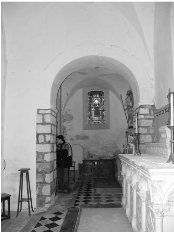
Fig. 34 : L'arcade séparant la partie centrale du chevet et le clocher.
