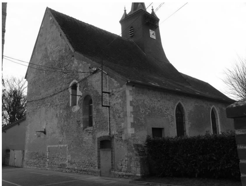
Fig. 6 : L'église vue depuis le nord-est.
