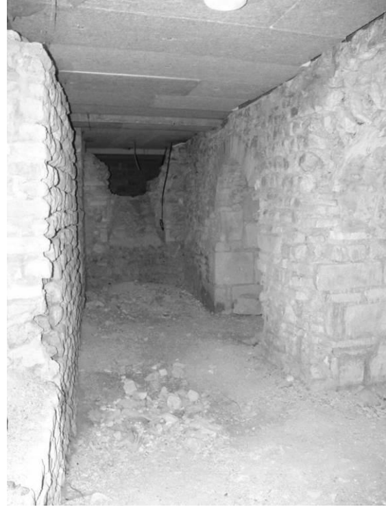
Fig. 63 : Le couloir nord, vu vers l'est.
