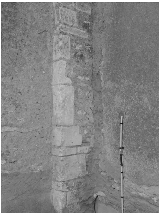
Fig. 13 : Le chaînage d'angle à la naissance de l'abside, côté nord.
