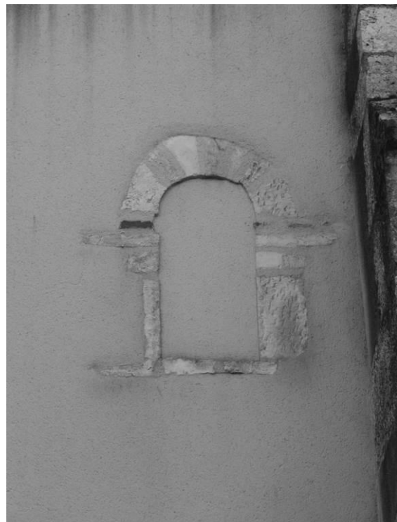
Fig. 12 : La petite baie bouchée dans la deuxième travée du mur gouttereau nord de la nef.
