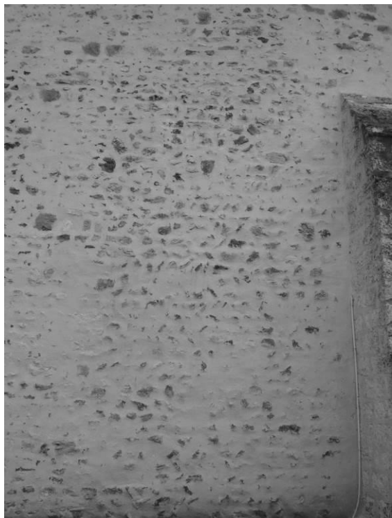
Fig. 13 : Vestiges d' opus spicatum dans le mur nord de la nef.
