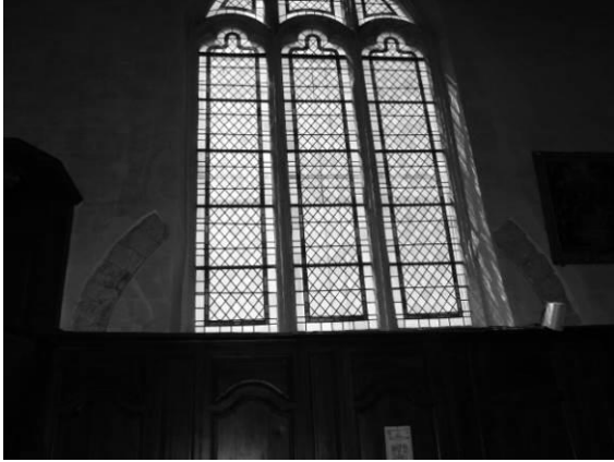
Fig. 46 : Ancienne arcade dans le mur gouttereau sud de la nef.
