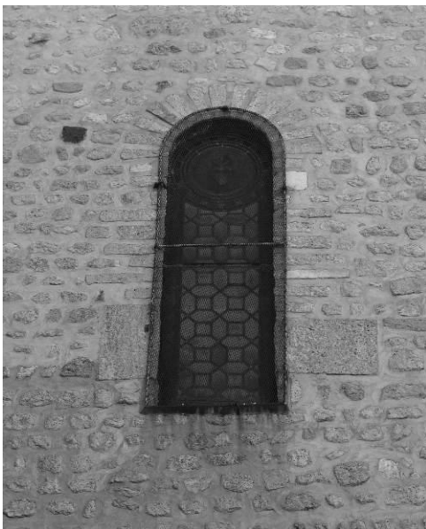
Fig. 18 : Fenêtre du mur nord de la nef.
