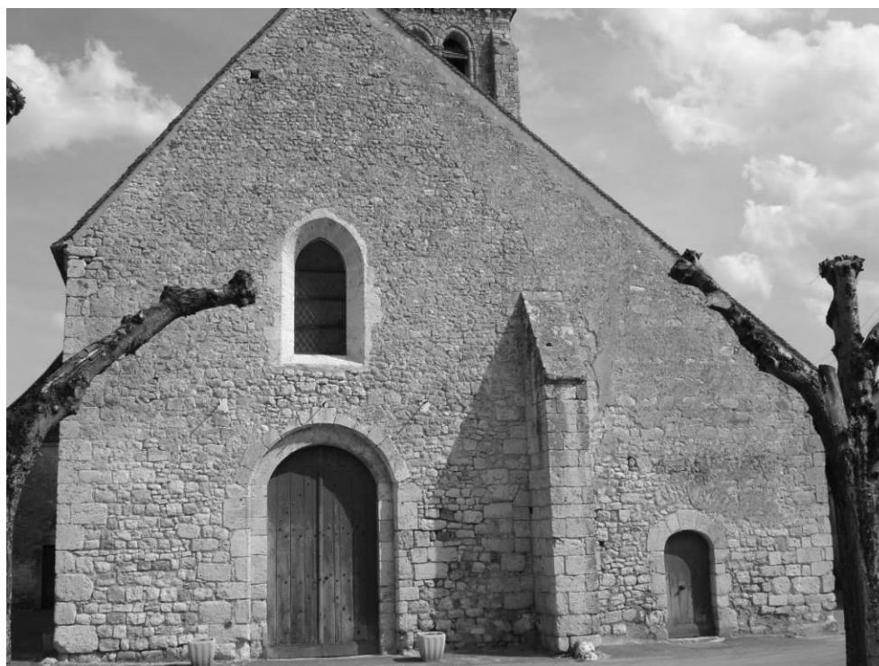
Fig. 21 : La façade ouest.
