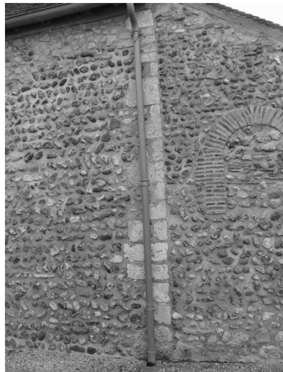
Fig. 8 : La jonction entre la nef et le porche, au nord.
