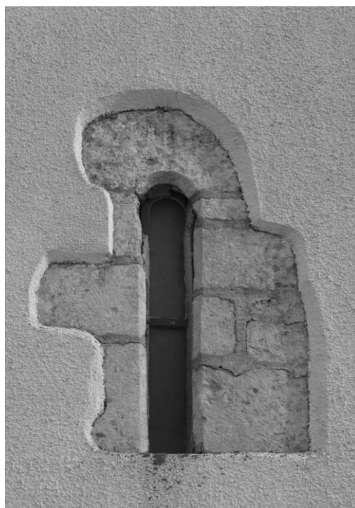
Fig. 10 : La fenêtre du pignon occidental.
