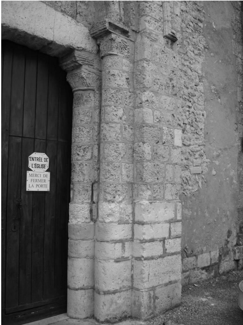
Fig. 49 : Piédroit sud du portail ouest.
