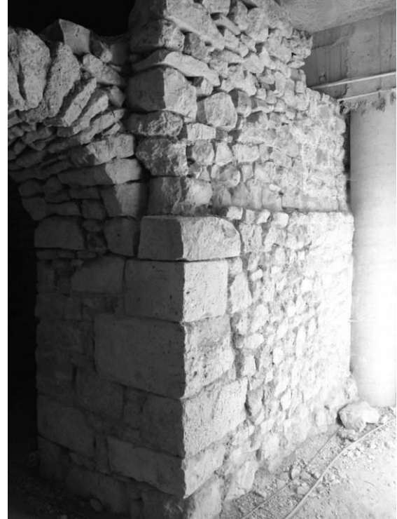
Fig. 95 : La face orientale de l'arcade est de la salle sud, côté nord.
