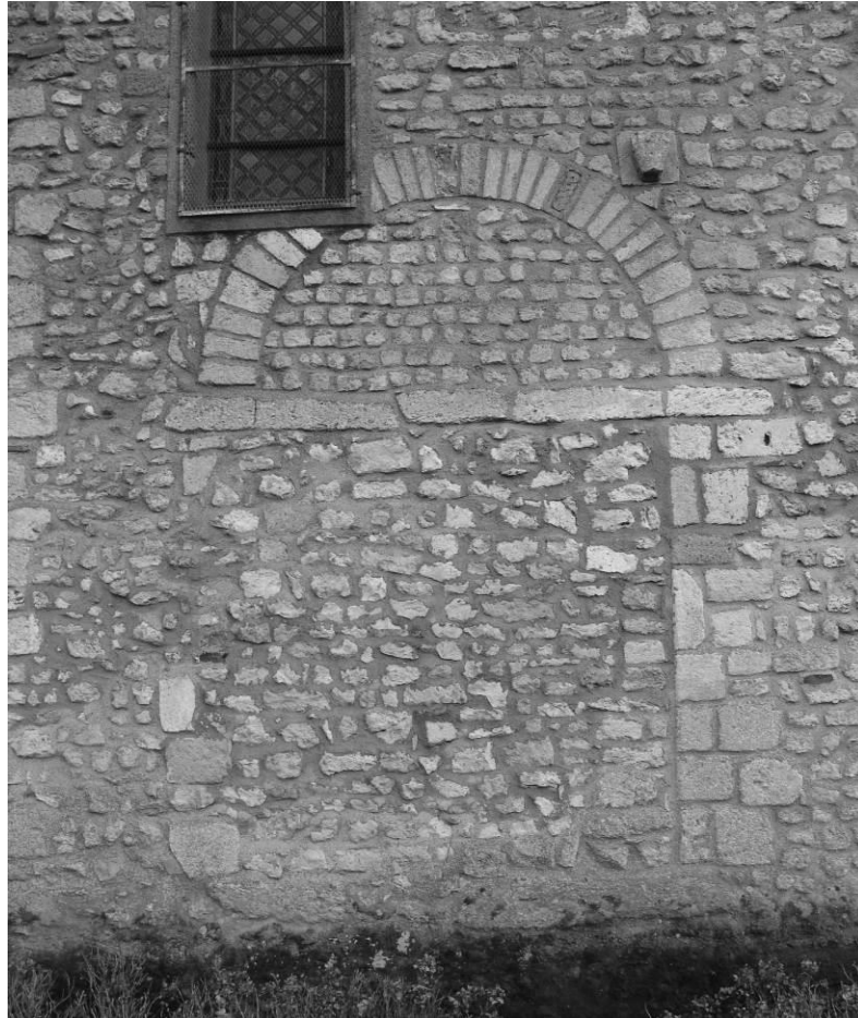
Fig. 8 : Le portail nord de la nef.
