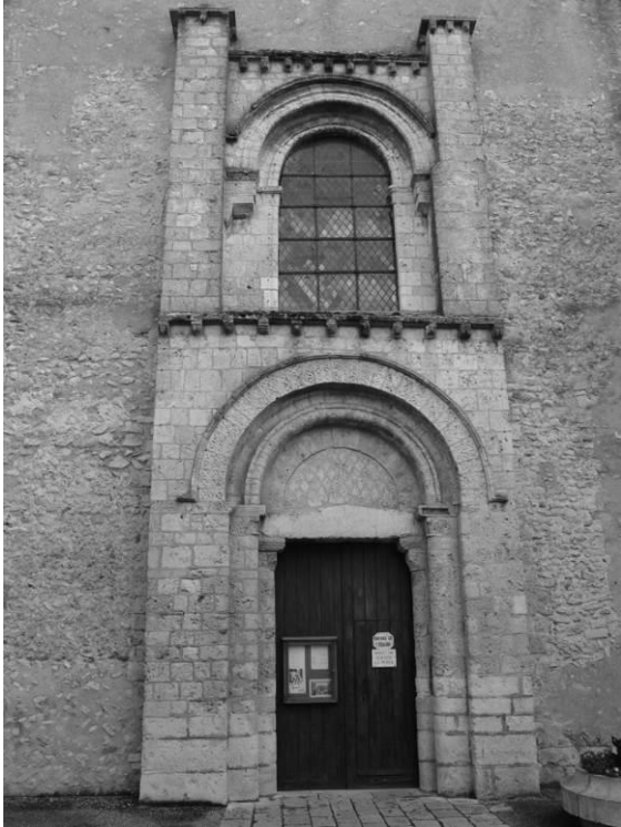
Fig. 34 : Le massif en saillie de la façade ouest.
