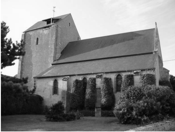
Fig. 6 : Vue de l'église depuis le nord-ouest.
