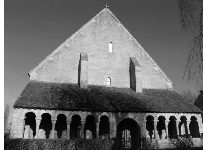
Fig. 9 : La façade ouest.
