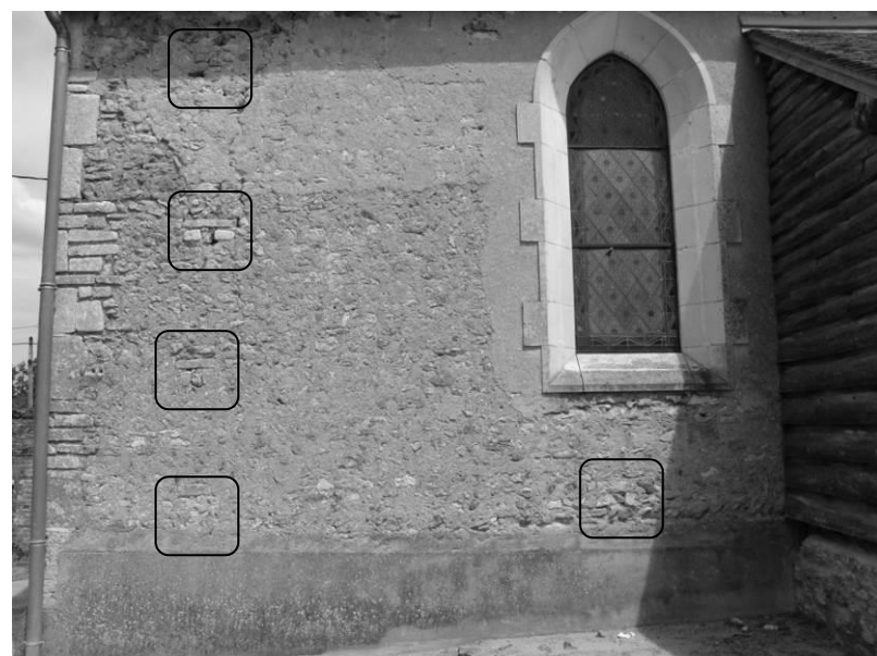
Fig. 17 : La partie occidentale du mur gouttereau sud de la nef. Cinq trous de boulins sont encadrés.
