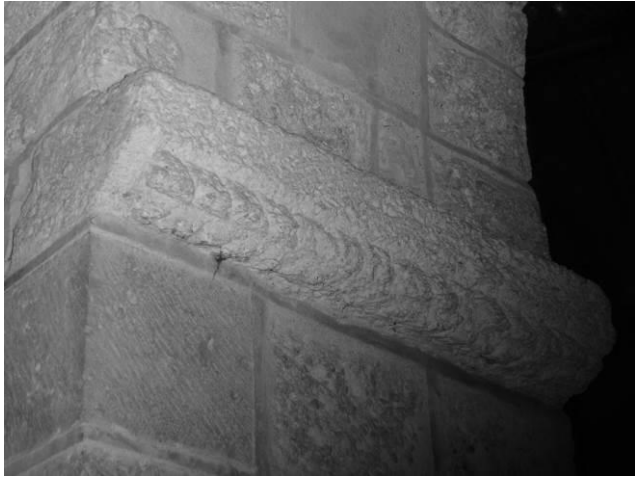
Fig. 73 : Mur gouttereau nord, deuxième pilier depuis l'est, imposte ouest.
