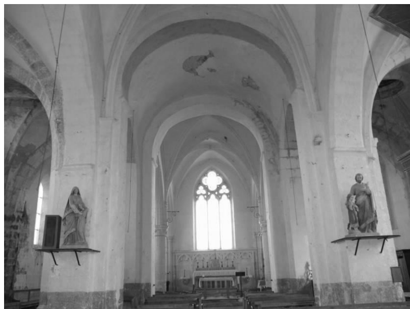
Fig. 38 : La travée voûtée en plein cintre, au cœur de l'édifice, vue depuis l'ouest.
