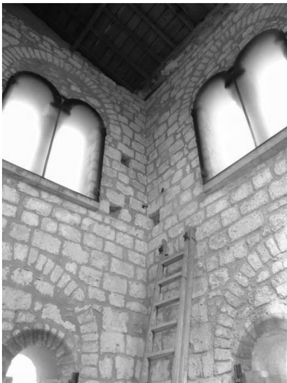
Fig. 32 : Les deux derniers niveaux du clocher : angle nord-ouest.
