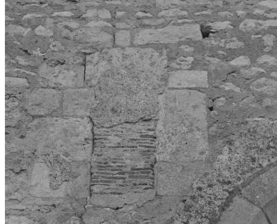
Fig. 10 : La fenêtre orientale du mur nord de la nef.
