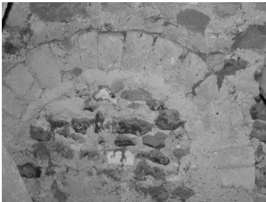
Fig. 35 : Les claveaux d'une baie triple du second niveau, face ouest.
