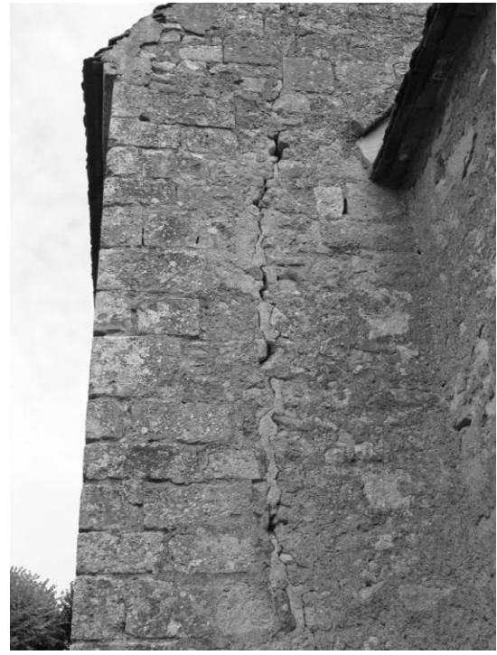
Fig. 25 : Le mur pignon oriental de la nef, côté sud.
