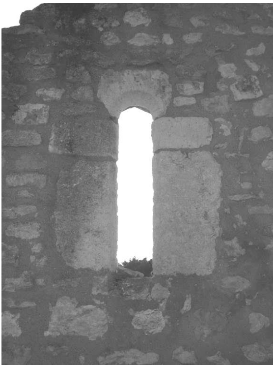
Fig. 55 : La baie du mur sud du chevet, face extérieure.
