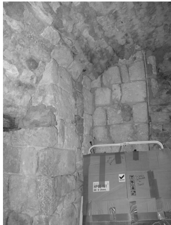
Fig. 42 : Cave située sous le bas-côté nord, mur occidental : vestiges d'un autre pilier placé dans l'alignement du précédent, témoins de l'ancienne nef à trois vaisseaux de l'église
