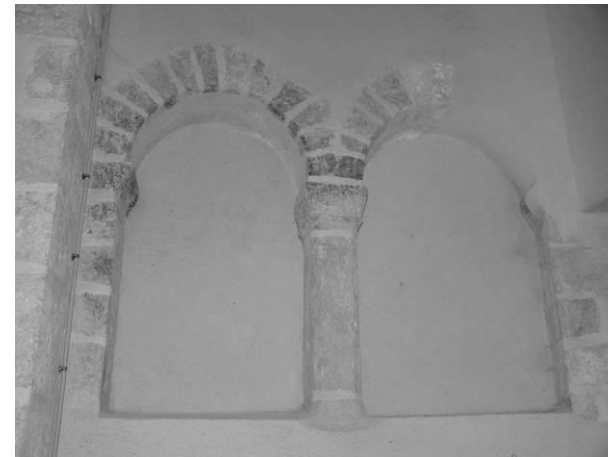
Fig. 35 : Les arcatures de l'absidiole.
