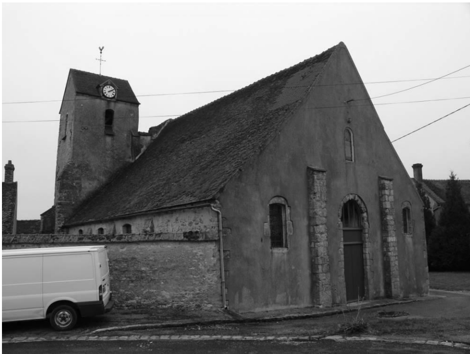
Fig. 13 : L'église vue depuis le nord-ouest.
