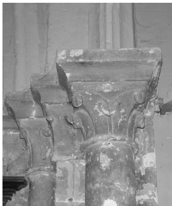
Fig. 19 : Chapiteaux à l'entrée du chœur.
