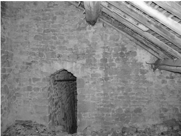
Fig. 68 : Combles au-dessus de la partie centrale du chœur : mur nord.
