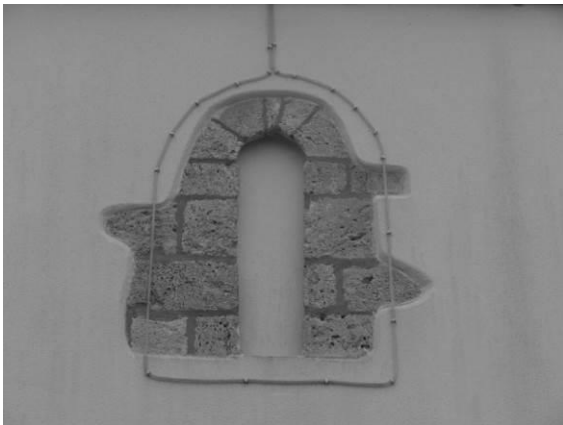
Fig. 10 : La baie est du mur sud de la nef.
