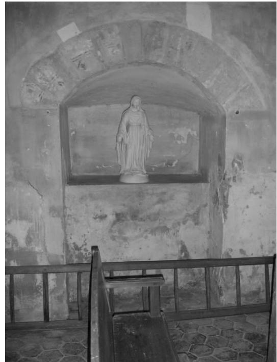
Fig. 16 : Vestiges d'une porte dans le mur nord de la nef.
