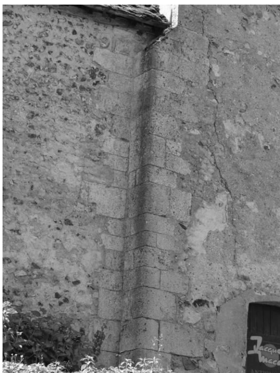
Fig. 10 : L'angle nord entre la nef et l'abside.
