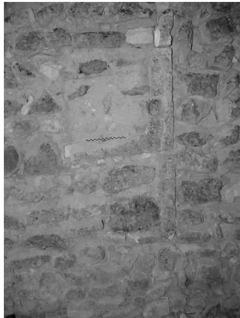
Fig. 74 : Chaînage en remplois de sarcophages dans le mur sud du couloir sud.
