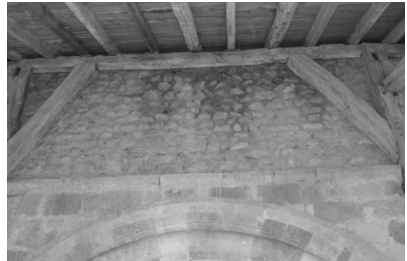
Fig. 17 : Le parement en moellons, au-dessus du portail ouest.
