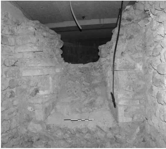
Fig. 66 : Couloir nord : baie dans le pignon oriental.
