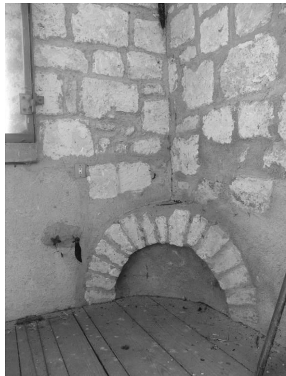
Fig. 33 : Les deux derniers niveaux du clocher : trompe d'angle.
