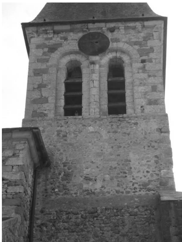
Fig. 15 : La face nord du clocher, partie supérieure.
