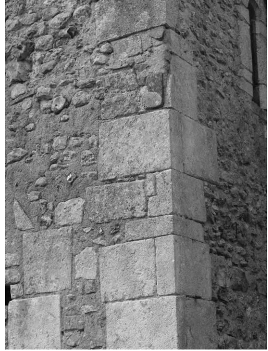
Fig. 14 : Le chaînage de l'angle sud-est de la nef.
