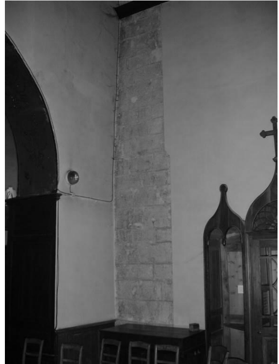
Fig. 47 : Contrefort dans le mur oriental du bras sud du transept.
