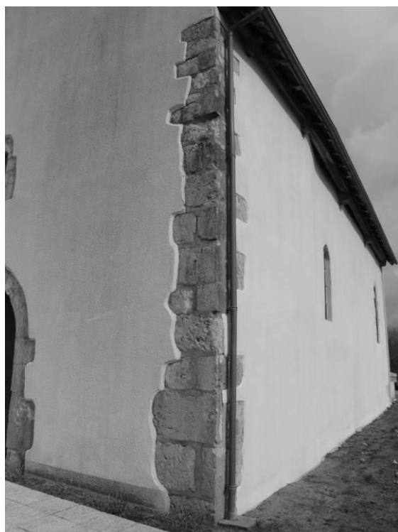
Fig. 11 : L'angle sud-ouest de la nef.
