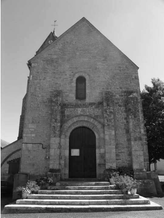
Fig. 12 : La façade ouest.
