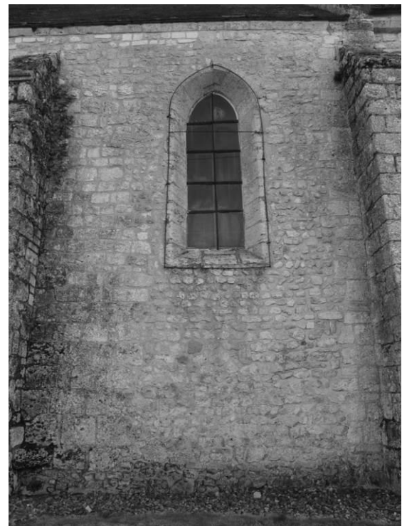
Fig. 23 : Le mur nord de l'église : quatrième travée depuis l'ouest.
