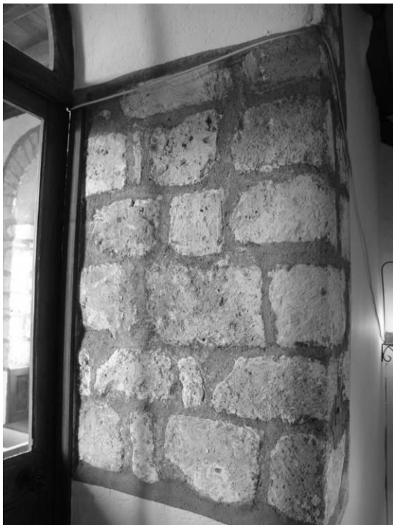
Fig. 28 : Premier étage du clocher, au-dessus de l'abside : piédroit ouest de la baie nord.
