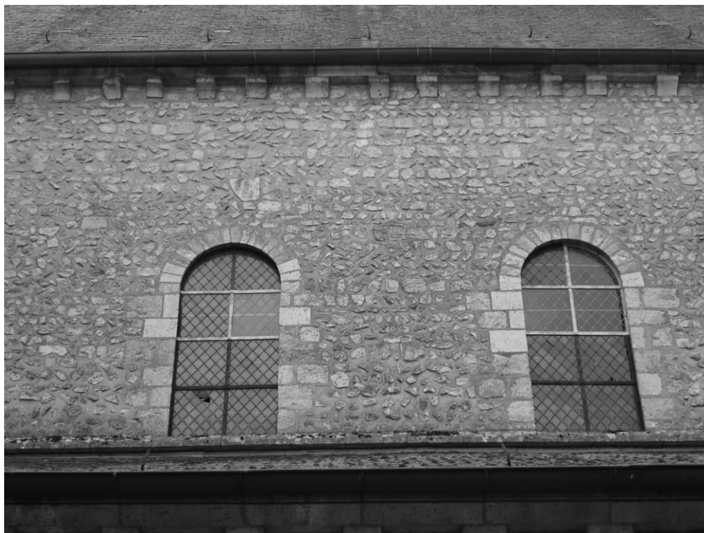
Fig. 31 : Mur gouttereau nord de la nef.
