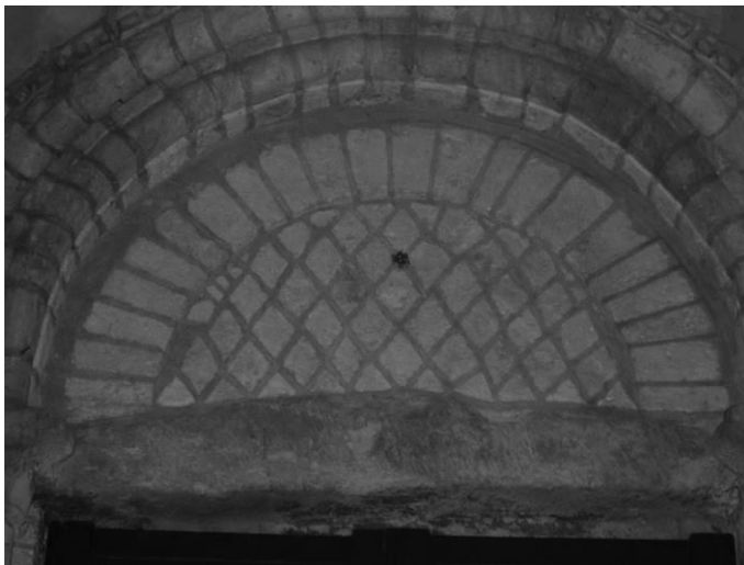
Fig. 54 : Tympan intérieur du portail ouest.
