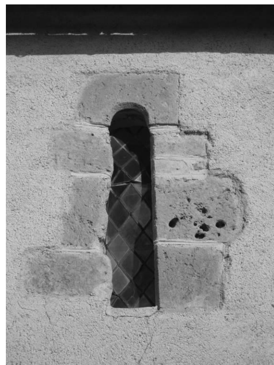
Fig. 9 : Une des baies du mur gouttereau sud de la nef.
