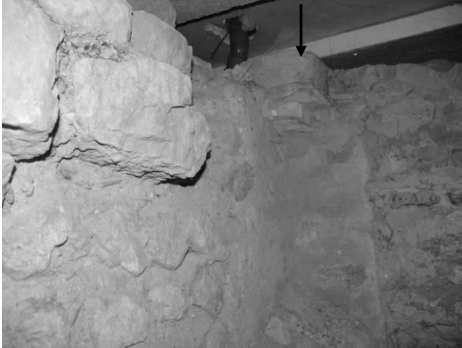
Fig. 78 : Vestiges du premier angle ouest du mur sud du couloir sud et des vestiges d'enduits anciens.
