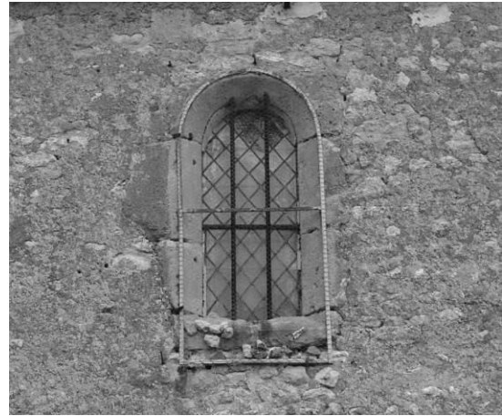
Fig. 21 : Une baie du mur gouttereau sud de la nef.
