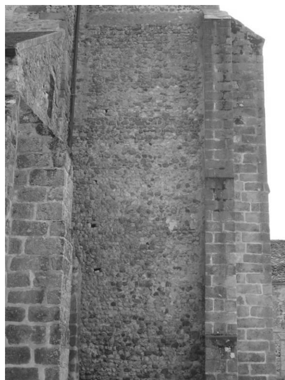
Fig. 14 : Détail de la face nord.
