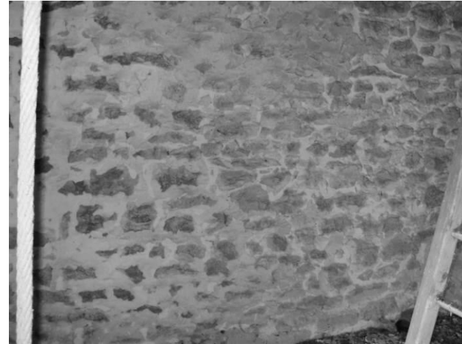
Fig. 61 : Premier étage du clocher : mur nord.
