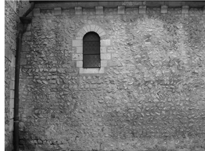
Fig. 24 : Partie est du mur du bas-côté nord.
