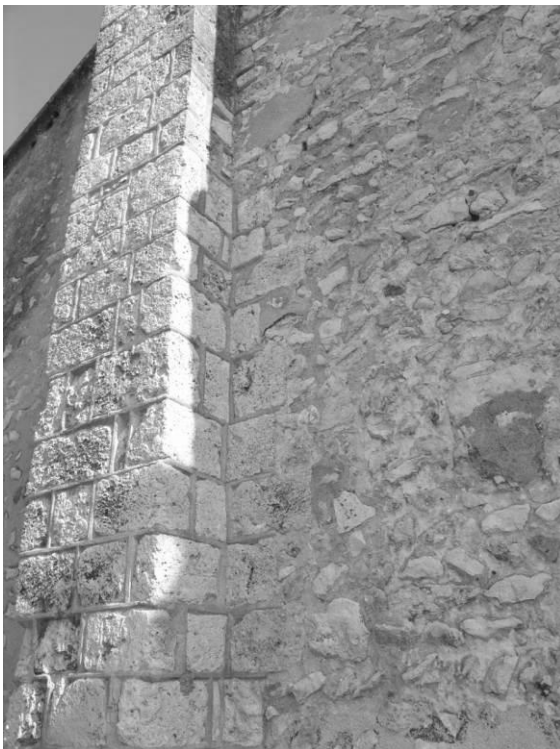
Fig. 36 : Angle entre le contrefort ouest et le pignon.
