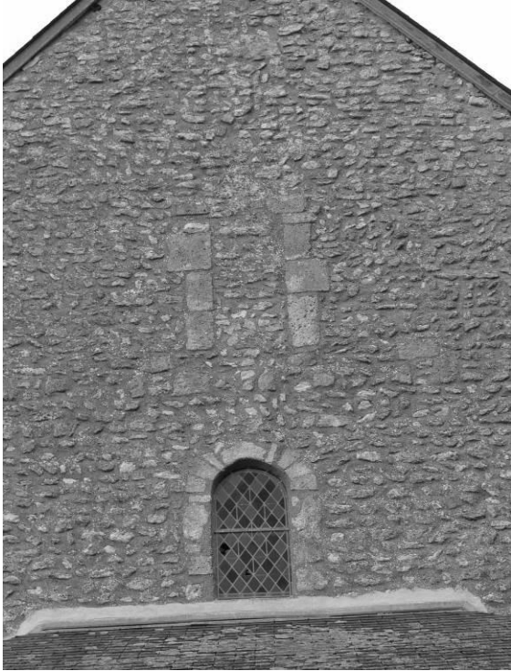
Fig. 11 : Le mur pignon ouest.
