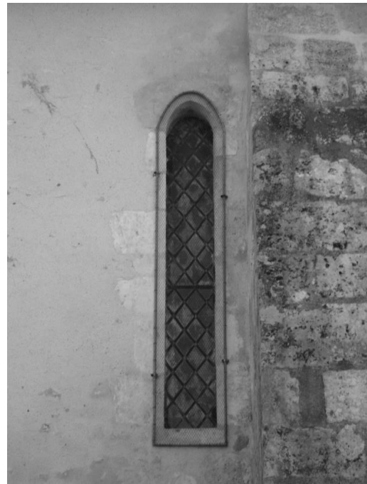
Fig. 11 : La baie à linteau monolithe du mur nord de la nef.
