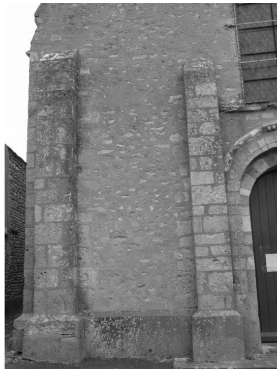
Fig. 7 : La partie nord de la façade ouest.
