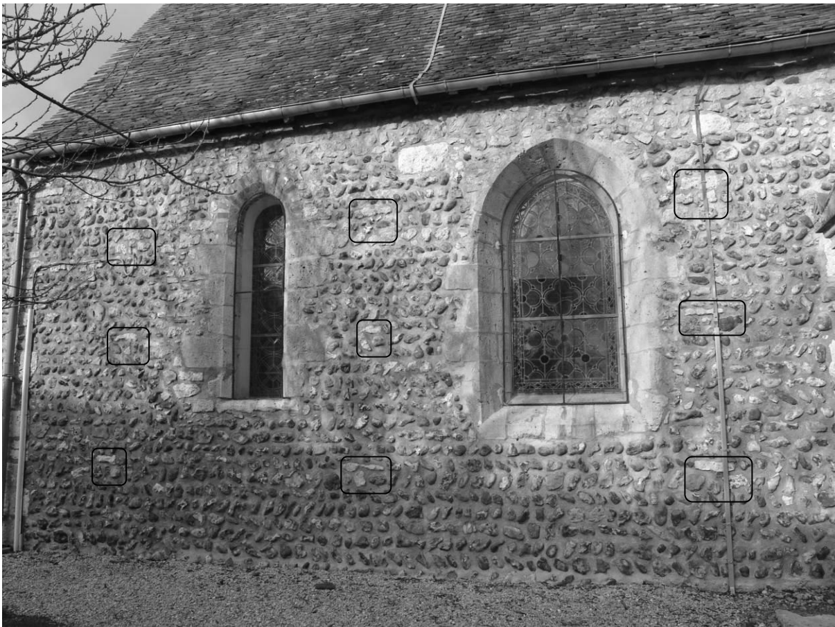
Fig. 10 : Le mur gouttereau sud de la nef, avec trois rangées de trous de boulins.
