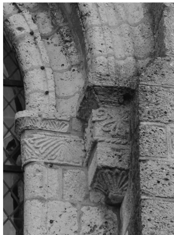
Fig. 40 : Chapiteaux du piédroit sud de la fenêtre centrale du pignon ouest.
