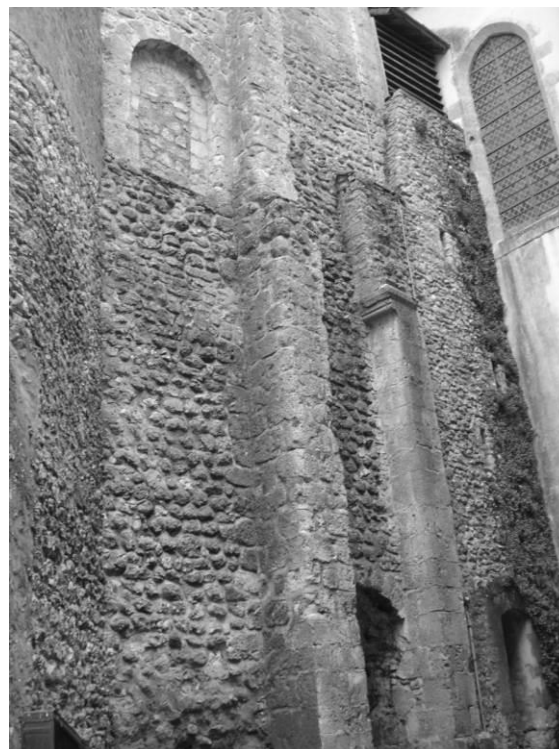
Fig. 39 : La face sud de la base du clocher.
