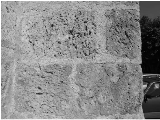
Fig. 18 : Détail des calcaires taillés (contrefort sud de la nef).
