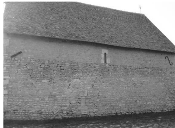
Fig. 32 : Le mur nord de la nef en 2007.
