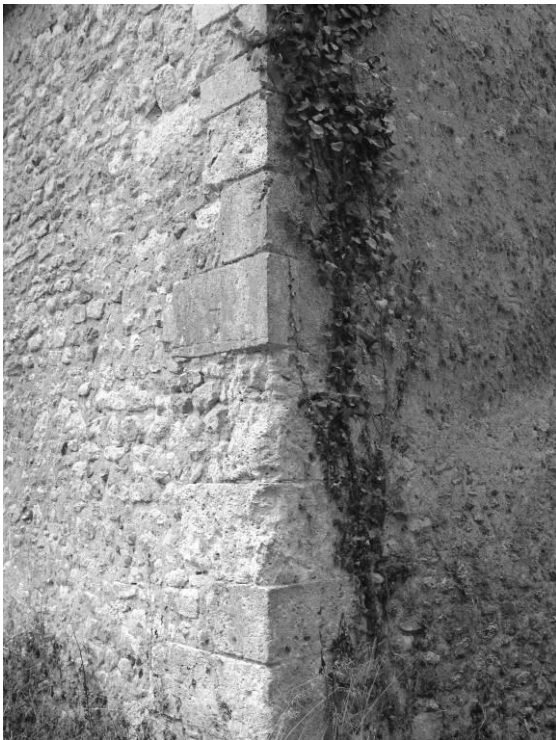
Fig. 18 : L'angle sud-est de l'abside.
