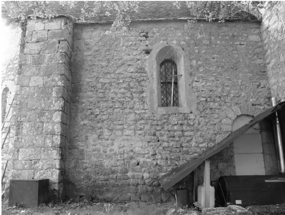
Fig. 34 : Le mur nord de la travée droite du chœur.
