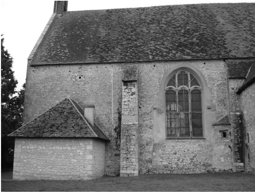
Fig. 33 : Le mur gouttereau sud de la nef.
