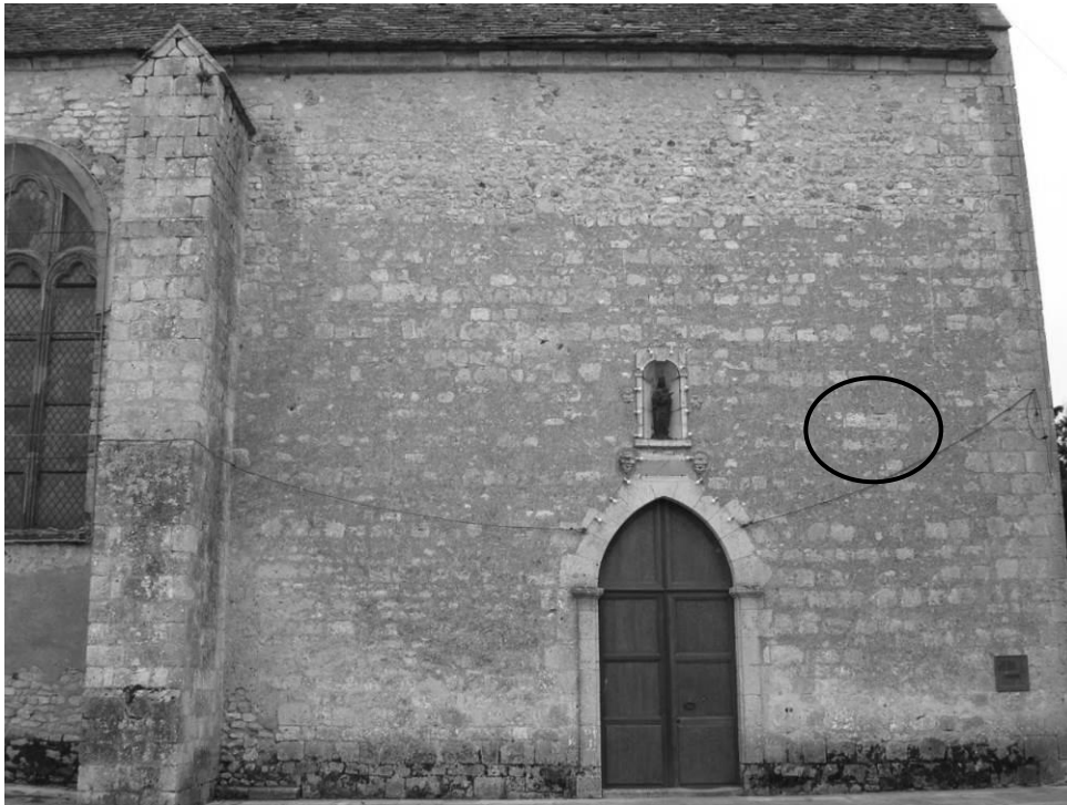
Fig. 42 : La partie occidentale du mur gouttereau nord de la nef. Les remplois sculptés sont entourés.
