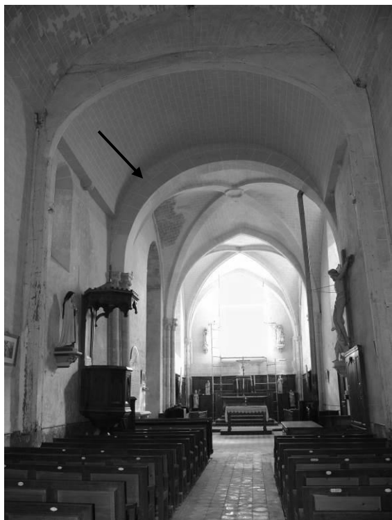
Fig. 20 : L'intérieur de l'église, vers l'est. La flèche indique l'arc en plein cintre entre nef et chœur.
