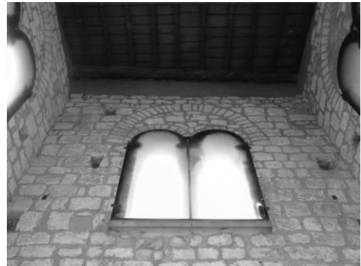
Fig. 31 : Les deux derniers niveaux du clocher : baie géminée sud supérieure.
