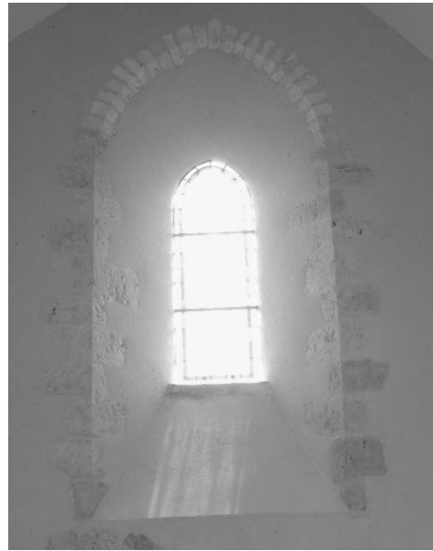
Fig. 18 : La baie sud de la travée orientale du chevet.
