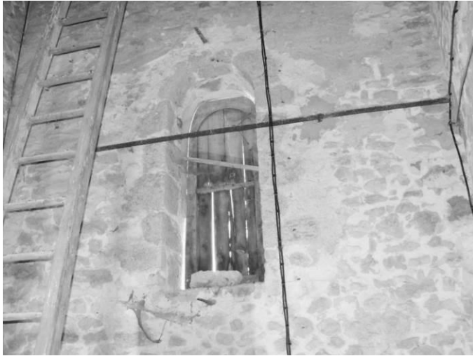
Fig. 60 : Premier étage du clocher : mur est.
