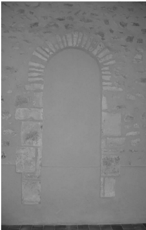
Fig. 78 : Le portail nord de la nef.
