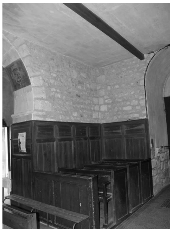
Fig. 28 : L'angle entre le mur gouttereau sud et le pignon ouest de la nef.
