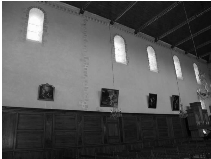
Fig. 30 : Le mur gouttereau nord de la nef.
