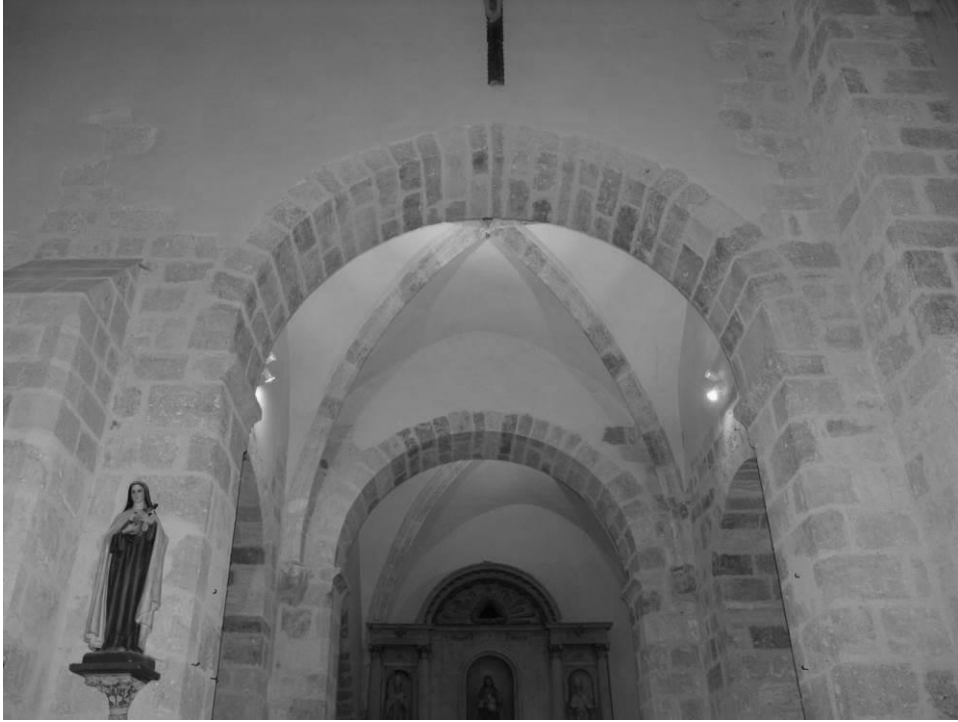
Fig. 11 : La partie centrale du chevet.
