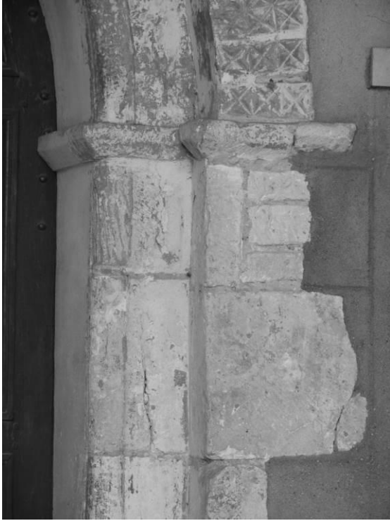
Fig. 12 : Détail du piédroit sud du portail, avec remplois probables de sarcophages.
