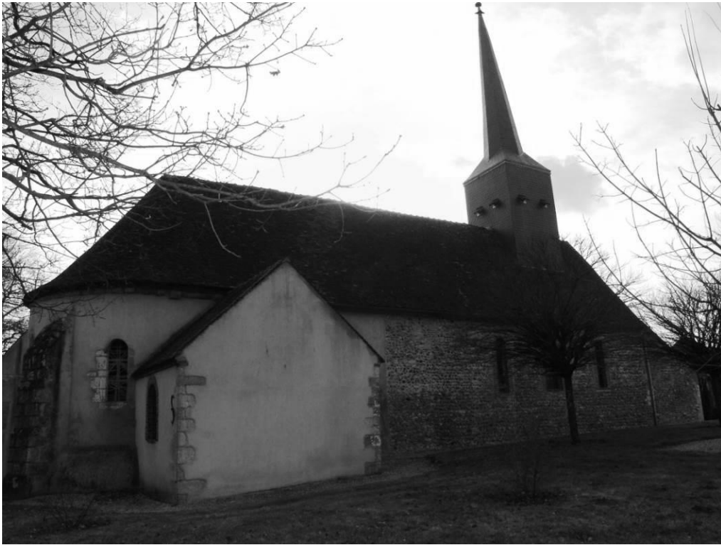
Fig. 6 : L'église vue depuis le nord-est.
