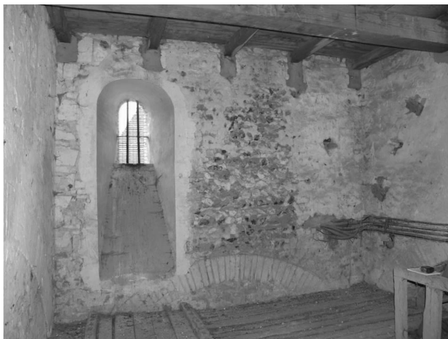
Fig. 21 : L'arcade sud du clocher.
