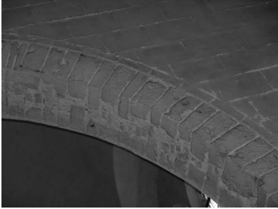
Fig. 50 : Détail des claveaux de l'arc triomphal.
