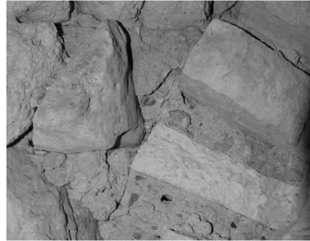
Fig. 55 : Reprise de mortier au-dessus des claveaux de l'un des arcs de la salle orientale.
