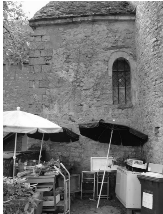
Fig. 36 : La partie orientale du mur gouttereau nord de la nef.
