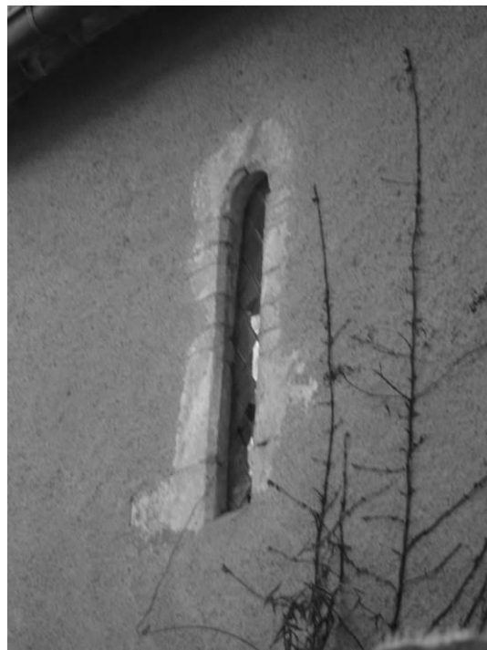
Fig. 11 : La baie du mur gouttereau nord.
