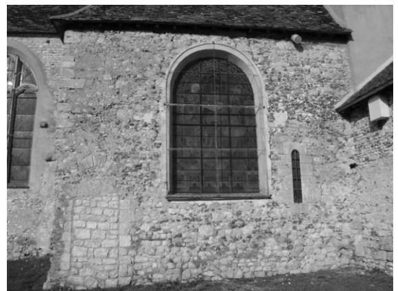
Fig. 32 : Le transept sud.
