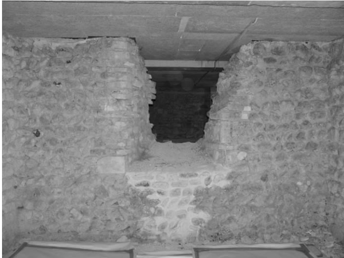
Fig. 50 : Le mur oriental de la crypte, face ouest.
