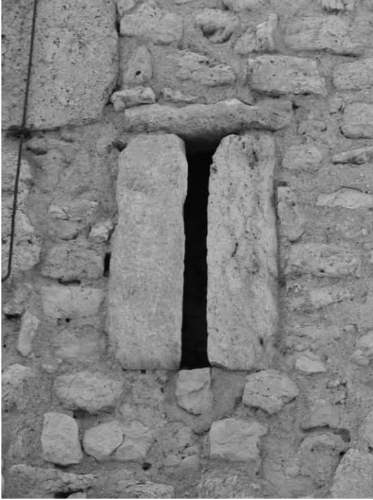
Fig. 32 : Meurtrière aménagée dans le mur sud de la nef (deuxième travée ouest).
