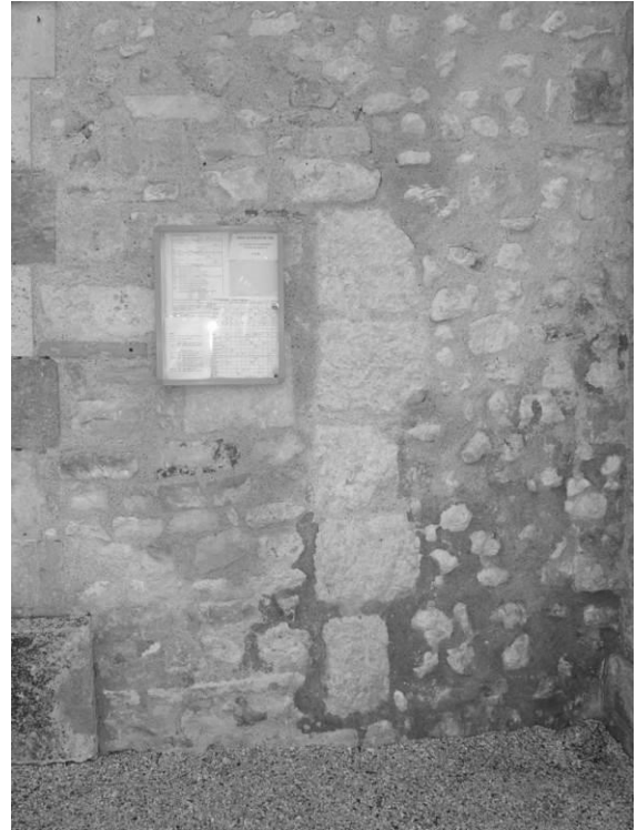
Fig. 13 : Le piédroit d'une ancienne porte dans la façade ouest.
