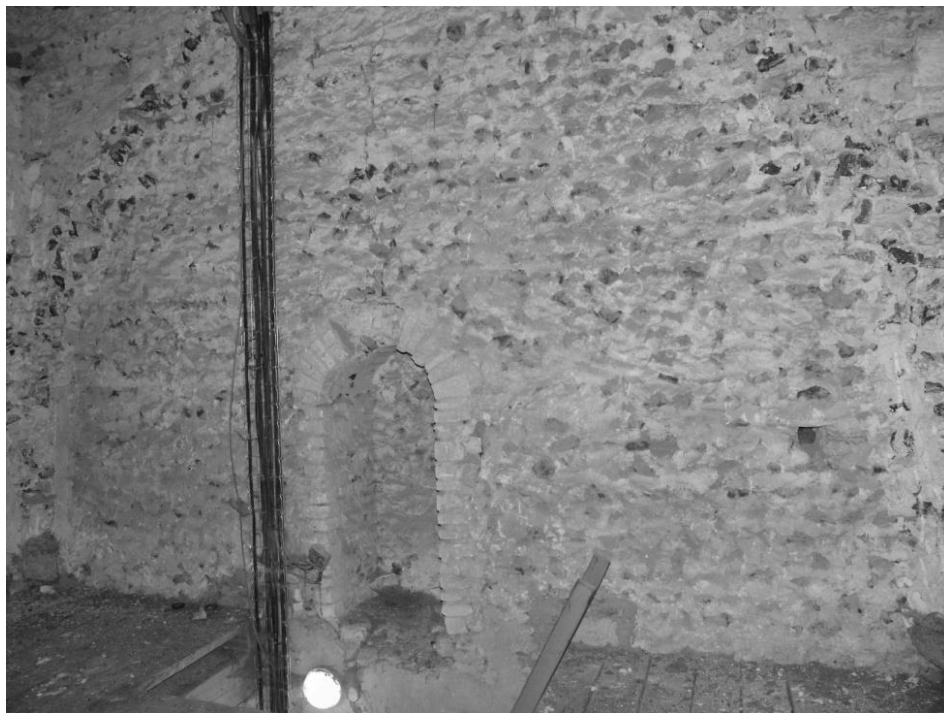
Fig. 29 : Sous la retombée des voûtes, face ouest, une baie bouchée.
