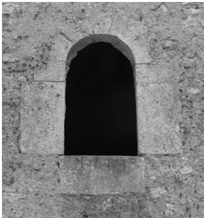
Fig. 22 : La baie orientale de l'abside.
