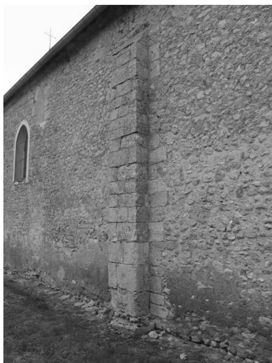
Fig. 14 : Un des contreforts du mur gouttereau nord.
