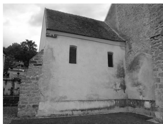
Fig. 10 : Le mur sud de la nef et la souche du clocher.
