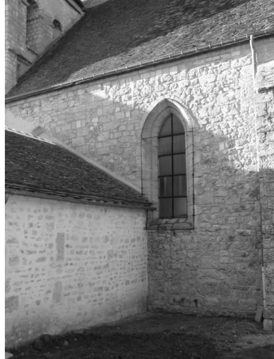
Fig. 25 : Le mur sud de l'église : première travée depuis l'est.
