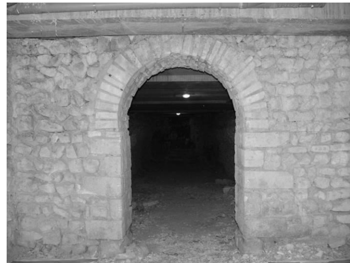
Fig. 53 : Le mur ouest de la salle orientale.
