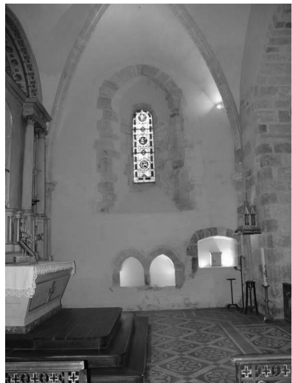
Fig. 17 : La travée orientale du chevet, partie centrale.
