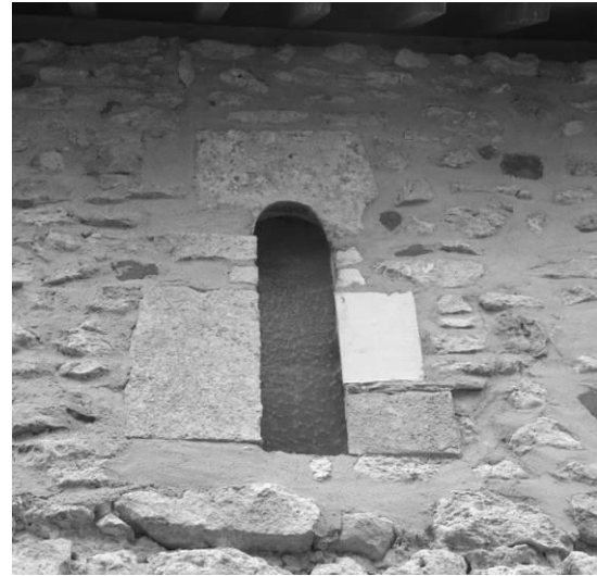
Fig. 54 : La baie du mur sud de la nef.
