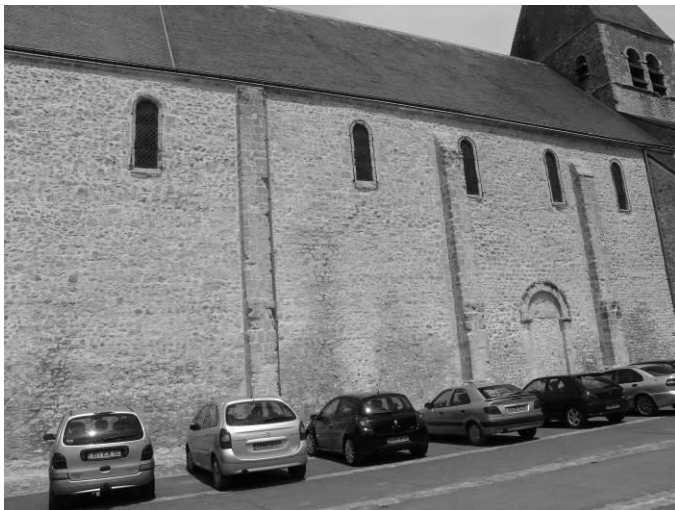
Fig. 15 : Le mur gouttereau sud de la nef.
