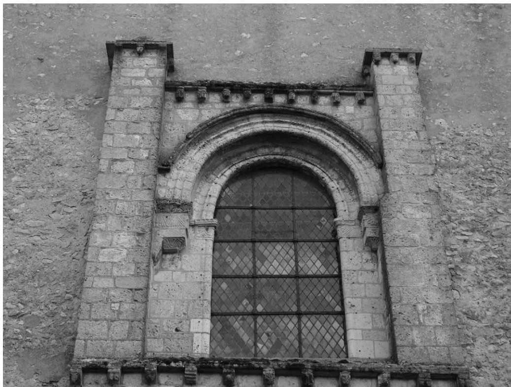
Fig. 38 : La fenêtre du pignon ouest.
