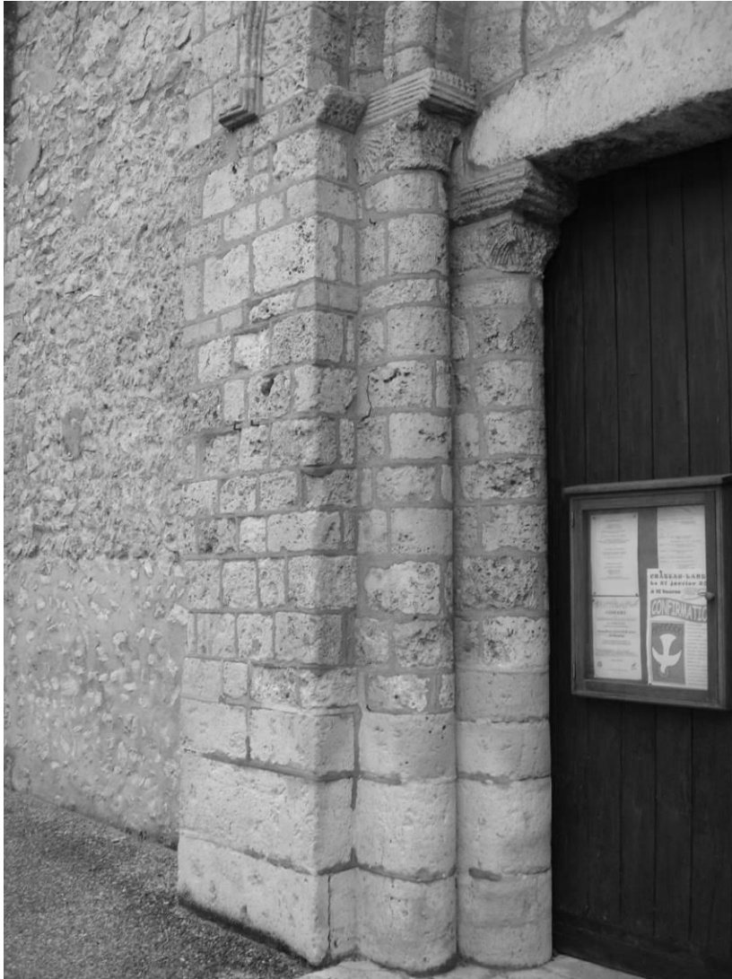
Fig. 46 : Piédroit nord du portail ouest.
