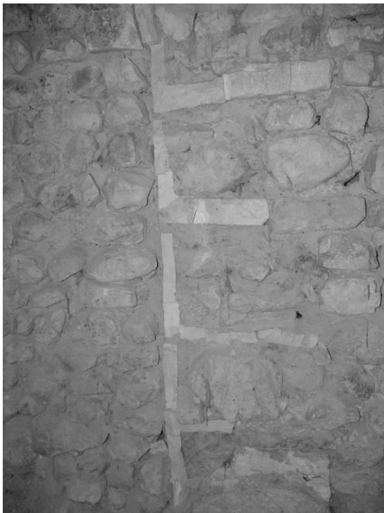
Fig. 64 : Un chaînage en remploi de sarcophages dans le mur nord du collatéral nord.
