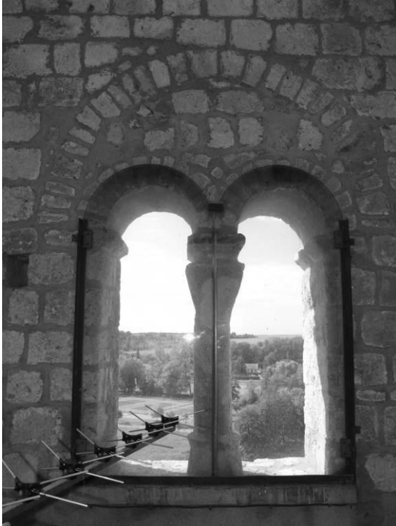
Fig. 30 : Les deux derniers niveaux du clocher : baie géminée sud inférieure.
