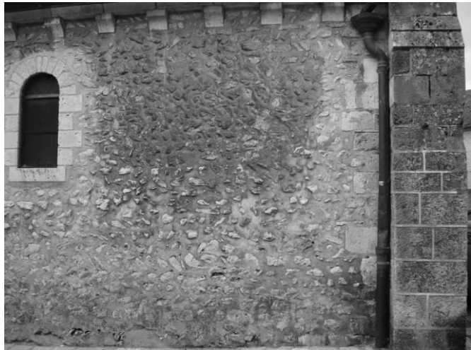
Fig. 25 : Partie ouest du mur du bas-côté nord.
