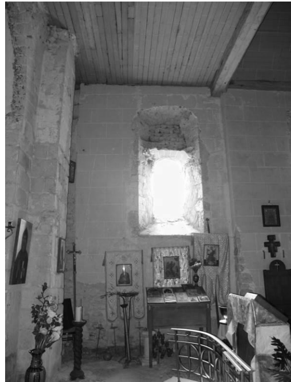
Fig. 48 : La partie orientale du mur gouttereau sud de la nef.
