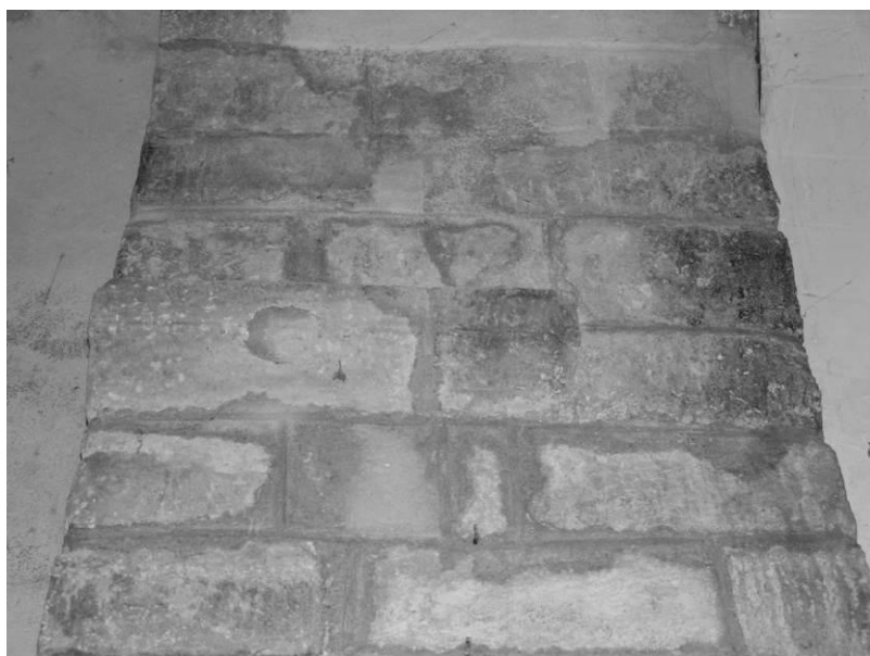
Fig. 28 : Imposte du pilier sud-ouest de la souche du clocher.
