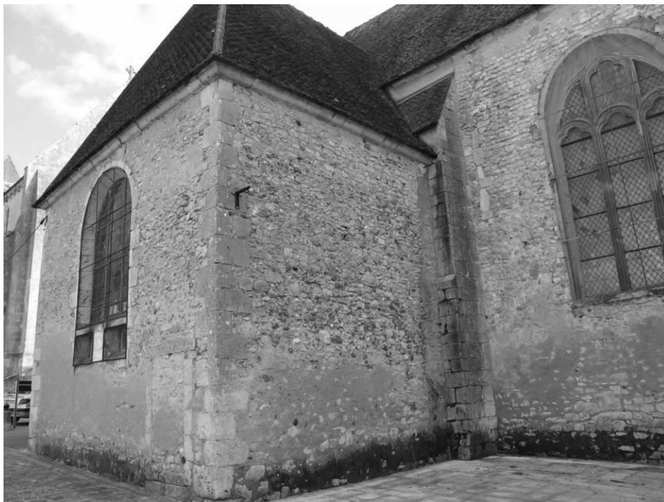
Fig. 39 : Le transept sud.
