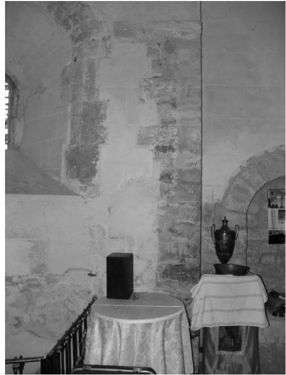
Fig. 67 : L'entrée sud de l'absidiole.
