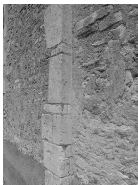
Fig. 9-10 : Vue générale et détail du chaînage d'angle sud, à la naissance de l'abside.
