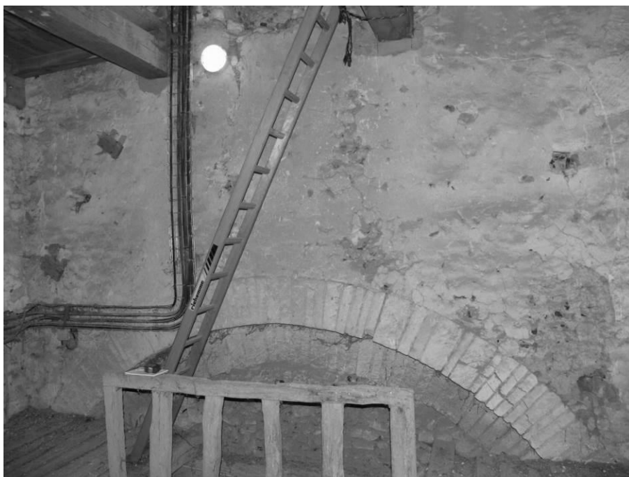
Fig. 20 : L'arcade occidentale du clocher, à double rouleau.
