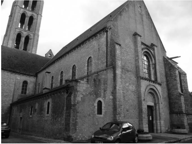
Fig. 23 : L'église, vue depuis le nord-ouest.
