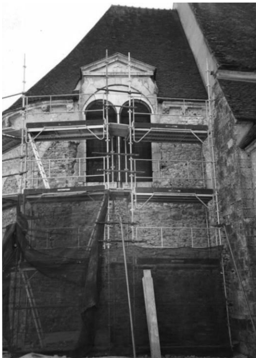
Fig. 16 : Le mur nord de l'abside en cours de restauration en mars 1998. Ferrières-en-Gâtinais. Chapelle de Bethléem , [photographie], mars 1998, Orléans, Service départemental de l'architecture et du patrimoine, Dossier de la commune de Ferrières, cliché 52/3/10.
