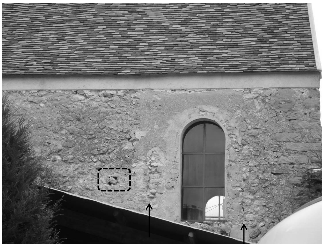
Fig. 27 : Le mur gouttereau sud. Un éventuel trou de boulins est entouré. Les flèches indiquent l'emplacement de reprises.
