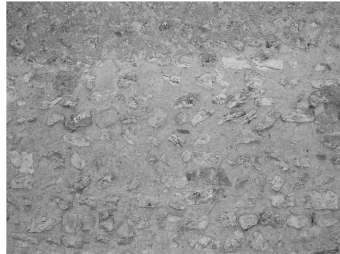
Fig. 23 : Détail du parement du mur gouttereau nord.
