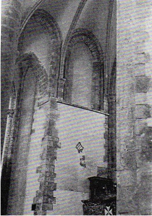
Fig. 32 : Le mur nord de l'abside, avant restauration (fig. 12, n°3).
