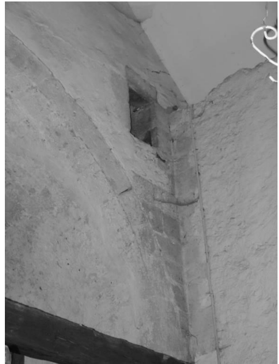
Fig. 20 : Détail de l'arc de tête de l'abside, côté sud.
