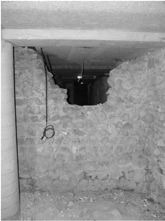
Fig. 47 : Le mur oriental du collatéral nord, face est.
