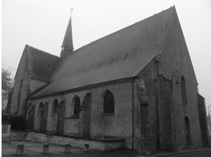
Fig. 9 : Vue depuis le nord-ouest.
