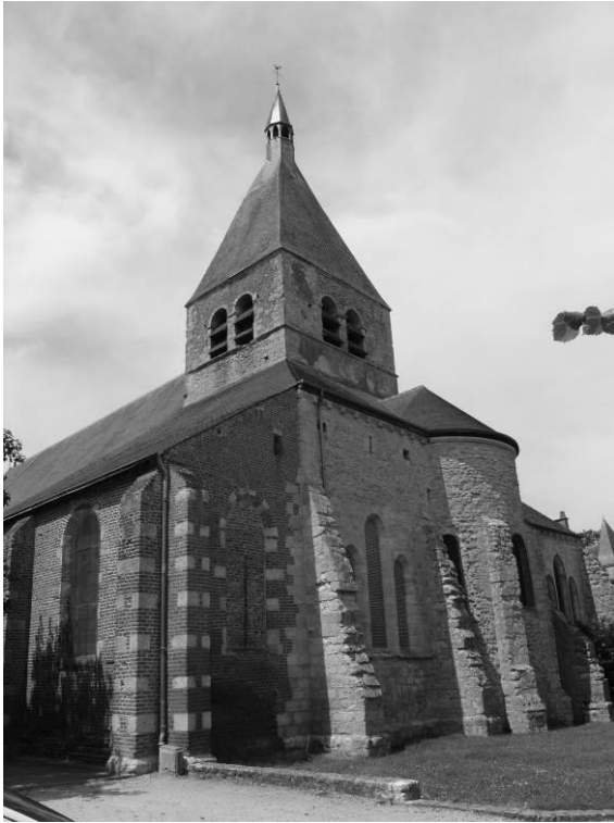
Fig. 25 : Le chevet vu depuis le sud-est.
