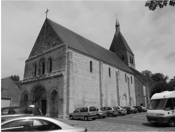
Fig. 14 : Vue de l'église depuis le sud-ouest.
