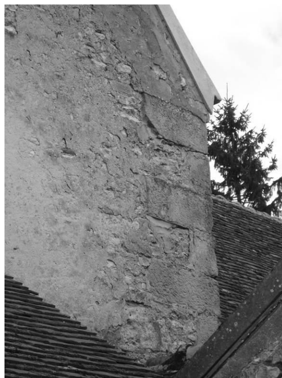
Fig. 16 : L'angle sud-ouest de la nef.
