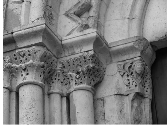
Fig. 82 : Détails des chapiteaux du portail du transept sud.
