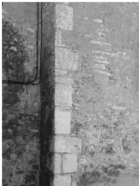
Fig. 14 : Le chaînage d'angle entre la nef et le chevet, au nord.
