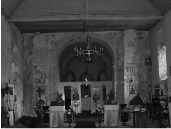
Fig. 51 : Le mur pignon oriental de la nef.
