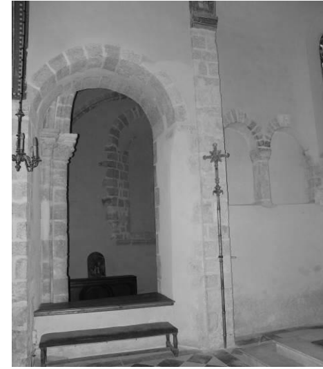
Fig. 34 : Le côté nord de la partie centrale du chœur.
