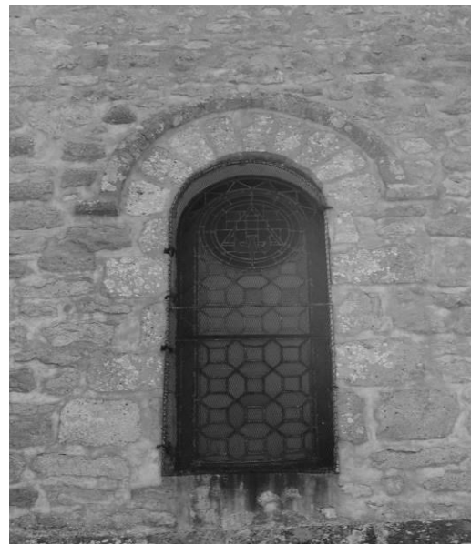
Fig. 19 : Fenêtre du mur ouest de la nef.
