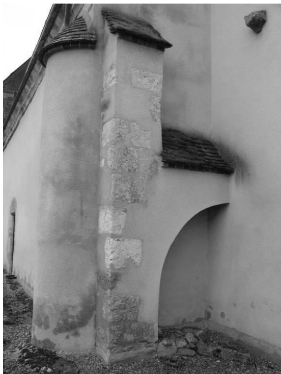
Fig. 8 : Contreforts de l'angle nord-ouest de la nef.
