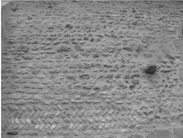
Fig. 13 : Le mur gouttereau sud de la nef.
