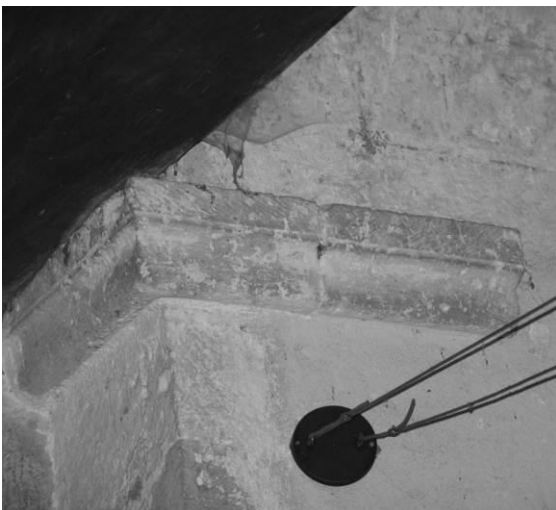
Fig. 21 : Imposte du pilier nord de l'arc de tête de l'abside.
