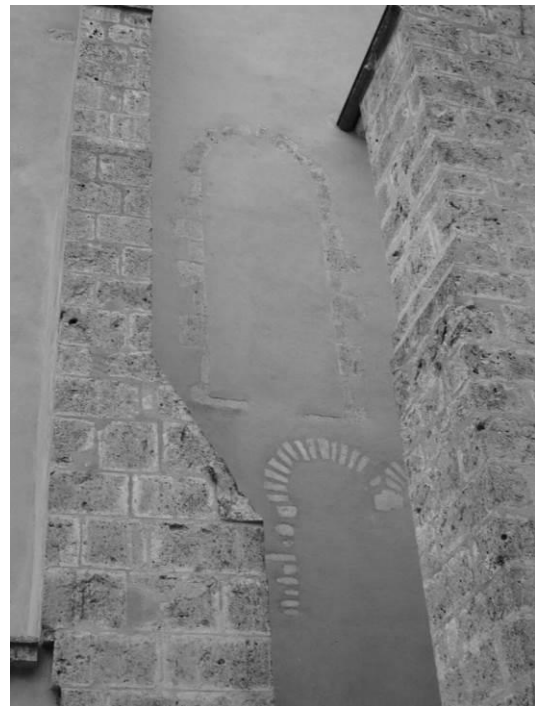
Fig. 24 : Détail du mur nord de l'abside (fig. 12 : n°2).
