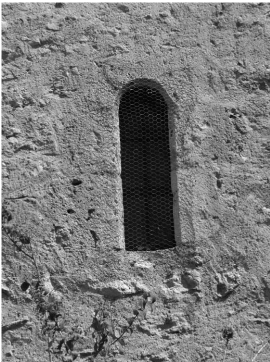
Fig. 12 : La fenêtre du mur gouttereau sud de la nef.
