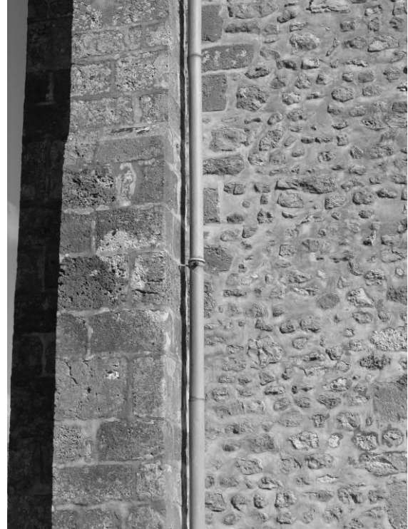
Fig. 17 : Le contrefort sud de la façade ouest et sa liaison avec le mur gouttereau sud.
