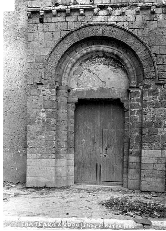
Fig. 17 : Le portail ouest de l'église au cours du XIX e siècle.
