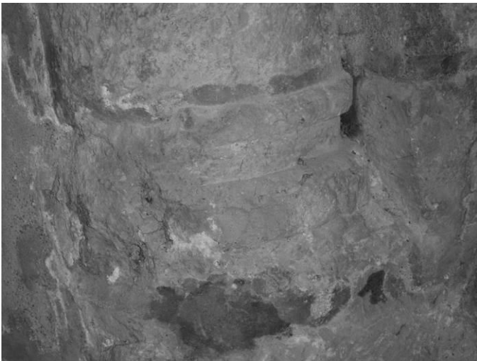
Fig. 58 : Portail ouest, face intérieure, base du piédroit sud.
