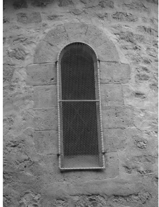
Fig. 10 : Une baie de l'absidiole nord du chevet.
