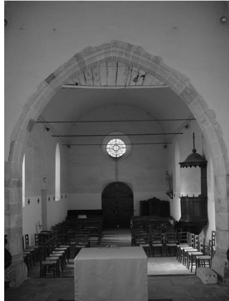
Fig. 25 : L'intérieur de l'édifice, vu vers l'ouest.
