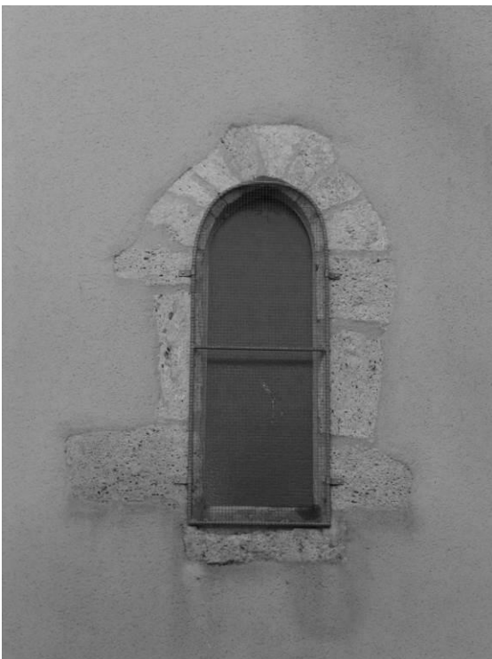
Fig. 11 : La baie nord de l'abside.
