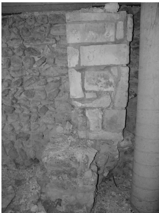
Fig. 45 : Le contrefort nord.
