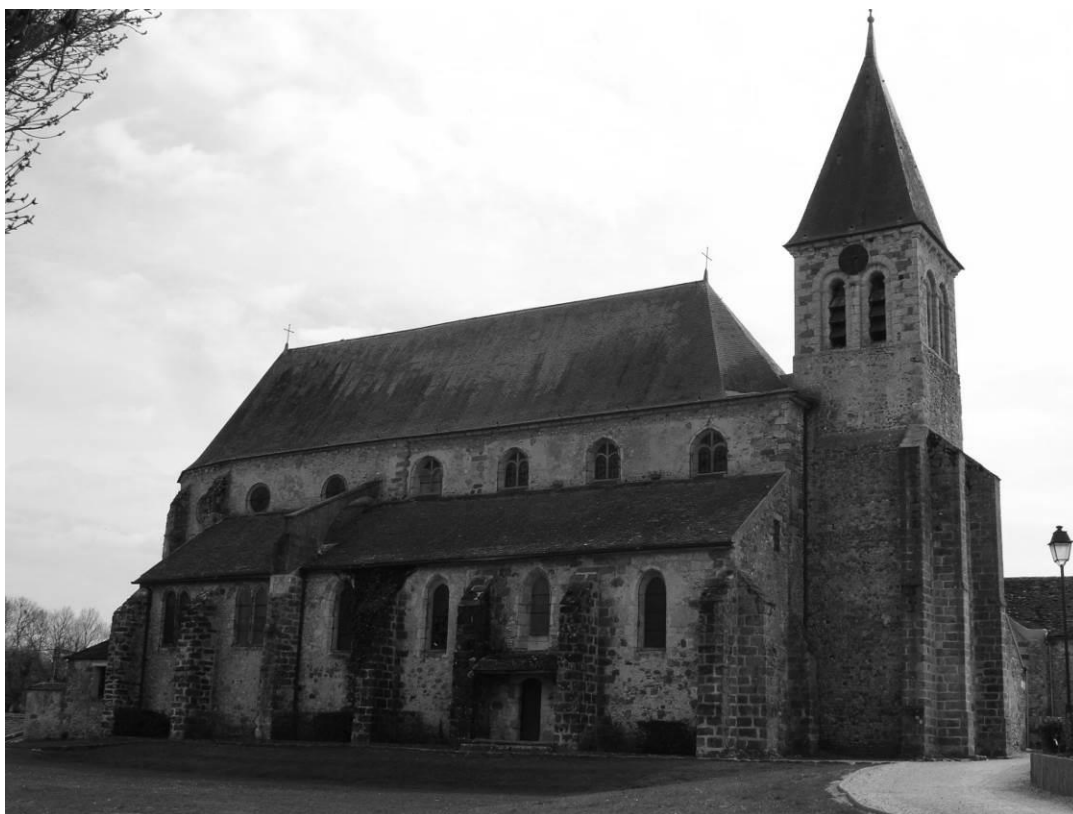
Fig. 12 : Vue de l'église depuis le nord-ouest.
