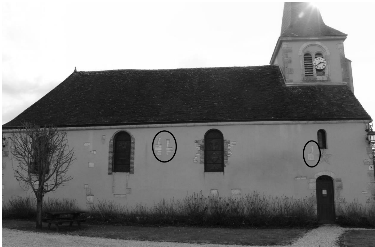
Fig. 5 : Le mur nord de l'église. Les anciens éléments en remplois de sarcophages sont entourés.
