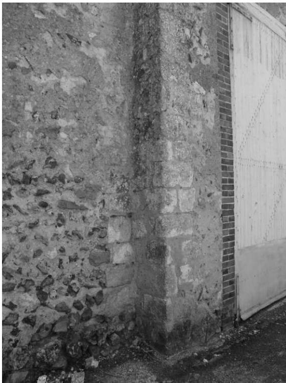
Fig. 12 : Détail de l'angle entre la nef et le chevet.
