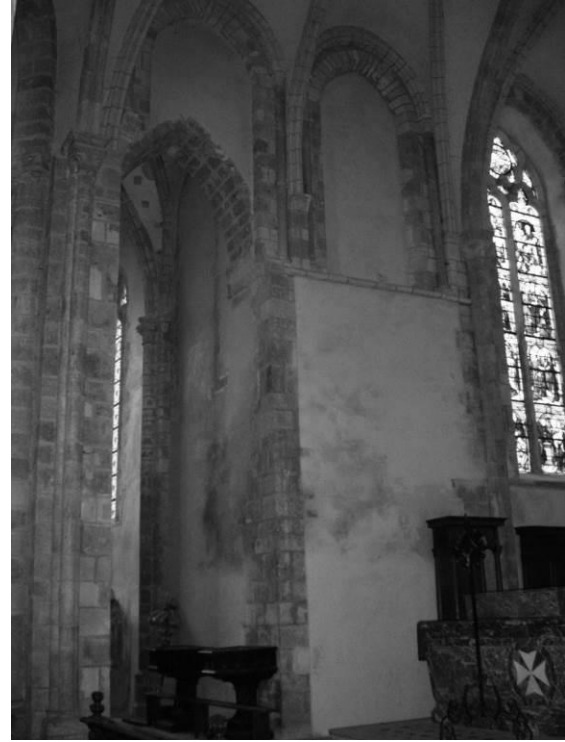
Fig. 33 : Le mur nord de l'abside, aujourd'hui.
