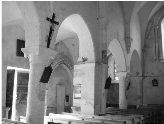
Fig. 15 : Le mur gouttereau sud de la nef.
