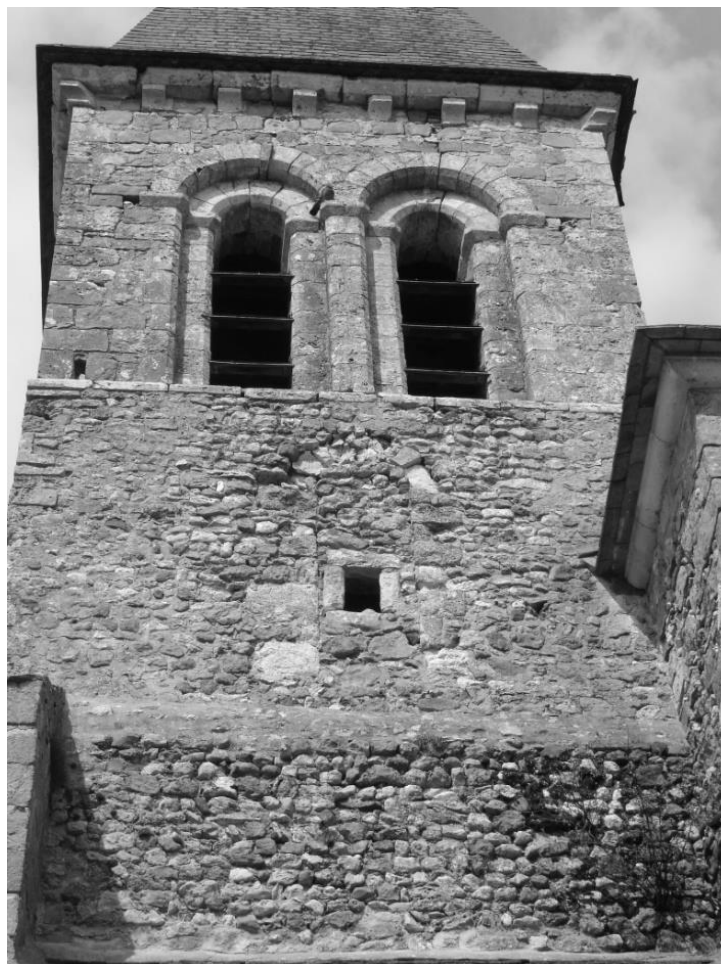
Fig. 22 : La face sud du clocher, partie supérieure.
