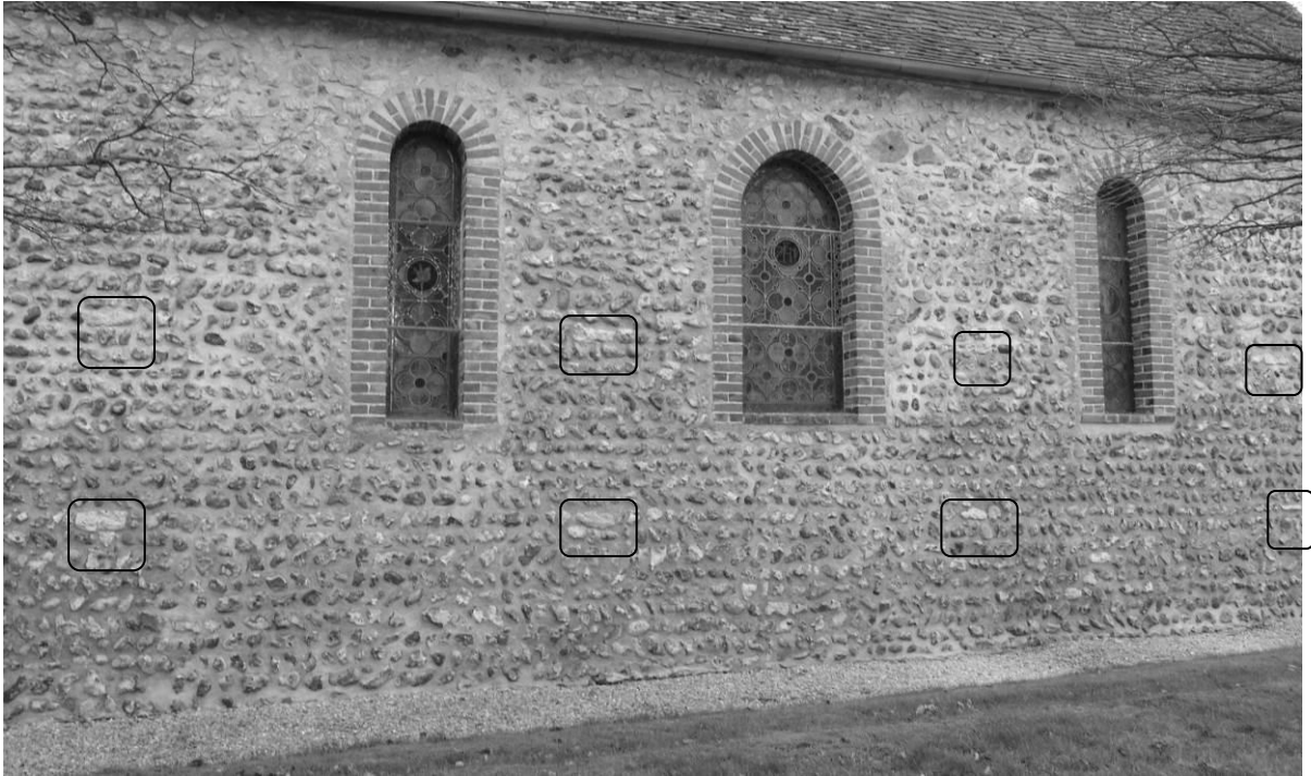
Fig. 9 : Le mur gouttereau nord de la nef, avec deux rangées de trous de boulins.
