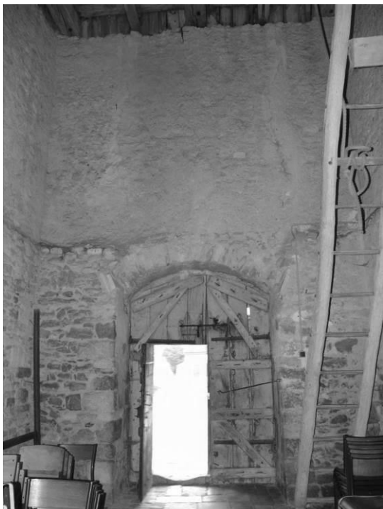
Fig. 12 : Le portail occidental du clocher-porche, à l'intérieur.
