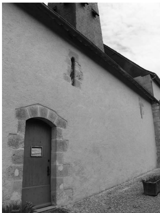
Fig. 8 : Le mur gouttereau sud de la nef.
