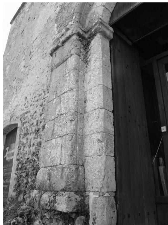
Fig. 7 : Détail du piédroit est.
