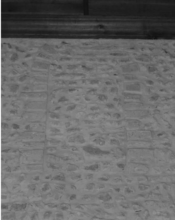
Fig. 16 : La fenêtre ouest du mur gouttereau nord de la nef.
