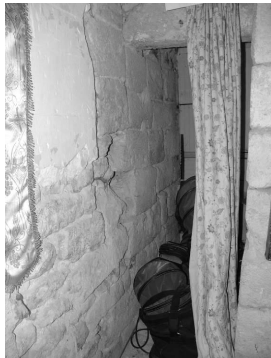
Fig. 50 : Angle nord-est de la nef, partie inférieure.
