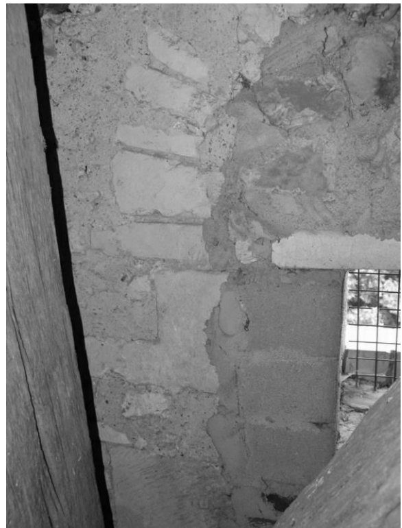
Fig. 33 : Détail d'une des baies triples du second niveau, face est.
