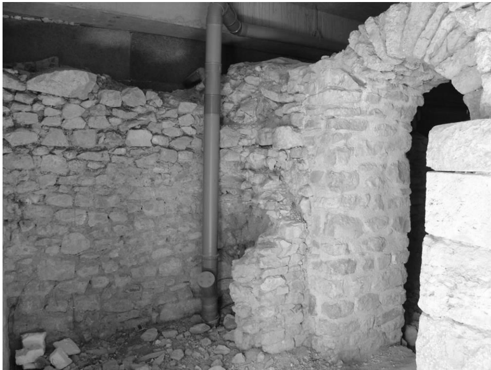
Fig. 96 : La face orientale de l'arcade est de la salle sud, côté sud.
