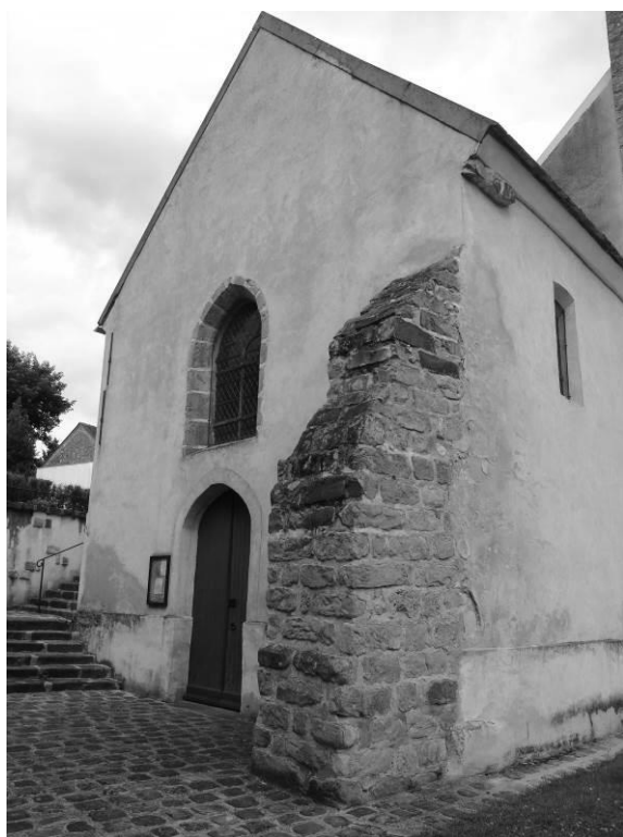
Fig. 9 : La façade occidentale de l'église.
