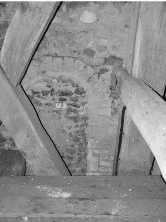
Fig. 32 : Une des baies triples du second niveau, face ouest.
