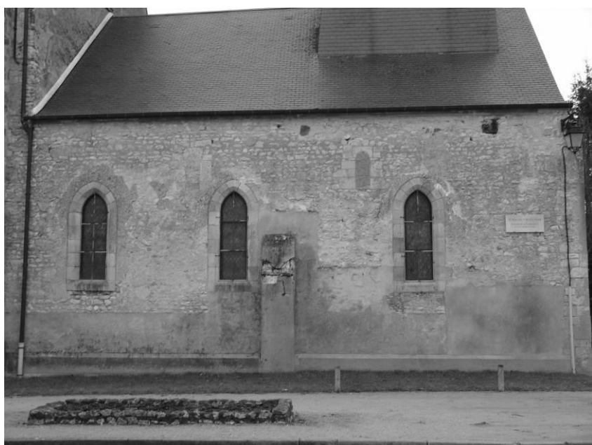
Fig. 8 : Le mur nord de la nef.
