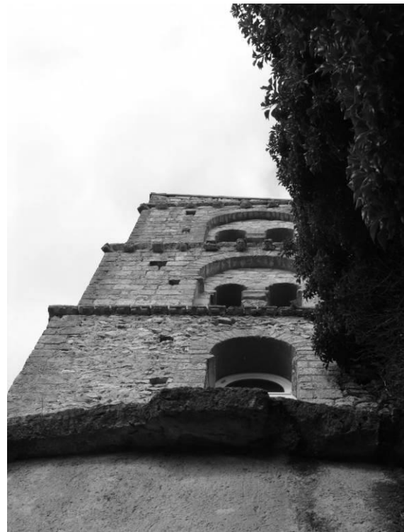
Fig. 17 : Face est du clocher, avec la toiture de l'absidiole au premier plan.
