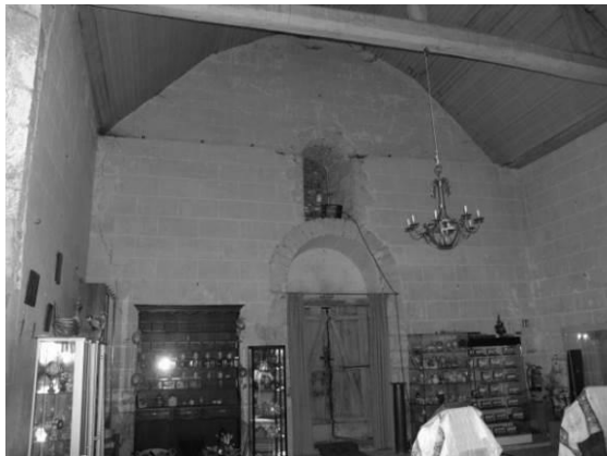
Fig. 41 : Le mur ouest de la nef.
