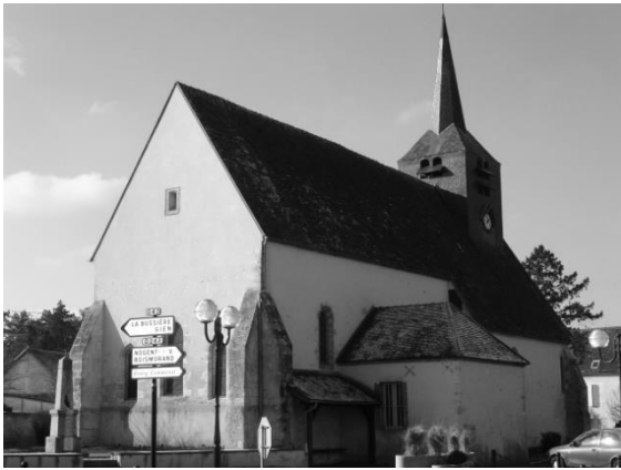
Fig. 5 : L'église vue depuis le nord-est.
