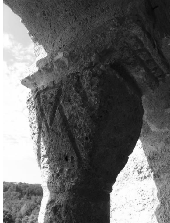
Fig. 35 : Chapiteau de la baie géminée sud.
