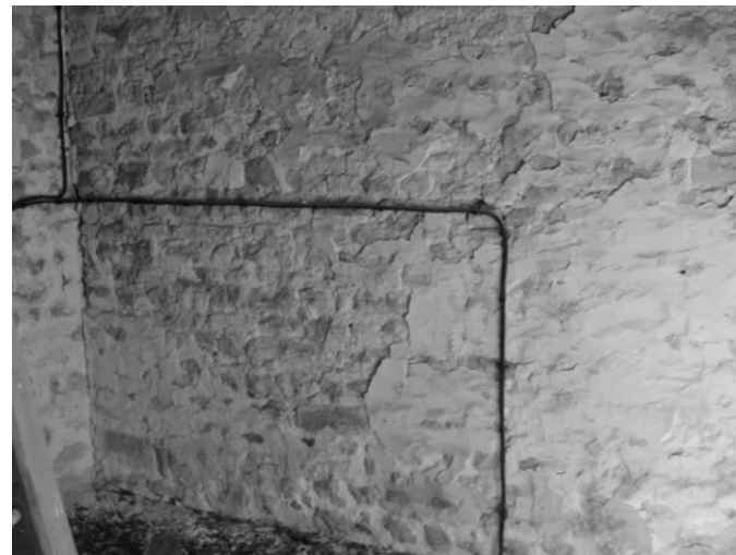
Fig. 63 : Premier étage du clocher : mur sud.
