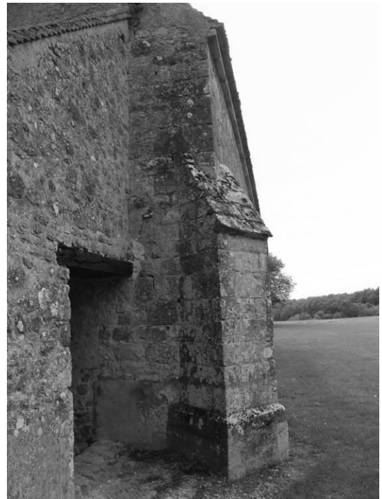
Fig. 19 : L'angle sud-ouest de la nef.
