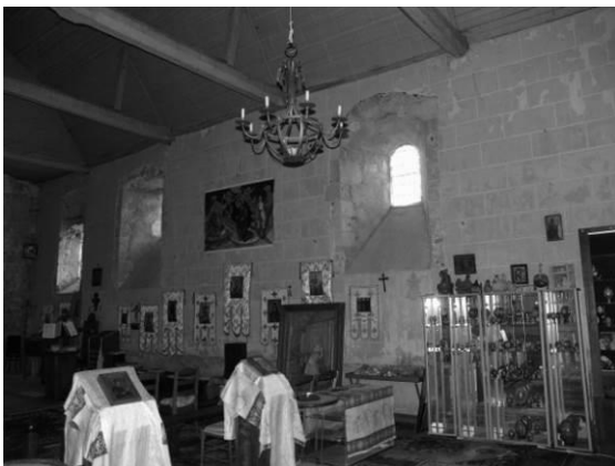
Fig. 45 : Le mur nord de la nef.
