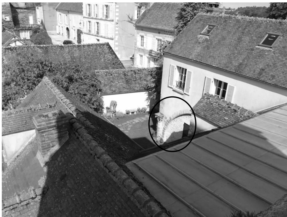
Fig. 39 : Vestiges d'arcades dans le mur gouttereau nord ( ?). Photographie prise depuis une des fenêtres ouest du clocher.
