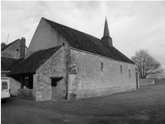
Fig. 16 : L'église vue depuis le sud-ouest.
