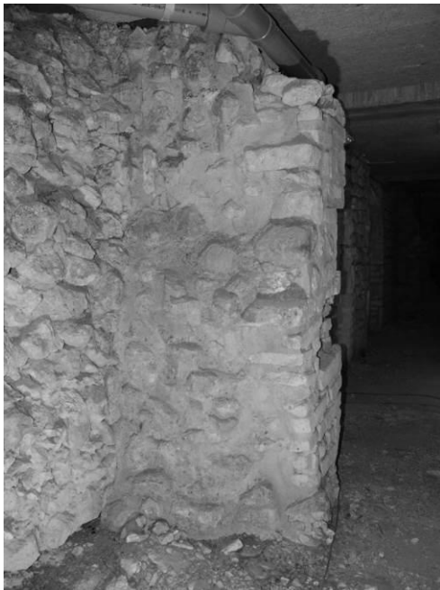
Fig. 73 : Revers du retrait dans le couloir sud (face ouest).
