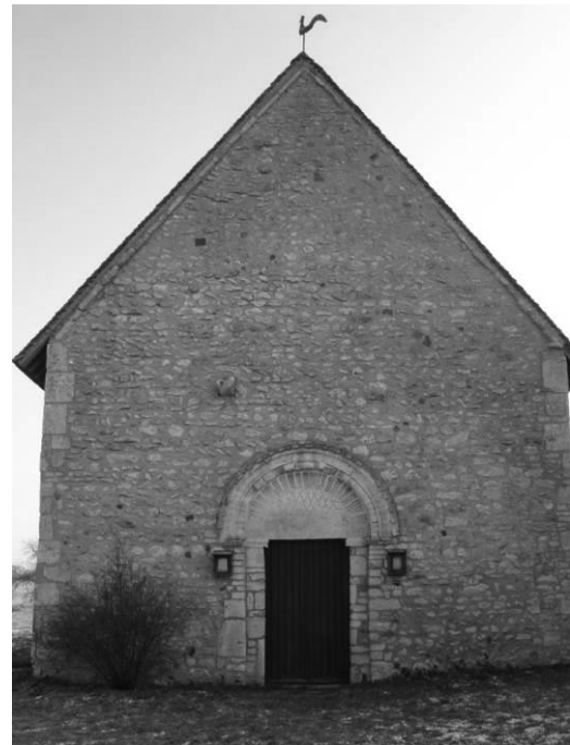
Fig. 28 : La façade ouest, en février 2007.
