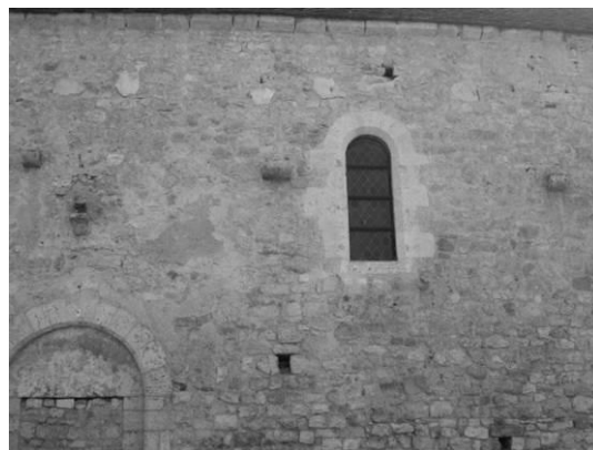
Fig. 20 : Détail du mur gouttereau nord.
