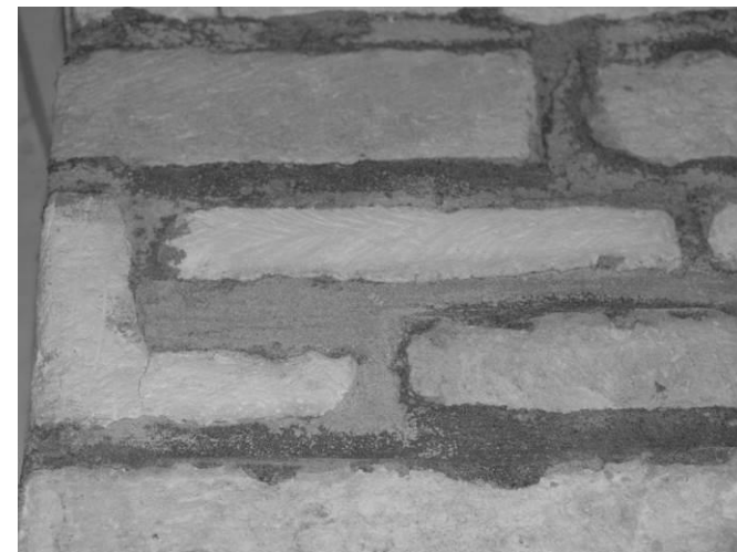
Fig. 45 : Détail du parement d'un des piliers du chevet.
