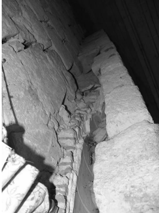
Fig. 55 : Contrefort nord, face nord.
