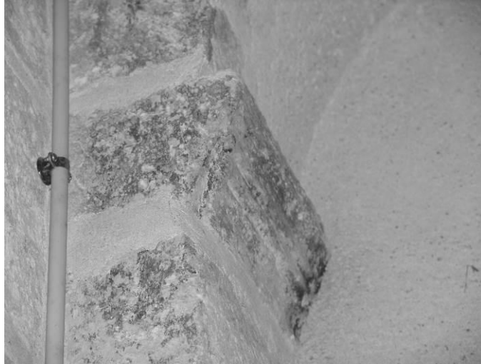
Fig. 36 : Détail de l'imposte ouest de l'arcature nord de l'abside.
