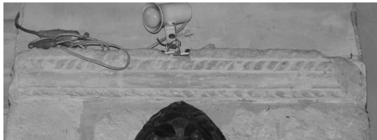
Fig. 31 : Imposte est du deuxième pilier du mur gouttereau sud.
