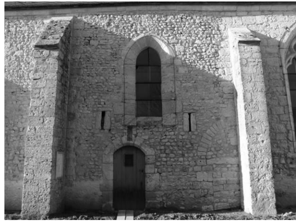
Fig. 29 : Le mur sud de l'église : cinquième travée depuis l'est.
