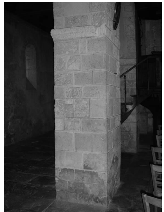
Fig. 69 : Le troisième pilier du mur gouttereau nord de la nef, depuis l'ouest.
