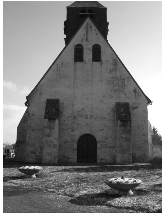
Fig. 6 : La façade ouest.
