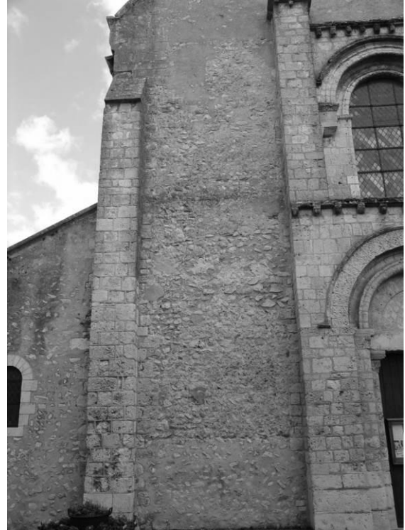
Fig. 35 : Portion de mur entre le contrefort ouest et le massif en saillie.
