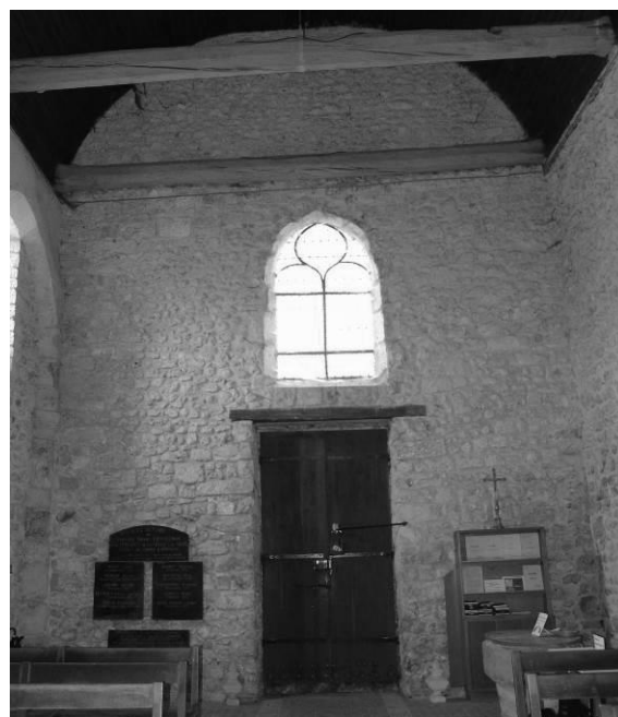
Fig. 12 : Le mur occidental de la nef.
