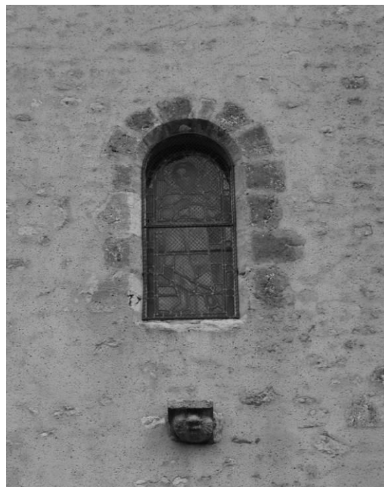
Fig. 9 : La fenêtre du mur pignon ouest.
