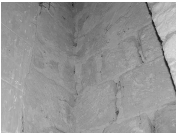
Fig. 49 : Angle nord-est de la nef, partie supérieure.
