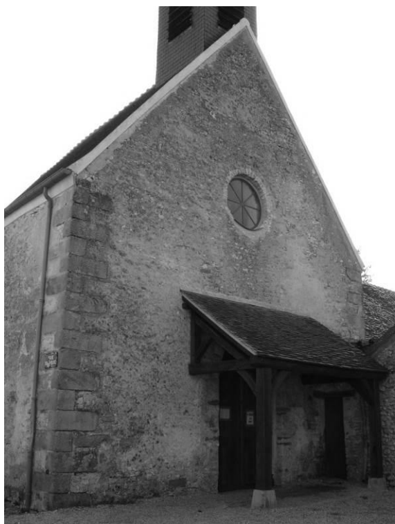
Fig. 15 : La façade occidentale de l'église.
