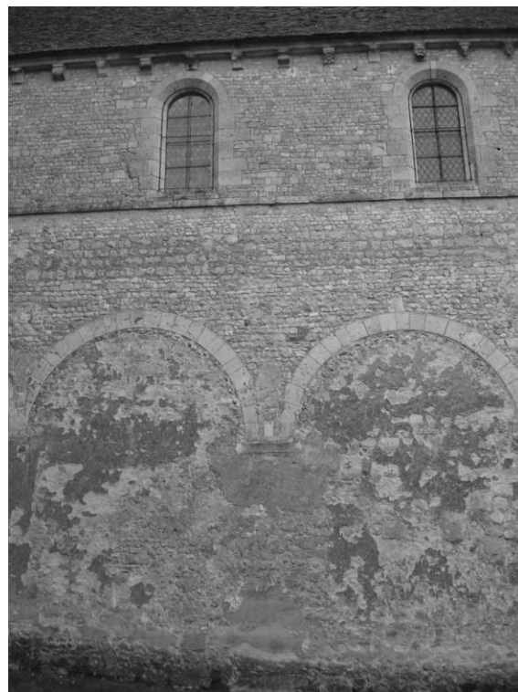
Fig. 44 : Le mur gouttereau nord de la nef.
