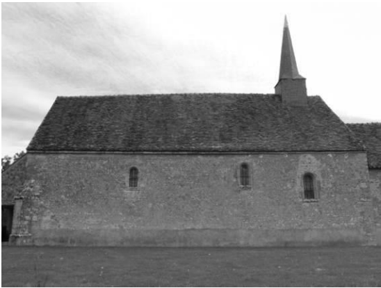
Fig. 20 : Le mur gouttereau sud de la nef.
