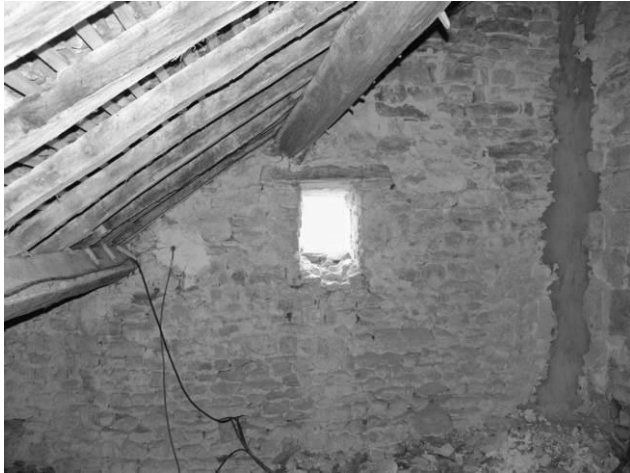
Fig. 67 : Combles au-dessus de la partie centrale du chœur : mur sud.
