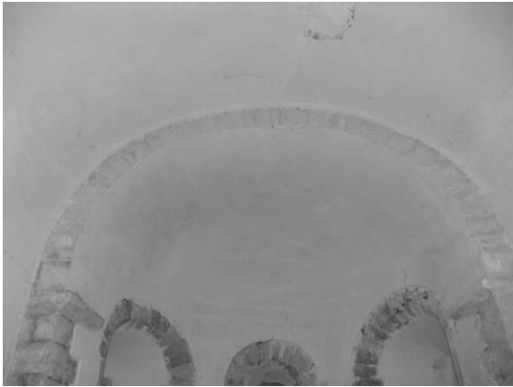
Fig. 70 : La voûte en cul-de-four de l'apsidiole.
