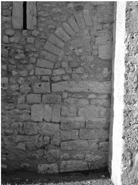
Fig. 30 : Portail bouché dans la cinquième travée depuis l'est du mur sud.
