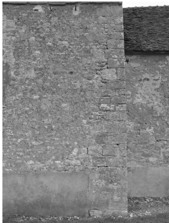
Fig. 23 : L'angle oriental du mur sud de la nef.
