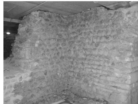
Fig. 57 : Angle entre le mur est et le mur sud de la salle orientale.
