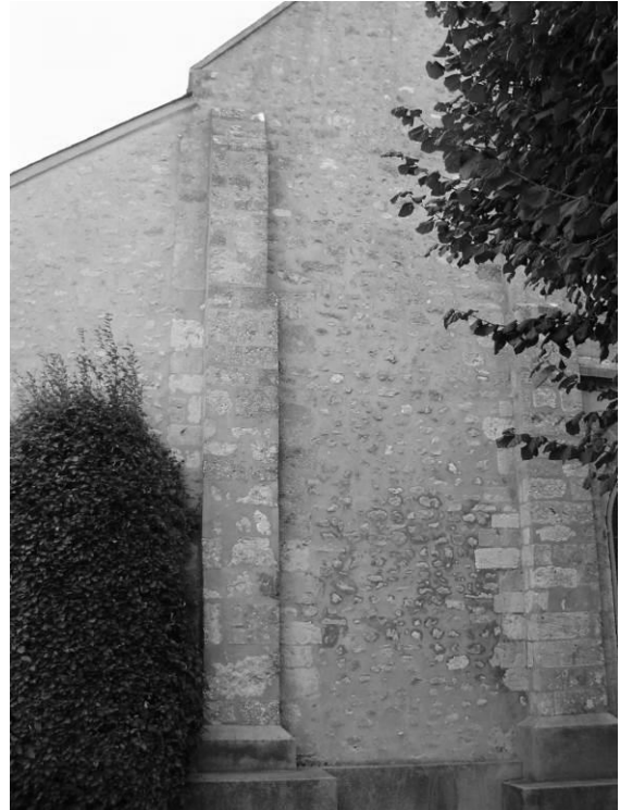
Fig. 11 : L'angle nord de la nef centrale.
