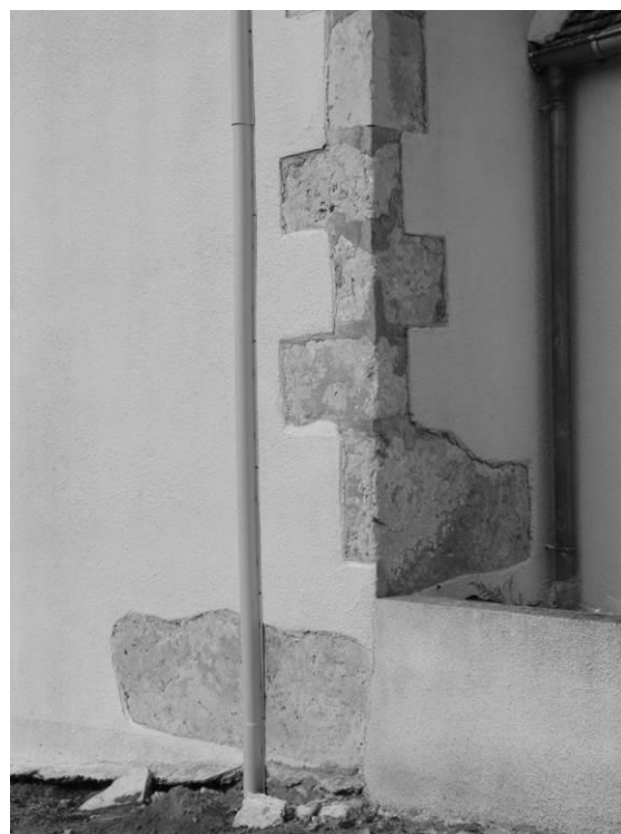
Fig. 12 : L'angle sud-est de l'édifice.
