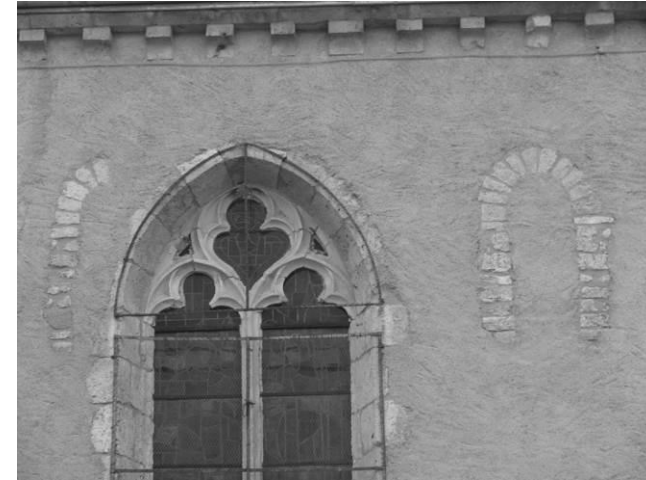
Fig. 11 : Détail des fenêtres bouchées dans le mur sud de la nef.
