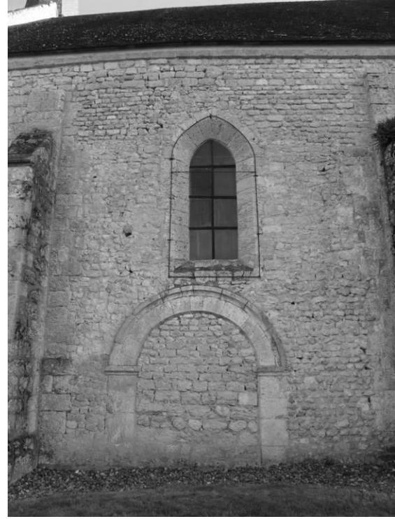
Fig. 21 : Le mur nord de l'église : deuxième travée depuis l'ouest.
