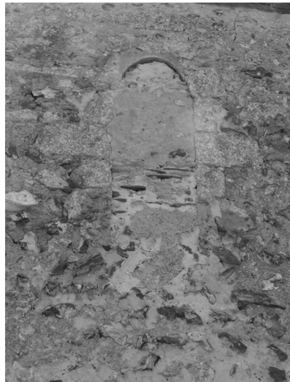
Fig. 13 : L'une des fenêtres bouchées du mur nord de la nef.
