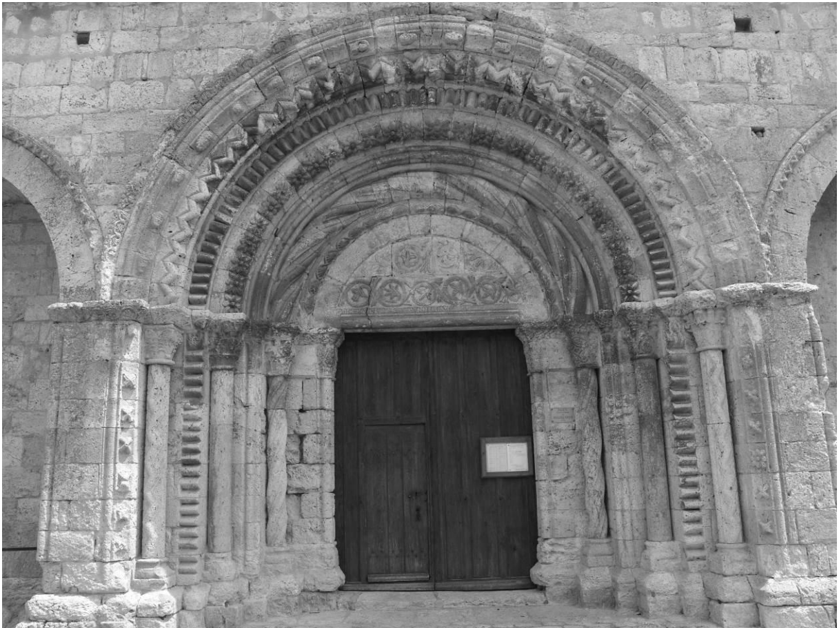
Fig. 24 : Le portail occidental de la nef.
