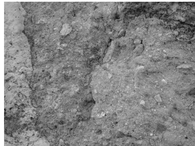
Fig. 24 : Détail des mortiers du parement du mur gouttereau nord.
