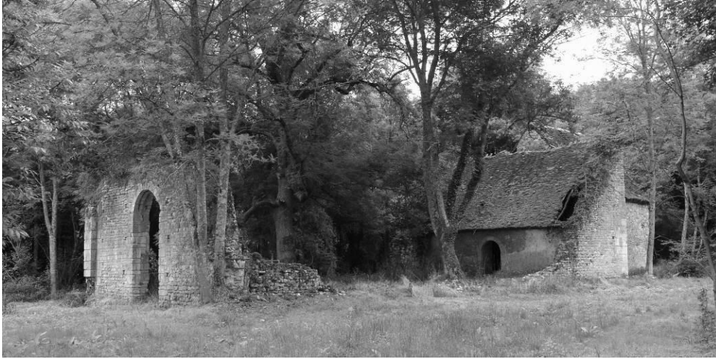
Fig. 7 : Vue générale des vestiges de la chapelle.
