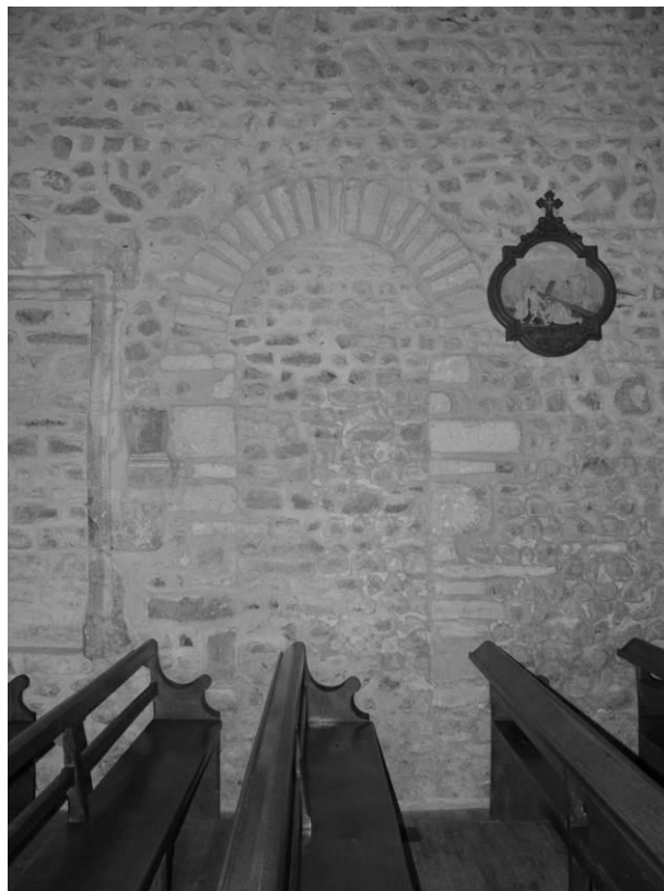
Fig. 15 : Le portail nord de la nef.
