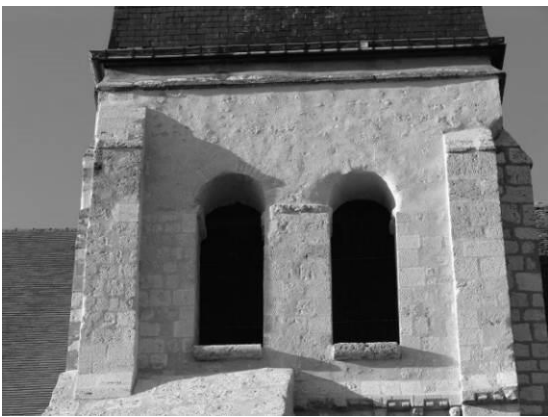
Fig. 34 : Premier étage du clocher, face sud.
