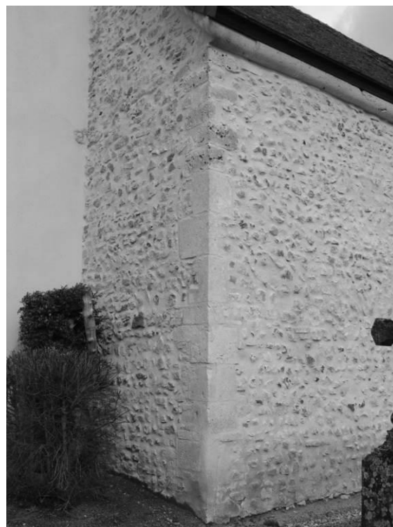
Fig. 12 : L'angle sud-ouest de la nef.
