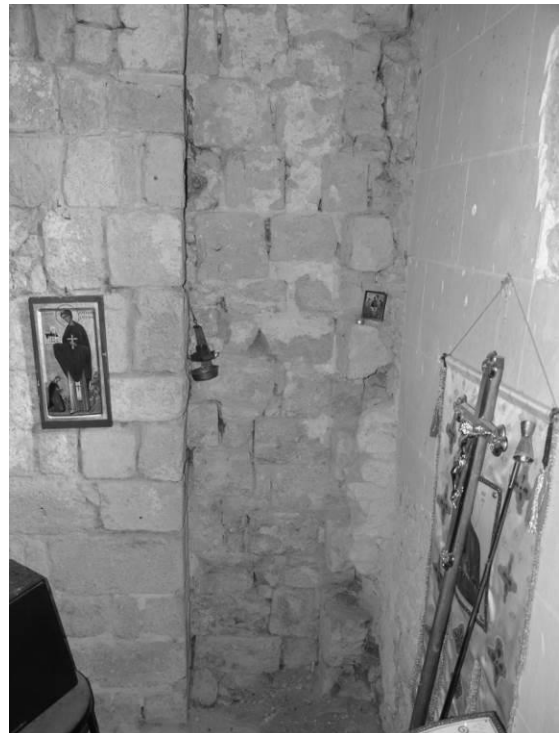
Fig. 57 : Le mur pignon oriental de la nef : détail de l'angle sud.
