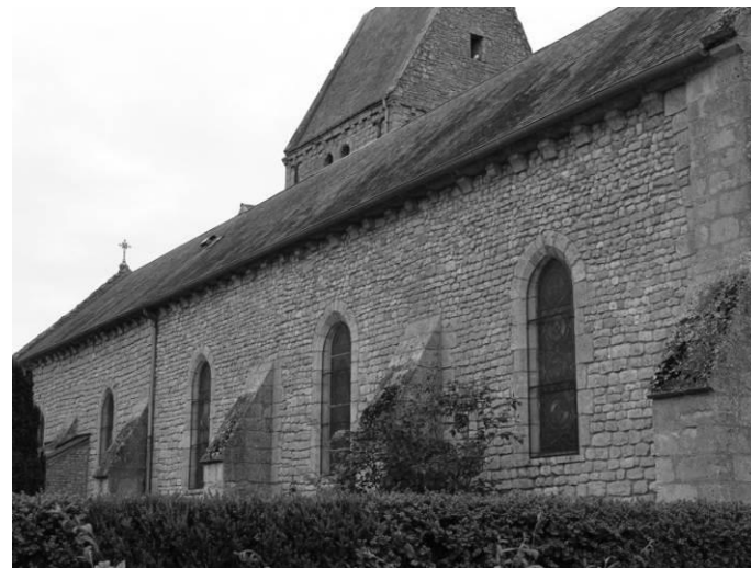
Fig. 9 : Le mur nord de l'église.
