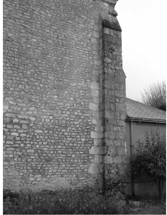
Fig. 12 : Le contrefort de l'angle nord-ouest de la nef.
