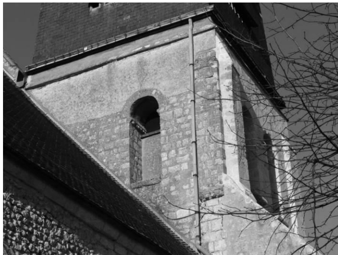
Fig. 48 : Le mur ouest du clocher.
