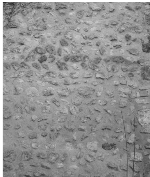
Fig. 15 : Détail du parement en moellons de la nef.
