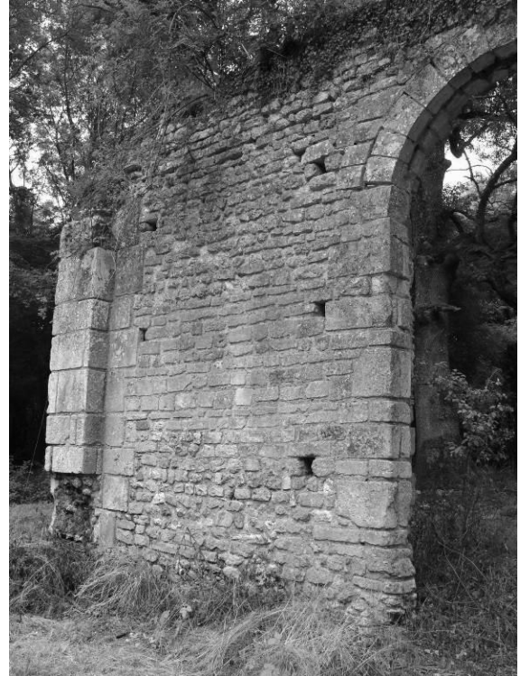
Fig. 11 : Le piédroit nord du portail, à l'extérieur.
