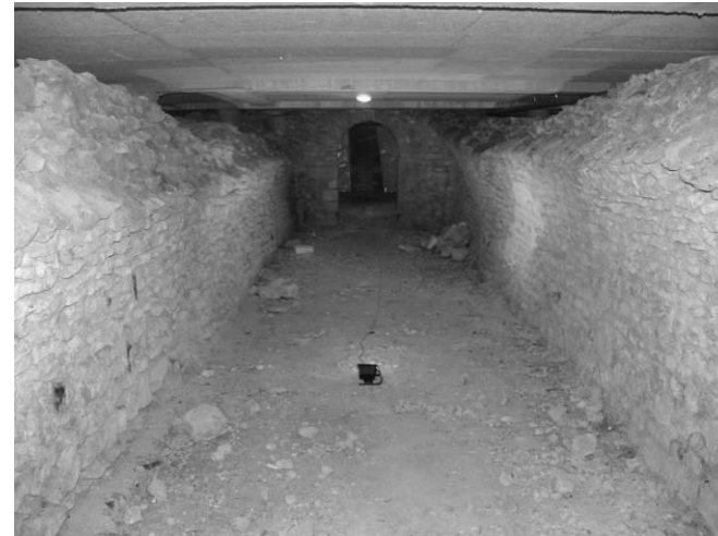
Fig. 81 : La salle occidentale, vue vers l'est.
