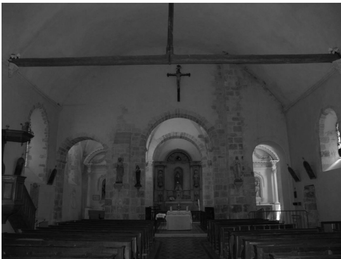
Fig. 10 : L'intérieur de l'église, vers l'est.
