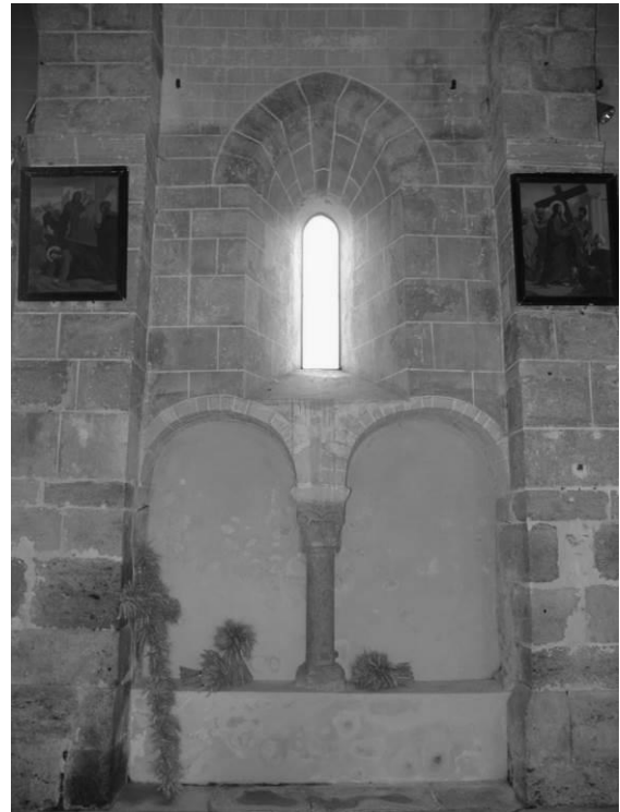
Fig. 17 : Détail de la travée occidentale.
