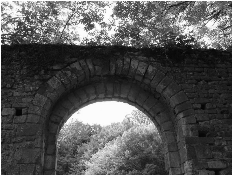
Fig. 12 : L'arc du portail, vu depuis l'intérieur de la nef.
