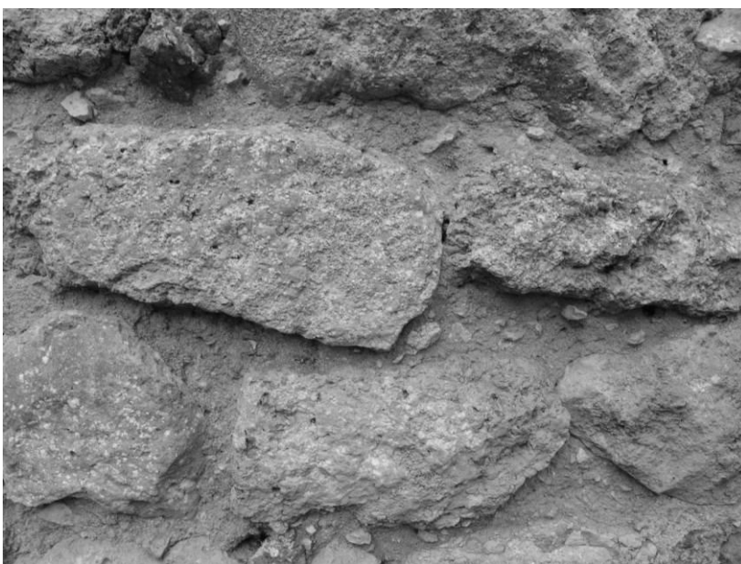
Fig. 79 : Détail du parement en moellons de l'absidiole.
