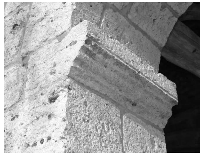
Fig. 15 : Une autre imposte du porche ouest.
