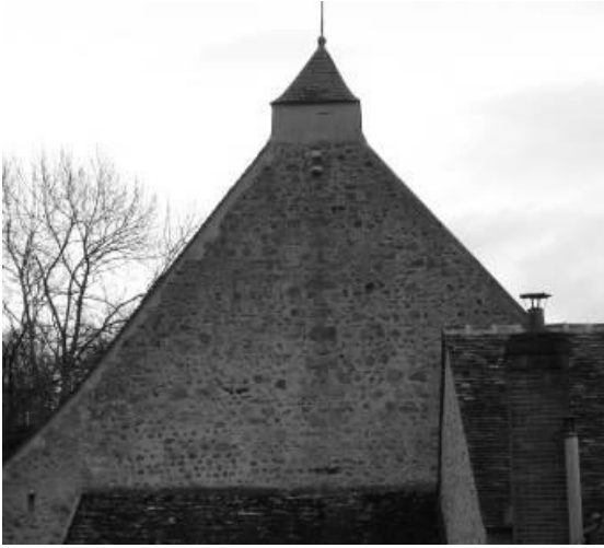
Fig. 14 : Vue de la partie supérieure du pignon ouest.
