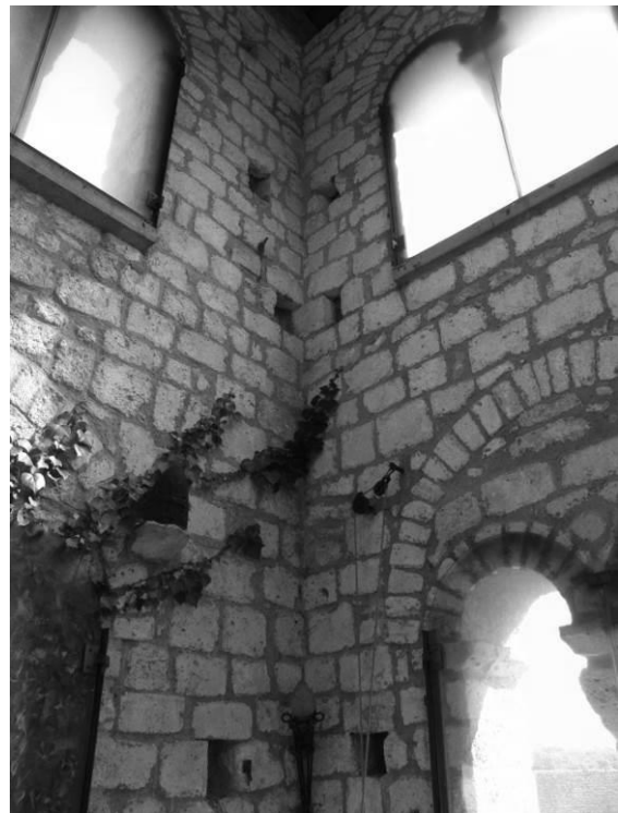
Fig. 29 : Les deux derniers étages du clocher : angle sud-est.
