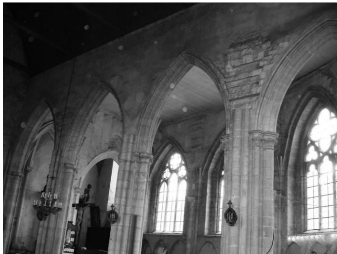
Fig. 64 : Le mur gouttereau sud de la nef.
