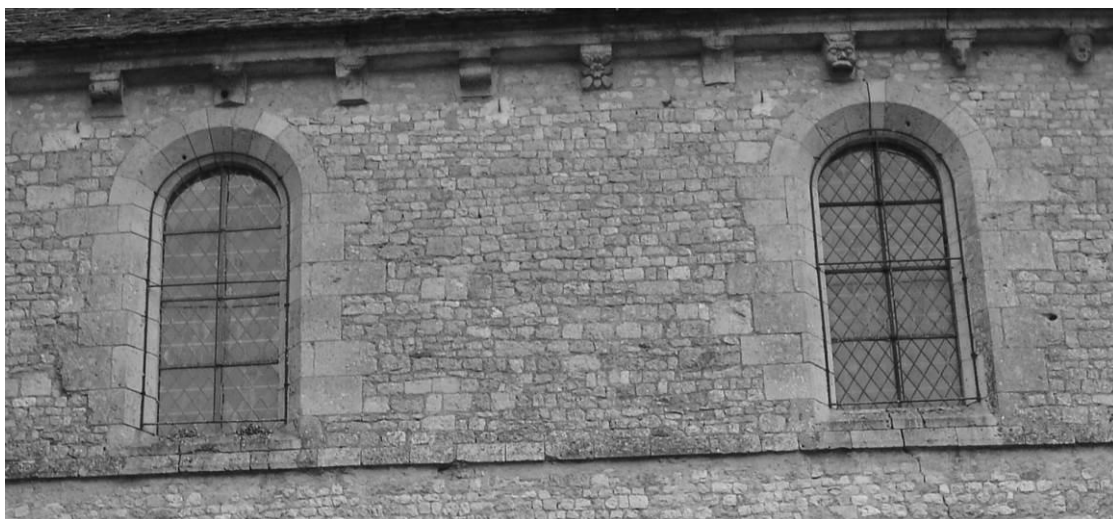
Fig. 45 : Baies hautes du mur gouttereau nord de la nef.
