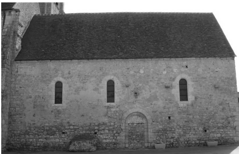
Fig. 17 : Le mur gouttereau nord de la nef.
