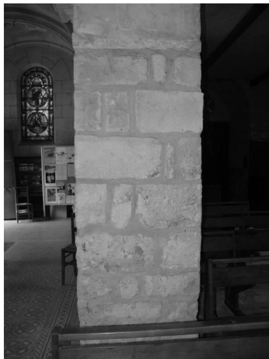
Fig. 26 : Le premier pilier du mur gouttereau sud, face est.
