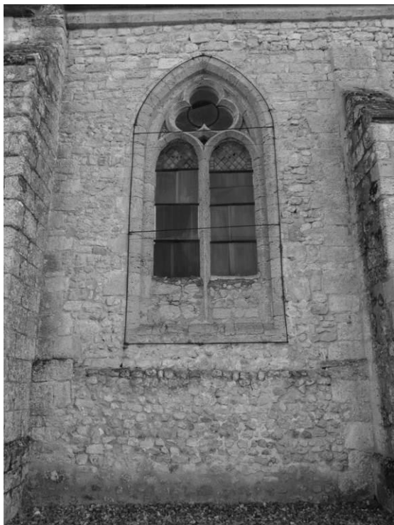
Fig. 22 : Le mur nord de l'église : troisième travée depuis l'ouest.
