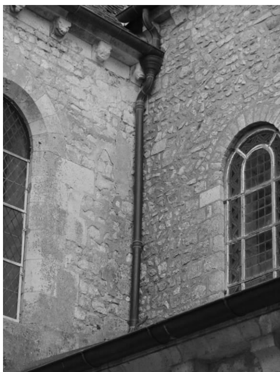
Fig. 32 : Angle entre le mur gouttereau nord de la nef et le transept.
