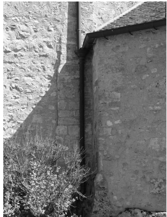
Fig. 13 : La jonction entre le mur gouttereau sud de la nef et le chevet.
