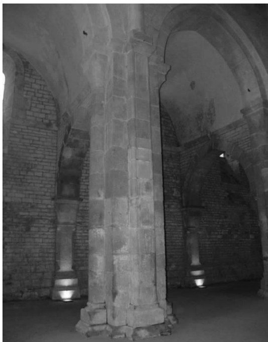
Fig. 137 : Voûtes en berceaux transversaux dans le collatéral nord de Fontenay.
