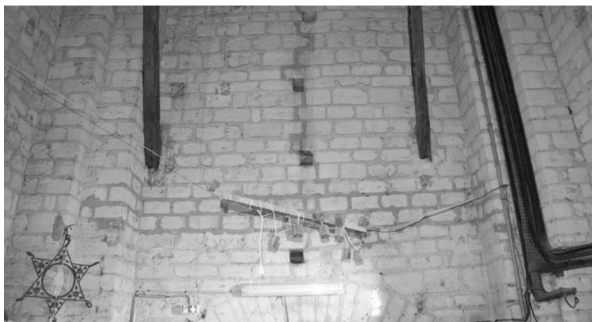
Fig. 118 : Le parement en moyen appareil de la tour-porche de Saint-Germain-des-Prés (salle haute, mur oriental).
