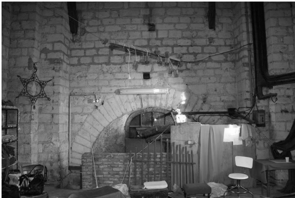
Fig. 293 : La partie supérieure de l'ancienne ouverture sur la nef de la salle haute de la tour-porche de Saint-Germain-des-Prés (salle haute aujourd'hui subdivisée dans sa hauteur pour aménager deux niveaux successifs).
