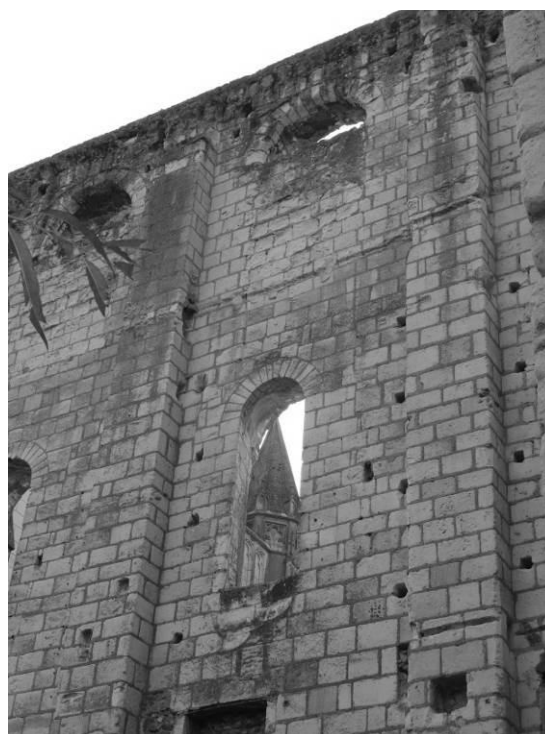
Fig. 122 : Détail du parement du mur nord de la nef de Beaulieu-lès-Loches.
