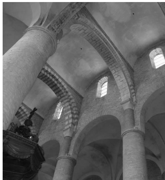
Fig. 138 : Voûtes en berceaux transversaux dans le vaisseau central de la nef de Tournus.
