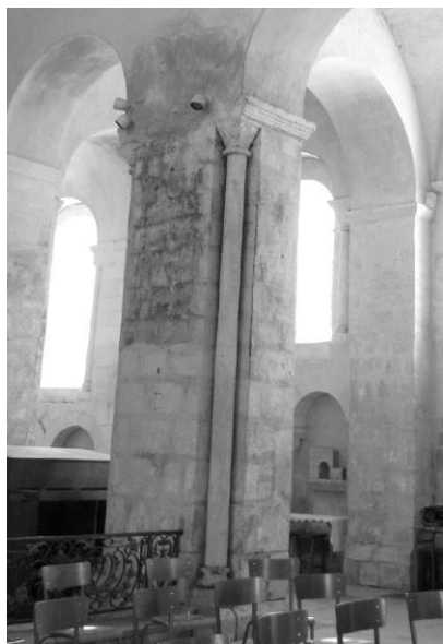
Fig. 161 : Pile composée dans le chevet de Vignory.
