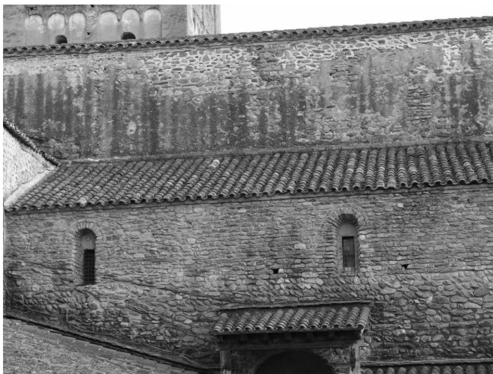
Fig. 107 : Les murs gouttereaux nord de l'abbatiale de Cuxa.
