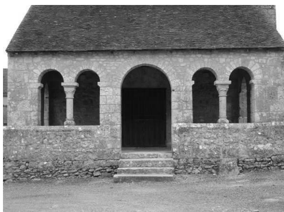
Fig. 278 : Porche occidental de l'église de Préfontaines.
