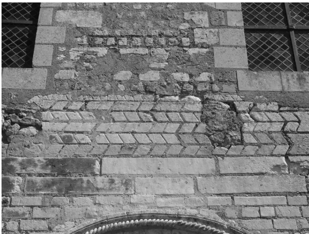
Fig. 102 : L' opus spicatum dans le mur gouttereau sud de la nef de Cravant.
