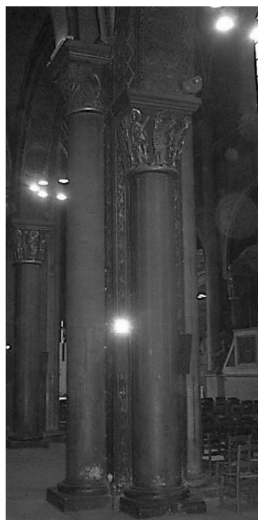
Fig. 164 : Piles à ressauts de l'abbatiale Saint-Germain-des-Prés à Paris.
