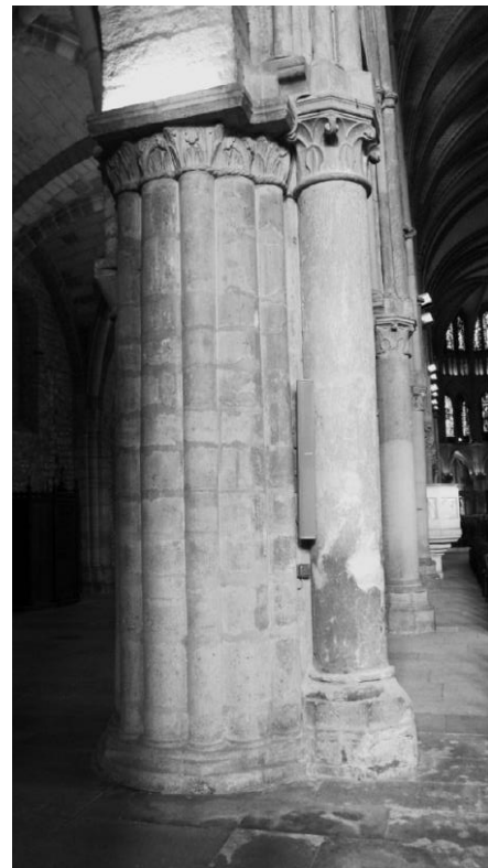
Fig. 160 : Pile fasciculée du mur gouttereau nord de la nef de Saint-Rémi de Reims.
