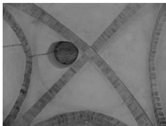
Fig. 140 : Voûte à doubleaux entrecroisés dans la souche du clocher de l'église Saint-Salomon de Pithiviers.
