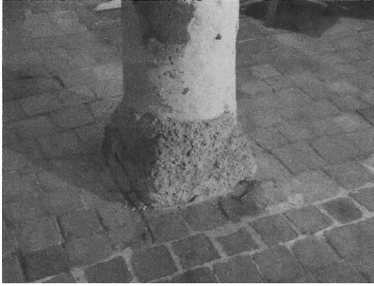
Fig. 256 : Base talutée dans la crypte de la collégiale d'Étampes.
