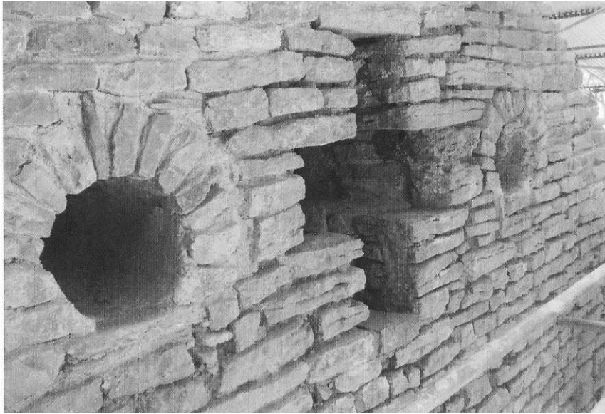
Fig. 200 : Partie supérieure de la façade ouest de Saint-Lupicin.
