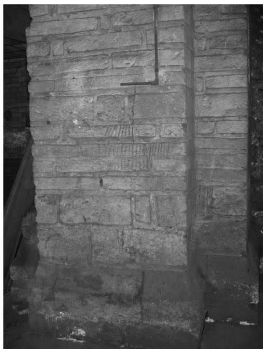
Fig. 163 : Piles à ressauts de la cathédrale Sainte-Croix d'Orléans.
