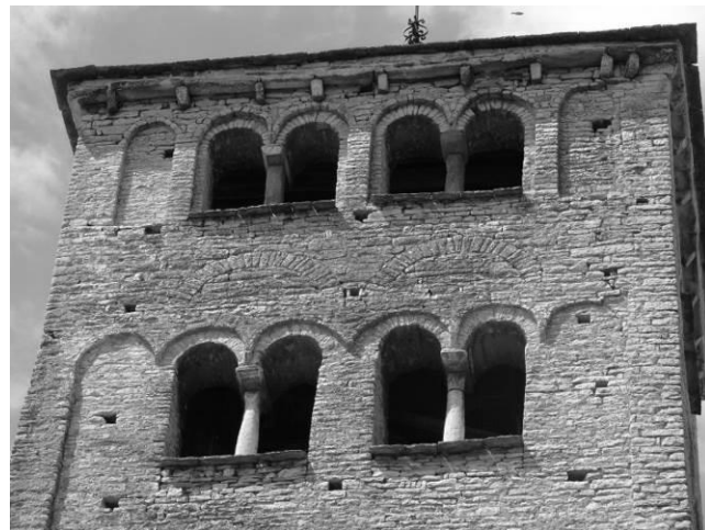
Fig. 206 : Baies géminées du clocher de Chapaize.
