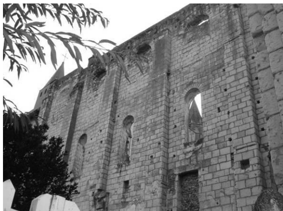
Fig. 166 : Mur nord de la nef de Beaulieu-lès-Loches.
