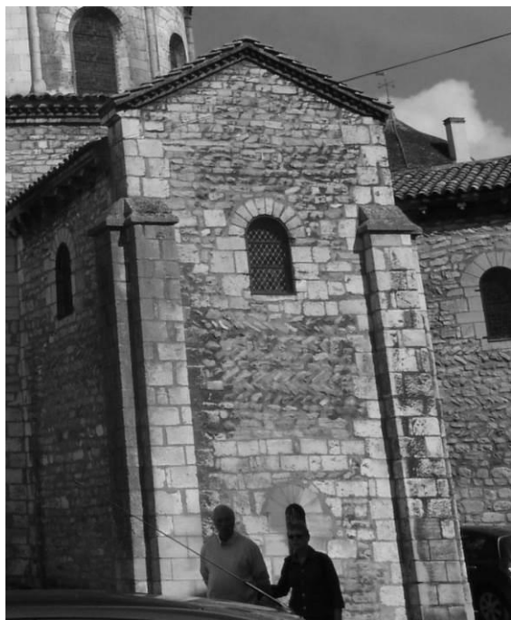
Fig. 169 : Contreforts en équerre aux angles des chapelles du chevet de l'abbatiale de Tournus.
