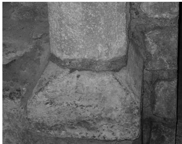
Fig. 255 : Base talutée dans la crypte de Saint-Avit d'Orléans.
