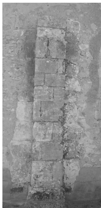
Fig. 179 : Contrefort du chevet de l'église de Lombreuil.
