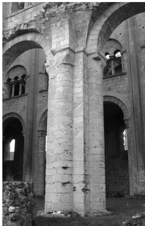
Fig. 162 : Pile composée dans la nef de Notre-Dame de Jumièges.
