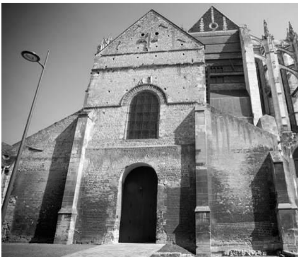
Fig. 199 : Façade occidentale de la Basse-Œuvre de Beauvais.
