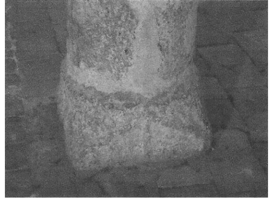
Fig. 257 : Base talutée dans la crypte de la chapelle octogonale de Senlis.
