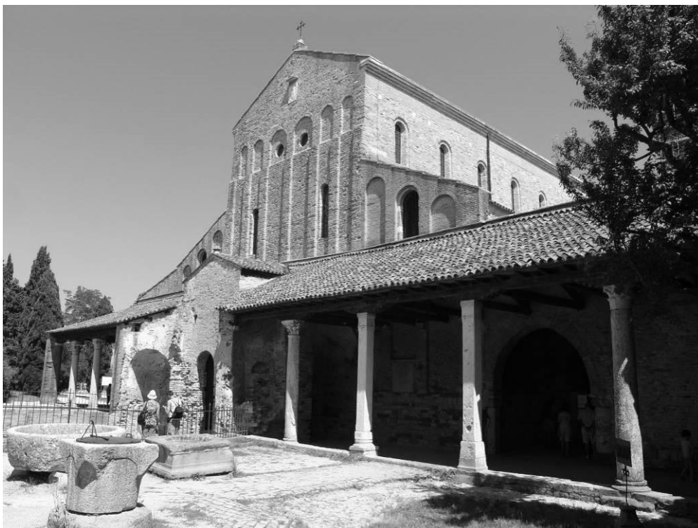
Fig. 277 : Façade occidentale de l'église de Torcello.
