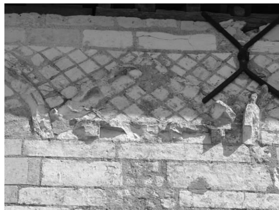
Fig. 222 : Détail du décor en opus reticulatum du mur sud de la nef de Cravant.
