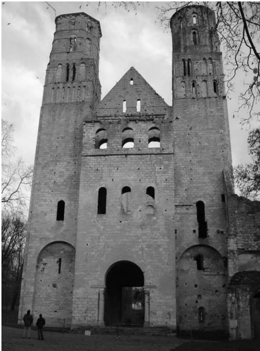
Fig. 286 : La façade actuelle du massif occidental de Notre-Dame de Jumièges, face ouest.
