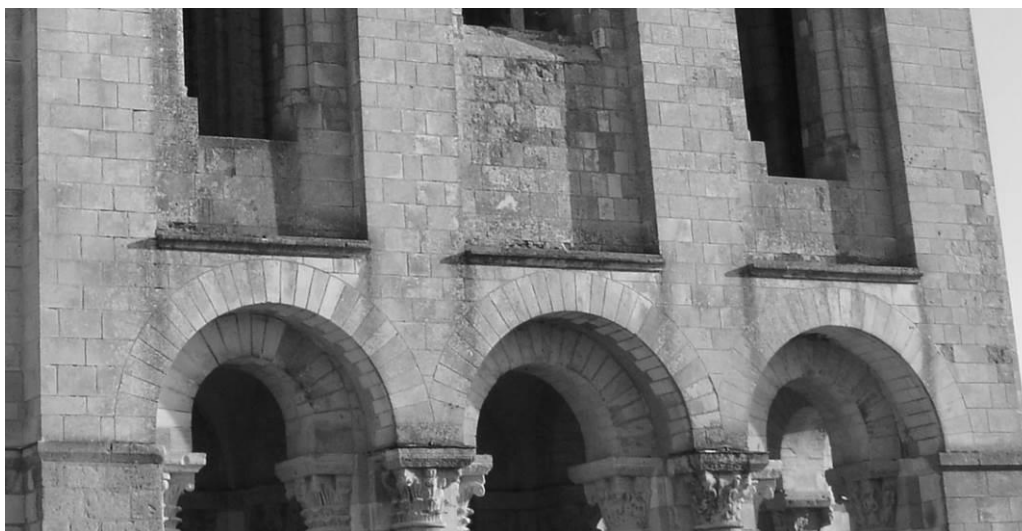
Fig. 117 : Le parement en moyen appareil de la tour-porche de Saint-Benoît-sur-Loire.
