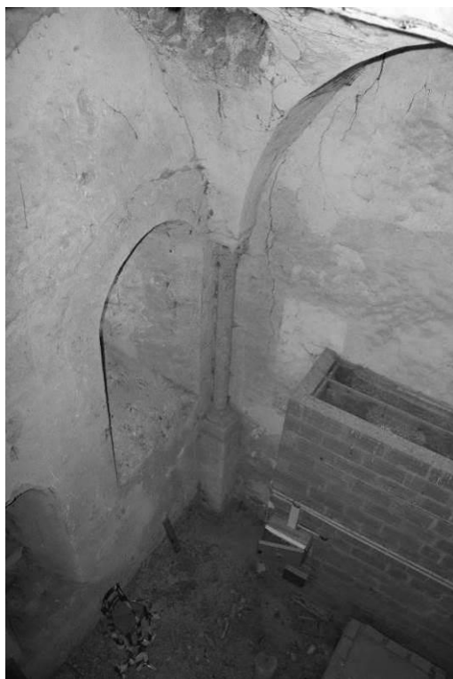
Fig. 303 : La salle haute de la tour-porche de Meung-sur-Loire.
