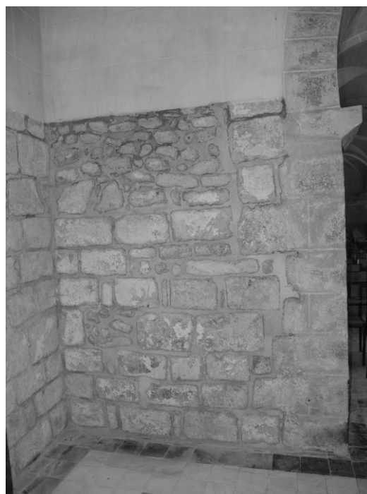
Fig. 395 : L'angle sud-ouest du transept.
