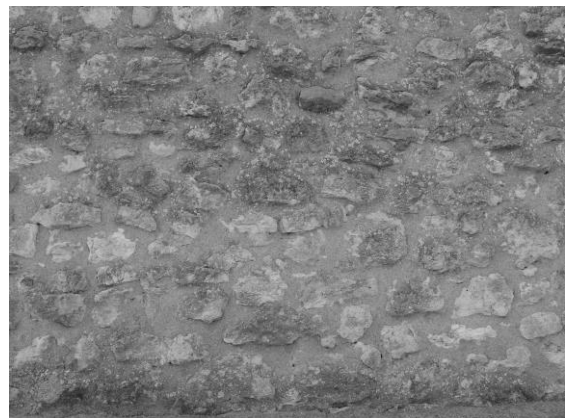
Fig. 304 : Détail du parement du mur gouttereau sud de la nef.
