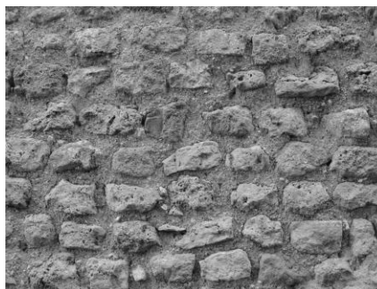
Fig. 124 : Détail du parement du mur nord du transept, face extérieure.
