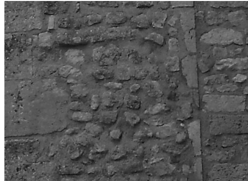
Fig. 215 : Détail du parement du mur ouest du bras nord du transept.
