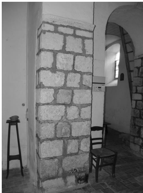
Fig. 334 : Pile nord-ouest du chœur.
