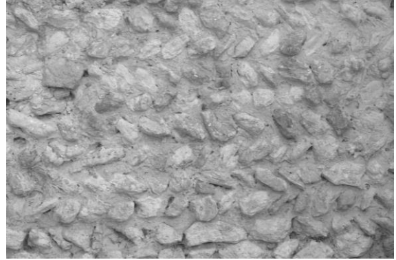
Fig. 277 : Détail du mur gouttereau sud de la nef.
