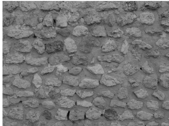
Fig. 1 : Le mur gouttereau nord de la nef.
