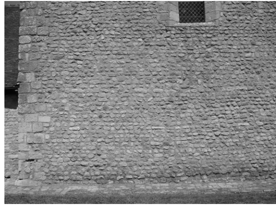
Fig. 190 : La partie occidentale du mur sud de la nef.
