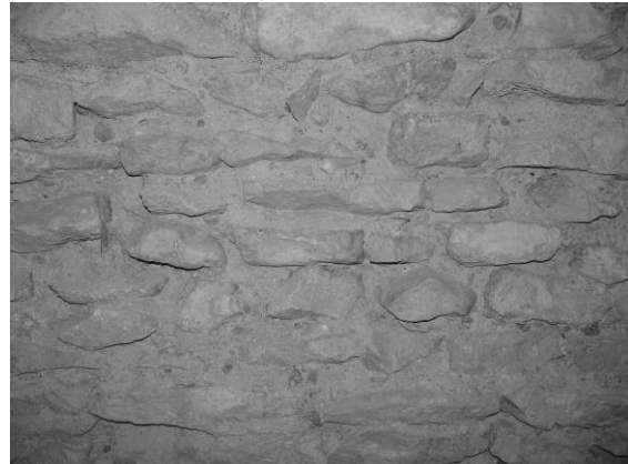
Fig. 52 : Détail du parement du mur nord de la salle sud.
