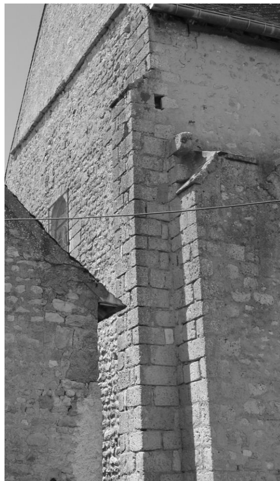
Fig. 401 : Les contreforts épaulant l'angle sud-est.
