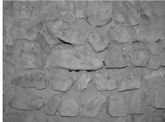
Fig. 42 : Détail du parement du mur ouest de la salle orientale.
