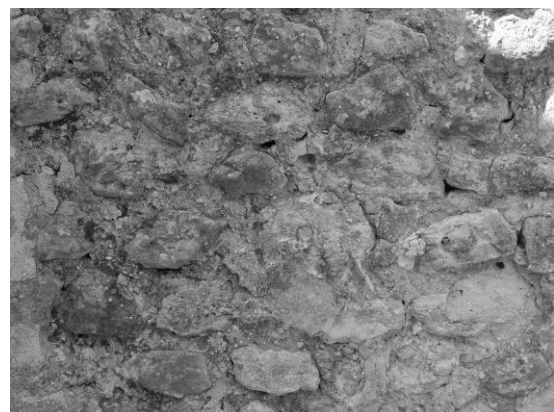
Fig. 291 : Détail du parement du mur sud de la nef.
