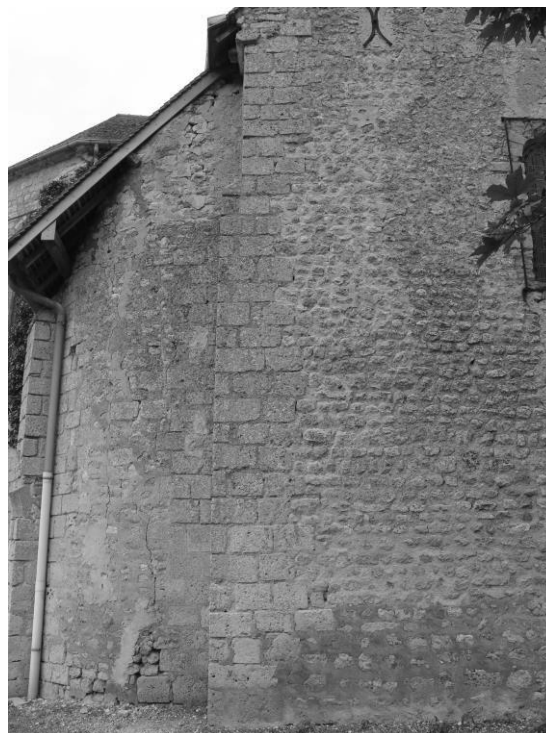
Fig. 388 : L'angle nord-est du transept.
