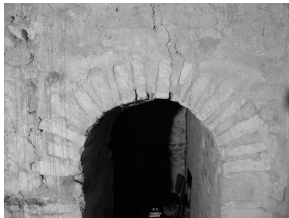
Fig. 494 : L'arc de la porte nord-ouest du clocher, face nord.
