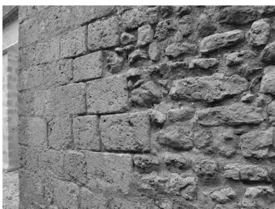
Fig. 400 : Détail du chaînage d'angle sud-ouest.
