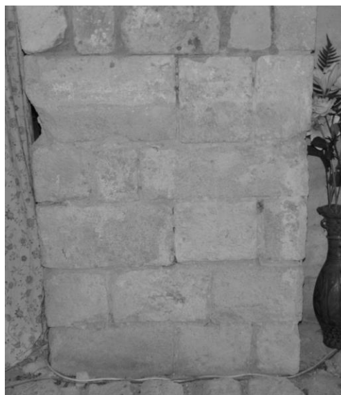
Fig. 309 : Détail de la base du contrefort nord du mur pignon oriental de la nef.
