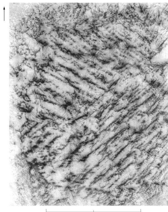
Fig. 546 : Nef, mur gouttereau nord, quatrième pile, face ouest.
