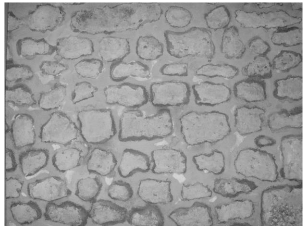
Fig. 119 : Détail du parement intérieur du mur nord du transept.
