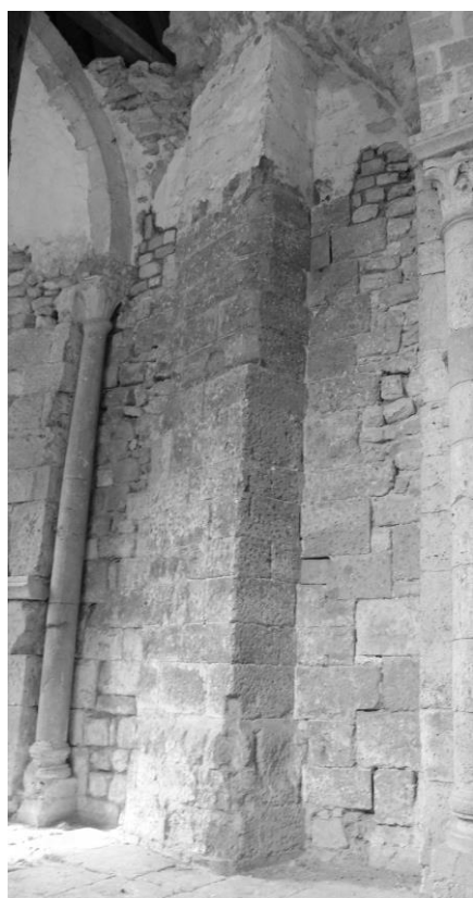
Fig. 439 : Le contrefort au rez-de-chaussée.
