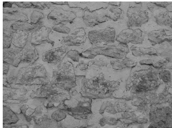
Fig. 296 : Détail du parement de l’abside.
