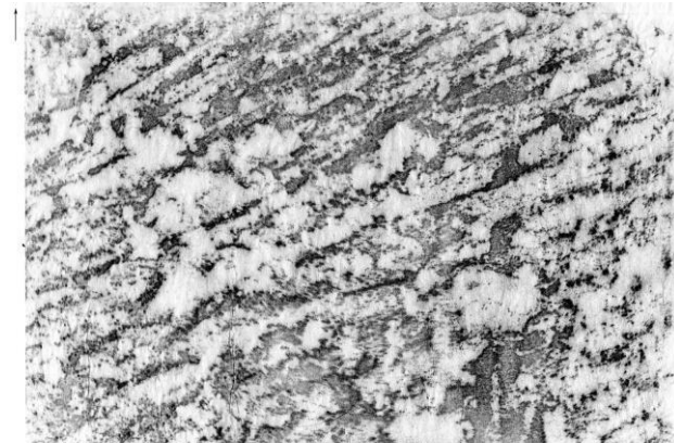
Fig. 502 : Bloc du pilier sud de l'arc triomphal du chœur (8 e assise).
