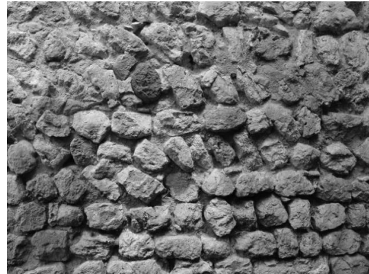
Fig. 154 : Détail du parement du mur sud de la nef, à l'est du coup de sabre.
