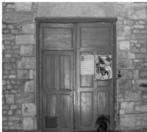
Fig. 487 : Le portail ouest de la nef.
