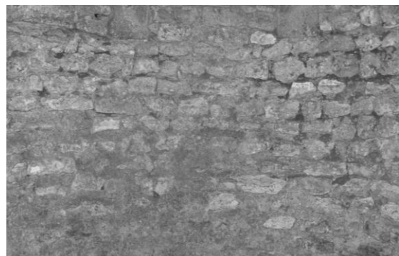
Fig. 173 : Détail du parement de l'absidiole de la crypte.
