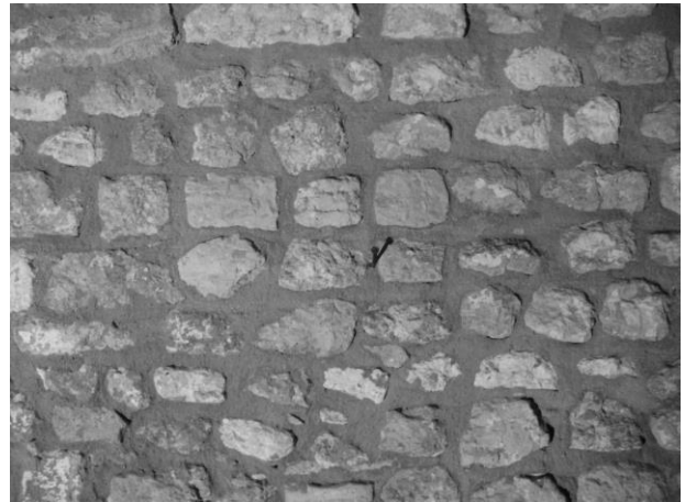
Fig. 197 : Détail du parement du mur ouest de la nef.
