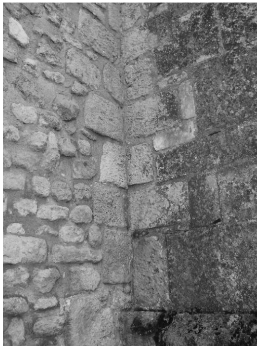
Fig. 483 : Détail du chaînage entre le mur nord du transept le contrefort nord-ouest.
