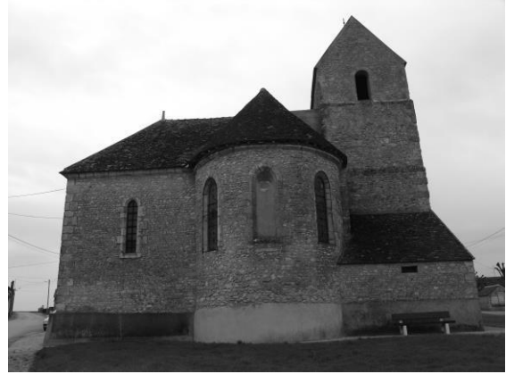
Fig. 302 : L'église vue depuis l'est.
