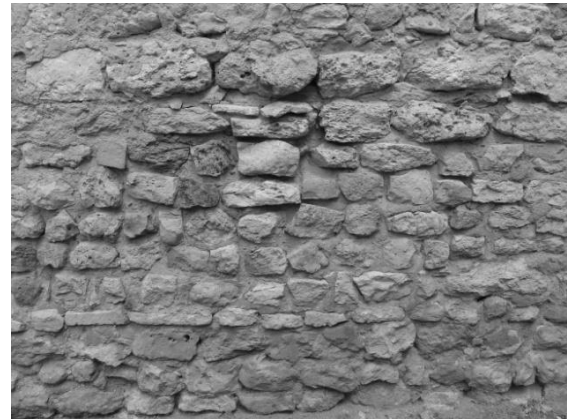
Fig. 149 : Détail du parement dans la partie occidentale du mur sud de la nef.
