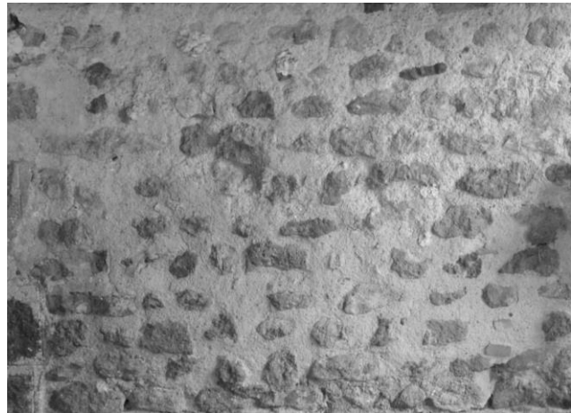
Fig. 12 : Détail du parement en moellons du mur ouest de la nef.
