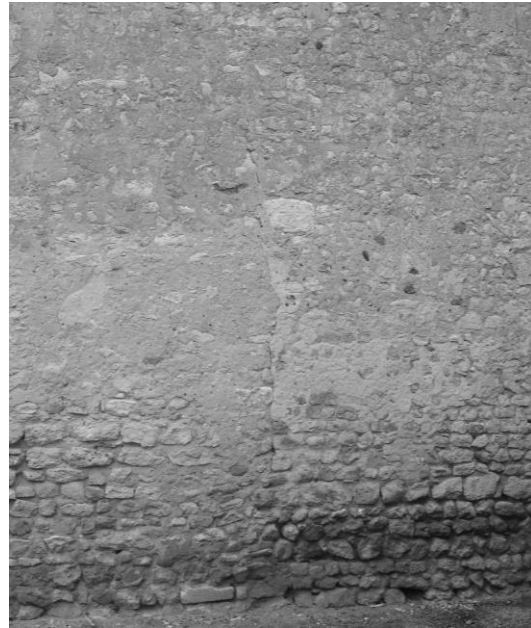
Fig. 148 : Le coup de sabre au centre du mur gouttereau sud de la nef.
