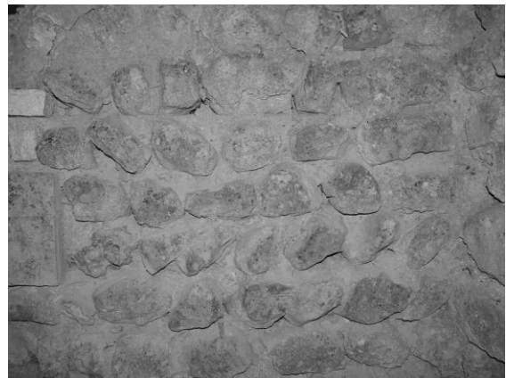
Fig. 37 : Détail du parement du mur nord de la salle orientale.
