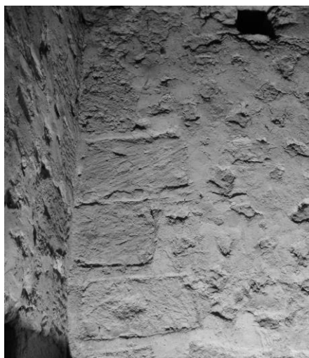
Fig. 477 : L'angle sud-est du clocher, face intérieure.
