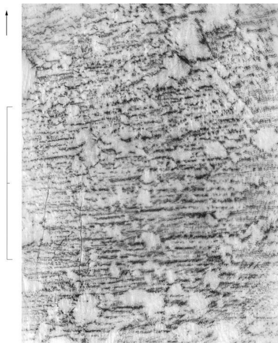
Fig. 551 : Support ouest à l'entrée de la chapelle haute, 6 e assise.
