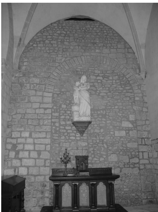
Fig. 394 : Le mur est du bras sud du transept.
