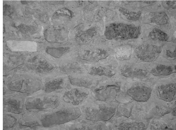
Fig. 47 : Détail du parement du mur sud du couloir sud.
