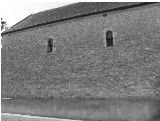
Fig. 303 : Le mur gouttereau sud de la nef.
