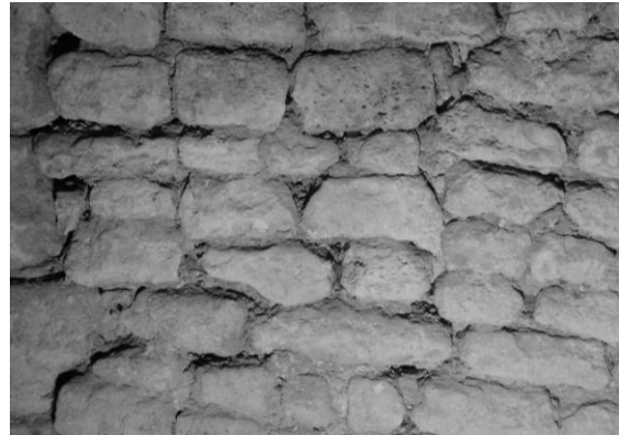
Fig. 221 : Détail du parement du mur sud du transept.
