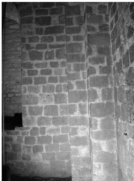
Fig. 358 : Le contrefort d'angle nord-ouest du clocher.
