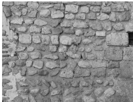
Fig. 129 : Détail du parement du pignon occidental du bas-côté nord.
