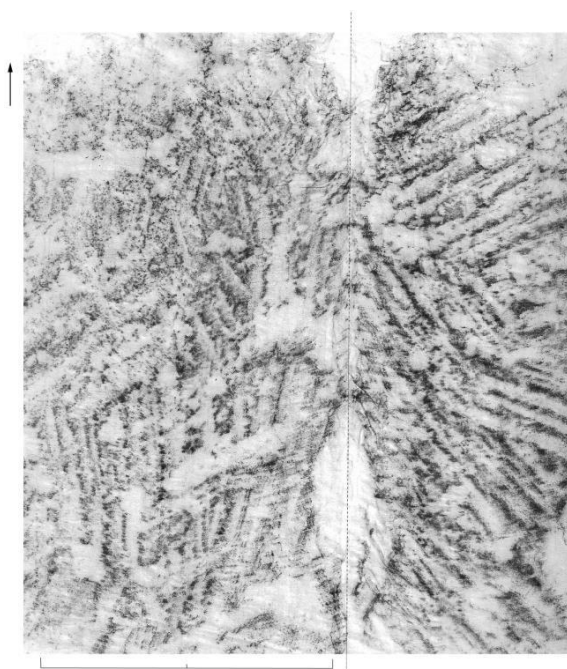
Fig. 541 : Clocher, baie ouest du premier étage, piédroit nord, deuxième assise.
