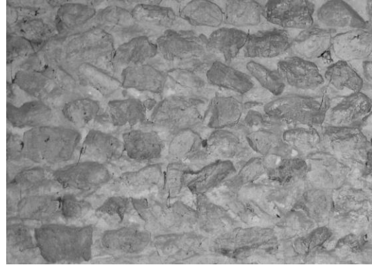
Fig. 96 : Détail du parement du mur gouttereau nord de la nef.
