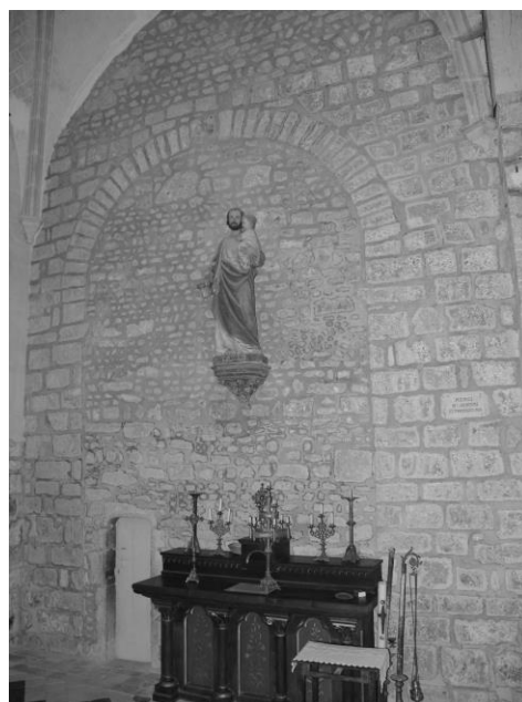
Fig. 382 : Le mur est du bras nord du transept.
