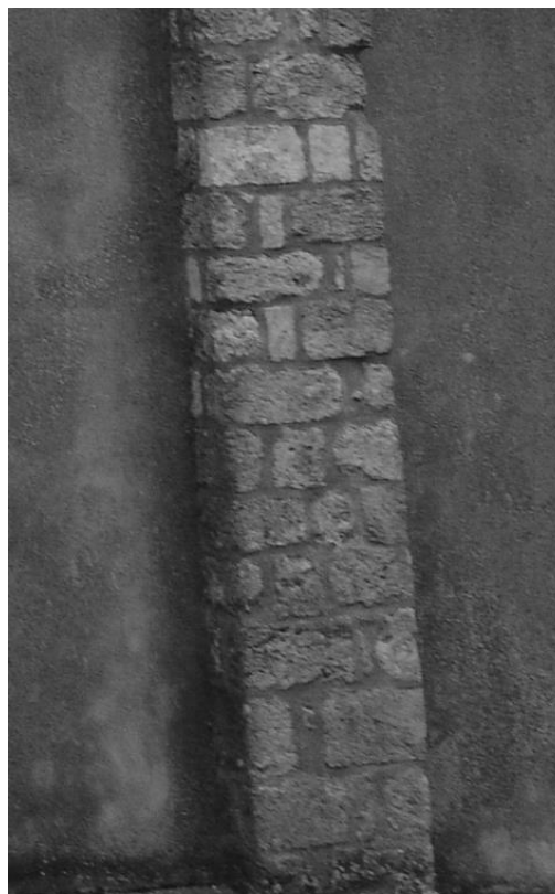
Fig. 339 : Détail du contrefort sud de la façade ouest.
