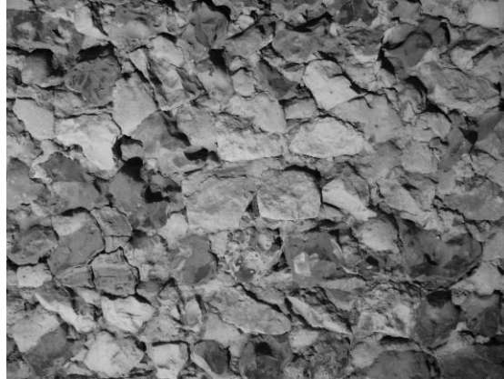
Fig. 58 : Détail du parement du mur sud du clocher.
