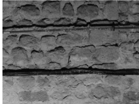
Fig. 232 : Détail du parement du mur sud du clocher (derrière des câbles électriques).
