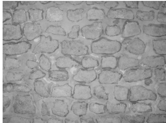
Fig. 109 : Détail du parement intérieur du mur sud du transept.
