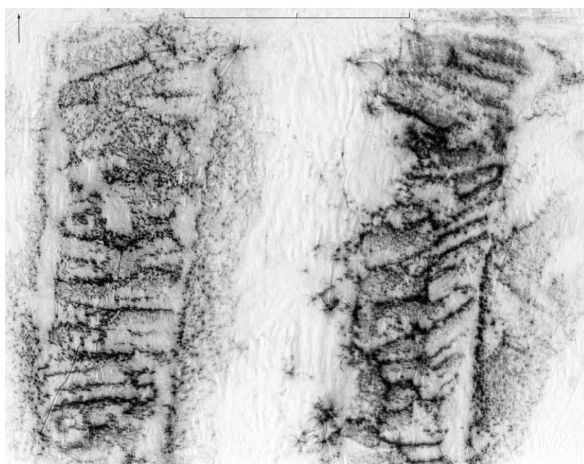
Fig. 559 : Deux claveaux de la porte nord-ouest du clocher, face nord.
