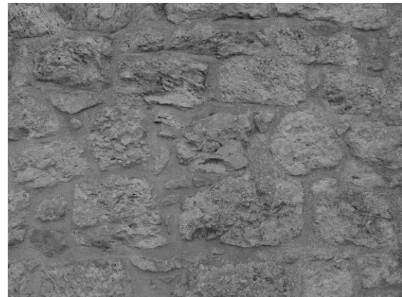
Fig. 7 : Détail du parement du mur gouttereau nord du chevet.
