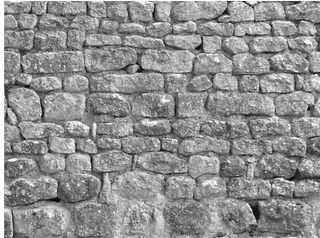
Fig. 17 : Détail du parement du mur nord de la nef.
