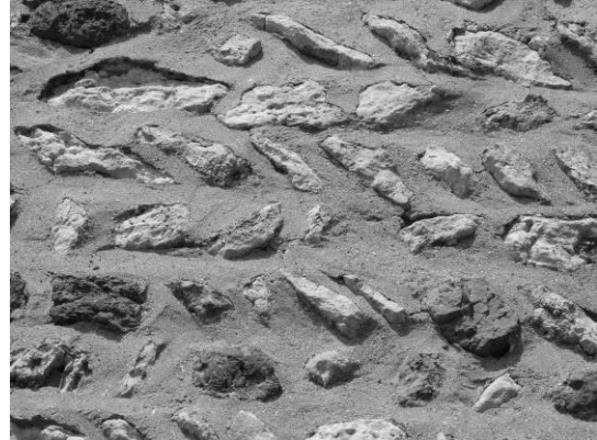
Fig. 256 : Détail du parement du mur sud du collatéral sud.
