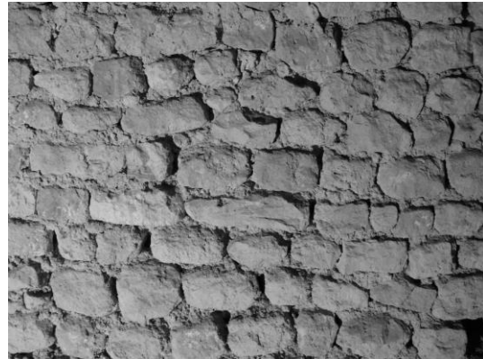
Fig. 210 : Détail du parement du mur nord du transept, partie supérieure.
