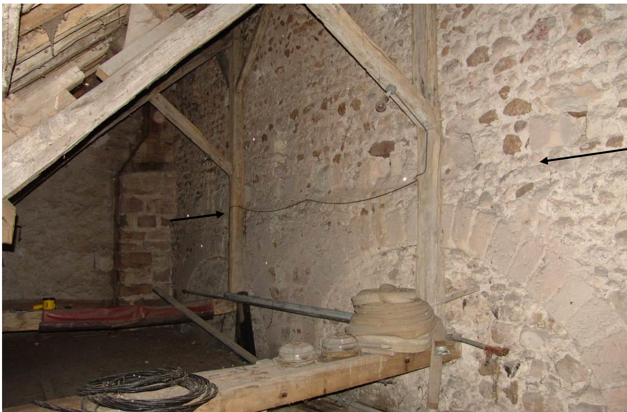
Fig. 39 : Mur gouttereau sud de la nef, dans le comble du collatéral. Les flèches indiquent l'emplacement de l'ancienne charpente, avec les cavités pour encastrer les poutres.
