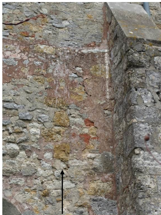
Fig. 16 : Une ancienne baie bouchée dans le mur gouttereau sud de la nef.
