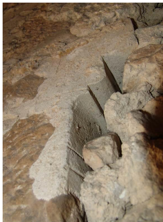
Fig. 41 : Pilier central du mur sud de la nef : imposte orientale en stuc avec vestiges de faux joints gravés.
