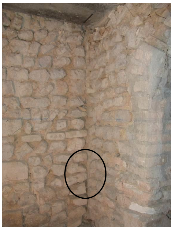
Fig. 60 : Angle entre le mur sud et le mur ouest de la salle orientale.
