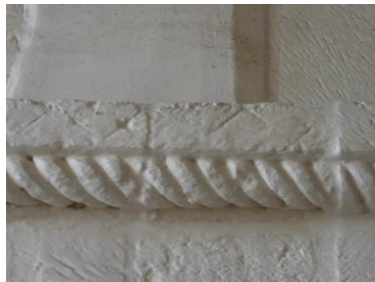
Fig. 35 : L'imposte sud, état actuel.
