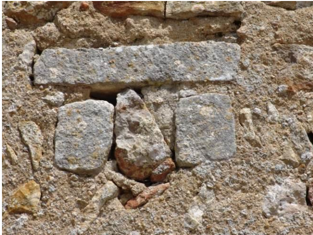
Fig. 21 : Détail de l'un des trous de boulins bouchés du mur gouttereau sud de la nef.
