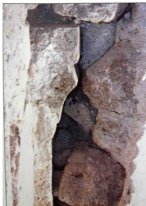
Fig. 33 : Sondage n°1 : détail du piédroit nord bûché à l'angle du mur nord. In : Herment H., Lallet C., Pithiviers. Salle du donjon. Ancienne collégiale Saint-Georges (Loiret). Rapport de diagnostic, avril 2004, pl. 2.
