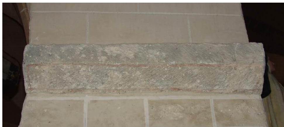
Fig. 182 : Imposte du mur gouttereau nord de la nef.
