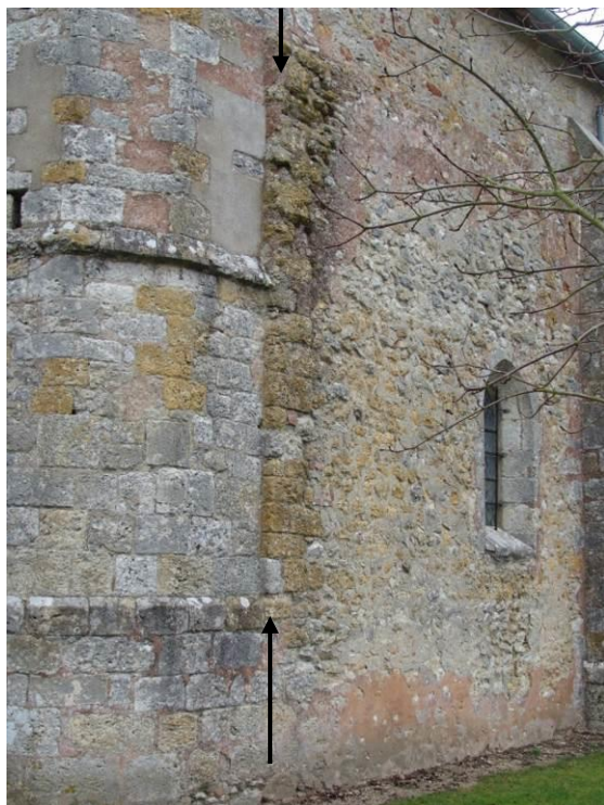
Fig. 15 : L'ancien angle de la nef, avec la tourelle d'escalier du clocher venue s'appuyer contre lui.
