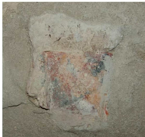
Fig. 184 : Bras sud du transept : élément sculpté (fragment de colonnette engagée ?) avec polychromie, en remploi dans le bouchage de l'arc de tête de l'absidiole.
