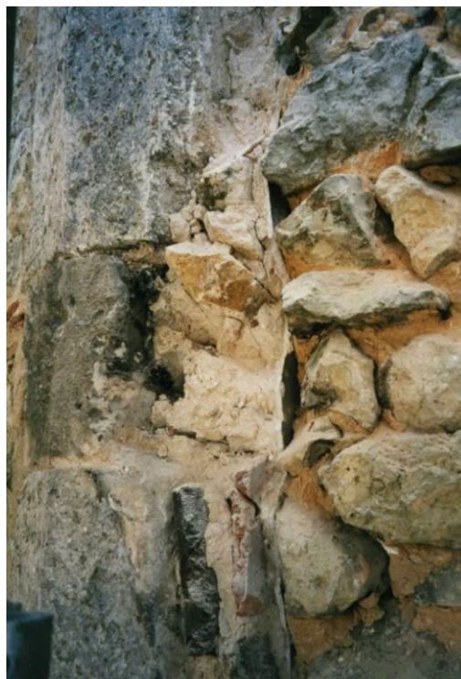
Fig. 19 : Traces de reprises entre l'angle oriental et le mur en moellons.
