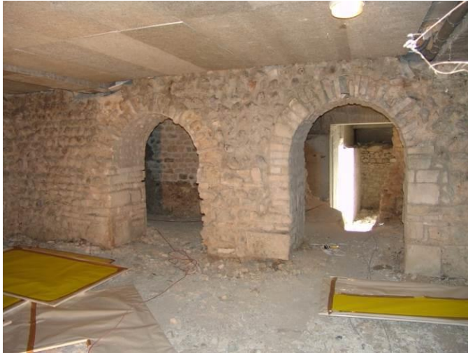
Fig. 54 : Le mur sud de la salle orientale.
