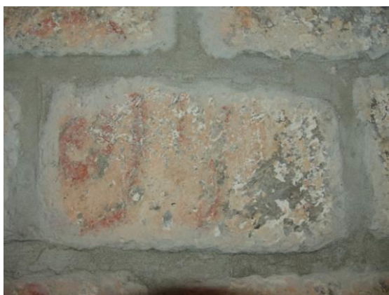
Fig. 183 : Bras nord du transept : bloc avec vestiges de laits de chaux polychromes.
