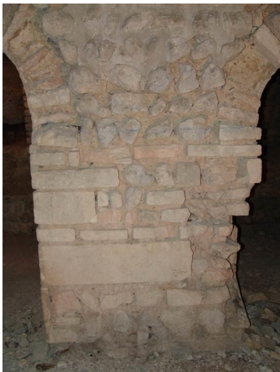
Fig. 58 : Pilier entre les deux arcades du mur nord de la salle orientale.
