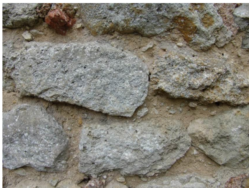
Fig. 79 : Détail du parement en moellons de l'absidiole.
