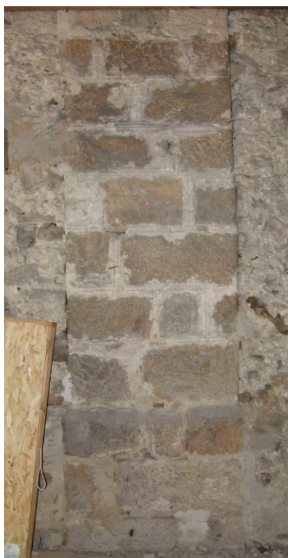
Fig. 40 : Pilier oriental du mur gouttereau sud de la nef.
