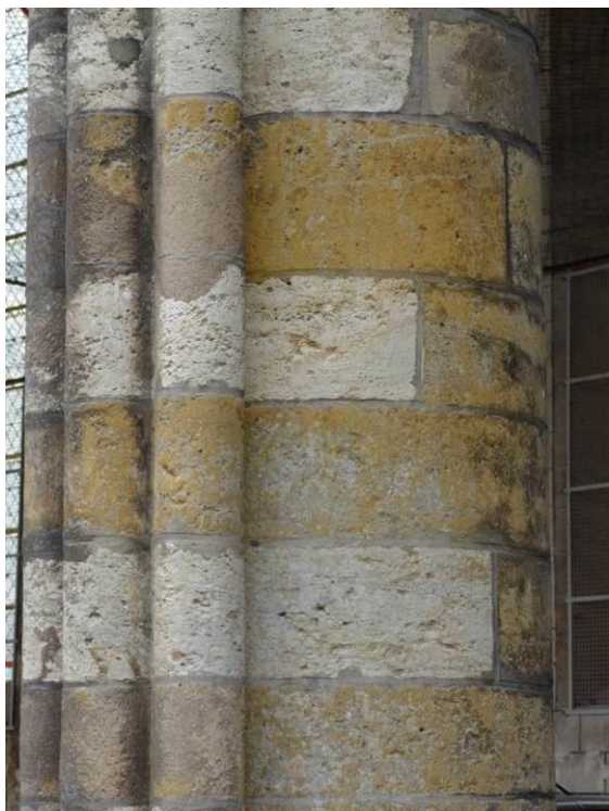
Fig. 130 : Alternance de calcaires de Pithiviers jaune et blanc dans les piles de la collégiale gothique.
