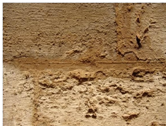
Fig. 131 : Détail de joints tirés au fer dans les piliers de la partie occidentale de la crypte.
