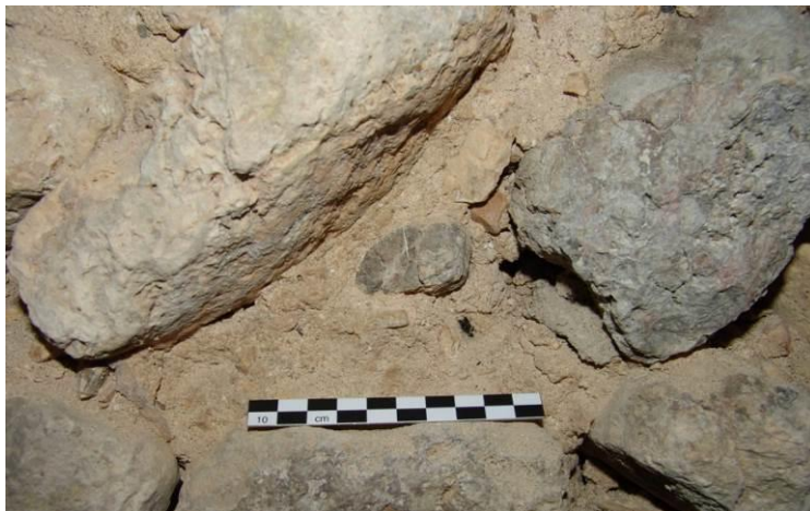
Fig. 56 : Détail du mortier dans les joints du mur oriental de la crypte.
