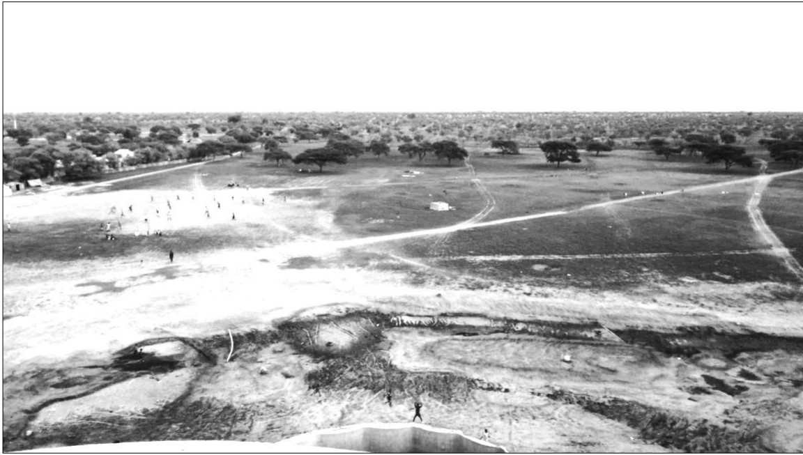
Photographie 1 : Absence de couvert végétal autour du forage (vue sud du château d'eau) Auteur : M. Moingeon, 2015
