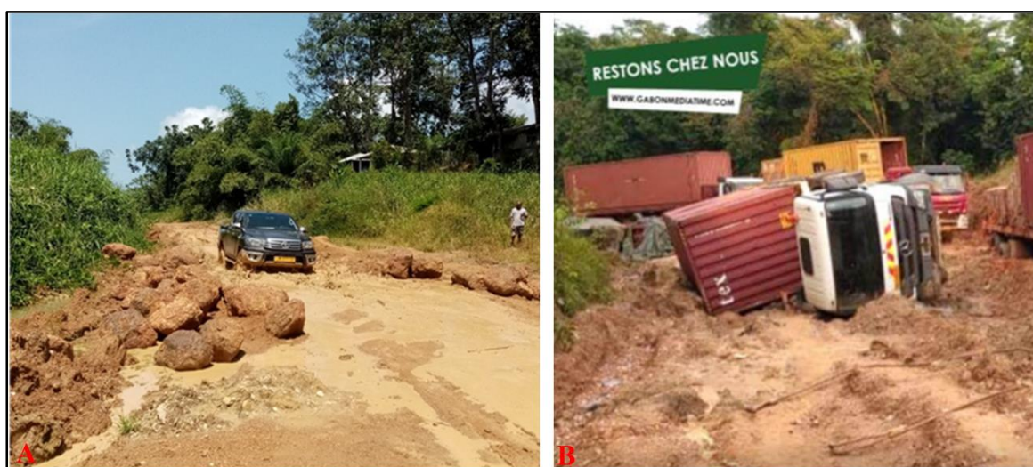
A) Bourbier à Santa-Clara, un véritable obstacle dans l'acheminement des produits agricoles, 2021 ; B) mauvais état de la route sur l'axe pont d'Alembé-Lopé en 2020.
