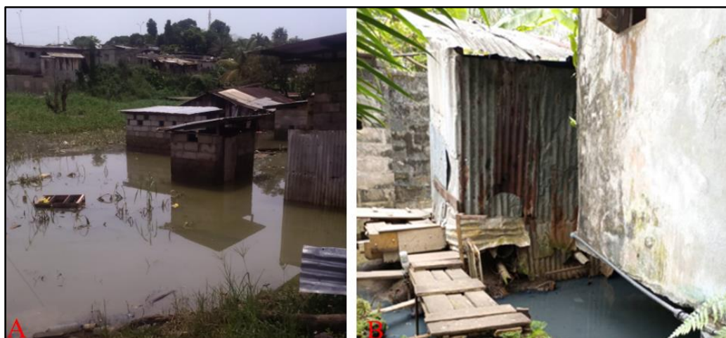
A) Les eaux usées provenant des latrines pendant l'inondation et utilisées pour l'irrigation des cultures au quartier Pk 8 ; B) latrine perforée en contrebas permettant l'évacuation des matières fécales directement dans le cours d'eau au quartier Baie des Cochons (3 ème arrondissement de Libreville).
