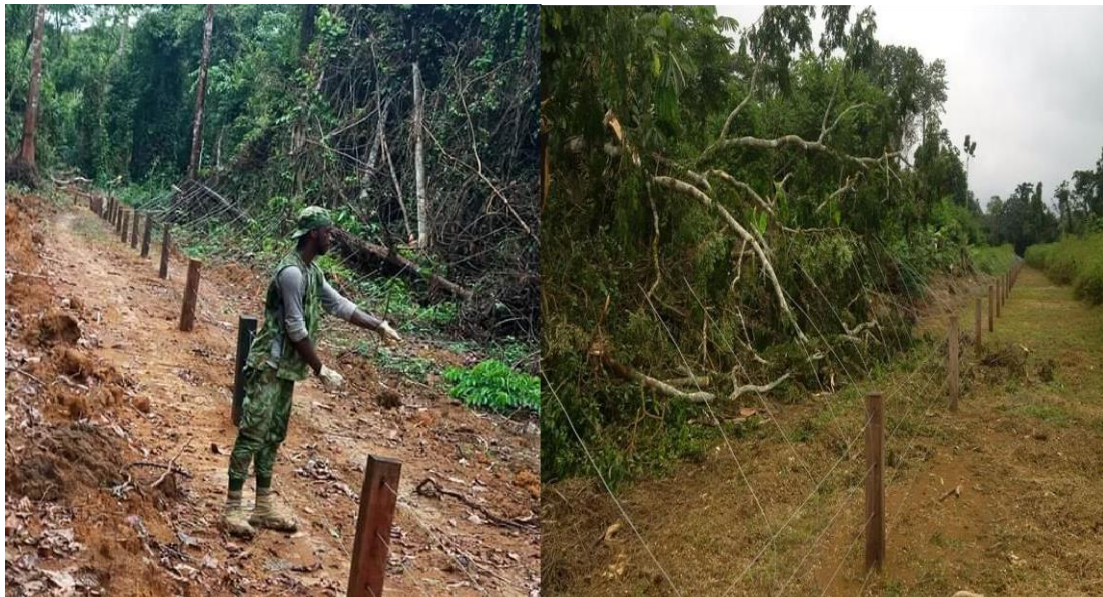
Figure n°17 - Construction des barrières électriques dans le village Panga et à Ndindi
